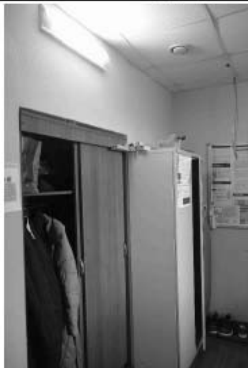
28. Фрагмент пом. 70-Н (12) в уровне 1-го этажа.
