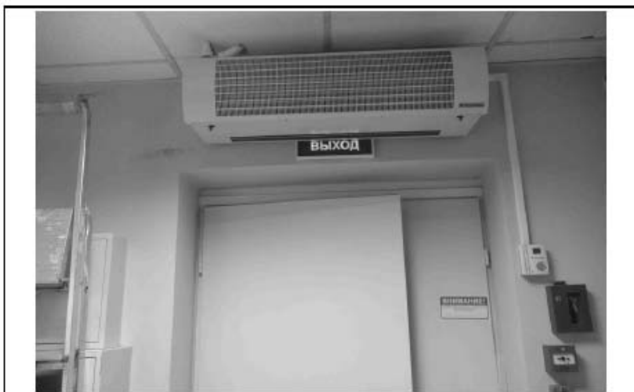
25. Фрагмент пом. 70-Н (11) в уровне 1-го этажа.
