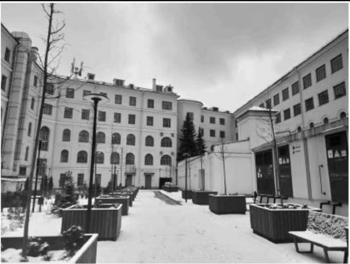
10. Общий вид южного дворового фасада северного лицевого корпуса объекта культурного наследия.
