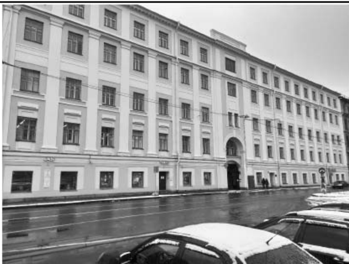
3. Общий вид южного лицевого фасада объекта культурного наследия.
