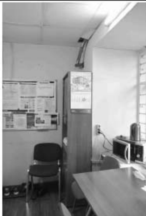
29. Фрагмент пом. 70-Н (12) в уровне 1-го этажа.
