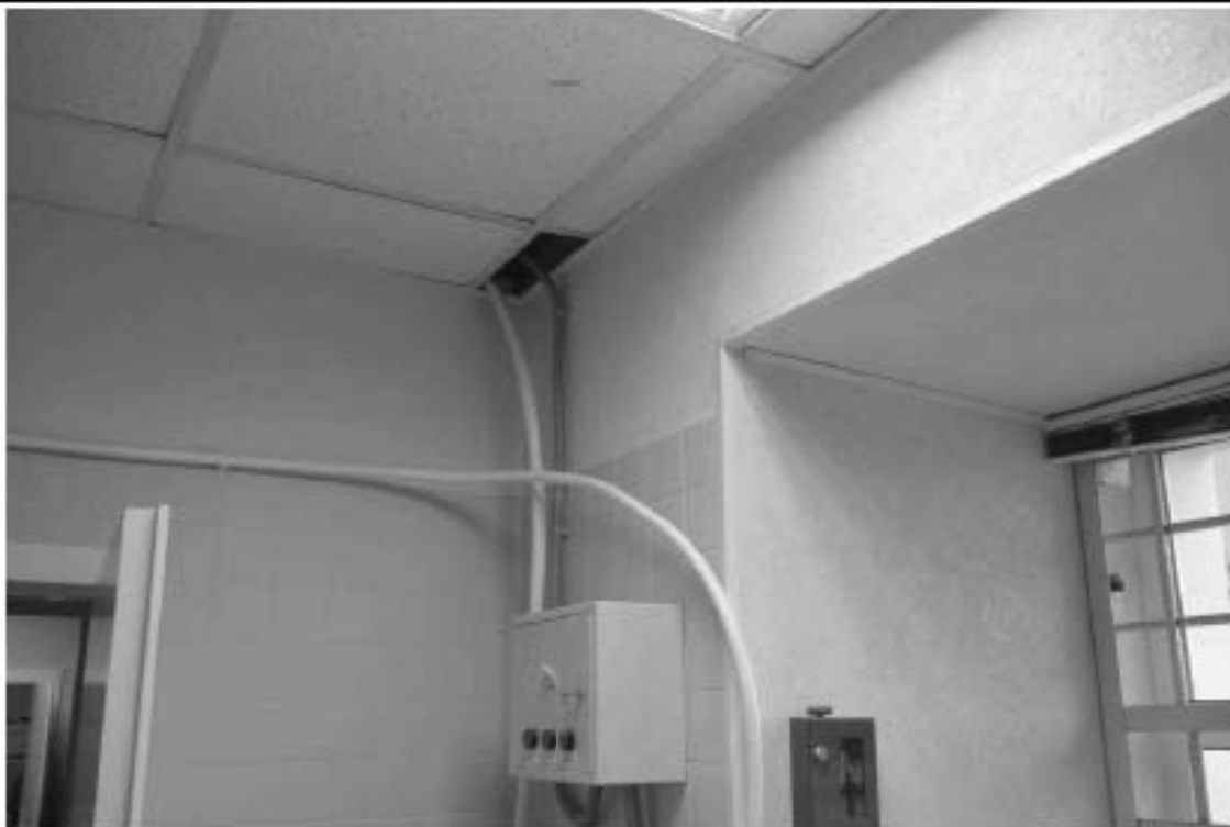
23. Фрагмент пом. 70-Н (7) в уровне 1-го этажа.
