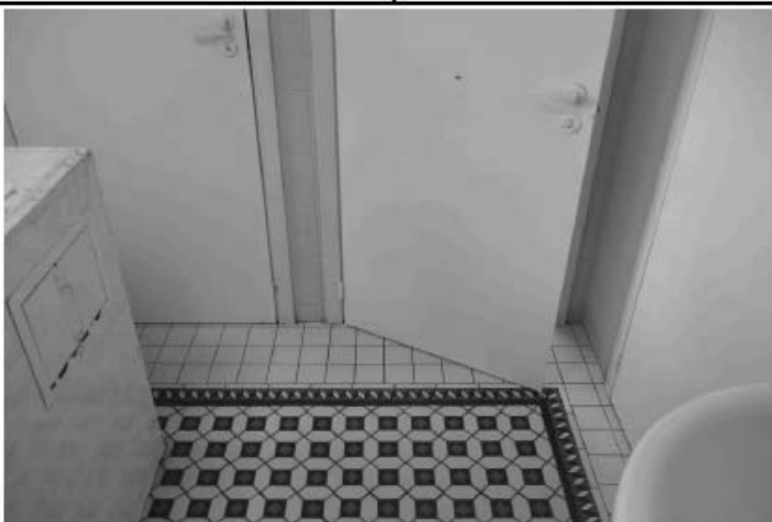
22. Фрагмент пом. 70-Н (7) в уровне 1-го этажа.
