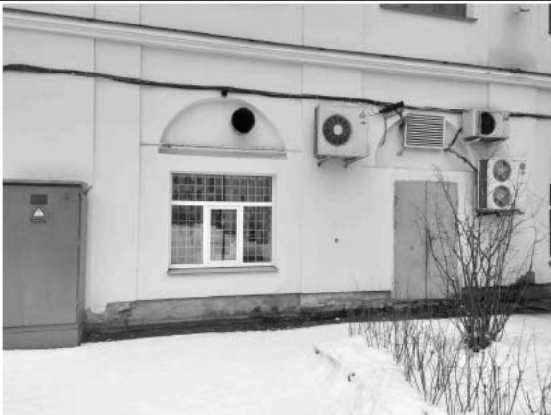
15. Фрагмент северного дворового фасада южного лицевого корпуса объекта культурного наследия. Замена оконного заполнения.
