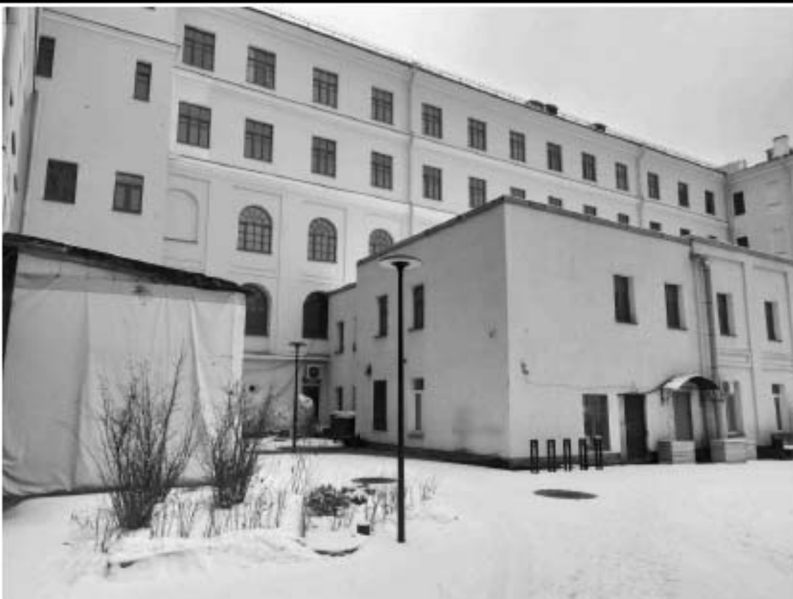
7. Фрагмент восточного дворового фасада западного лицевого корпуса здания объекта культурного наследия.
