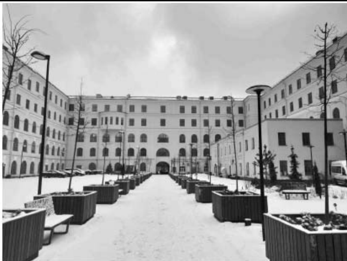
11. Общий вид северного дворового фасада южного лицевого корпуса объекта культурного наследия.
