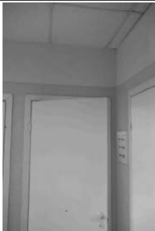
21. Фрагмент пом. 70-Н (7) в уровне 1-го этажа.
