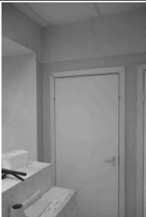
20. Фрагмент пом. 70-Н (7) в уровне 1-го этажа.
