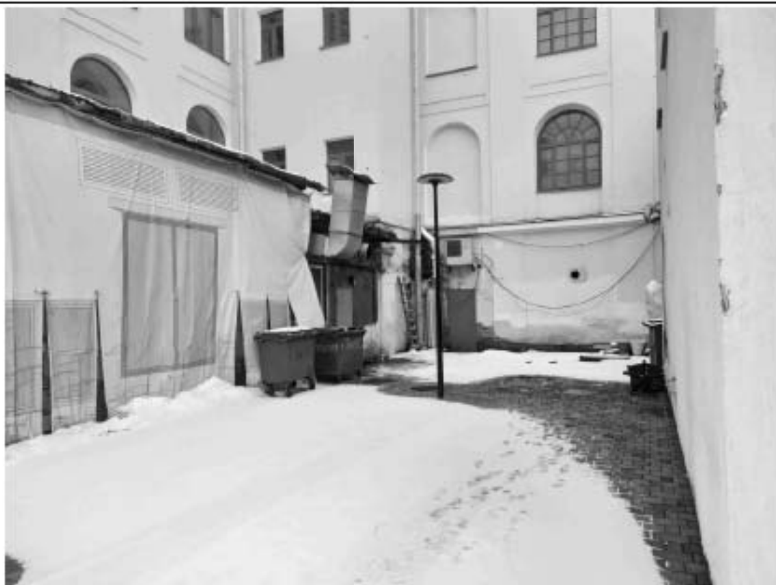
14. Фрагмент поздней пристройки (тепловой пункт) к северному дворовому фасаду южного лицевого корпуса объекта культурного наследия.
