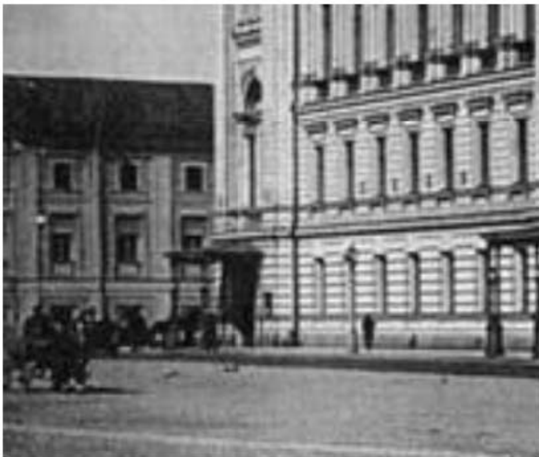
20. Петербургская консерватория (Театральная пл., 3). Фото 1903 г. Фрагмент южного лицевого фасада здания Главного Кригс-комиссариата.
