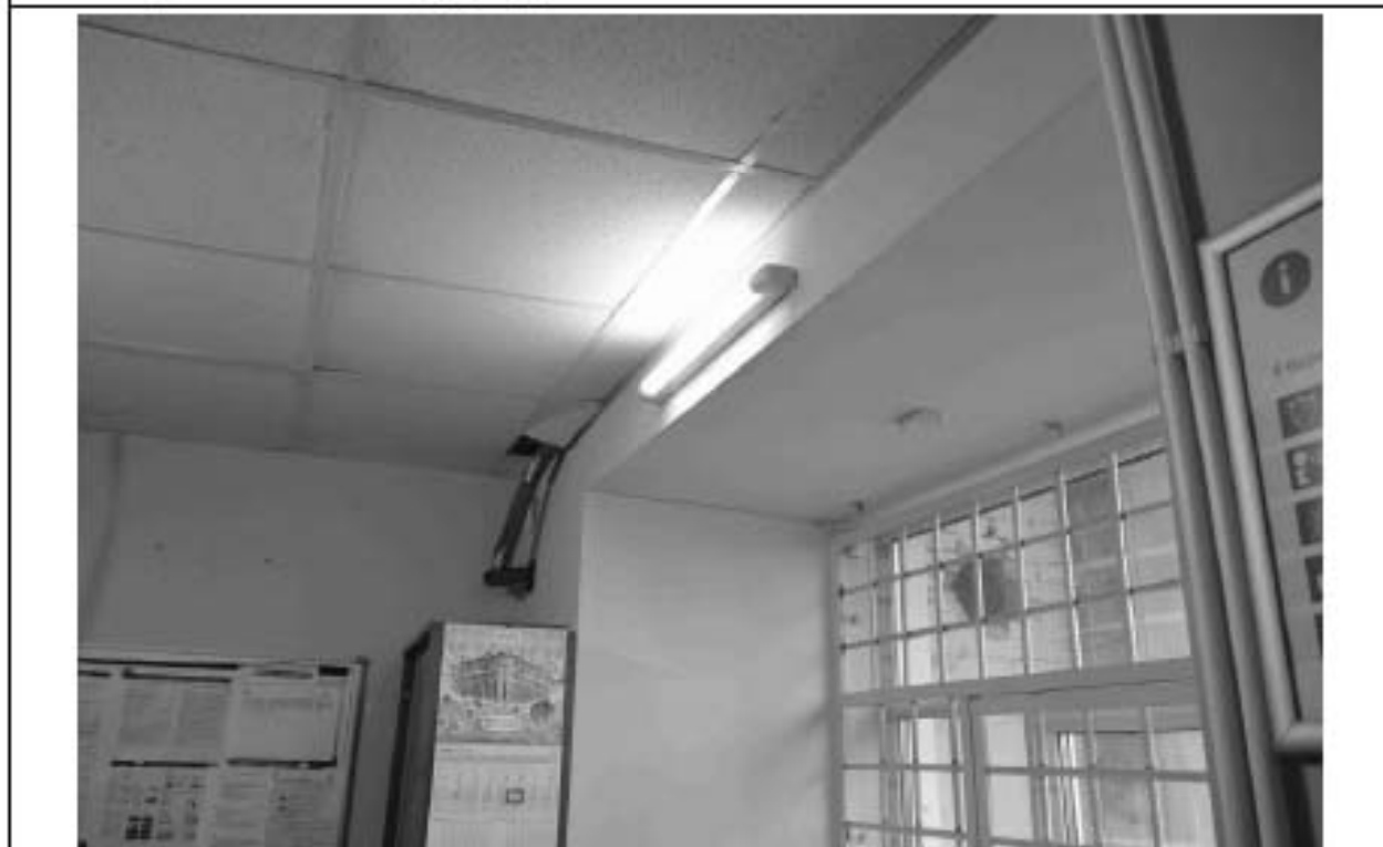
26. Фрагмент пом. 70-Н (12) в уровне 1-го этажа.
