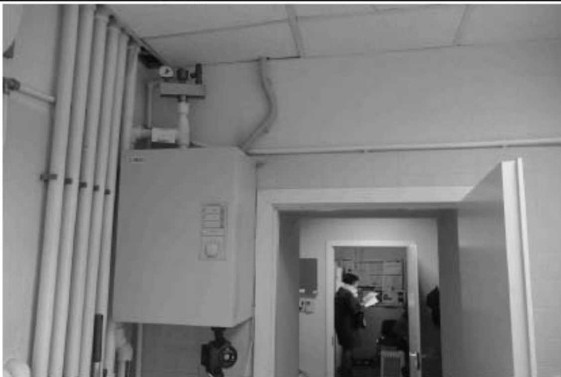
24. Фрагмент пом. 70-Н (7) в уровне 1-го этажа.
