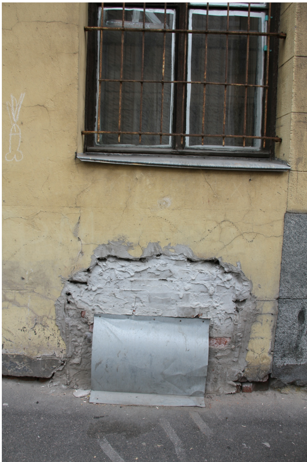
13. Дом Т.П. Павловой. Конная ул., 8, литера А. Лицевой фасад. Фрагмент. Оконный проем на месте исторической витрины. фото: 17.05.2021.
