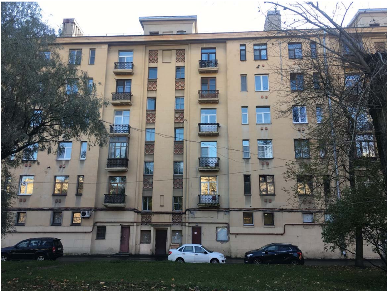
Фото №3. Дворовый фасад. Входы в помещение №№ 3-Н, 10-Н, 11-Н и в подвал. Оконные заполнения металлопластиковые со стеклопакетами, дверные заполнения – металлические.
