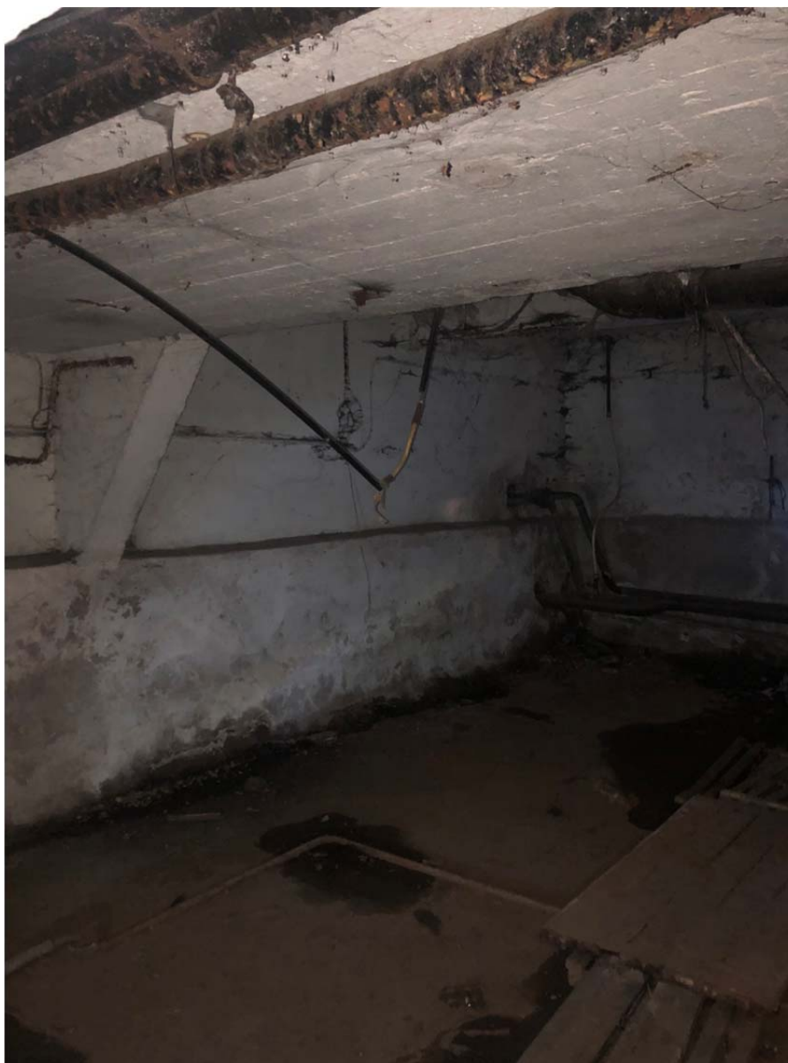
Фото №16. Помещение подвала.
