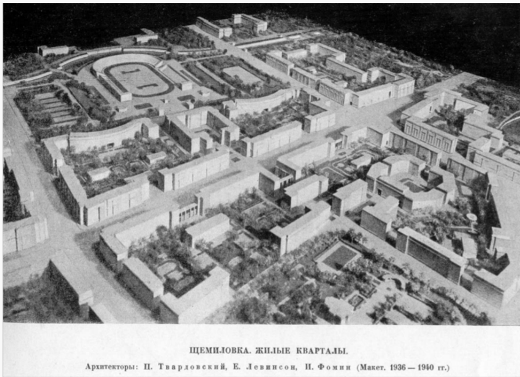
Илл. 4. Щемилловка. Жилые кварталы. Архитекторы: П. Твардовский, Е. Левинсон, И. Фомин (макет, 1936-1940 гг.). Источник: «Ленинград. Архитектурно-планировочный обзор развития города». Под ред. Н. В. Баранова, В. А. Каменского и др. М.-Л., «Искусство», 1943 г.
