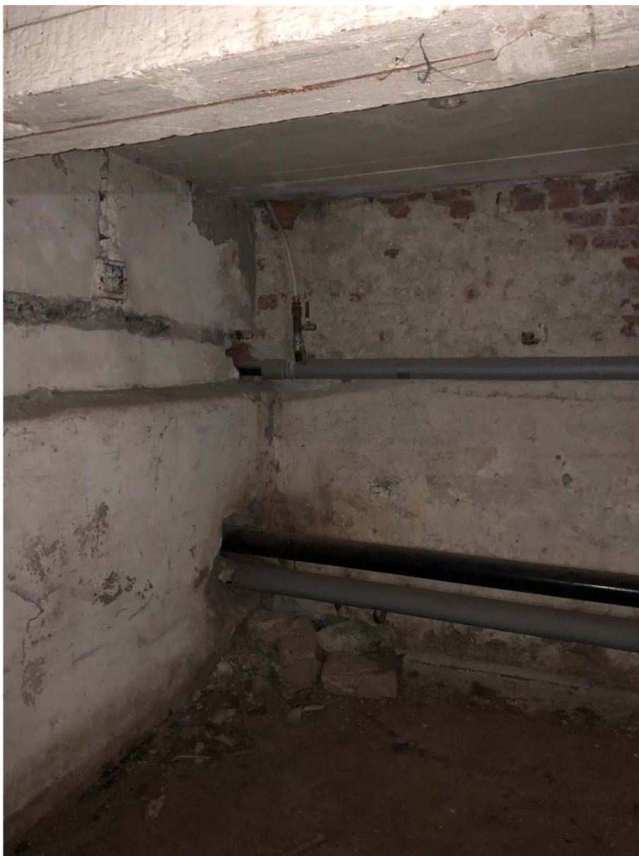
Фото №15. Помещение подвала.
