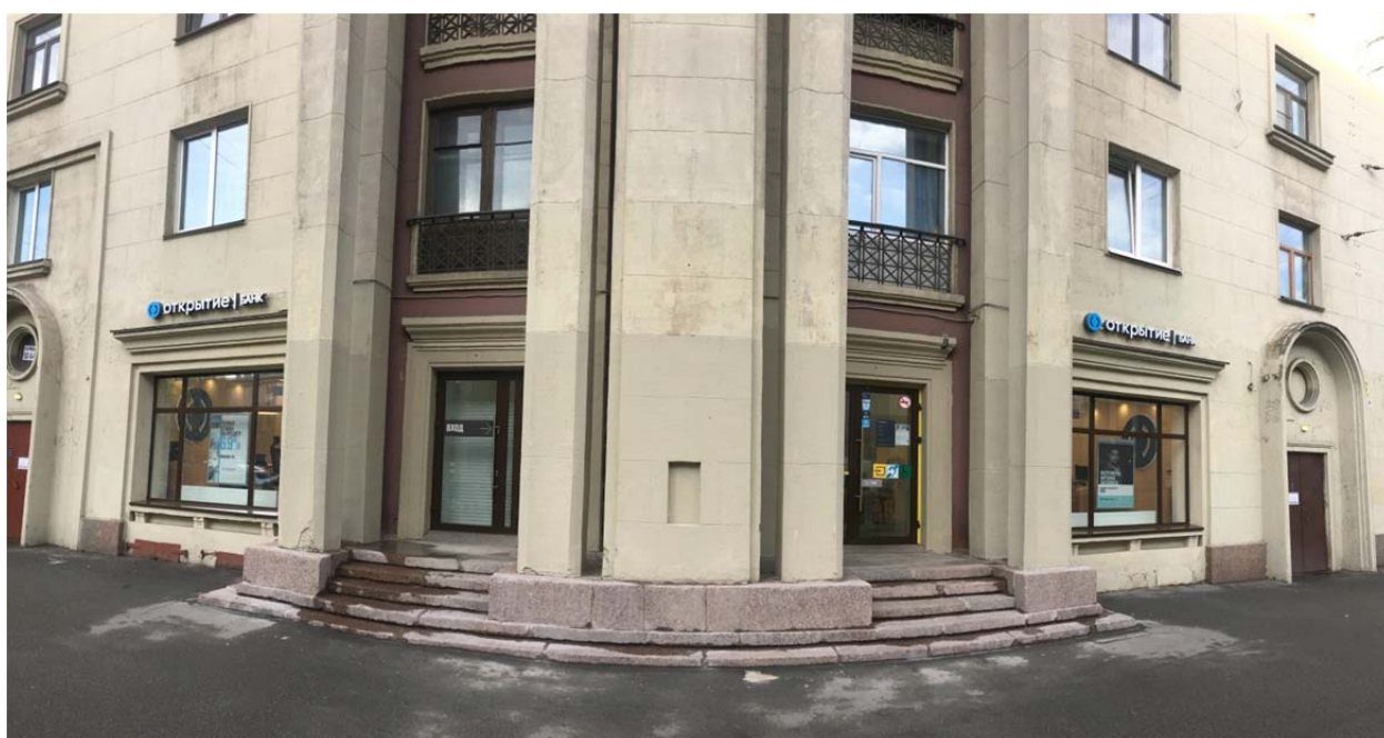
Фото №2. Лицевой фасад по улице Ивановской, вход в помещение №3-Н. Заполнения витринных окон выполнены из металлопластиковых профилей со стеклопакетами.
