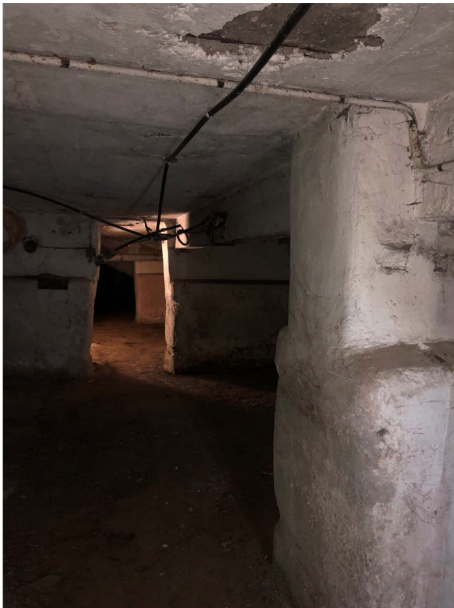
Фото №14. Помещение подвала.
