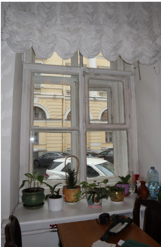
Фото 23. Окно в помещении 22.
