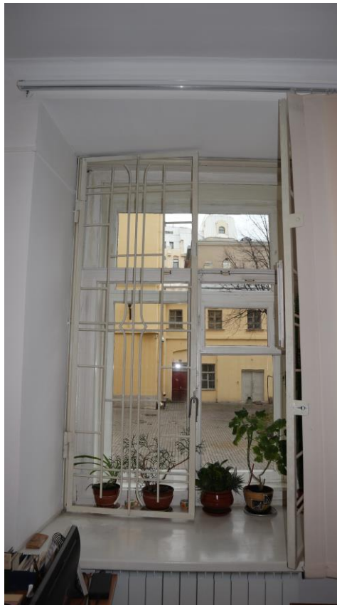
Фото 48. Окно в помещении 36
