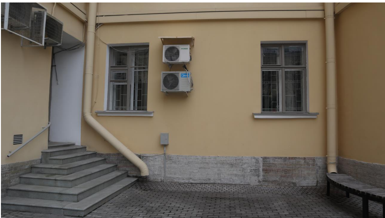
Фото 13. Окна по дворовому фасаду
