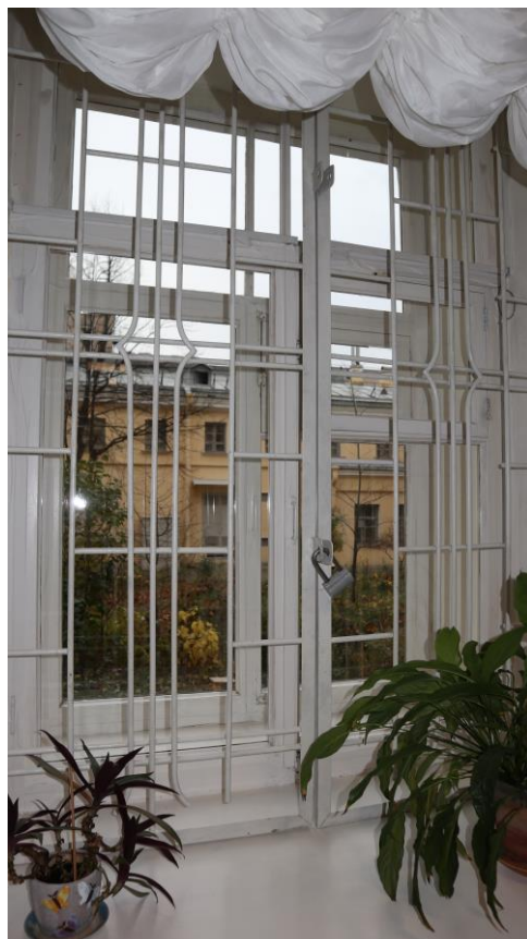
Фото 44. Окно в помещении 42
