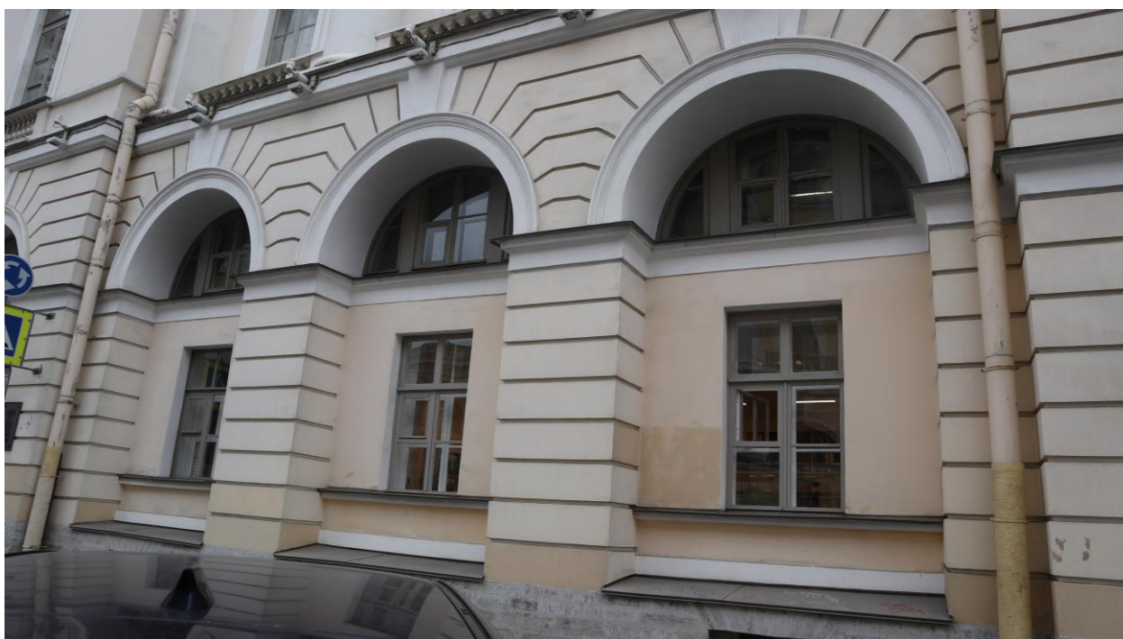
Фото 8. Окна по фасаду на ул. 3. Росси
