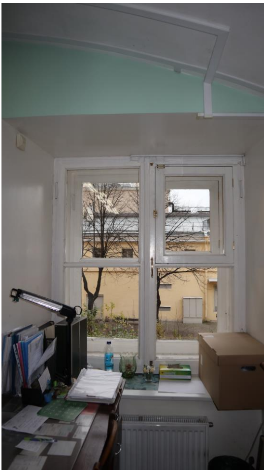
Фото 49. Окно в антресольном этаже, в помещении 45
