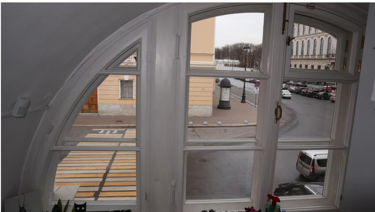
Фото 34. Окно в антресольном этаже в помещении 51
