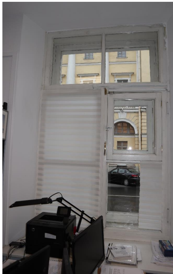
Фото 26. Окно в помещении 11.
