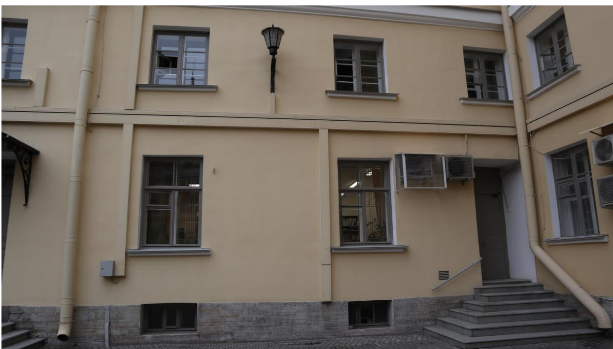
Фото 14. Окна по дворовому фасаду
