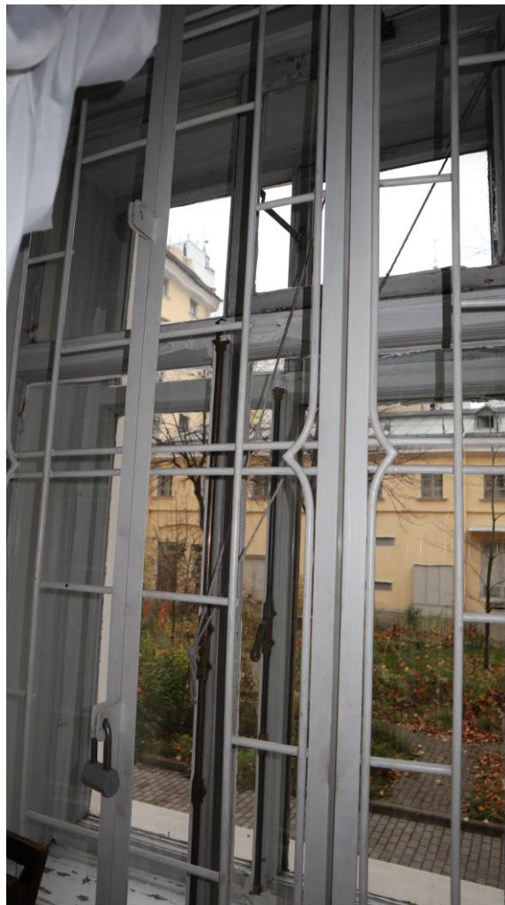
Фото 40. Окно в помещении 43
