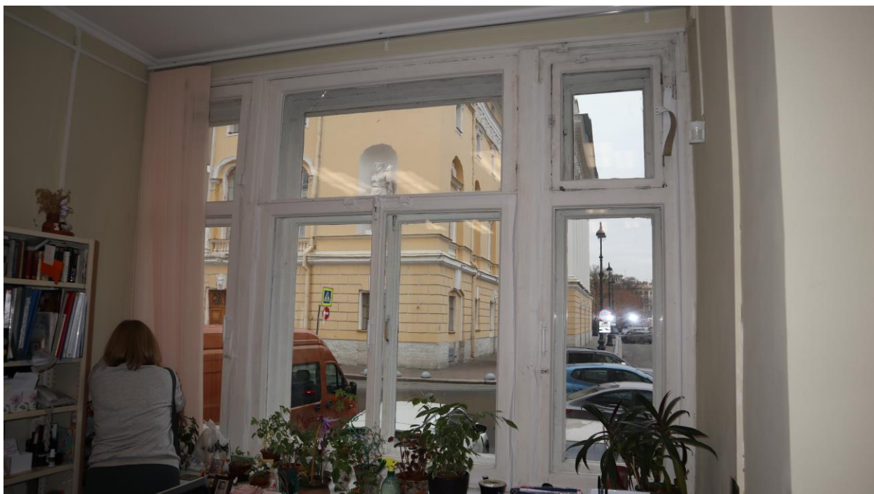
Фото 31. Окно в помещении 3
