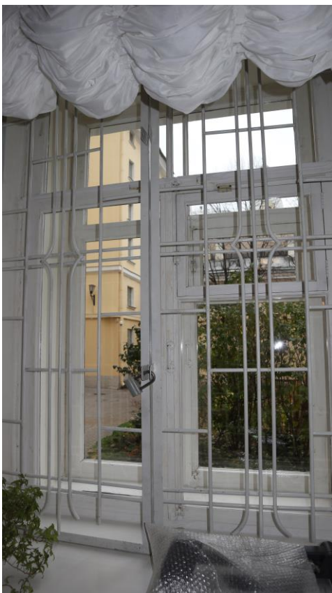
Фото 47. Окно в помещении 37
