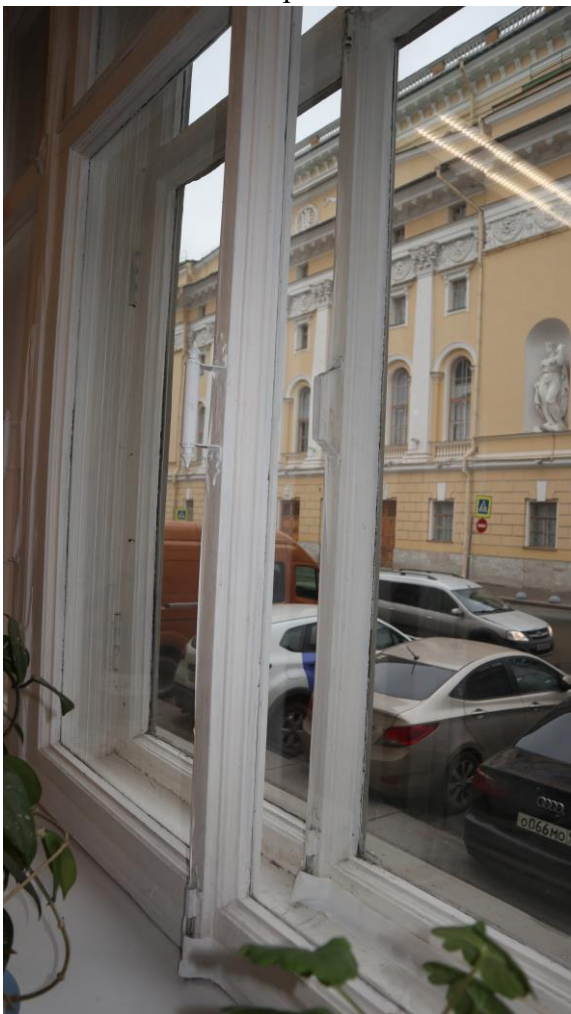
Фото 39. Окно в помещении 3
