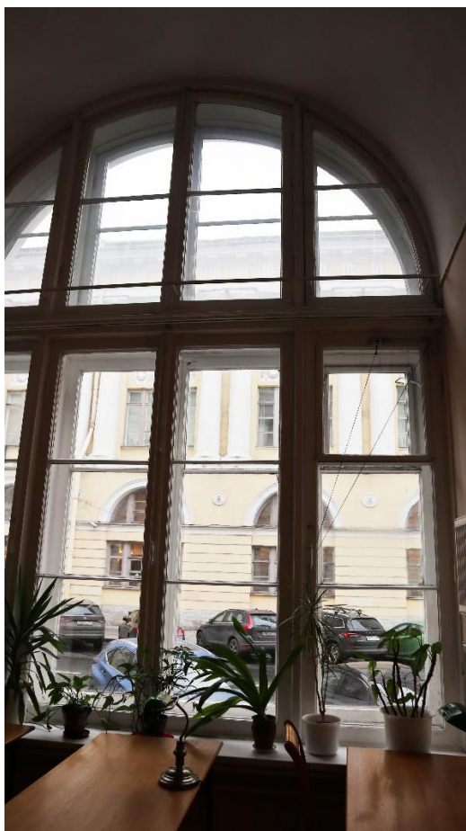
Фото 19. Окно в помещении 39
