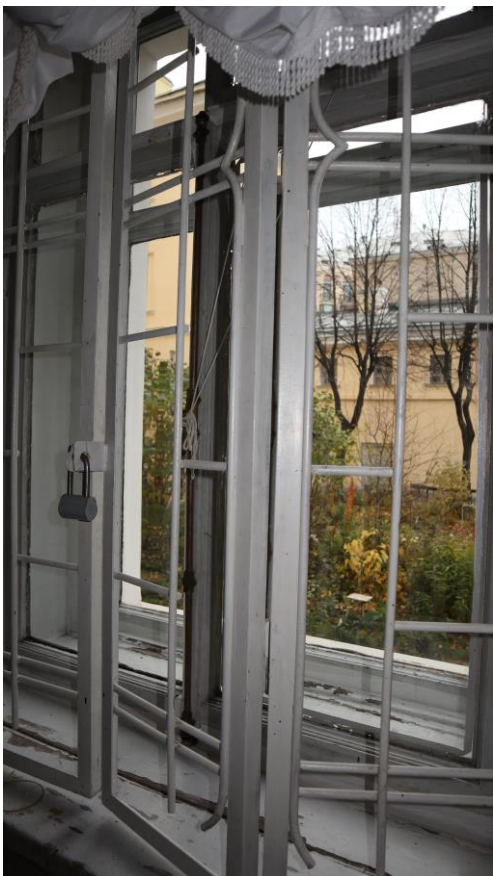
Фото 41. Окно в помещении 43
