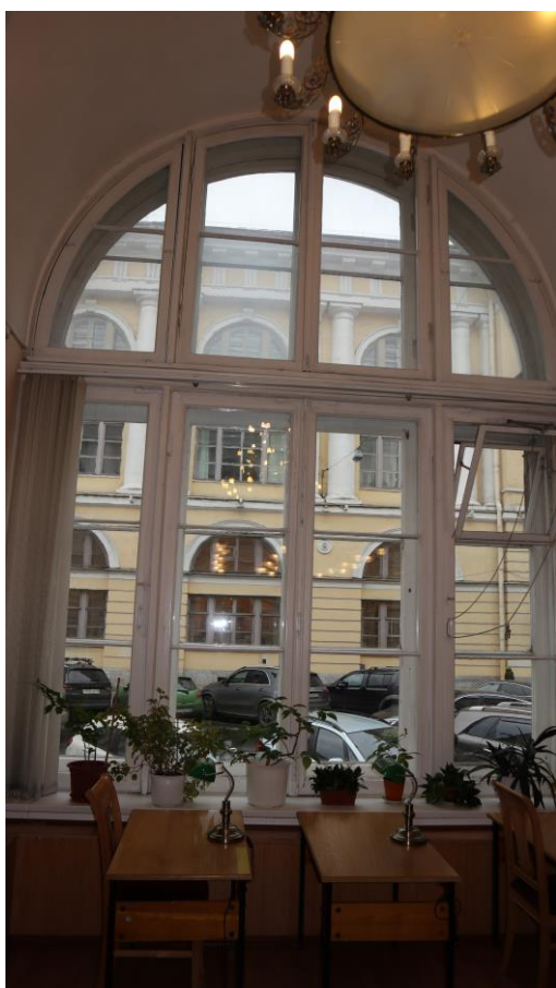
Фото 21. Окно в помещении 38.
