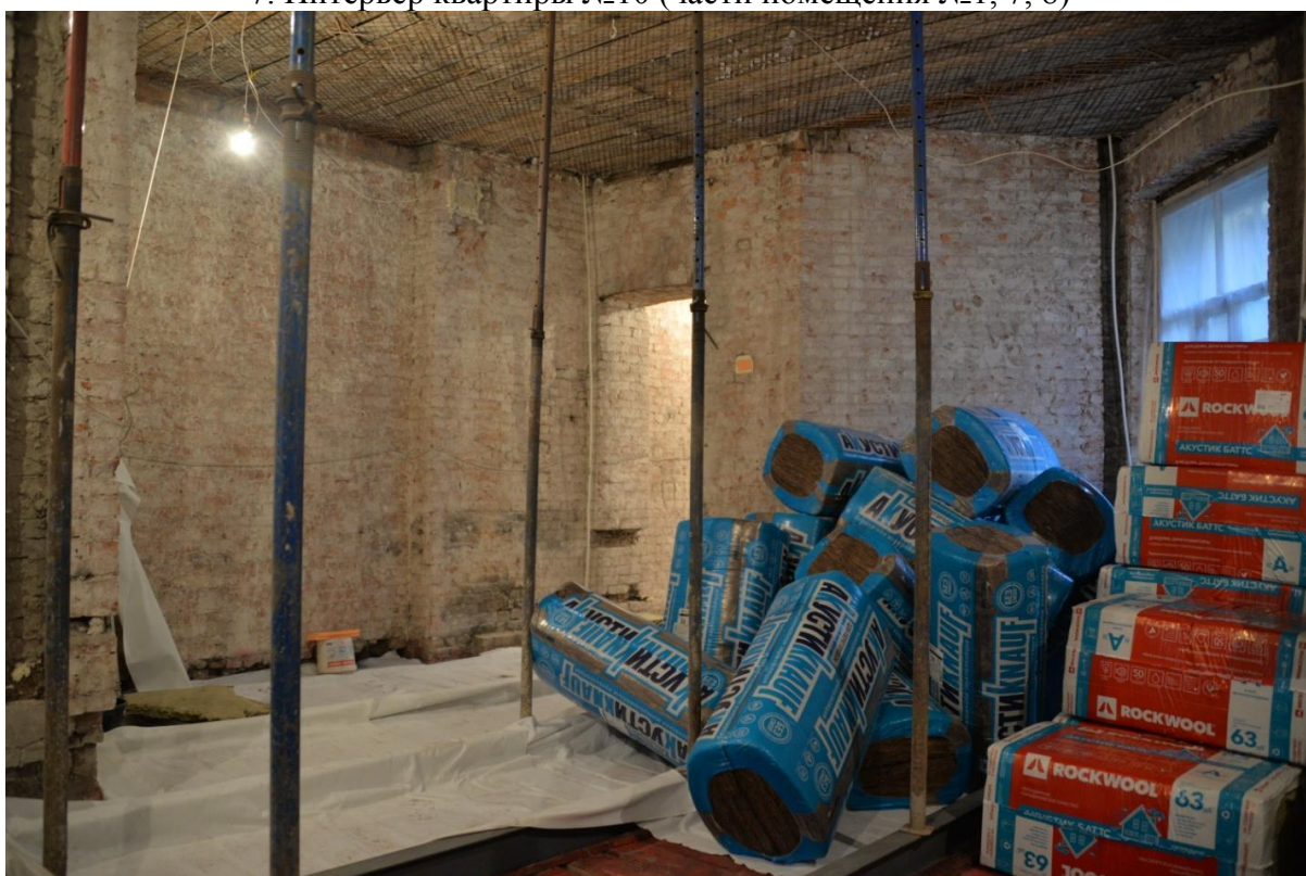
8. Интерьер квартиры №10 (части помещения №9, 11)
