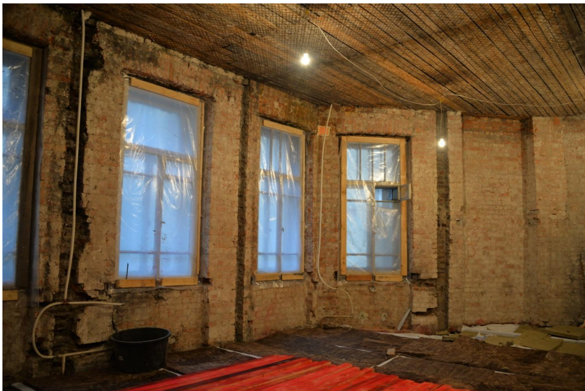
13. Интерьер квартиры №10 (части помещения №13, 14)
