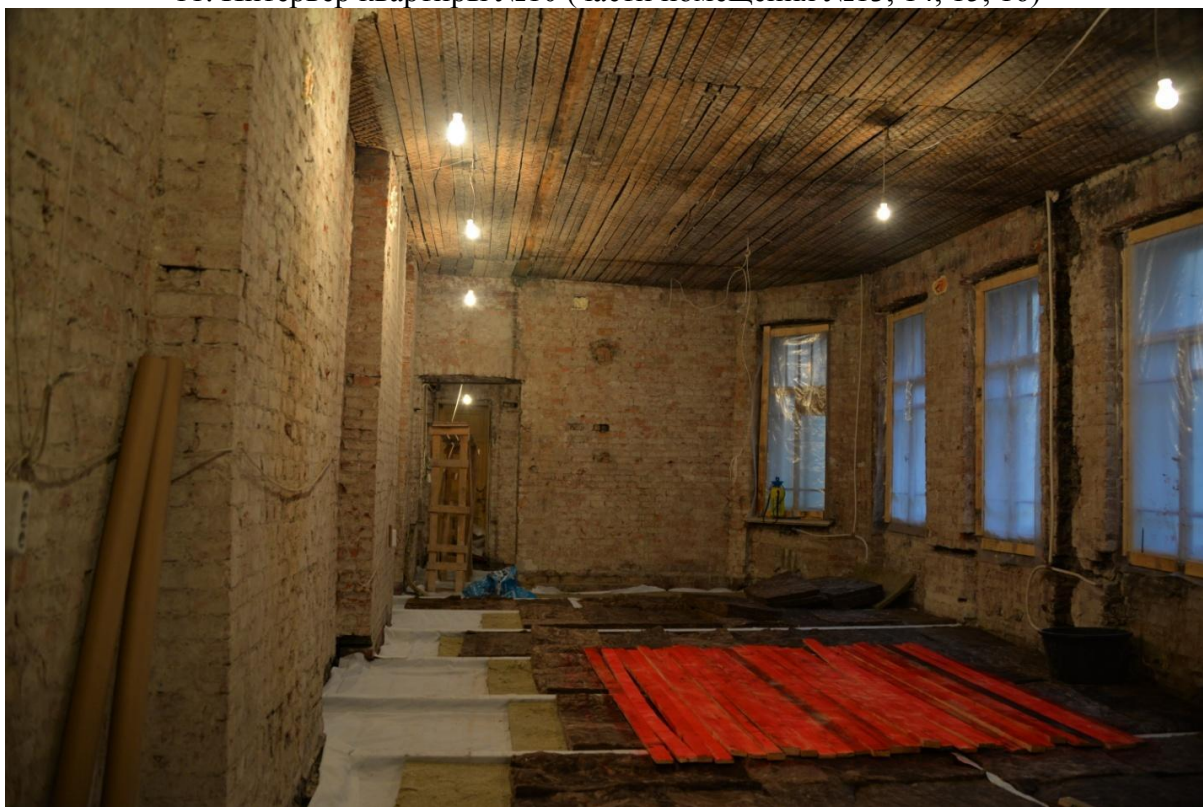
12. Интерьер квартиры №10 (части помещения №13, 14, 15, 16)
