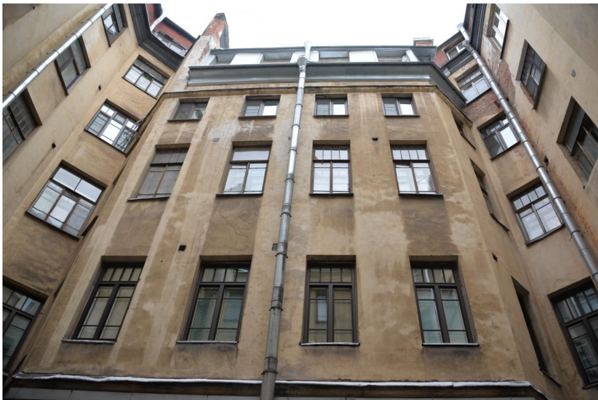
3. Фрагмент дворового фасада
