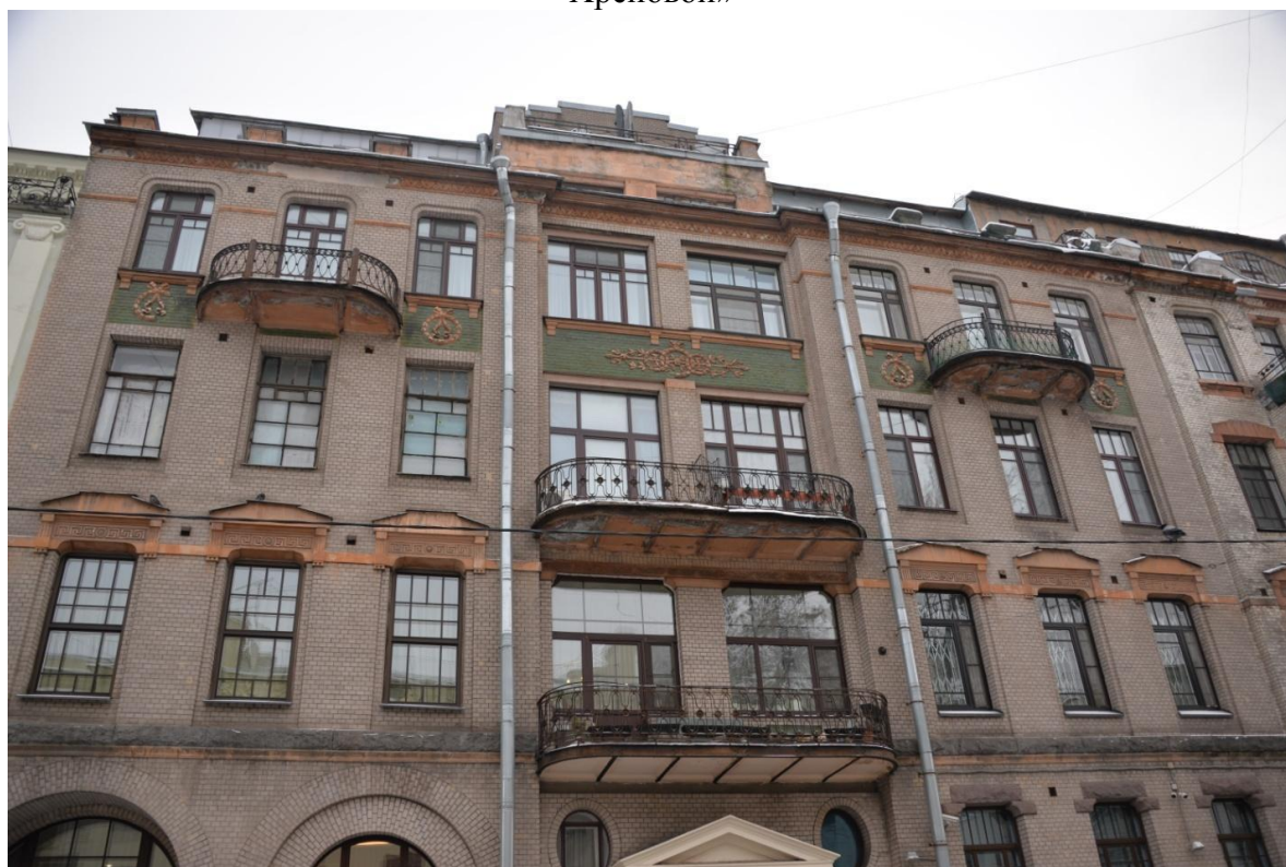
2. Фрагмент лицевого фасада объекта культурного наследия регионального значения «Дом И.Ф. Хреновой»
