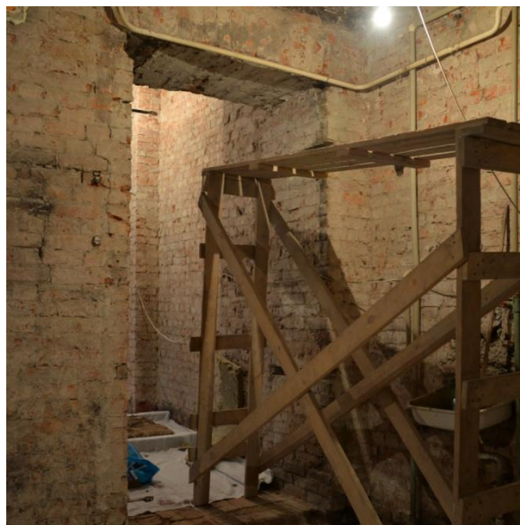
16. Дверной проем в квартире №10 (часть помещения 17)
