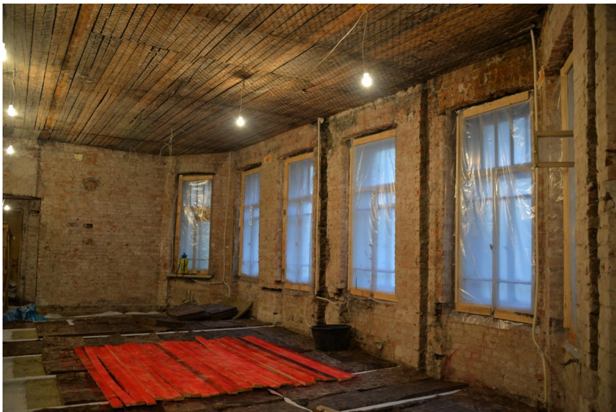
11. Интерьер квартиры №10 (части помещения №13, 14, 15, 16)
