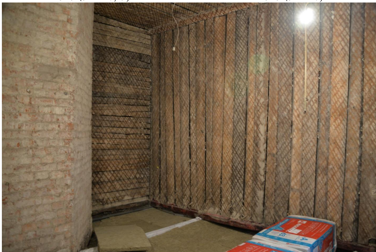
17. Интерьер квартиры №10 (части помещения №17)
