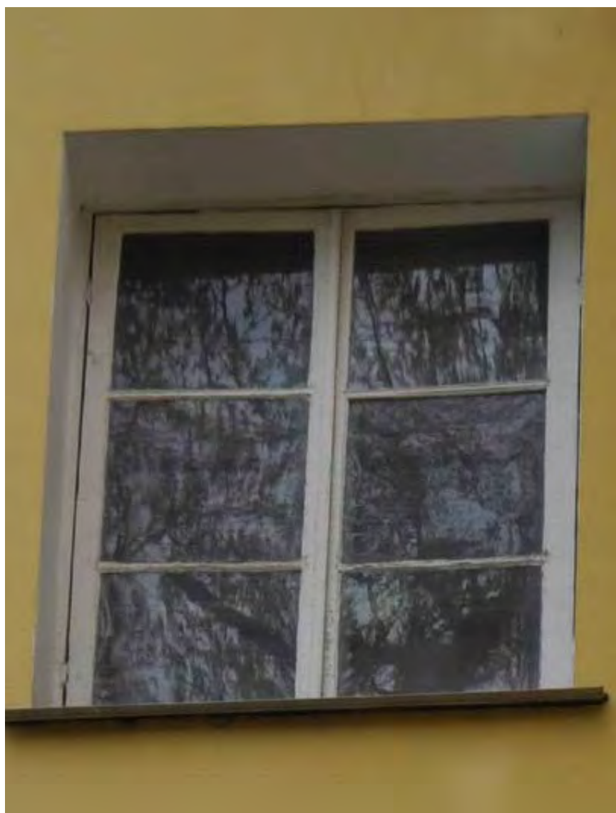
23. Оконное заполнение в уровне 2-ого этажа объекта культурного наследия федерального значения «Дворец Таврический. Дворец», расположенного по адресу: г. Санкт-Петербург, ул. Шпалерная, д. 47, лит. А. 15.12.2022
