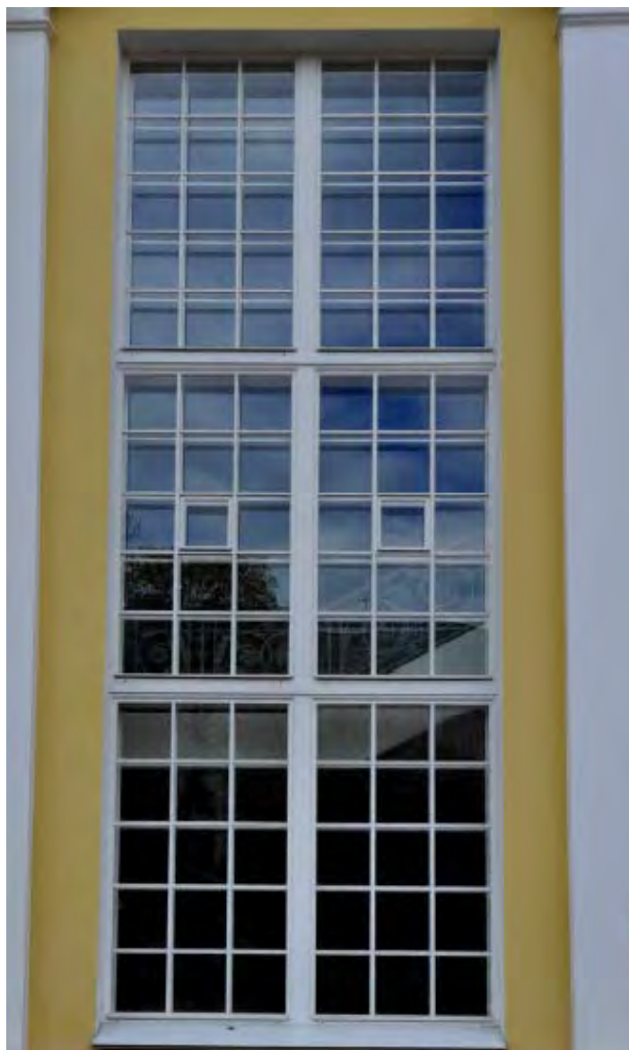
14. Оконное заполнение в уровне 1-ого этажа на дворовом фасаде объекта культурного наследия федерального значения «Дворец Таврический. Дворец», расположенного по адресу: г. Санкт-Петербург, ул. Шпалерная, д. 47, лит. А. 15.12.2022
