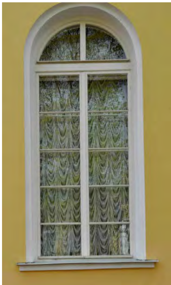
13. Оконное заполнение в уровне 1-ого этажа на дворовом фасаде объекта культурного наследия федерального значения «Дворец Таврический. Дворец», расположенного по адресу: г. Санкт-Петербург, ул. Шпалерная, д. 47, лит. А. 15.12.2022
