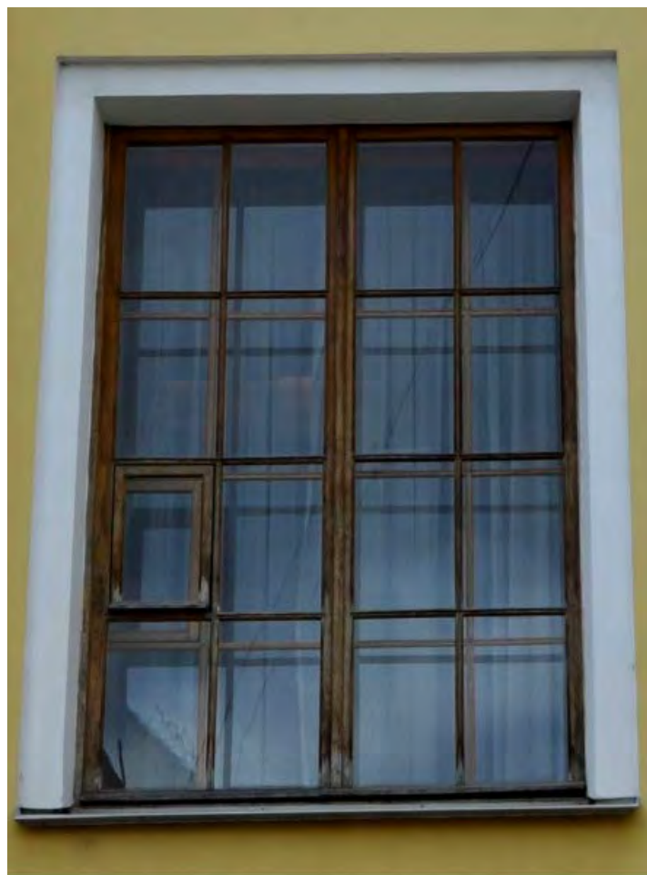
9. Оконное заполнение в уровне 1-ого этажа на дворовом фасаде объекта культурного наследия федерального значения «Дворец Таврический. Дворец», расположенного по адресу: г. Санкт-Петербург, ул. Шпалерная, д. 47, лит. А. 15.12.2022
