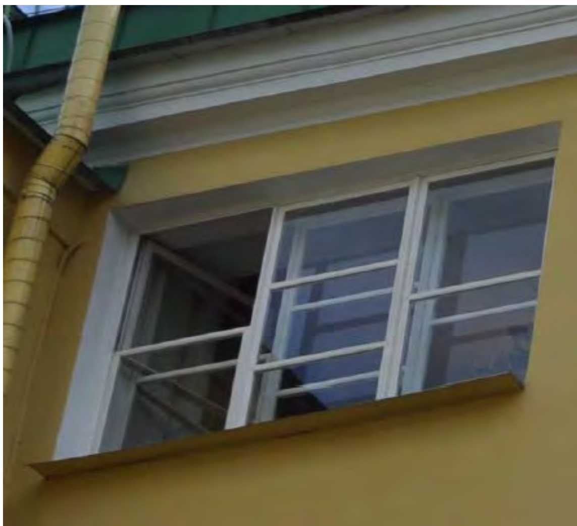
26. Оконное заполнение в уровне 2-ого этажа объекта культурного наследия федерального значения «Дворец Таврический. Дворец», расположенного по адресу: г. Санкт-Петербург, ул. Шпалерная, д. 47, лит. А. 15.12.2022
