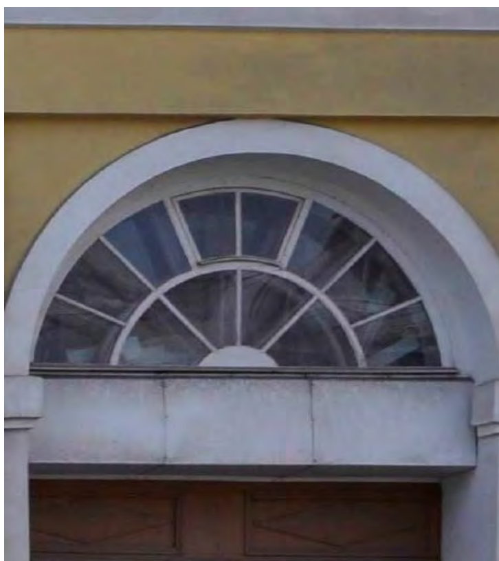
20. Оконное заполнение в уровне антресольного этажа объекта культурного наследия федерального значения «Дворец Таврический. Дворец», расположенного по адресу: г. Санкт-Петербург, ул. Шпалерная, д. 47, лит. А. 15.12.2022
