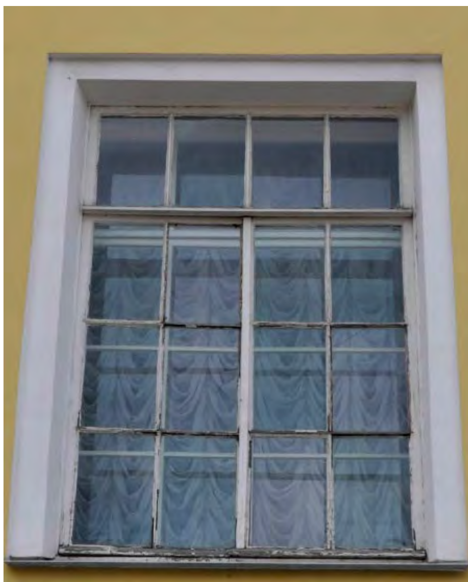
11. Оконное заполнение в уровне 1-ого этажа на дворовом фасаде объекта культурного наследия федерального значения «Дворец Таврический. Дворец», расположенного по адресу: г. Санкт-Петербург, ул. Шпалерная, д. 47, лит. А. 15.12.2022
