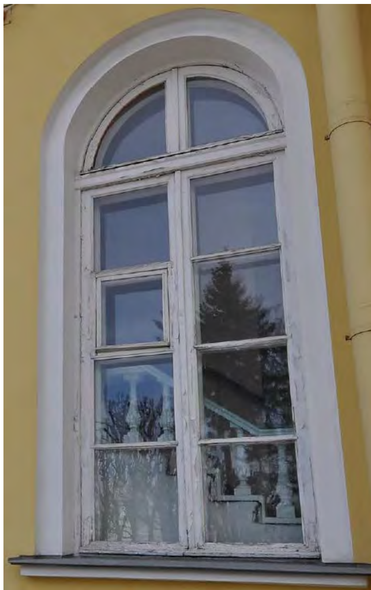
3. Оконное заполнение в уровне 1-ого этажа объекта культурного наследия федерального значения «Дворец Таврический. Дворец», расположенного по адресу: г. Санкт-Петербург, ул. Шпалерная, д. 47, лит. А. 15.12.2022
