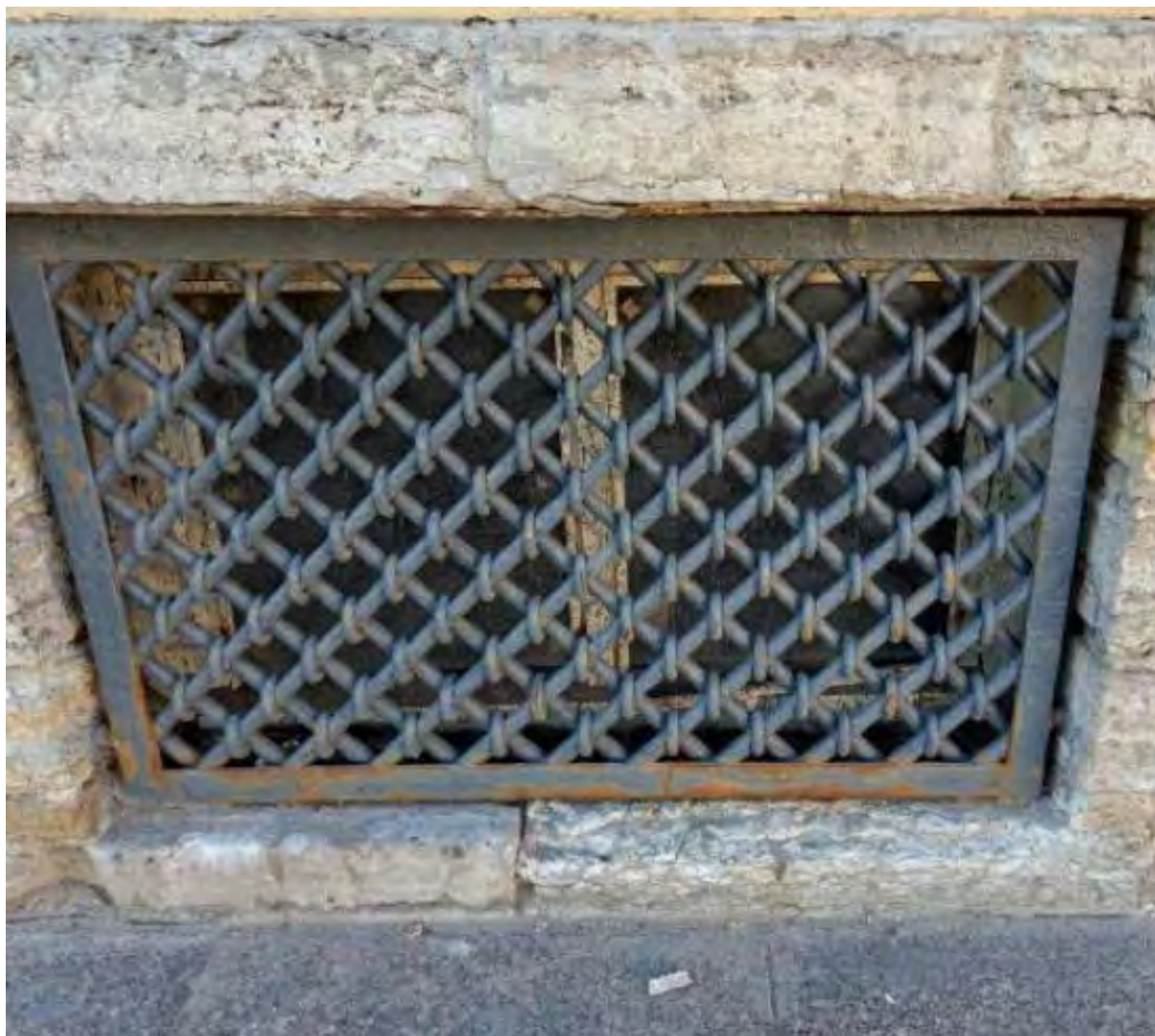
1. Оконное заполнение в уровне подвального этажа объекта культурного наследия федерального значения «Дворец Таврический. Дворец», расположенного по адресу: г. Санкт-Петербург, ул. Шпалерная, д. 47, лит. А. 15.12.2022
