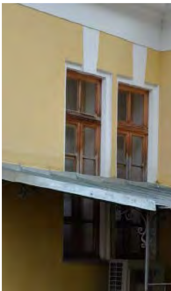
27. Оконное заполнение объекта культурного наследия федерального значения «Дворец Таврический. Флигель министерский (садовый)», расположенного по адресу: г. Санкт-Петербург, ул. Шпалерная, д. 47, лит. А. 15.12.2022
