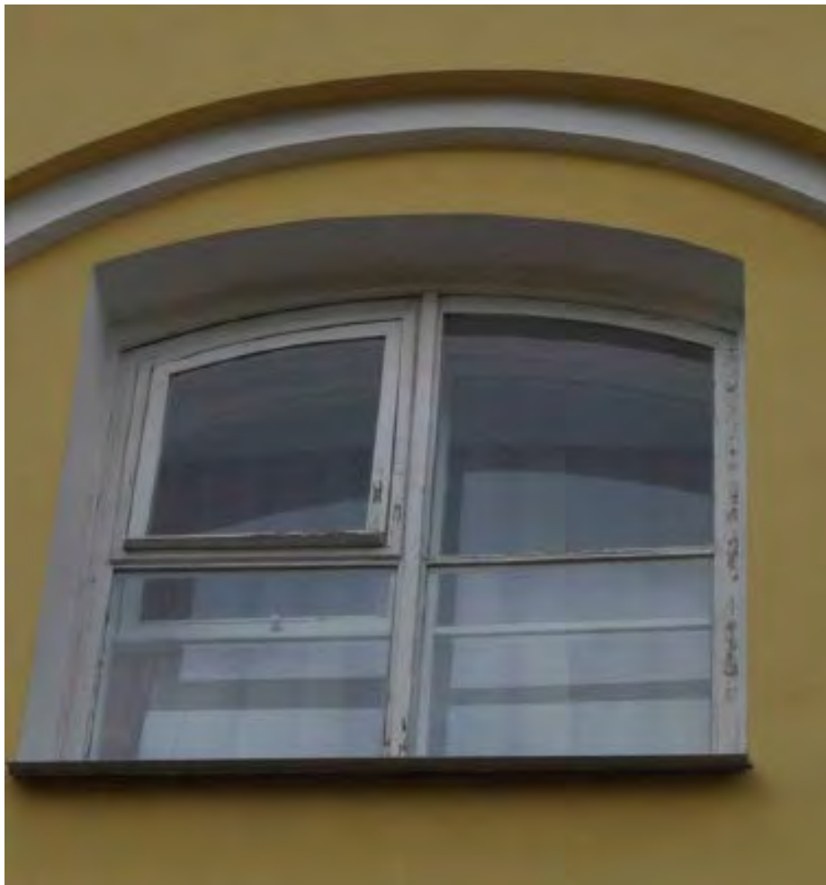
24. Оконное заполнение в уровне 2-ого этажа объекта культурного наследия федерального значения «Дворец Таврический. Дворец», расположенного по адресу: г. Санкт-Петербург, ул. Шпалерная, д. 47, лит. А. 15.12.2022
