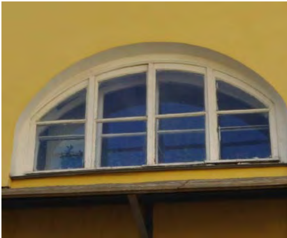
21. Оконное заполнение в уровне антресольного этажа объекта культурного наследия федерального значения «Дворец Таврический. Дворец», расположенного по адресу: г. Санкт-Петербург, ул. Шпалерная, д. 47, лит. А. 15.12.2022
