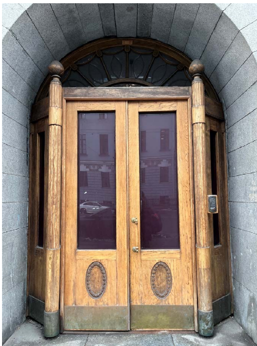
Фото №2. Лицевой фасад. Вход в общедомовую лестничную клетку.
