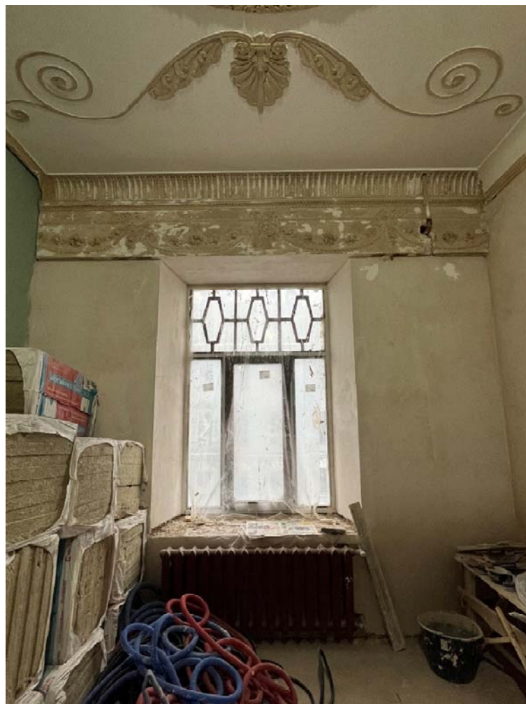
Фото №11. Квартира №45, отделка потолка.
