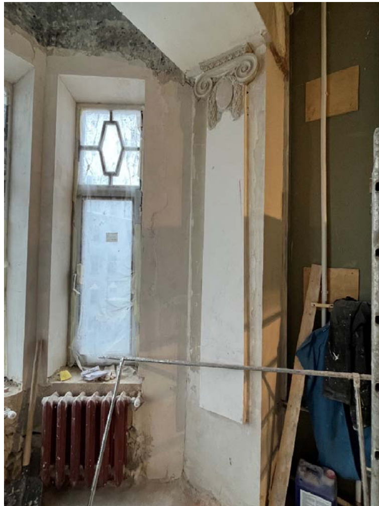
Фото №9. Квартира №45, отделка стен эркера, пилястра с капителью.
