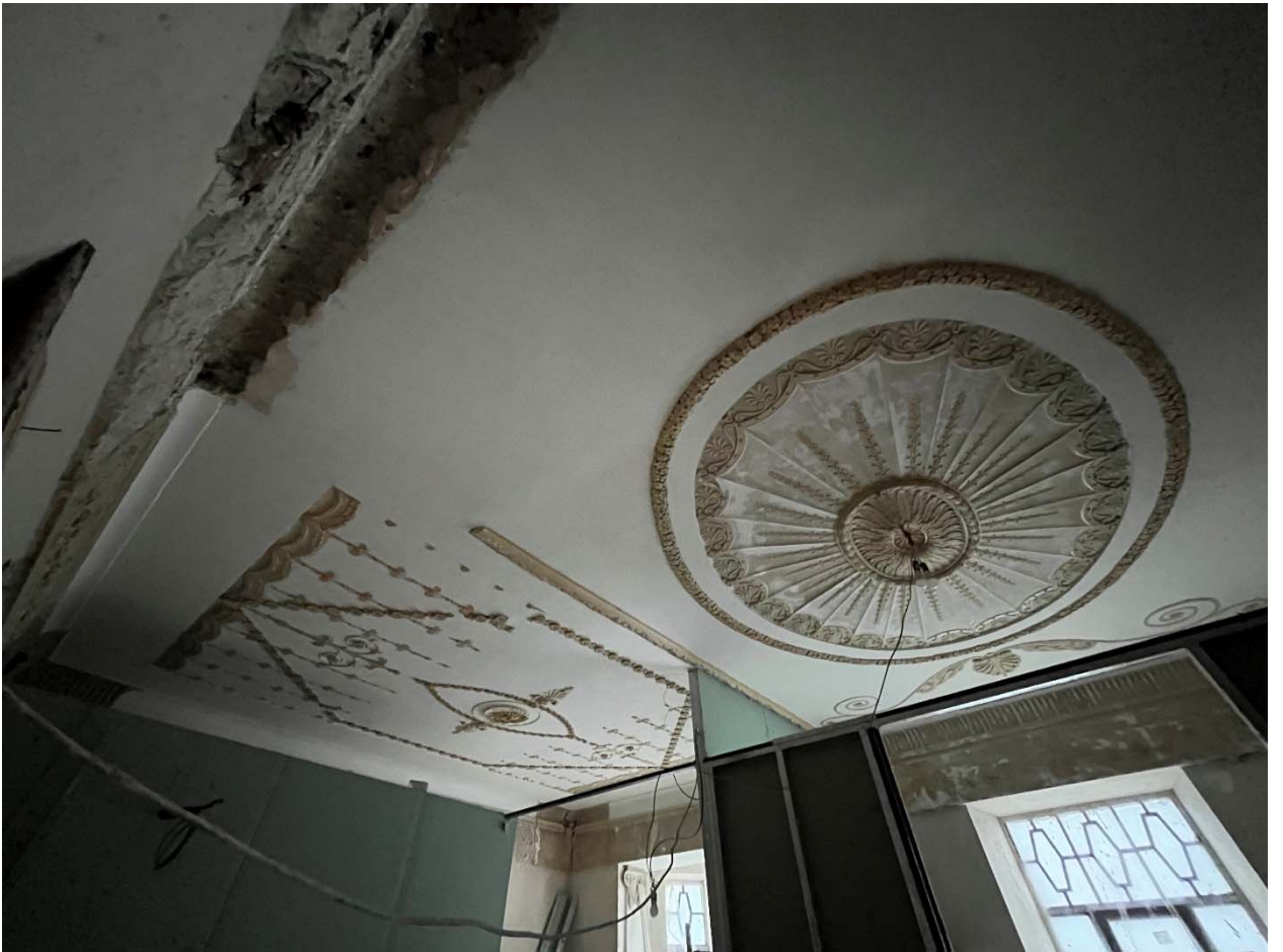
Фото №5. Квартира №45, отделка потолка.
