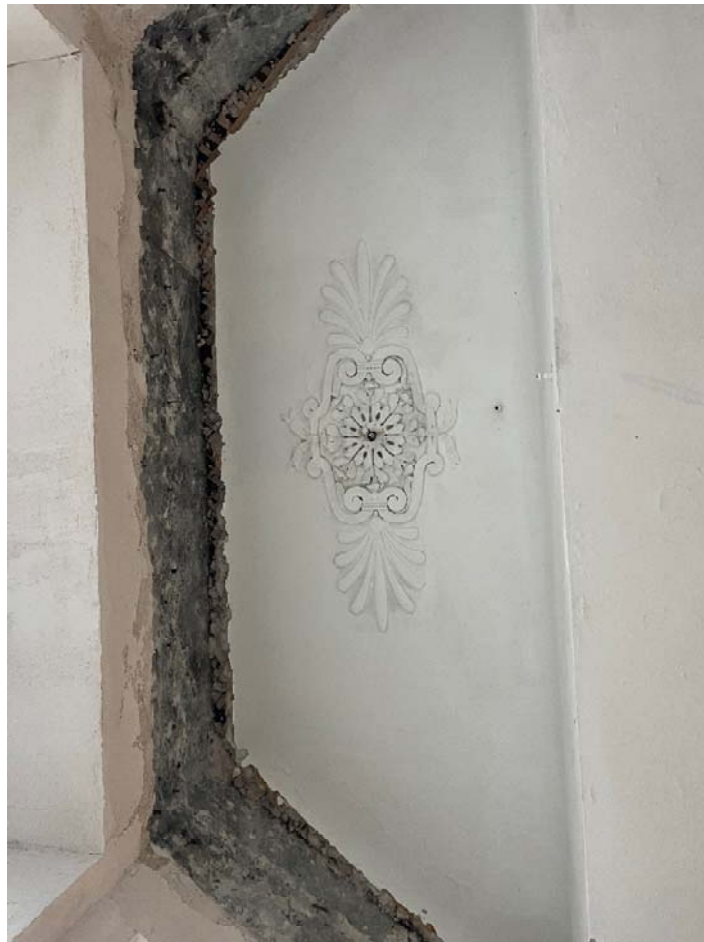
Фото №12. Квартира №45, отделка потолка эркера.
