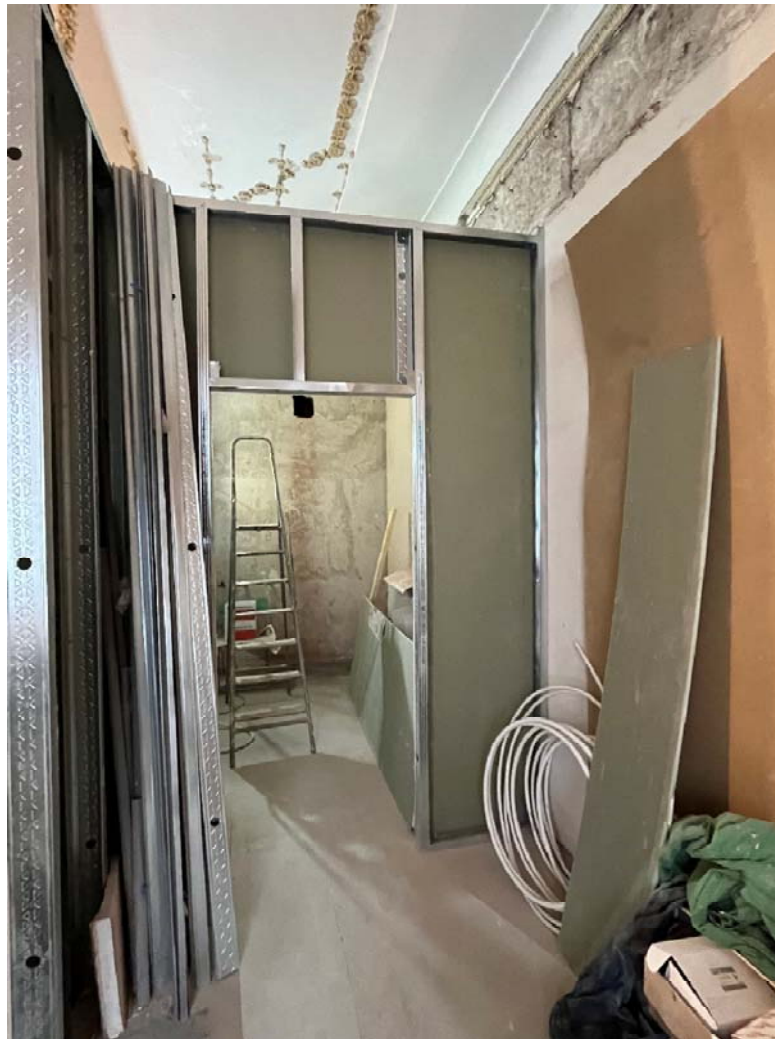
Фото №8. Квартира №45, перегородки из ГКЛ.
