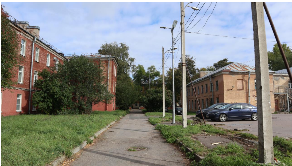
Фото 13. Вид на территорию объекта культурного наследия между зданием по адресу: Санкт-Петербург, г. Кронштадт, ул. Флотская д. 12а, литера А (справа) и объектом культурного наследия (слева).
