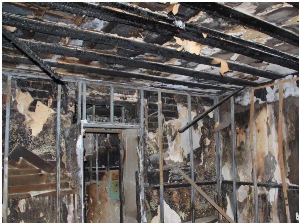
44. Объект культурного наследия регионального значения «Жилой дом», входящий в состав объекта культурного наследия регионального значения «Дача Сиверса (Кировский городок)», расположенный по адресу: Санкт-Петербург, Кировский район, пр. Стачек, д. 172, литера А. Помещение первого этажа. Фрагмент интерьера.
