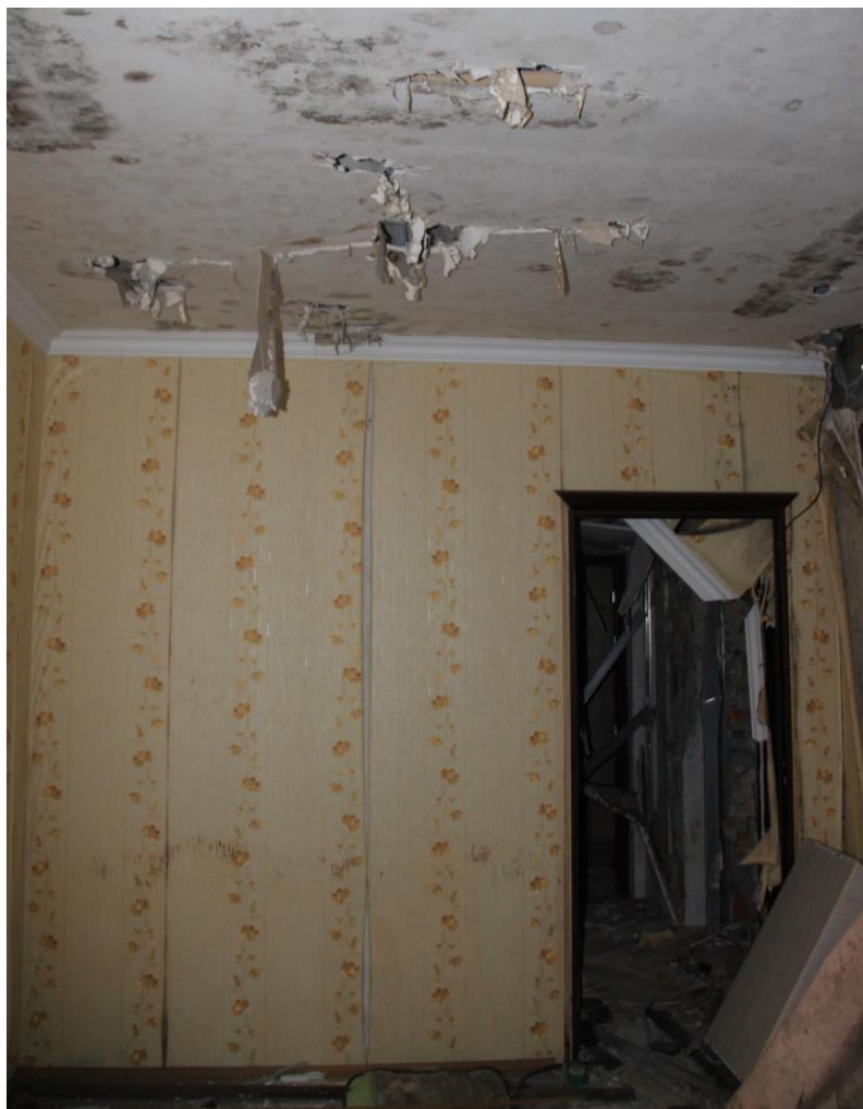
47. Объект культурного наследия регионального значения «Жилой дом», входящий в состав объекта культурного наследия регионального значения «Дача Сиверса (Кировский городок)», расположенный по адресу: Санкт-Петербург, Кировский район, пр. Стачек, д. 172, литера А. Помещение первого этажа. Фрагмент интерьера.
