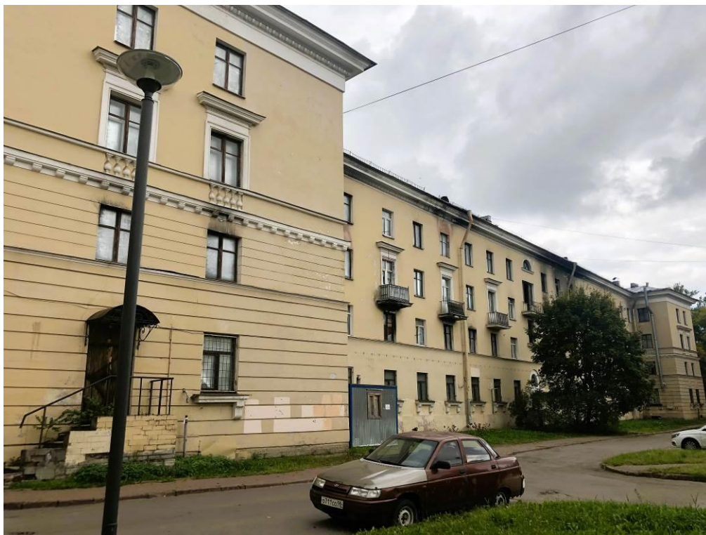
5. Объект культурного наследия регионального значения «Жилой дом», входящий в состав объекта культурного наследия регионального значения «Дача Сиверса (Кировский городок)», расположенный по адресу: Санкт-Петербург, Кировский район, пр. Стачек, д. 172, литера А. Общий вид в направлении проспекта Стачек. Дворовый фасад.
