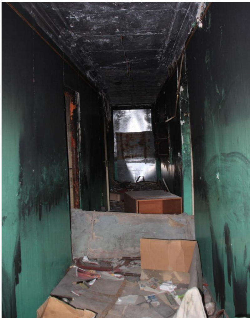
58. Объект культурного наследия регионального значения «Жилой дом», входящий в состав объекта культурного наследия регионального значения «Дача Сиверса (Кировский городок)», расположенный по адресу: Санкт-Петербург, Кировский район, пр. Стачек, д. 172, литера А. Помещение второго этажа. Фрагмент интерьера.
