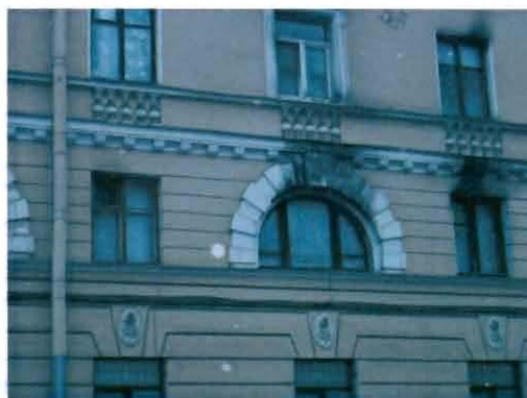
12. Оконные проемы второго этажа.
