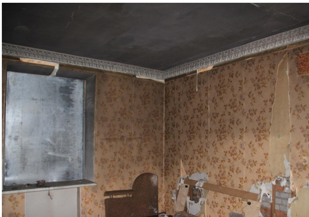
86. Объект культурного наследия регионального значения «Жилой дом», входящий в состав объекта культурного наследия регионального значения «Дача Сиверса (Кировский городок)», расположенный по адресу: Санкт-Петербург, Кировский район, пр. Стачек, д. 172, литера А. Помещение второго этажа. Фрагмент интерьера.
