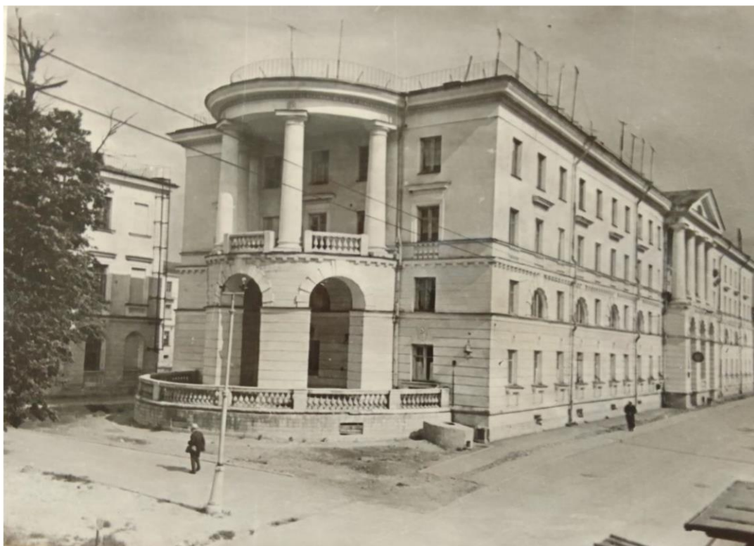
8. Общий вид дома №158 на проспекте Стачек (г. Ленинград). Фотография. 1957 г. Автор съёмки: Логинов В.И. ЦГАКФФД СПб. Ар-82357.
