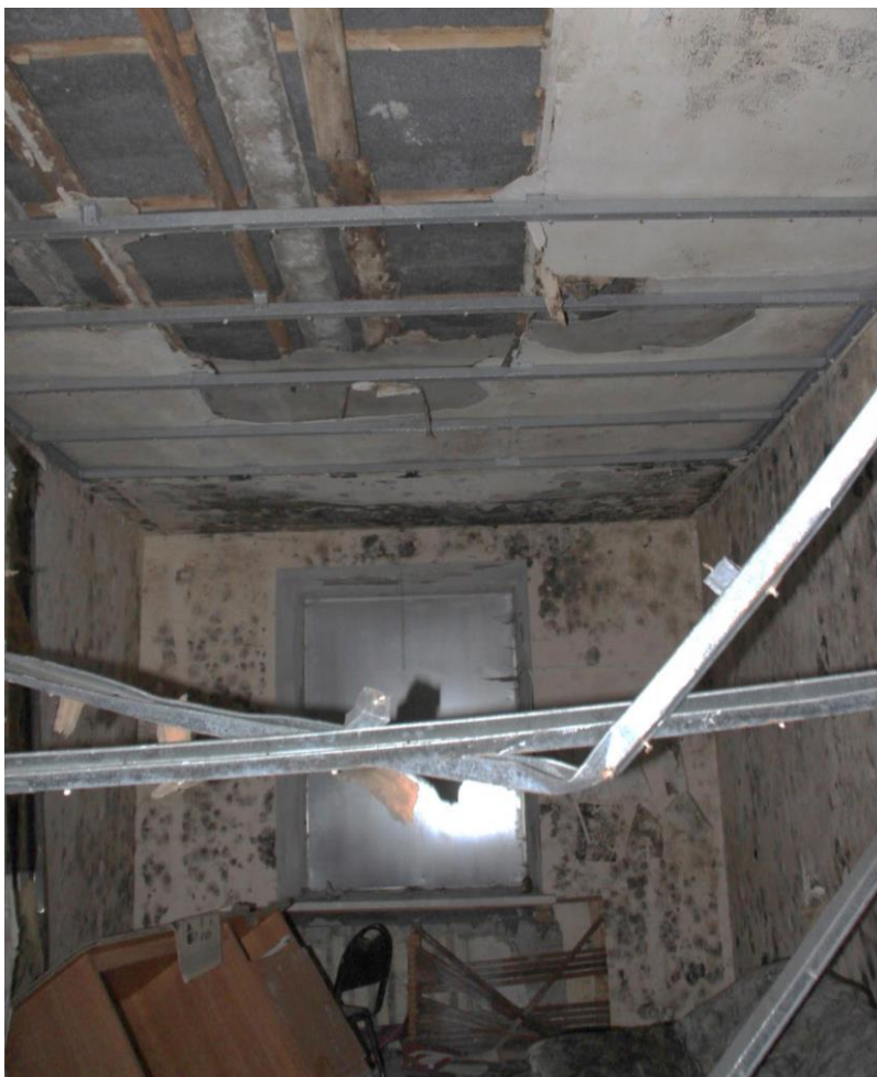
45. Объект культурного наследия регионального значения «Жилой дом», входящий в состав объекта культурного наследия регионального значения «Дача Сиверса (Кировский городок)», расположенный по адресу: Санкт-Петербург, Кировский район, пр. Стачек, д. 172, литера А. Помещение первого этажа. Фрагмент интерьера.
