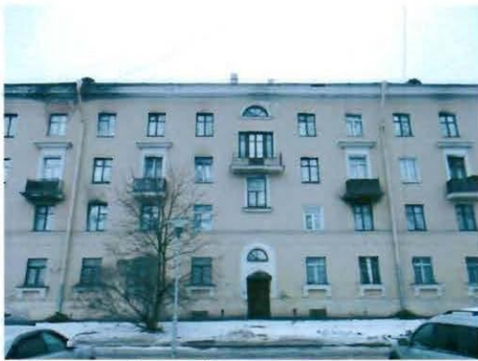
5. Фрагмент фасада. Вид с северо-востока.
