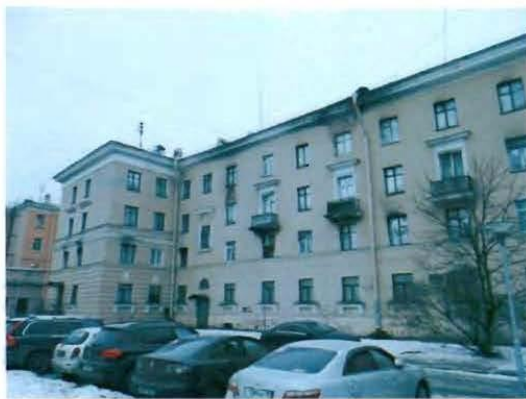
7. Фрагмент фасада. Вид с севера.
