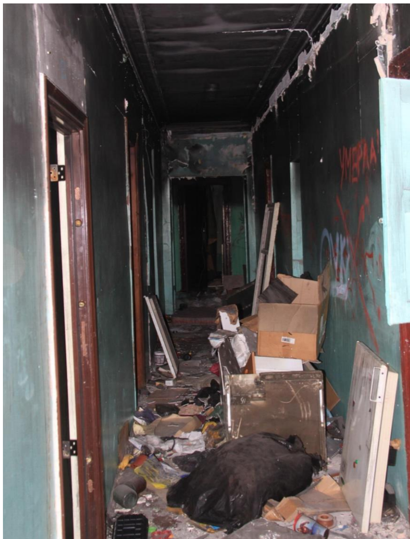
113. Объект культурного наследия регионального значения «Жилой дом», входящий в состав объекта культурного наследия регионального значения «Дача Сиверса (Кировский городок)», расположенный по адресу: Санкт-Петербург, Кировский район, пр. Стачек, д. 172, литера А. Помещение четвертого этажа. Коридор. Фрагмент интерьера.
