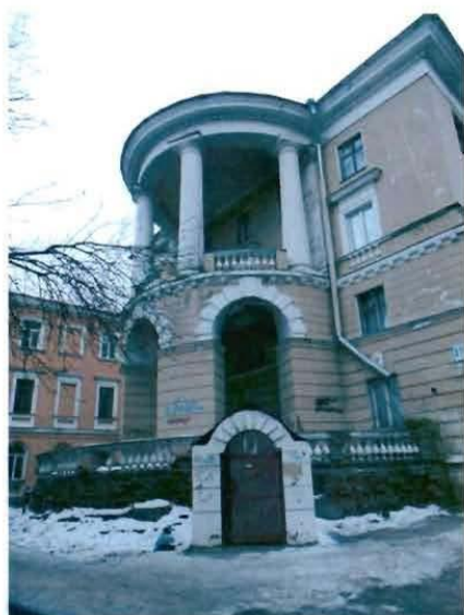
9. Полуциркульный ризалит с балконом и террасой.
