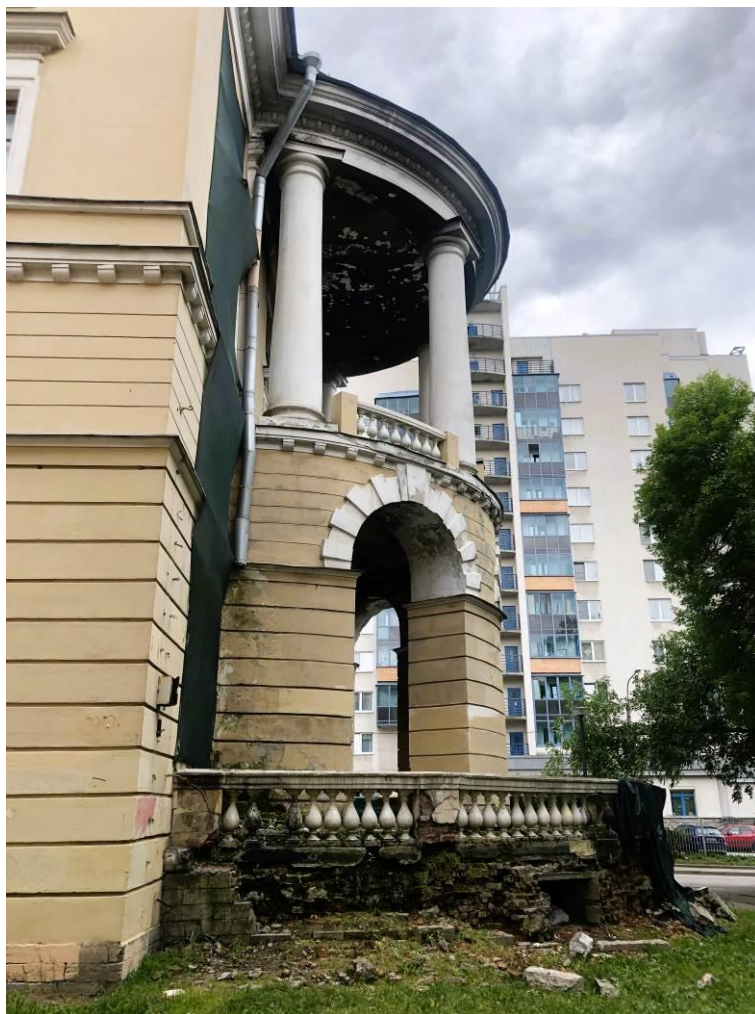
7. Объект культурного наследия регионального значения «Жилой дом», входящий в состав объекта культурного наследия регионального значения «Дача Сиверса (Кировский городок)», расположенный по адресу: Санкт-Петербург, Кировский район, пр. Стачек, д. 172, литера А. Общий вид в сторону Соломахинского проезда. Северо-западный фасад.
