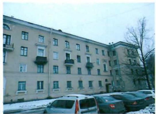
8. Фрагмент фасада. Вид с северо-востока.
