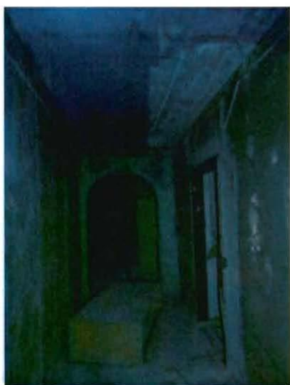
17. Помещение первого этажа.
