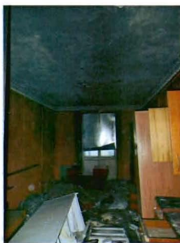
20. Помещение третьего этажа.
