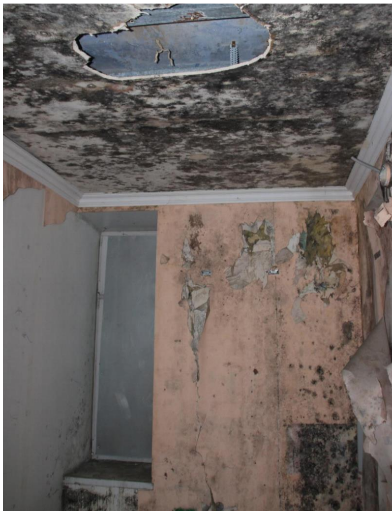
48. Объект культурного наследия регионального значения «Жилой дом», входящий в состав объекта культурного наследия регионального значения «Дача Сиверса (Кировский городок)», расположенный по адресу: Санкт-Петербург, Кировский район, пр. Стачек, д. 172, литера А. Помещение первого этажа. Фрагмент интерьера.
