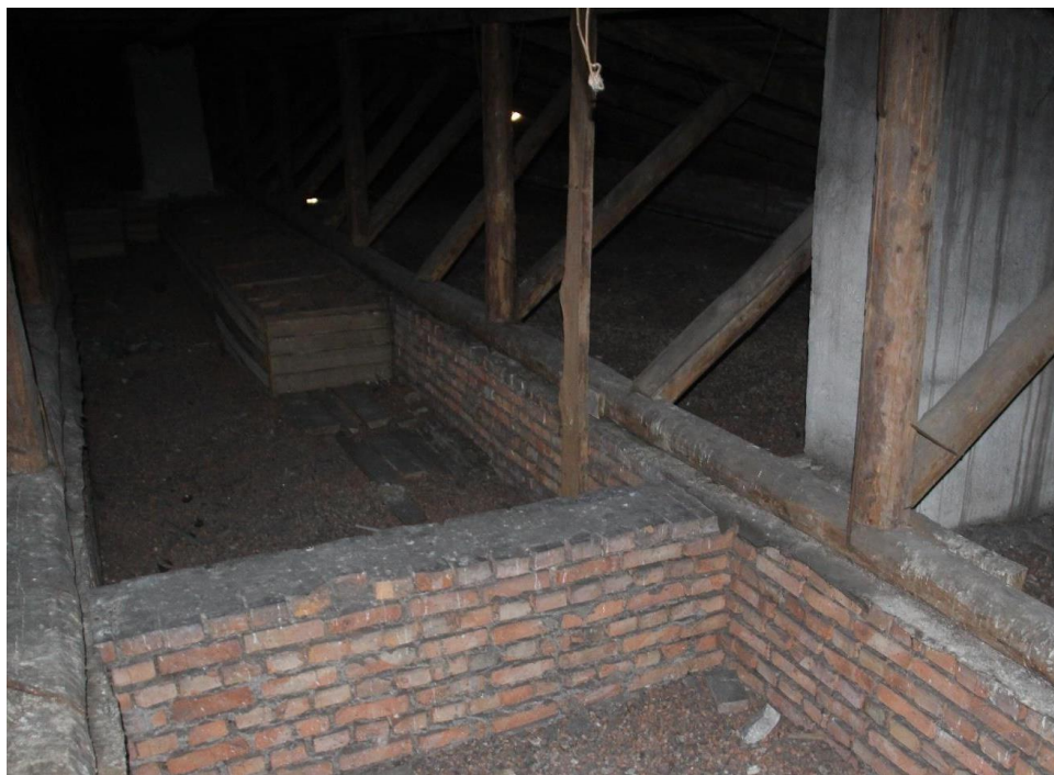
119. Объект культурного наследия регионального значения «Жилой дом», входящий в состав объекта культурного наследия регионального значения «Дача Сиверса (Кировский городок)», расположенный по адресу: Санкт-Петербург, Кировский район, пр. Стачек, д. 172, литера А. Чердак. Общий вид.
