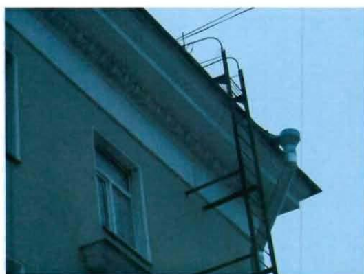
13. Профилированный карниз.
