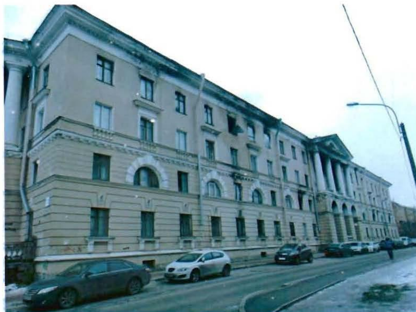
2. Лицевой фасад. Вид с запада.
