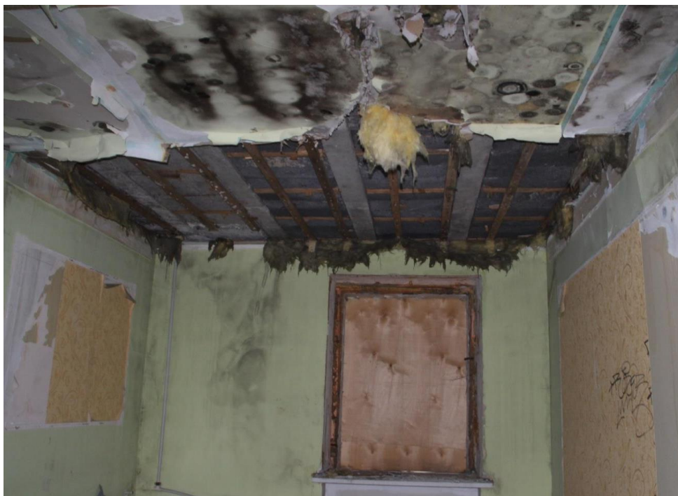
49. Объект культурного наследия регионального значения «Жилой дом», входящий в состав объекта культурного наследия регионального значения «Дача Сиверса (Кировский городок)», расположенный по адресу: Санкт-Петербург, Кировский район, пр. Стачек, д. 172, литера А. Помещение первого этажа. Фрагмент интерьера.
