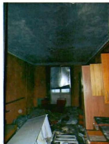
20. Помещение третьего этажа.
