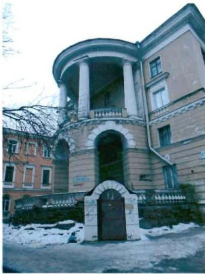
9. Полуциркульный ризалит с балконом и террасой.
