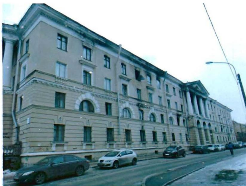
2. Лицевой фасад. Вид с запада.
