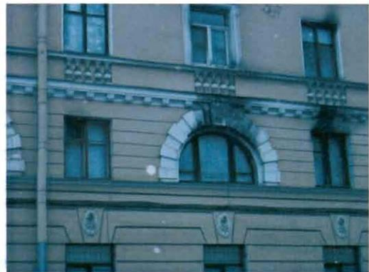
12. Оконные проемы второго этажа.
