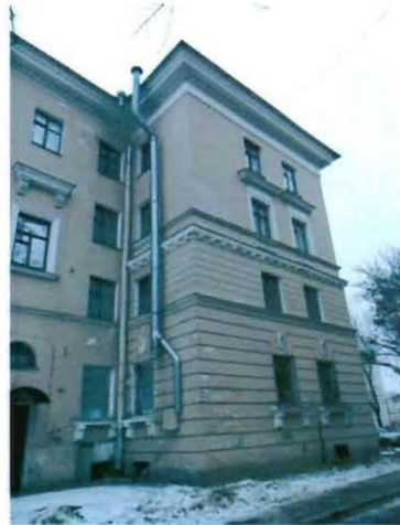
6. Ризалит в западной части.
