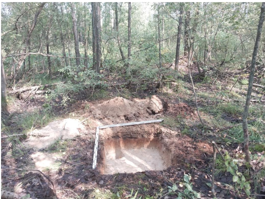
Рис. 14. г. Санкт-Петербург, Колпинский район. «Капитальный ремонт магистрального газопровода». Шурф 1. Общий вид после проведения земляных работ. Вид с юга. В качестве масштабов использованы линейки длиной 1 м.
