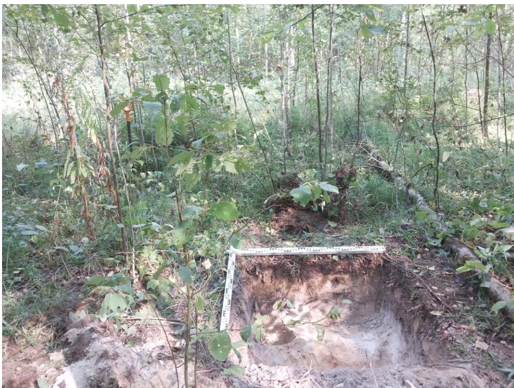
Рис. 28. г. Санкт-Петербург, Колпинский район. «Капитальный ремонт магистрального газопровода». Шурф 3. Общий вид после проведения земляных работ. Вид с востока. В качестве масштабов использованы линейки длиной 1 м.
