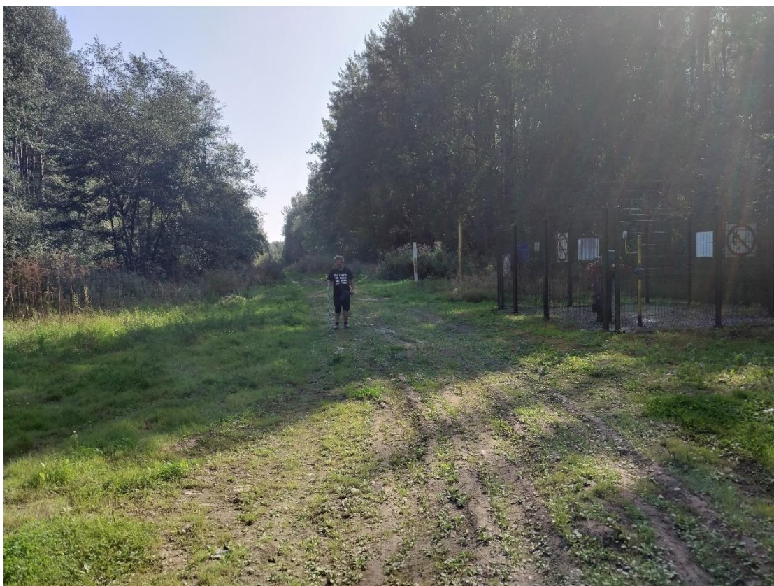
Рис.6. Точка фотофиксации 3. Объект: «Капитальный ремонт магистрального газопровода. Газопровод-отвод к ГРС пос. Никольское, Инв. № 000013994, ГО на ГРС «Никольское» с 0 км по 7,825 км. Колпинское ЛПУМГ». Направление съемки север.
