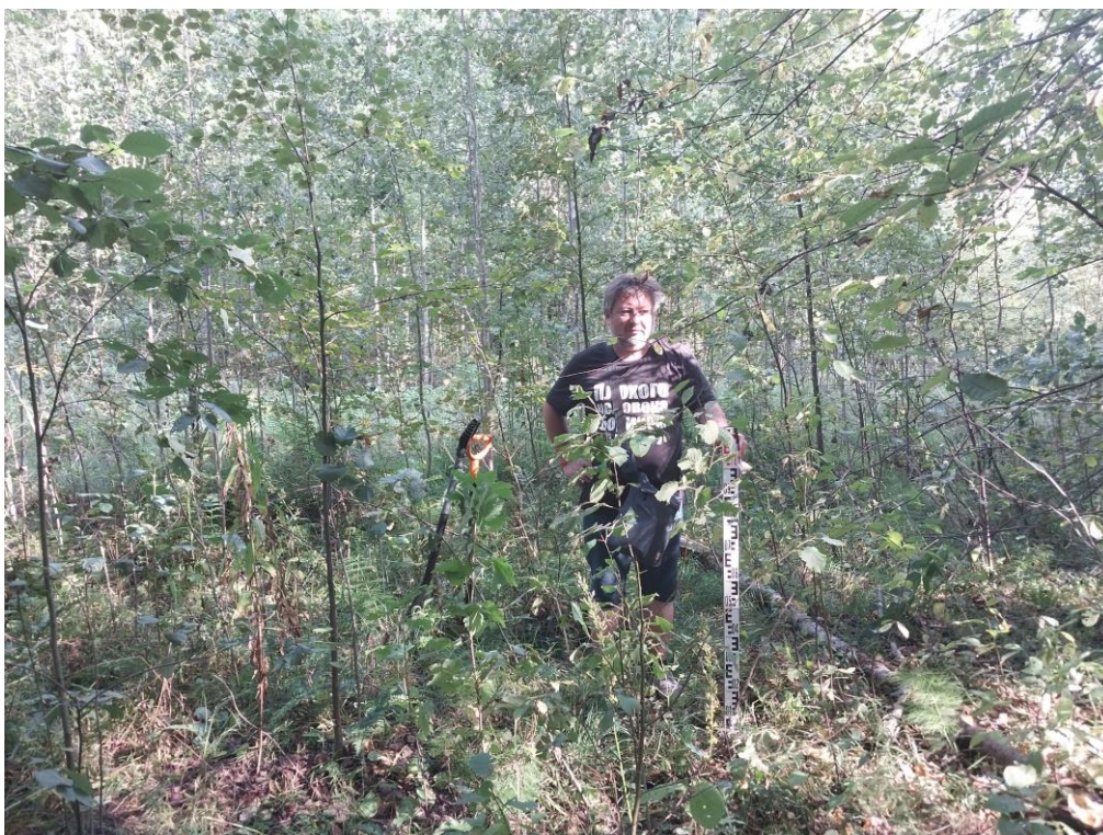
Рис. 26. г. Санкт-Петербург, Колпинский район. «Капитальный ремонт магистрального газопровода». Шурф 3. Общий вид поверхности до проведения земляных работ. Вид с востока. В качестве масштаба использована линейка длиной 1 м.
