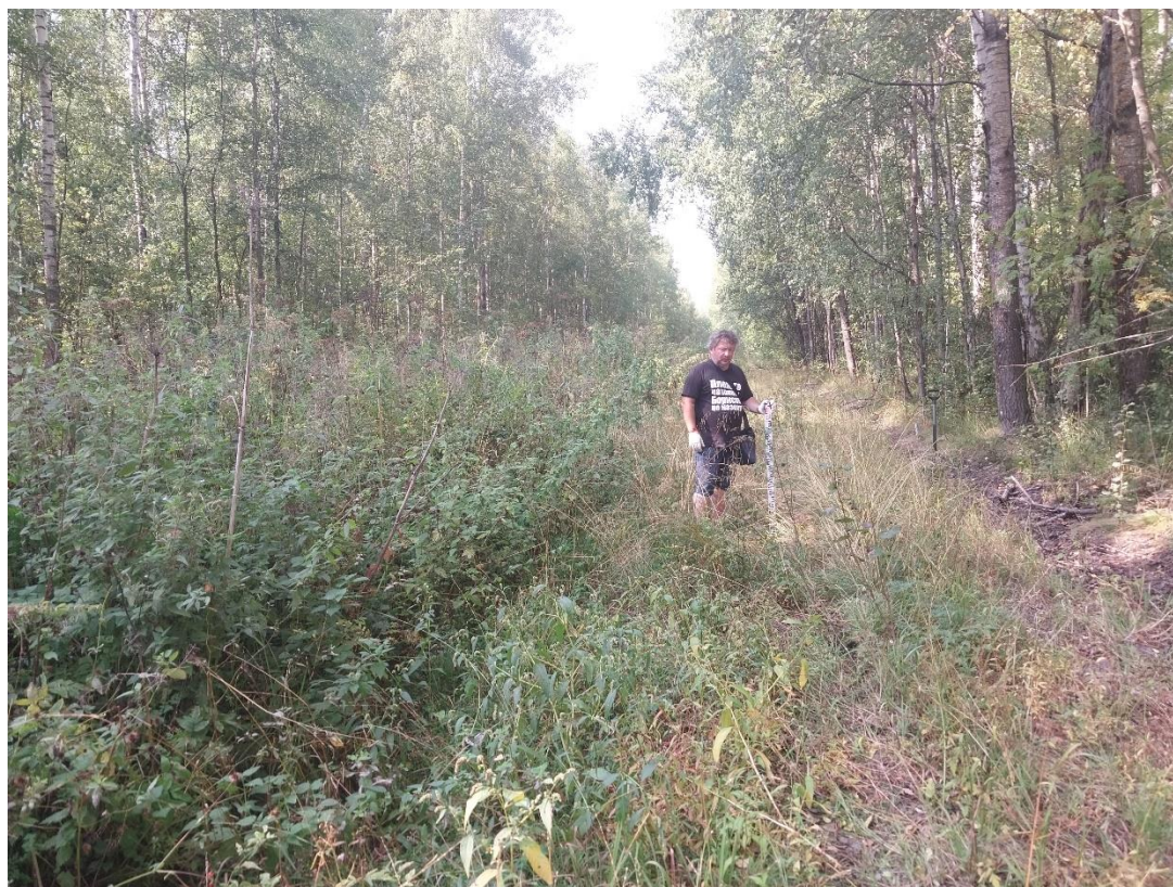
Рис.4. Точка фотофиксации 2. Объект: «Капитальный ремонт магистрального газопровода. Газопровод-отвод к ГРС пос. Никольское, Инв. № 000013994, ГО на ГРС «Никольское» с 0 км по 7,825 км. Колпинское ЛПУМГ». Направление съемки северо-запад.
