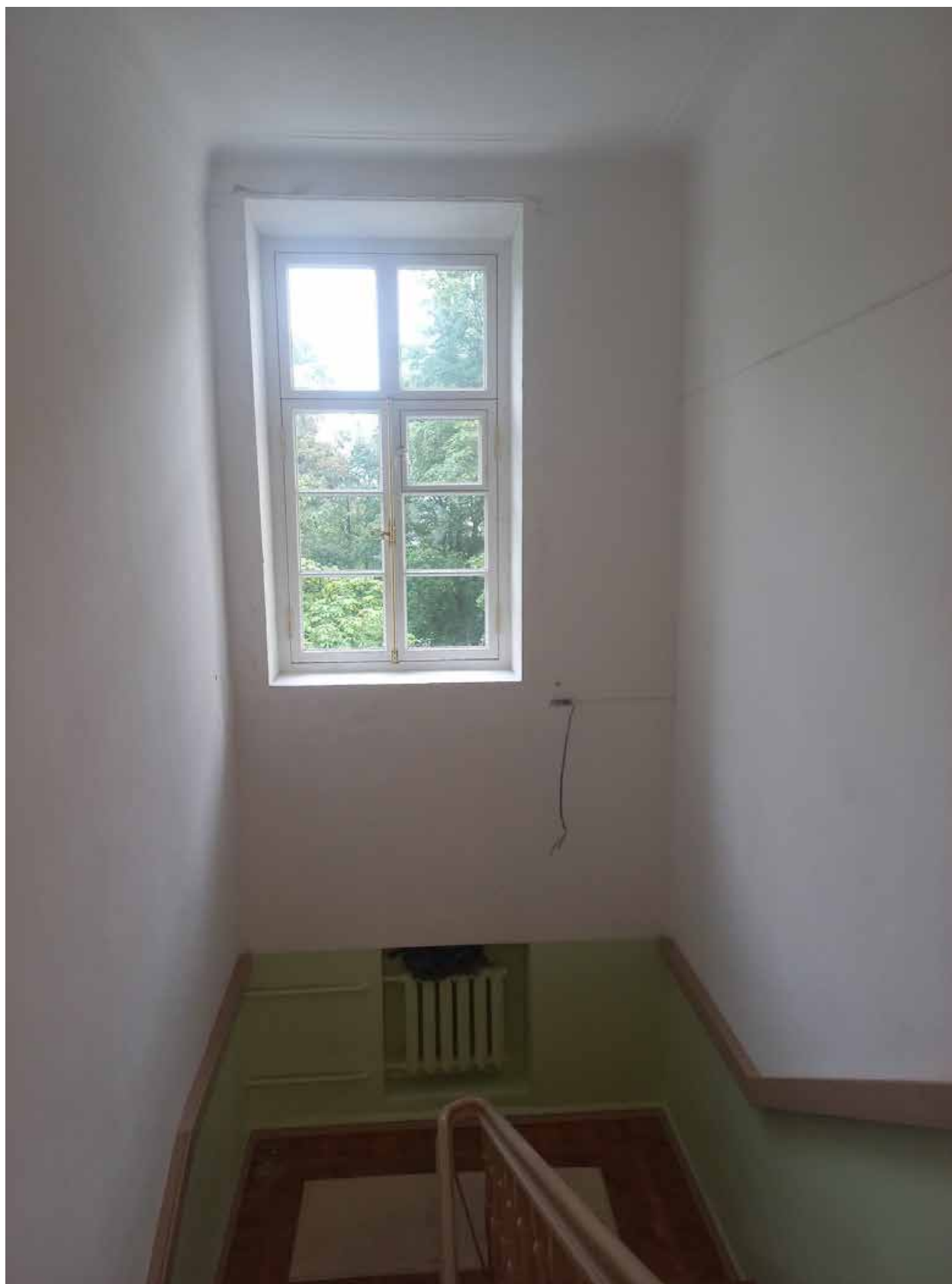
Фото 6. Вид с четвертого этажа.
