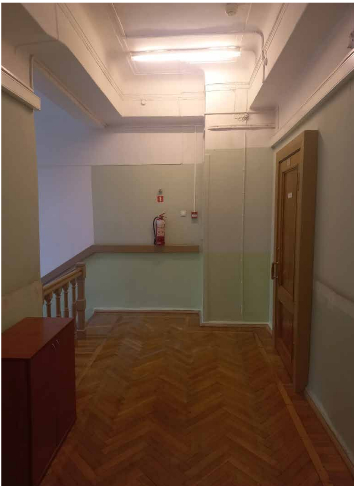
Фото 7. Коридор четвертого этажа. Проход на лестничный марш.
