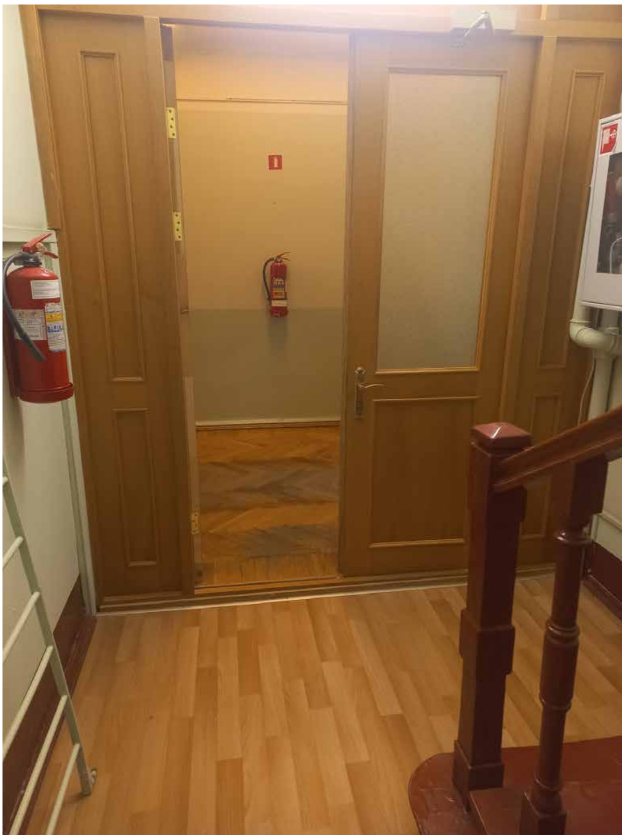
Фото 9. Первый этаж. Дверь в коридор.
