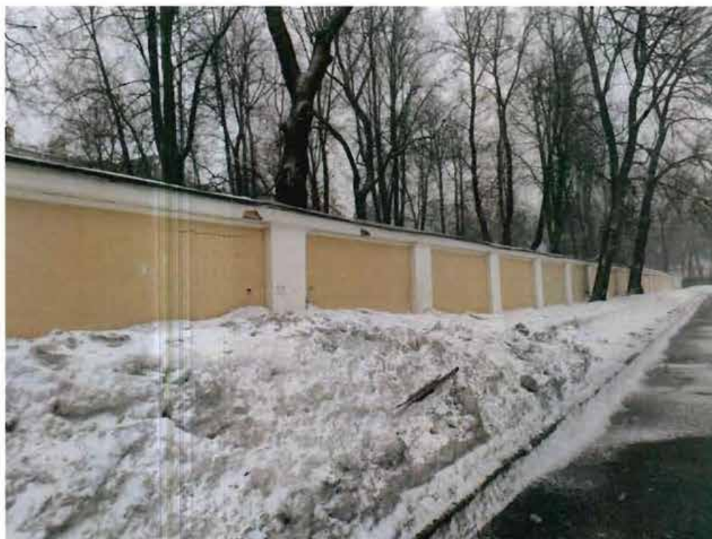
3. Северная часть объекта культурного наследия. Вид с востока.
