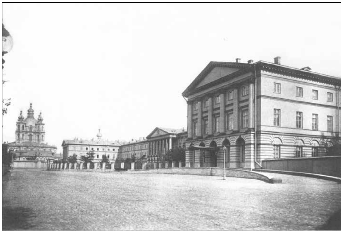
11. Смольный институт. Фасад. Правое крыло. Артистический подъезд. Фотография. 1900-е гг.
