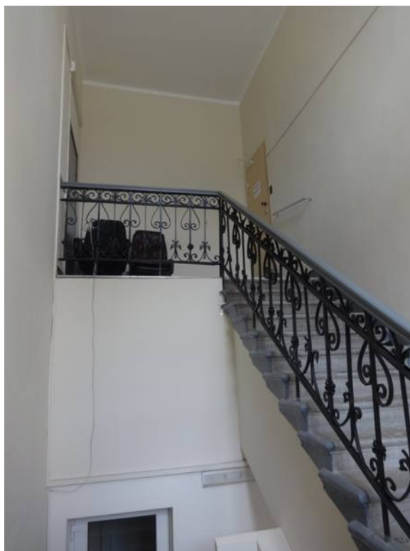
33. Лестничная клетка ЛК-3. Объект культурного наследия федерального значения «Дом, где в первой половине XIX в. размещалась Российско-Американская компания. Здесь в 1820-х гг. жили декабристы Бестужев-Марлинский А.А. и Рылеев К.Ф.», расположенный по адресу: Санкт-Петербург, Адмиралтейский район, набережная реки Мойки, дом 72, литера А. Дата дополнительной съемки: 08.07.2019.
