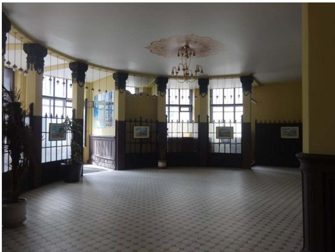
63. Помещение 1-Н (бывший «Операционный зал»). Покрытие пола – метлахская плитка, рисунок «соты». Объект культурного наследия федерального значения «Дом, где в первой половине XIX в. размещалась Российско-Американская компания. Здесь в 1820-х гг. жили декабристы Бестужев-Марлинский А.А. и Рылеев К.Ф.», расположенный по адресу: Санкт-Петербург, Адмиралтейский район, набережная реки Мойки, дом 72, литера А. Дата дополнительной съемки: 08.07.2019.
