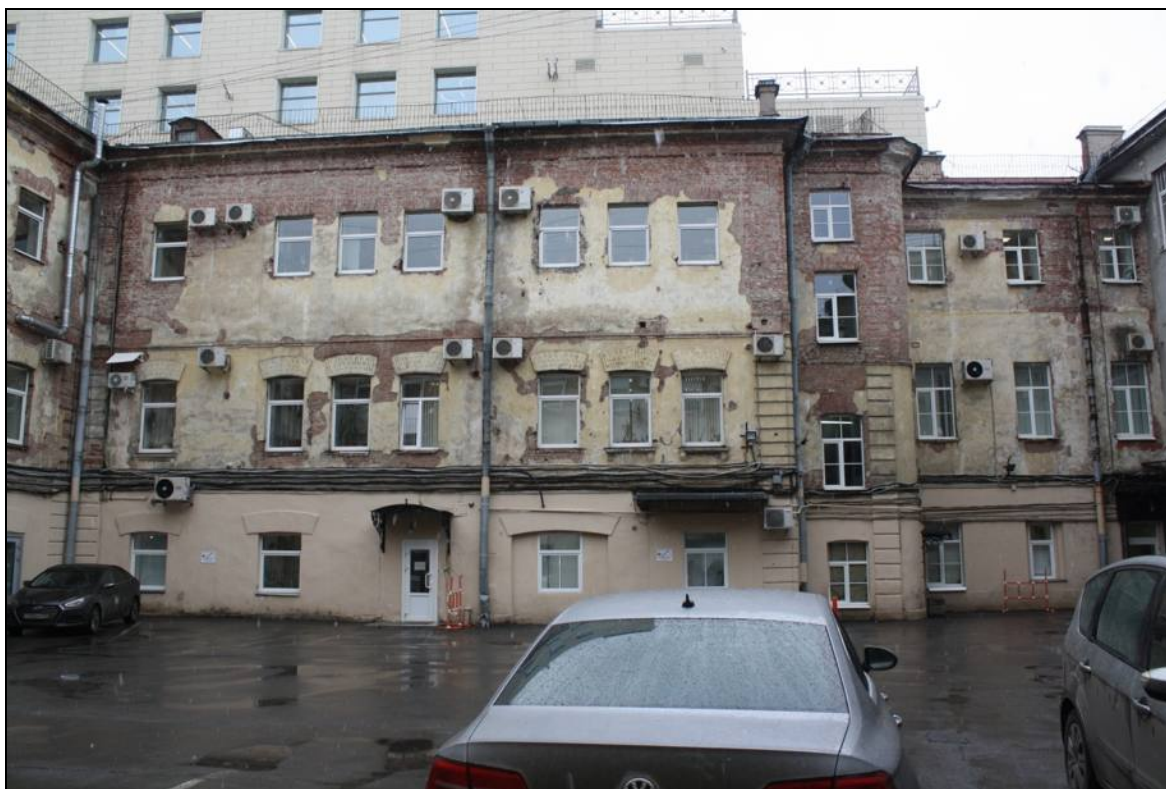
5. Дворовый фасад. Общий вид. Объект культурного наследия федерального значения «Дом, где в первой половине XIX в. размещалась Российско-Американская компания. Здесь в 1820-х гг. жили декабристы Бестужев-Марлинский А.А. и Рылеев К.Ф.», расположенный по адресу: Санкт-Петербург, Адмиралтейский район, набережная реки Мойки, дом 72, литера А. Дата съемки: 21.06.2019.
