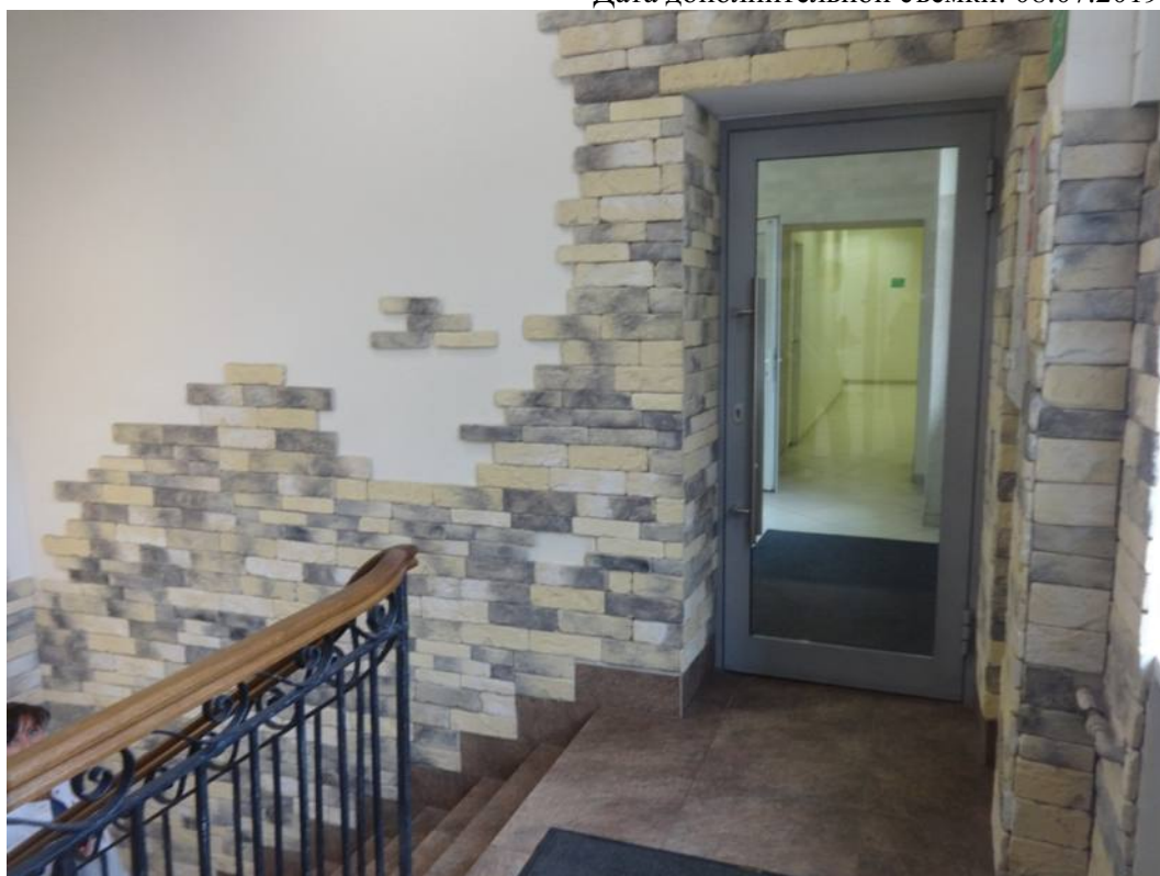
24. Обрамление площадки второго этажа лестницы Л-2 входа со стороны дворового фасада. Объект культурного наследия федерального значения «Дом, где в первой половине XIX в. размещалась Российско-Американская компания. Здесь в 1820-х гг. жили декабристы Бестужев-Марлинский А.А. и Рылеев К.Ф.», расположенный по адресу: Санкт-Петербург, Адмиралтейский район, набережная реки Мойки, дом 72, литера А. Дата дополнительной съемки: 08.07.2019.
