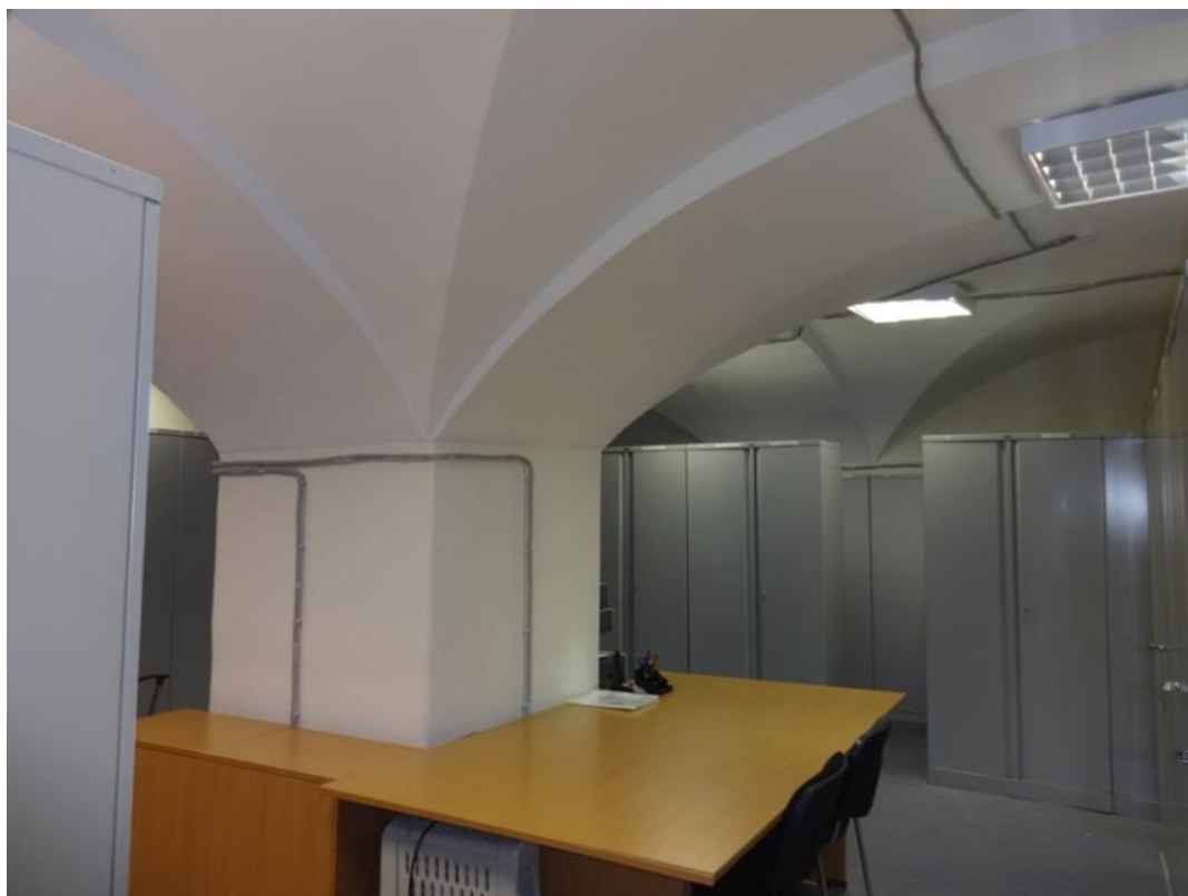
9. Помещение архива. Южный фасад. Вид на юг. Объект культурного наследия федерального значения «Дом, где в первой половине XIX в. размещалась Российско-Американская компания. Здесь в 1820-х гг. жили декабристы Бестужев-Марлинский А.А. и Рылеев К.Ф.», расположенный по адресу: Санкт-Петербург, Адмиралтейский район, набережная реки Мойки, дом 72, литера А. Дата дополнительной съемки: 08.07.2019.
