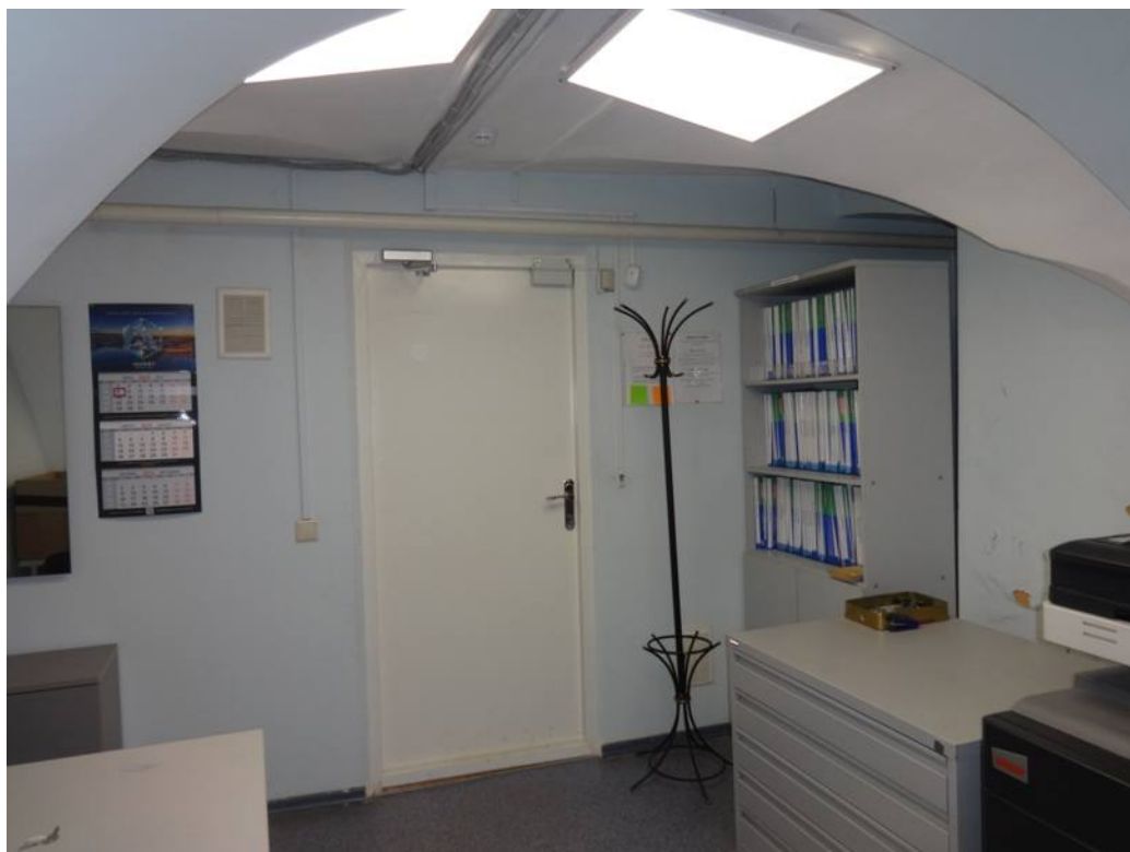
7. Помещение архива. Южный фасад. Вид на север. Объект культурного наследия федерального значения «Дом, где в первой половине XIX в. размещалась Российско-Американская компания. Здесь в 1820-х гг. жили декабристы Бестужев-Марлинский А.А. и Рылеев К.Ф.», расположенный по адресу: Санкт-Петербург, Адмиралтейский район, набережная реки Мойки, дом 72, литера А. Дата дополнительной съемки: 08.07.2019.
