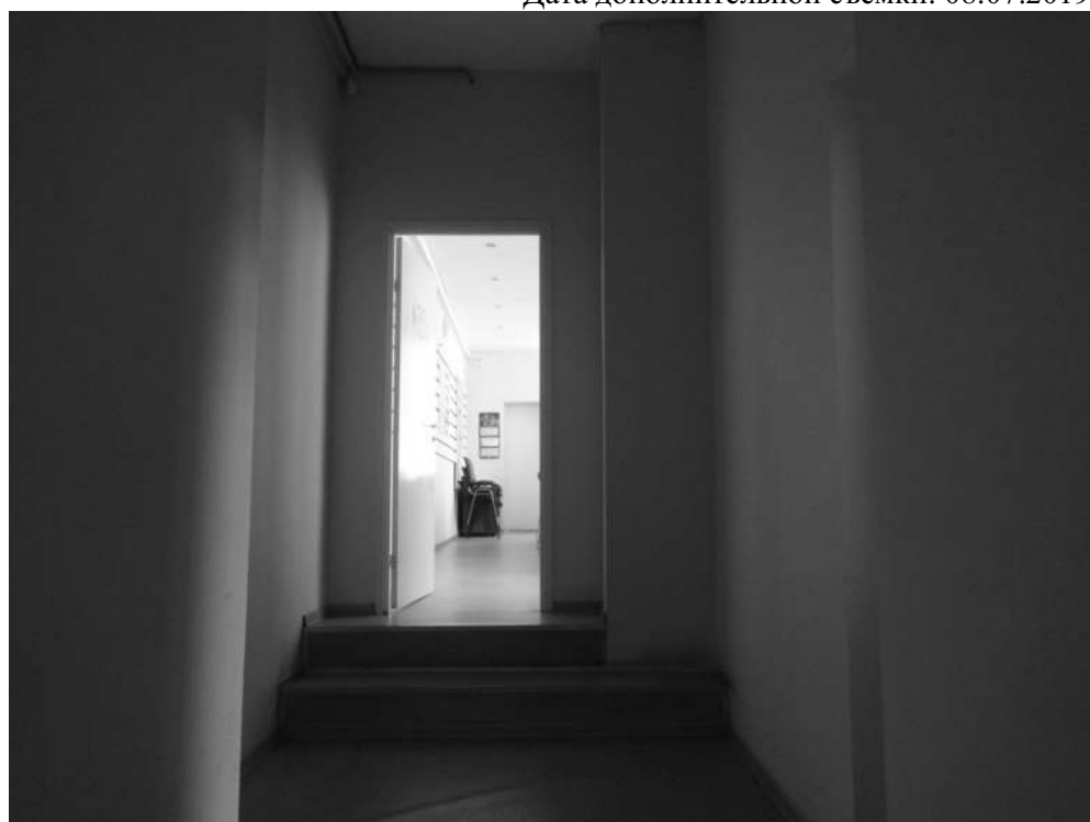
14. Коридор. Вид на юг. Объект культурного наследия федерального значения «Дом, где в первой половине XIX в. размещалась Российско-Американская компания. Здесь в 1820-х гг. жили декабристы Бестужев-Марлинский А.А. и Рылеев К.Ф.», расположенный по адресу: Санкт-Петербург, Адмиралтейский район, набережная реки Мойки, дом 72, литера А. Дата дополнительной съемки: 08.07.2019.
