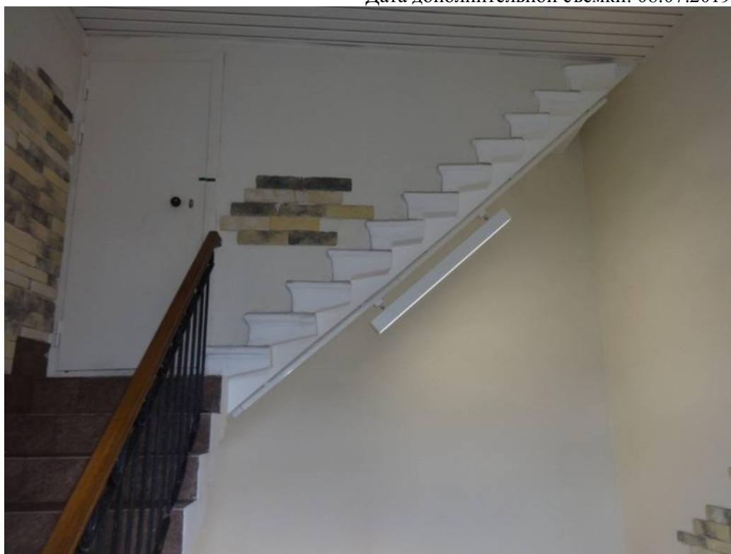
62. Лестничная клетка ЛК-2. Объект культурного наследия федерального значения «Дом, где в первой половине XIX в. размещалась Российско-Американская компания. Здесь в 1820-х гг. жили декабристы Бестужев-Марлинский А.А. и Рылеев К.Ф.», расположенный по адресу: Санкт-Петербург, Адмиралтейский район, набережная реки Мойки, дом 72, литера А. Дата дополнительной съемки: 08.07.2019.
