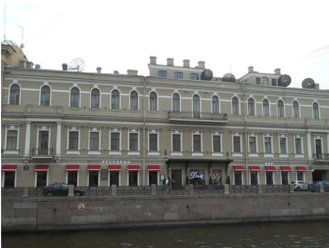
94. Лицевой фасад. 2018г.
