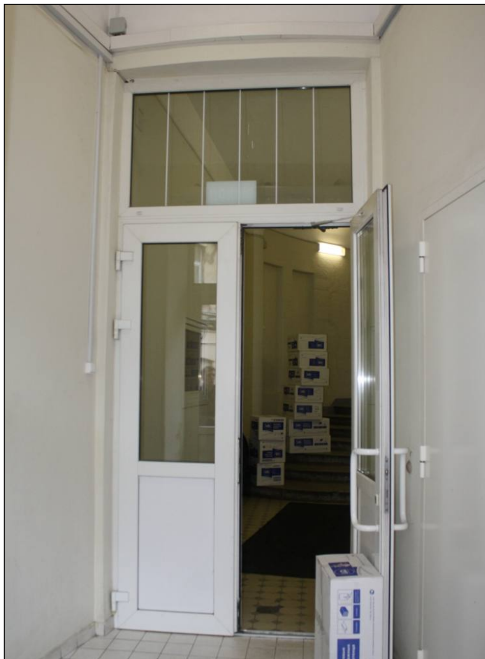
12. Входная группа. Дворовый фасад. Объект культурного наследия федерального значения «Дом, где в первой половине XIX в. размещалась Российско-Американская компания. Здесь в 1820-х гг. жили декабристы Бестужев-Марлинский А.А. и Рылеев К.Ф.», расположенный по адресу: Санкт-Петербург, Адмиралтейский район, набережная реки Мойки, дом 72, литера А. Дата съемки: 21.06.2019.
