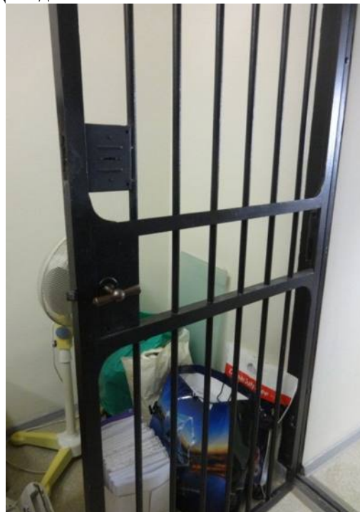
46. Решетка на лестничной клетке. Объект культурного наследия федерального значения «Дом, где в первой половине XIX в. размещалась Российско-Американская компания. Здесь в 1820-х гг. жили декабристы Бестужев-Марлинский А.А. и Рылеев К.Ф.», расположенный по адресу: Санкт-Петербург, Адмиралтейский район, набережная реки Мойки, дом 72, литера А. Дата дополнительной съемки: 08.07.2019.
