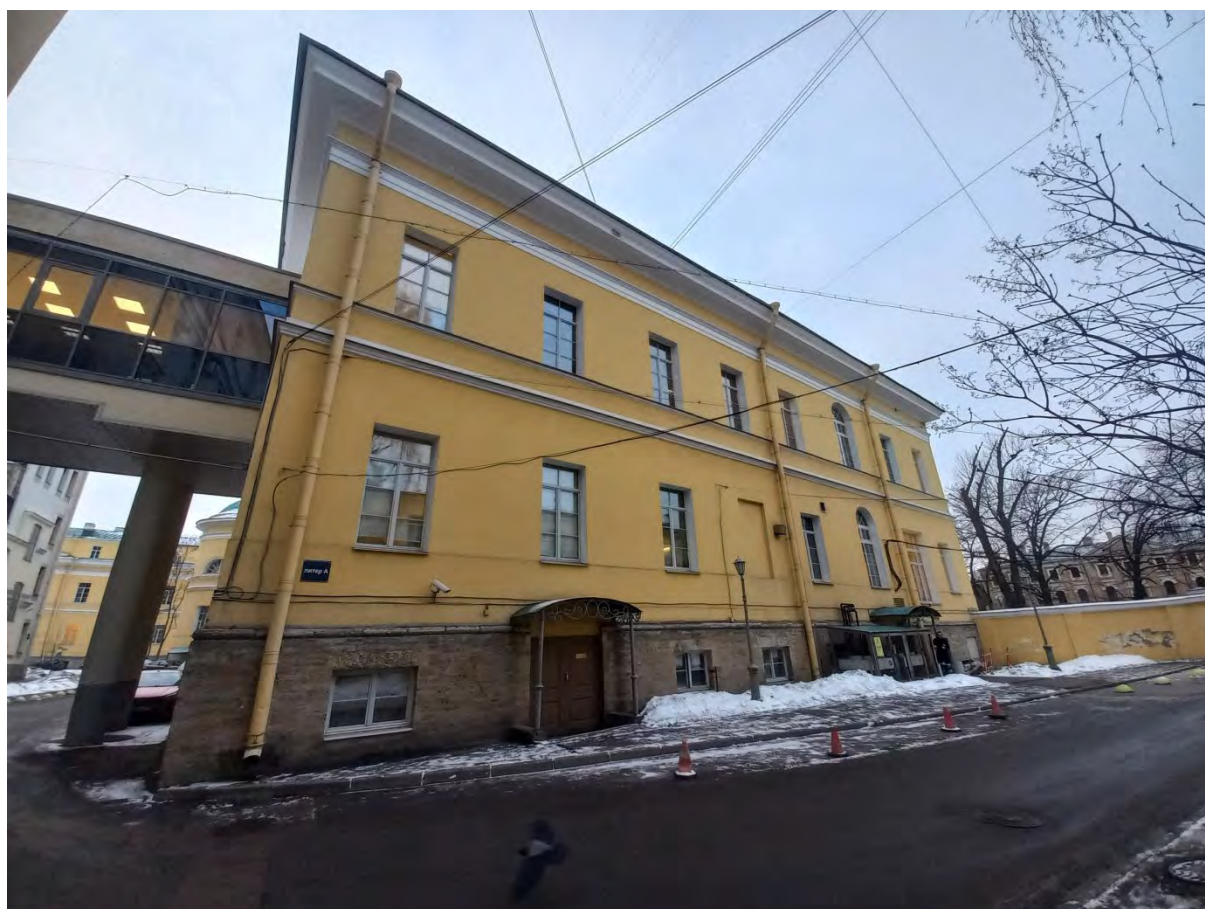
Фото 10. “Корпус Главный” – северный фасад. Территория памятника.
