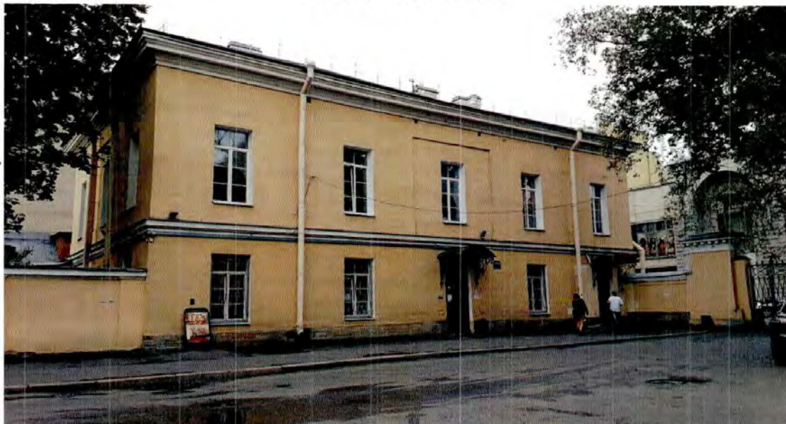
15. Северный фасад здания
