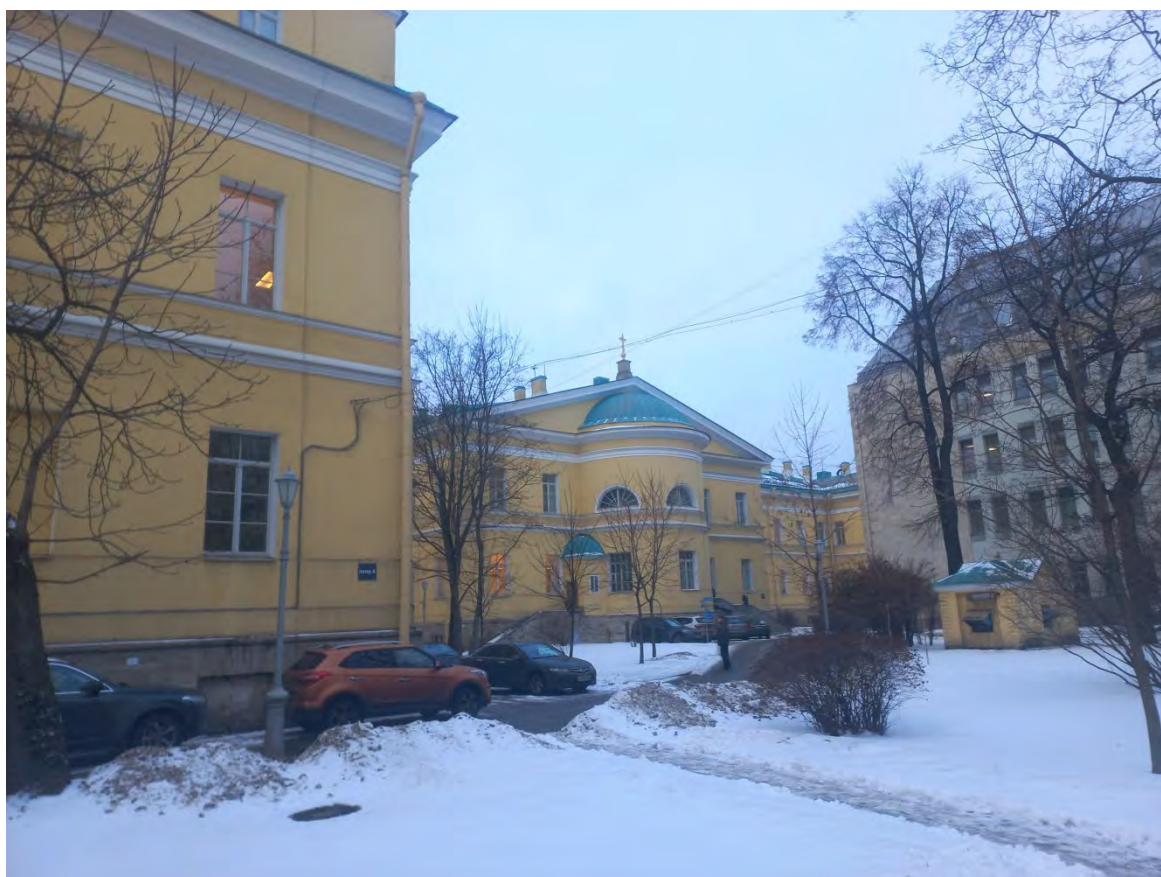
Фото 7. “Корпус Главный” – восточный фасад, домовая церковь. Территория памятника.
