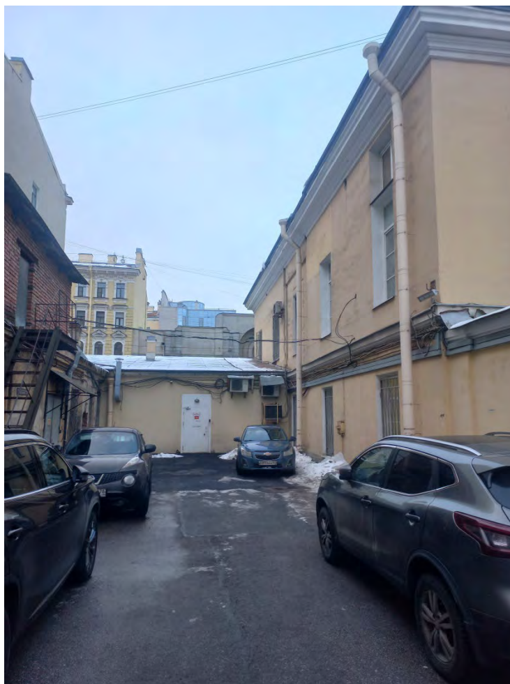
Фото 4. Боковой корпус. Южный фасад.
