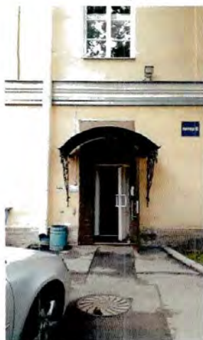
19. Вход с восточной стороны
