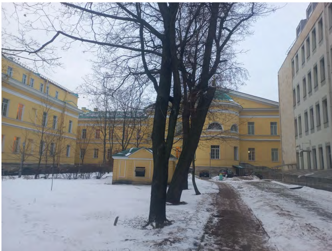
Фото 8. “Корпус Главный” – восточный фасад, домовая церковь. Территория памятника.
