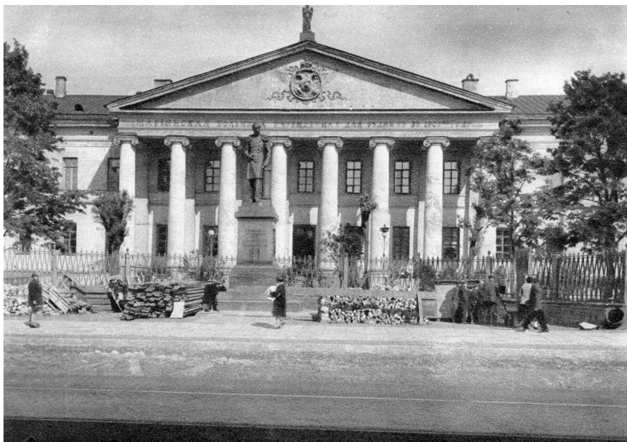
Илл. 39. Фасад Мариинской больницы. Открытка 1929 г. URL: https://www.citywalls.ru/photo462003.html
