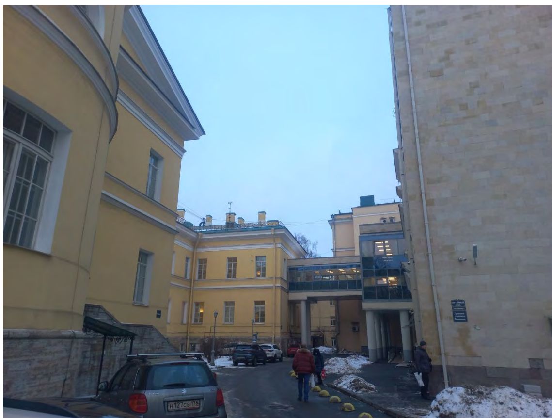
Фото 9. “Корпус Главный” – восточный фасад. Территория памятника.
