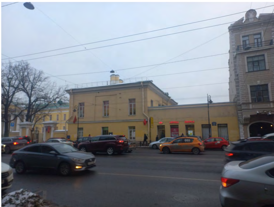
Фото 1. Боковой корпус. Фасад вдоль Литейного пр. (западный).
