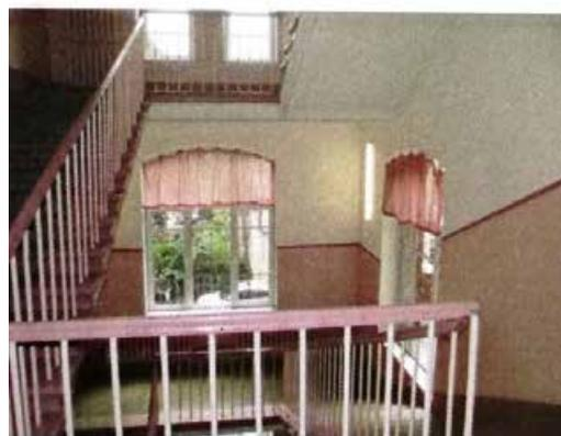
две боковые лестницы – тип (двухмаршевые), местоположение, габариты, конструкции (по косоурам, площадки на сводах), профиль и материал (известняк) ступеней, ограждения – материал (металл), техника исполнения (ковка), рисунок;
