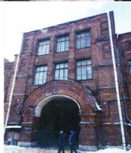
два боковых ризалита – габариты, местоположение, конфигурация (со скошенными углами), оформление – широкий фриз с ширинками, стилизованные кокошники над оконными проемами четвертого этажа, венчающий карниз с зубчиками;
