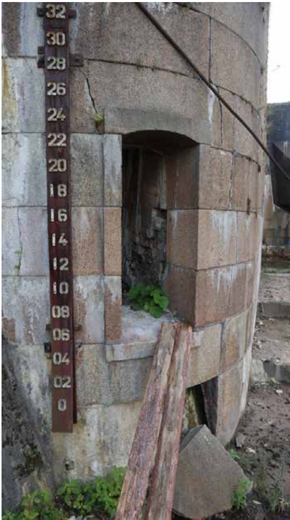
Фото 34. Вход в водоподводящую галерею в восточном устье южной головы дока.
