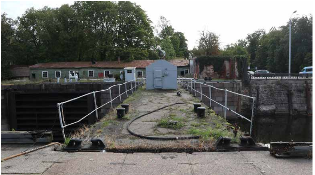
Фото 7. Вид на батопорт с западной площадки южной головы дока.
