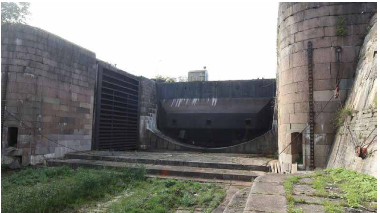
Фото 37. Вид на батопорт со стороны южного дока.
