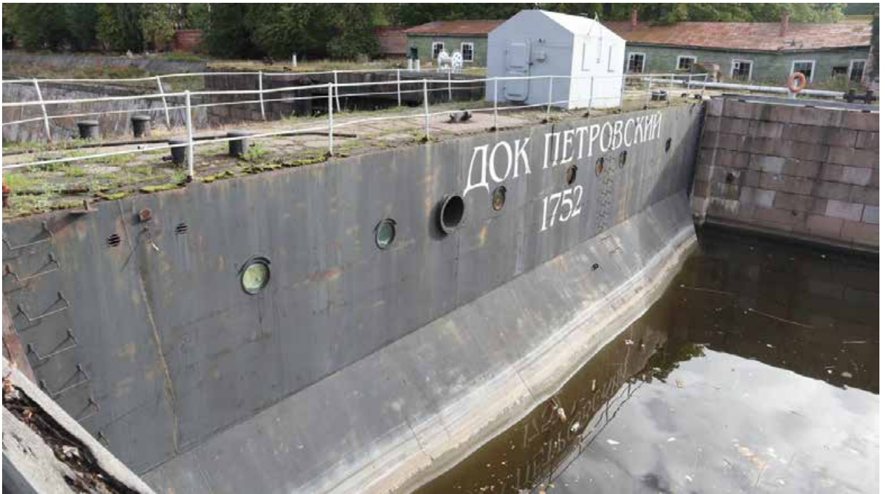
Фото 9. Вид на батопорт с западной площадки южной головы дока.
