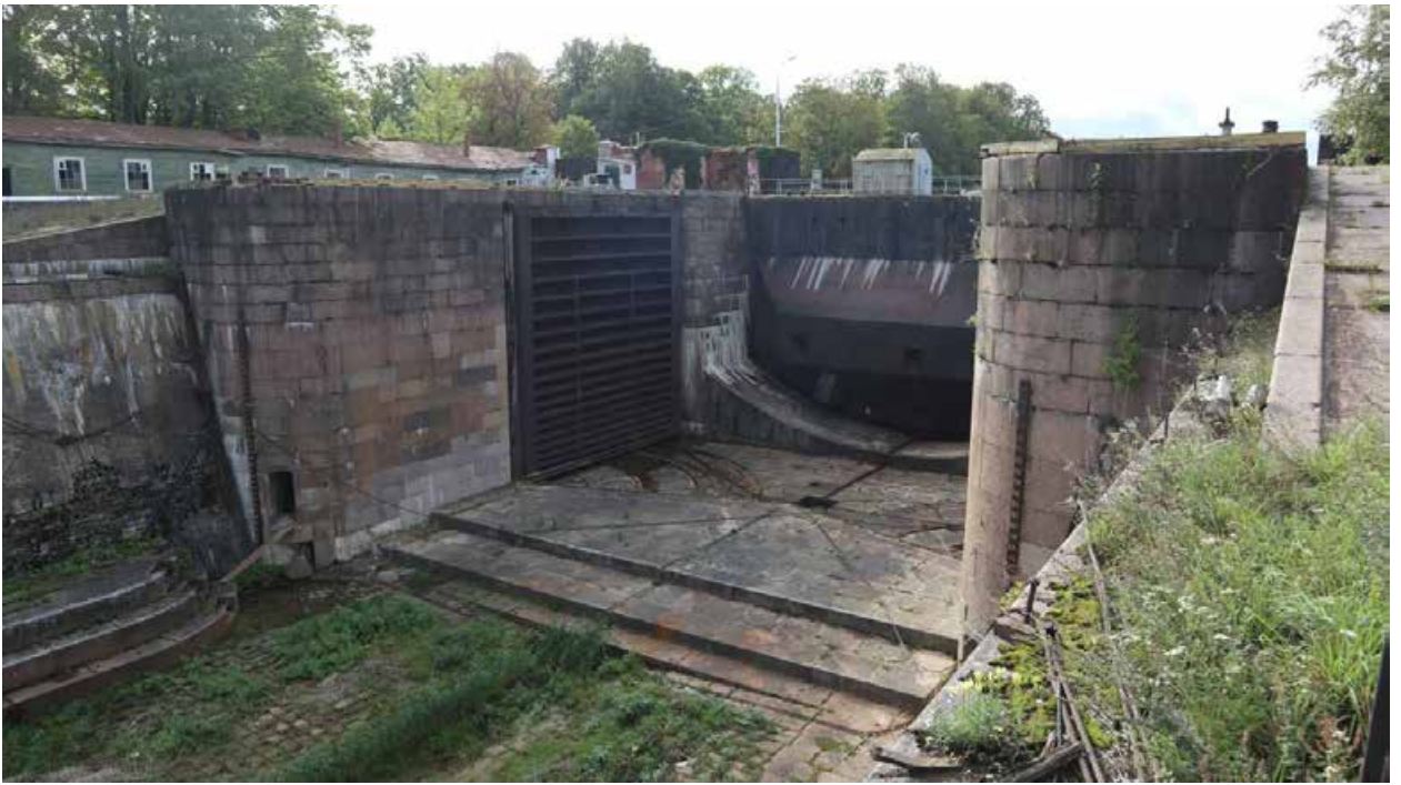
Фото 38. Вид на южную голову дока с западного берега дока.
