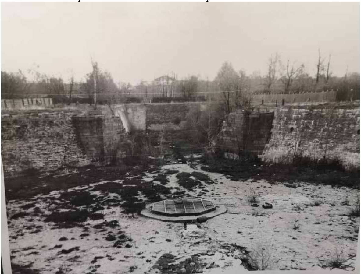
Илл. 40. Петровский док. Крест-канал. Центральная часть. 1983 г.// Фототека отд. охраны памятников № 128466. Архив КГИОП. П. 615
