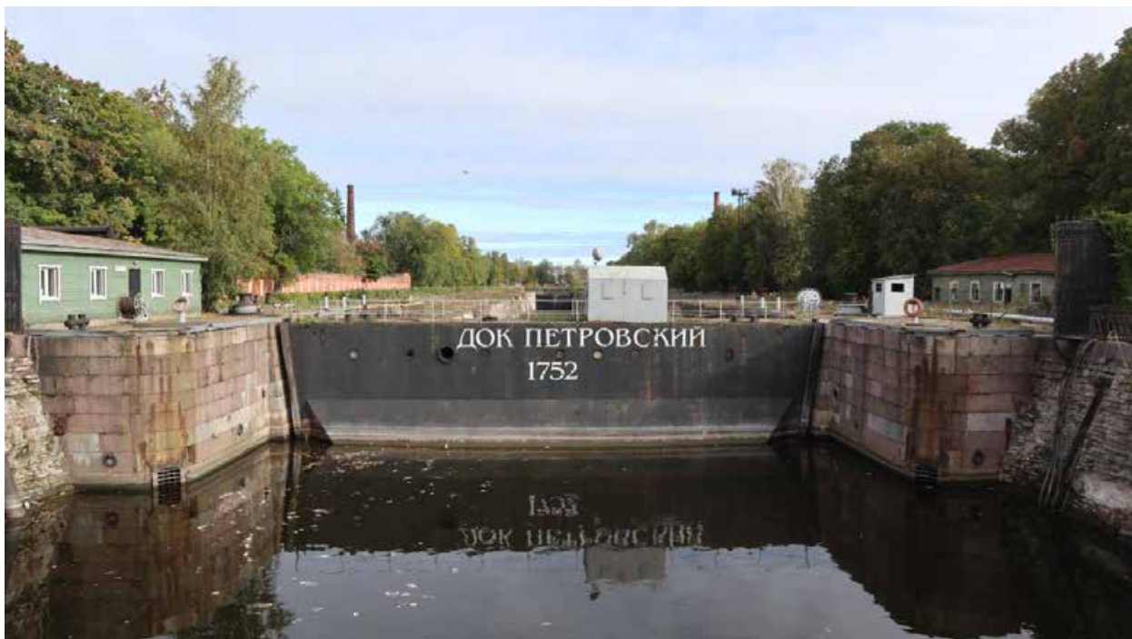
Фото 1. Вид на южную голову «Дока Петровского (южная часть)» с Докового моста.
