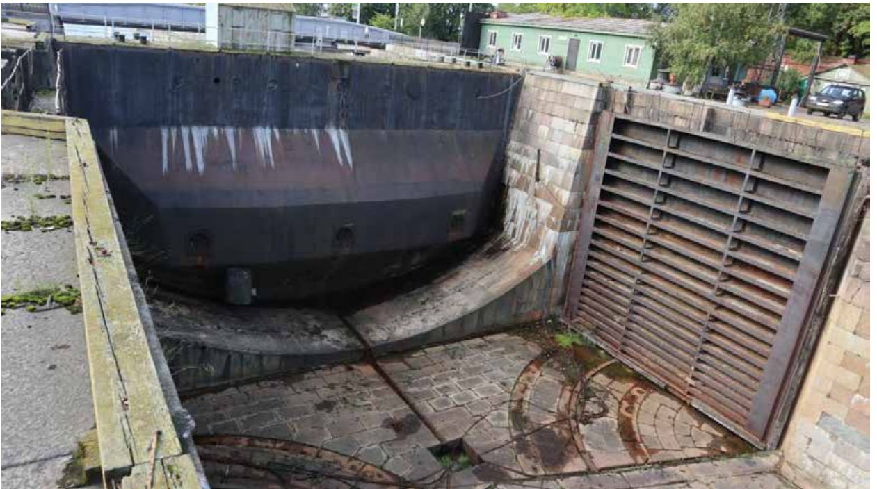
Фото 33. Вид на батопорт с восточной площадки южной головы дока.
