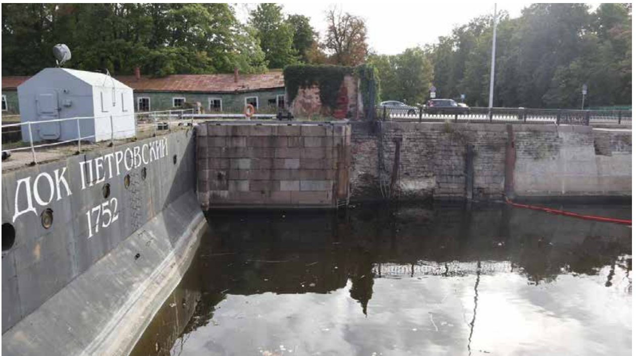
Фото 10. Вид на батопорт с западной площадки южной головы дока.
