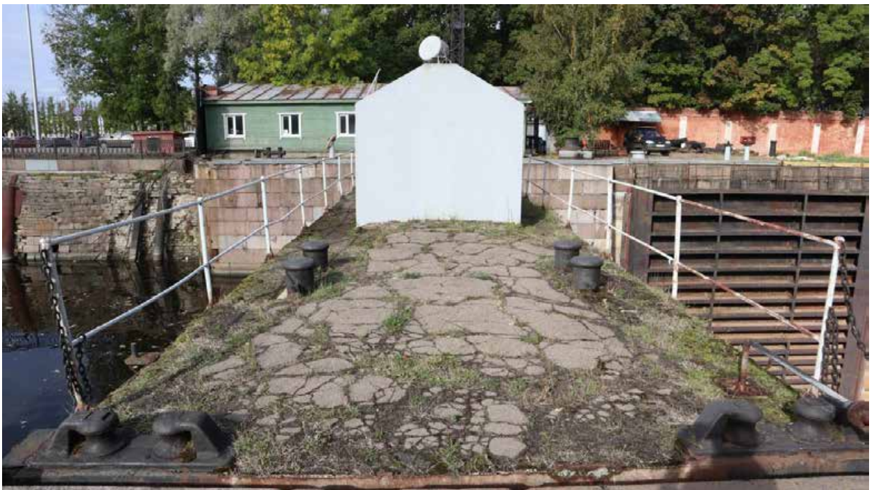
Фото 12. Верх батопорта. Металлическая рубка над люком-входом в батопорт.
