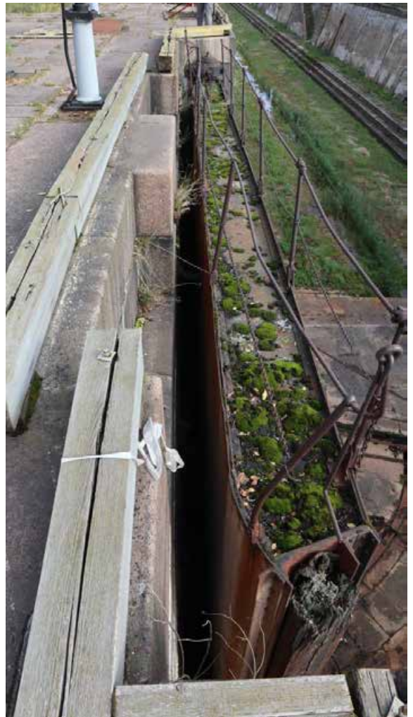
Фото 27. Верх западных ворот южной головы дока.
