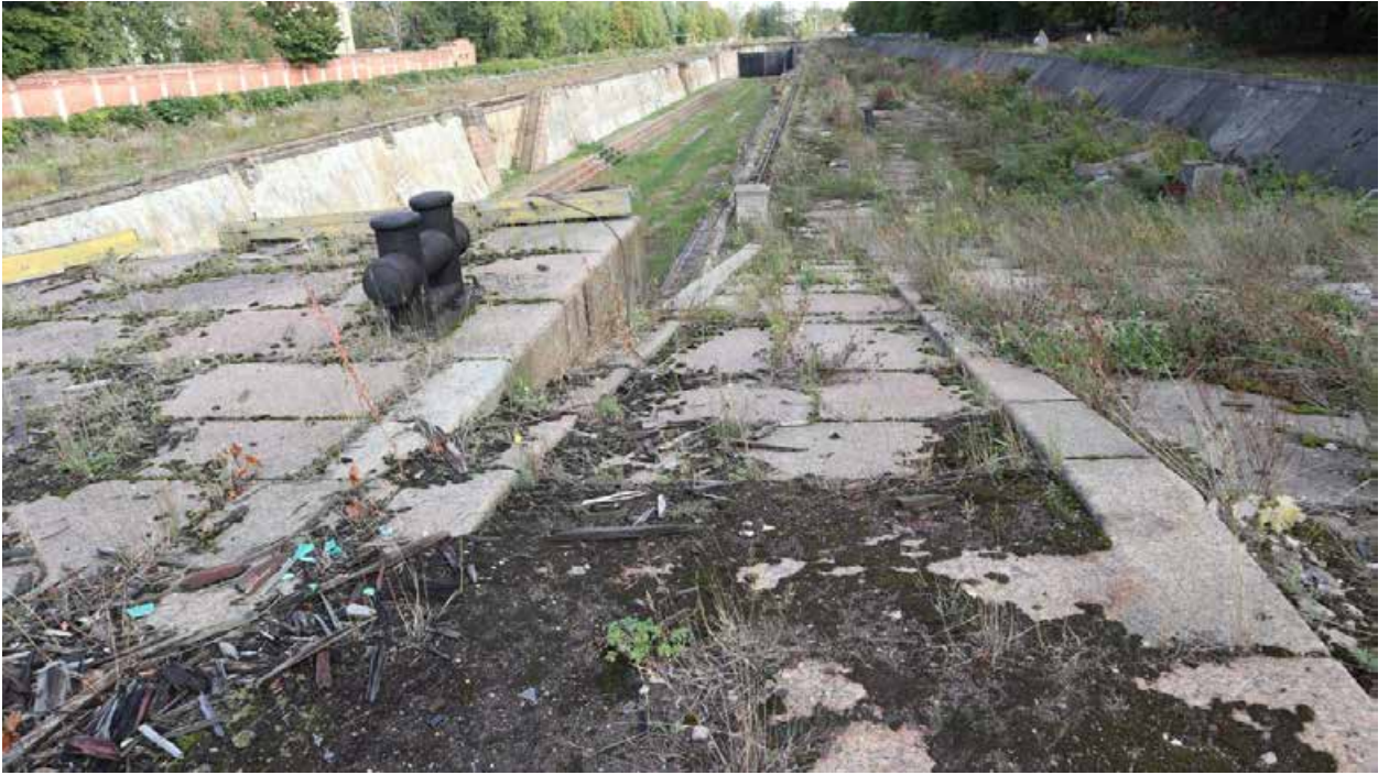
Фото 32. Гранитный спуск с восточной площадки южной головы дока.
