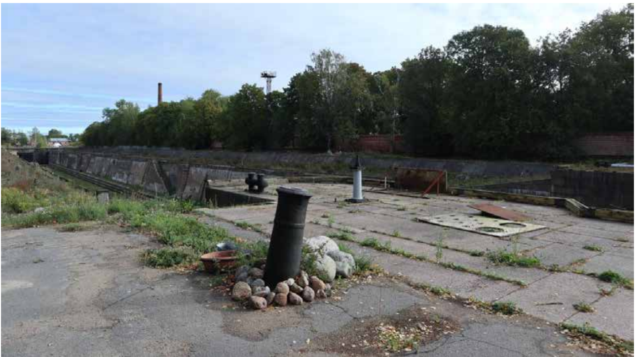
Фото 4. Вид на западную площадку южной головы дока.
