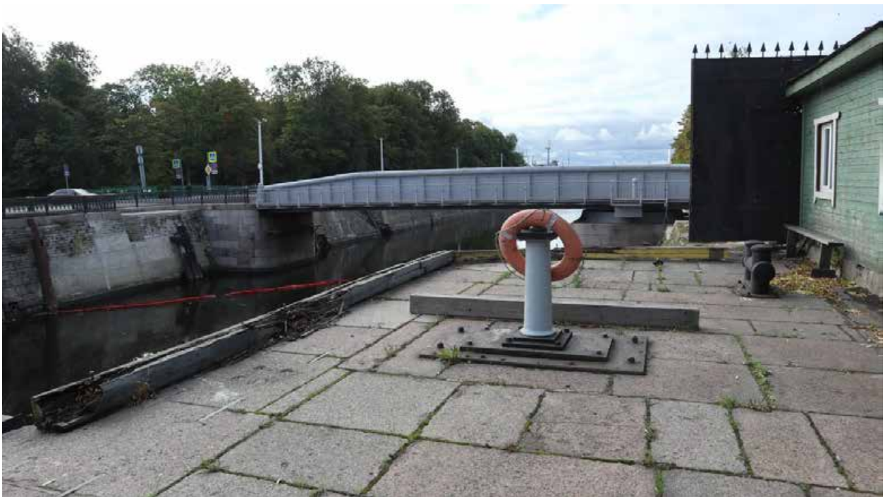
Фото 8. Вид на западную площадку южной головы дока.
