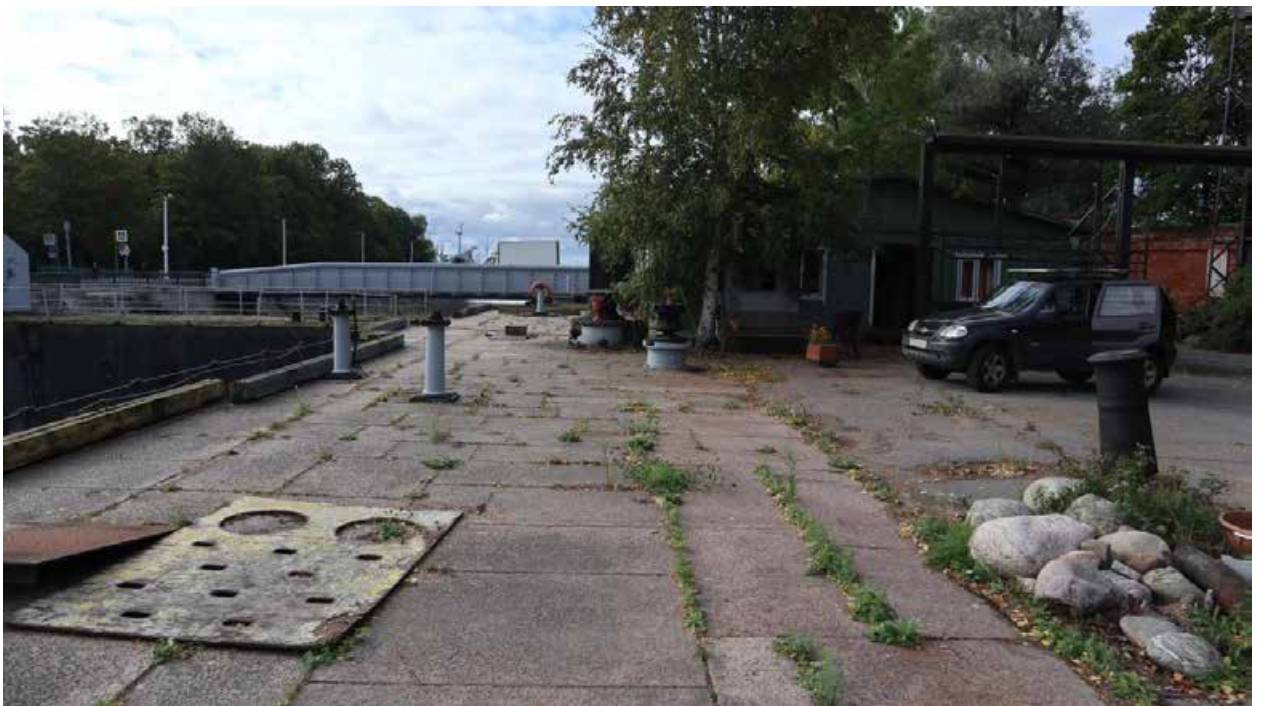
Фото 6. Вид на западную площадку южной головы дока.
