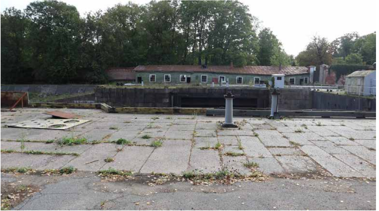
Фото 3. Вид на западную площадку южной головы дока.
