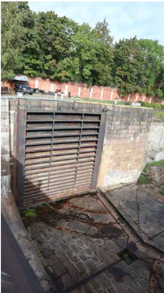
Фото 26. Вид на западные ворота южной головы дока
