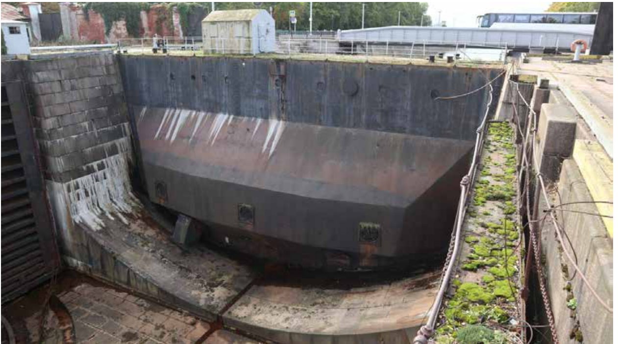
Фото 22. Вид на батопорт с западной площадки южной головы дока.
