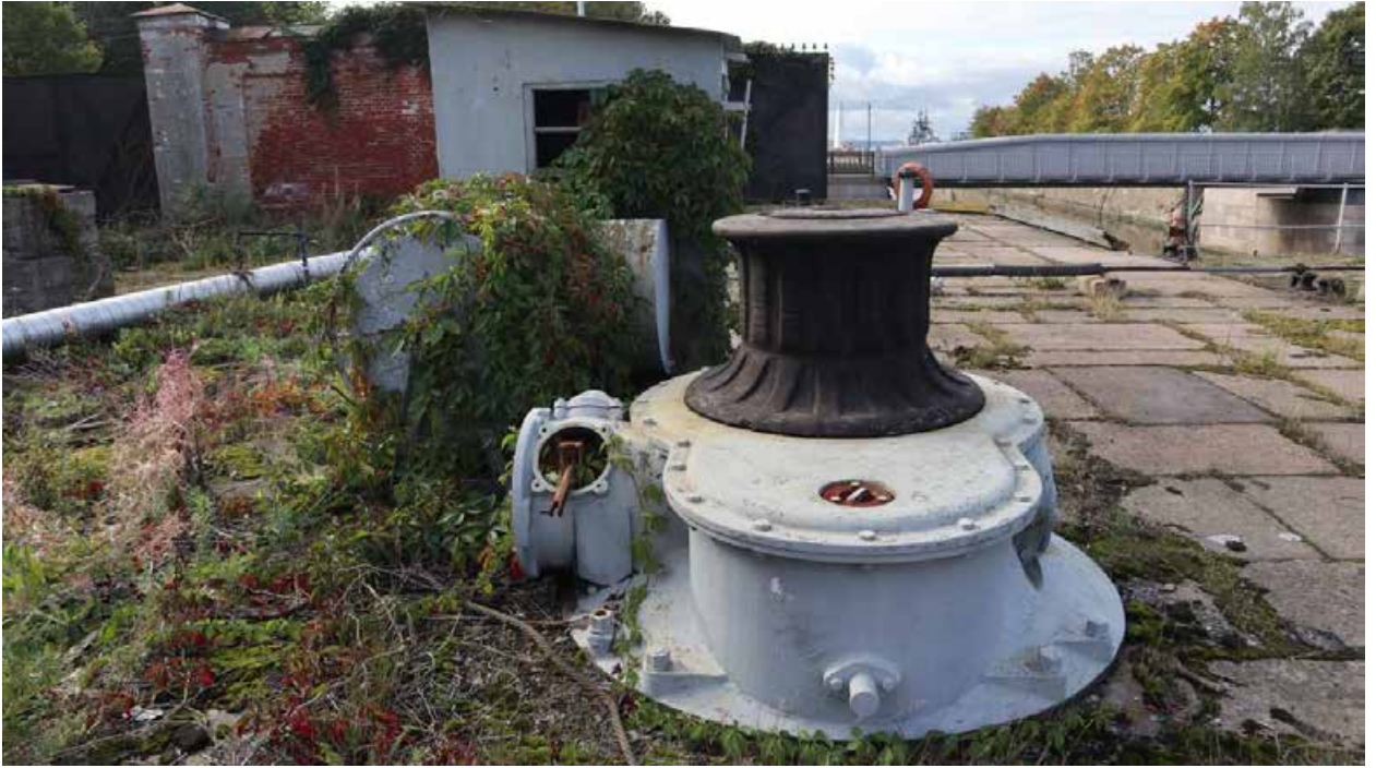
Фото 30. Шпиль на восточной площадке южной головы дока.
