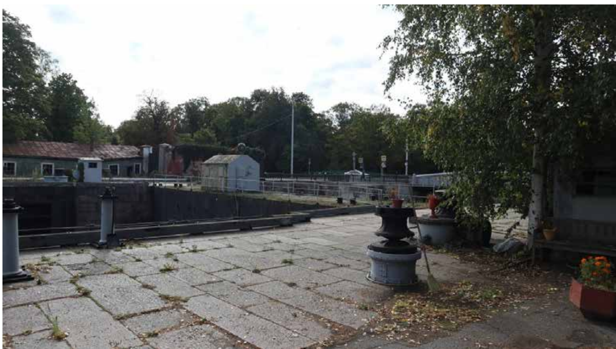
Фото 2. Вид на западную площадку южной головы дока.
