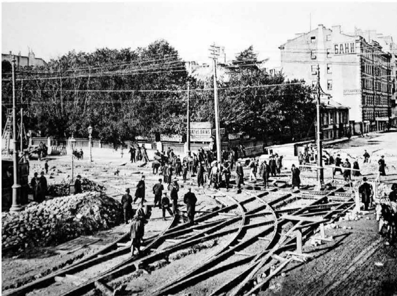
45. Укладка рельсов на перекрёстке Большого проспекта и 8-9 линии Васильевского острова. 1907 г.
