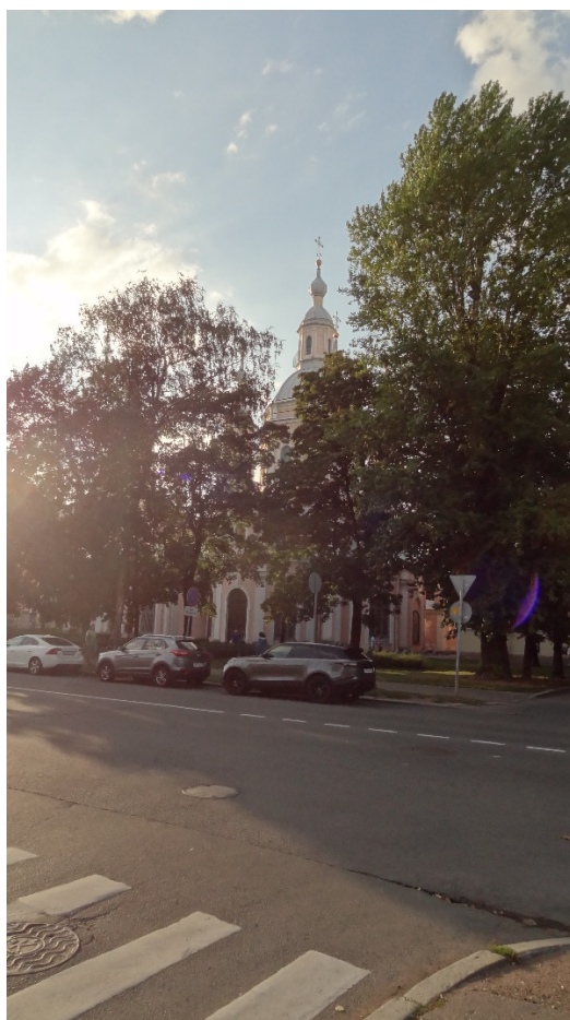
Фото 20. Зелёные насаждения и прихрамовая территория ансамбля Андреевского собора. Вид со стороны пересечения Большого проспекта В.О. и Волжского пер. Левая сторона. Дата фотофиксации: 18.08.23
