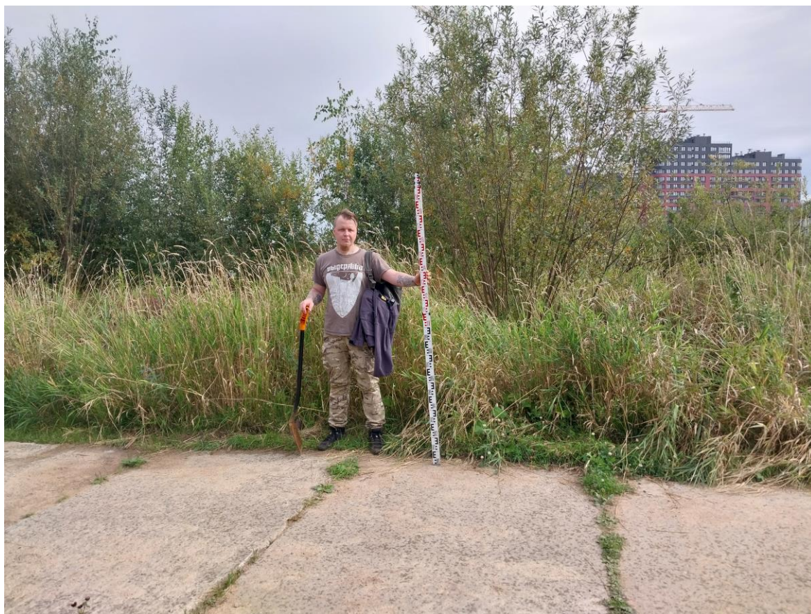
6. Территория обследования г. Санкт-Петербург, Приморский р-н. Точка фотофиксации № 2. Направление съемки восток.
