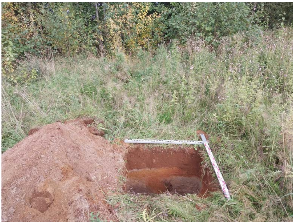
Рис. 12. г. Санкт-Петербург, Приморский район Участок обследования с кадастровым номером 78:34:0004281:74516 Шурф 1. Общий вид после проведения земляных работ Вид с юга
