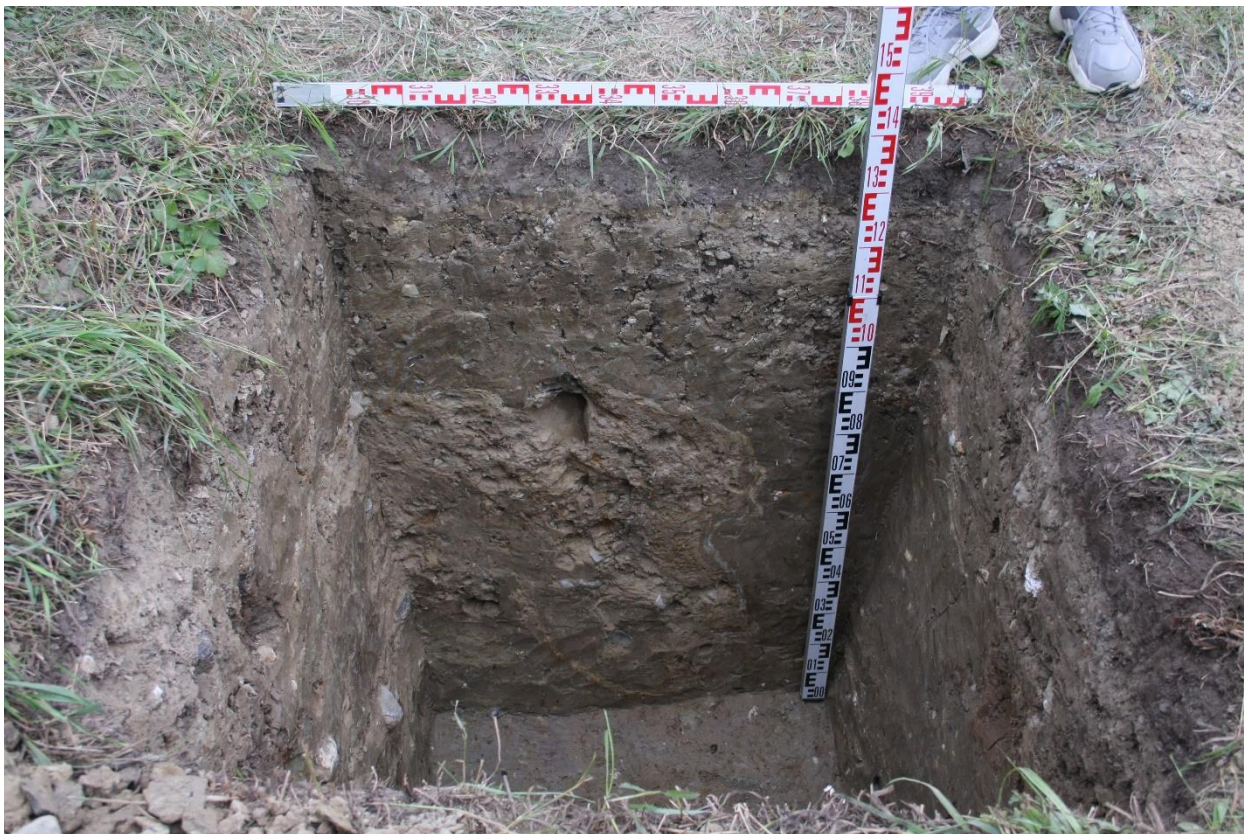
Рис. 22. Земельный участок с кадастровым номером 78:40:0009064:4873 по адресу: г. Санкт-Петербург, г. Красное Село, Родниковая улица, земельный участок 1. Шурф 1. Северная стенка.
