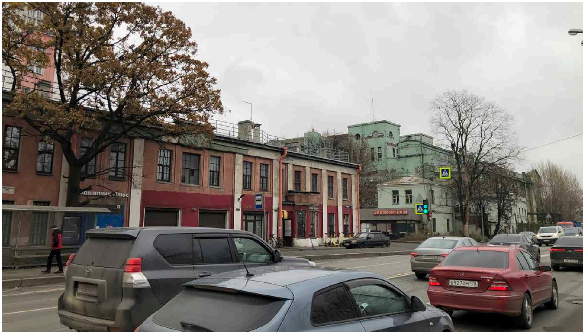
Объект культурного наследия регионального значения «ГРЭС «Красный Октябрь» (ТЭЦ № 5)» и выявленный объект культурного наследия «Здание пожарной части при ГРЭС «Красный Октябрь» (ТЭЦ № 5)». Вид с Октябрьской наб. Дата фотофиксации: 02.10.2023.
