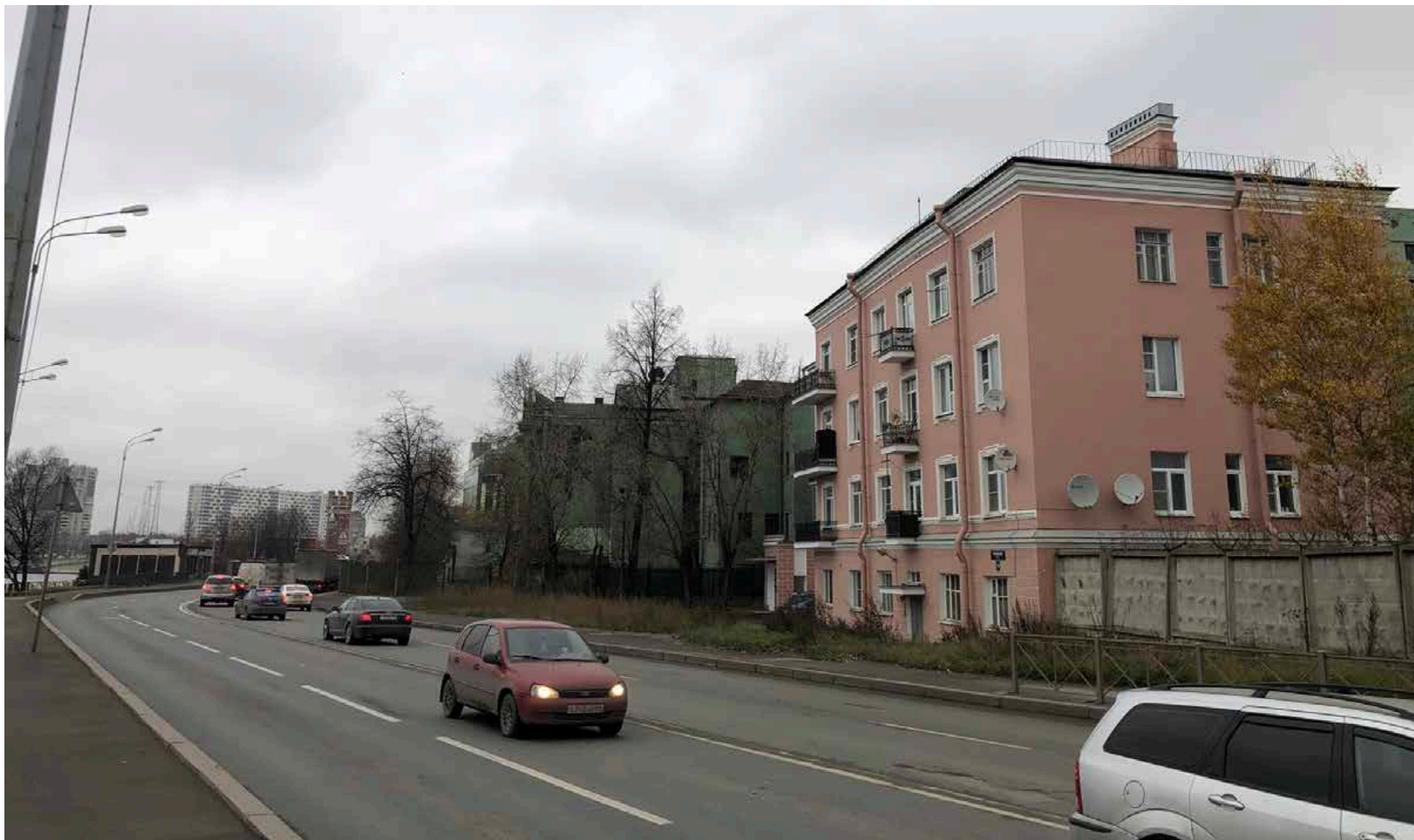
Территория, прилегающая к объекту культурного наследия регионального значения «ГРЭС «Красный Октябрь» (ТЭЦ № 5)». Вид от здания, расположенного по адресу: Октябрьской наб., д. 110, литера А, в северо-западном направлении. Дата фотофиксации: 02.10.2023.
