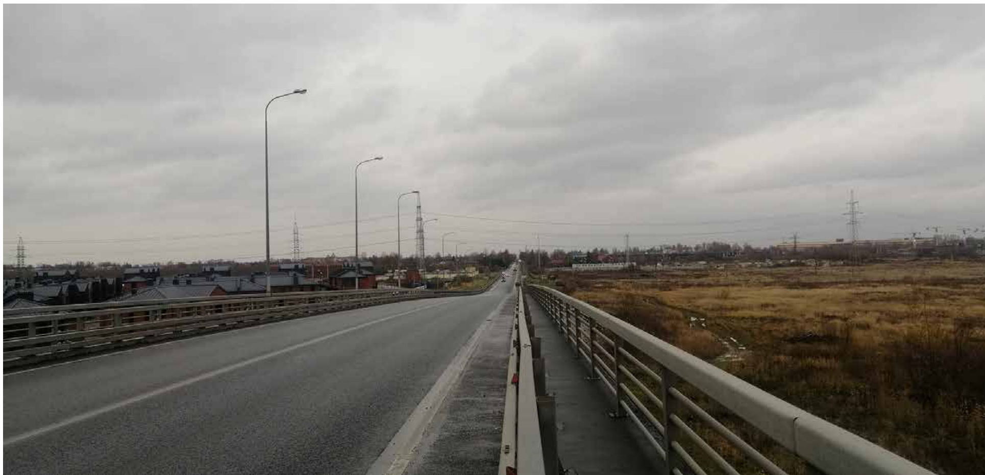
Петродворцовый район. Участок единой зоны охраняемого природного ландшафта, установленной вдоль трассы Красносельского шоссе. Вид от границы рассматриваемого участка в северном направлении. Дата фотофиксации: 03.10.2023.
