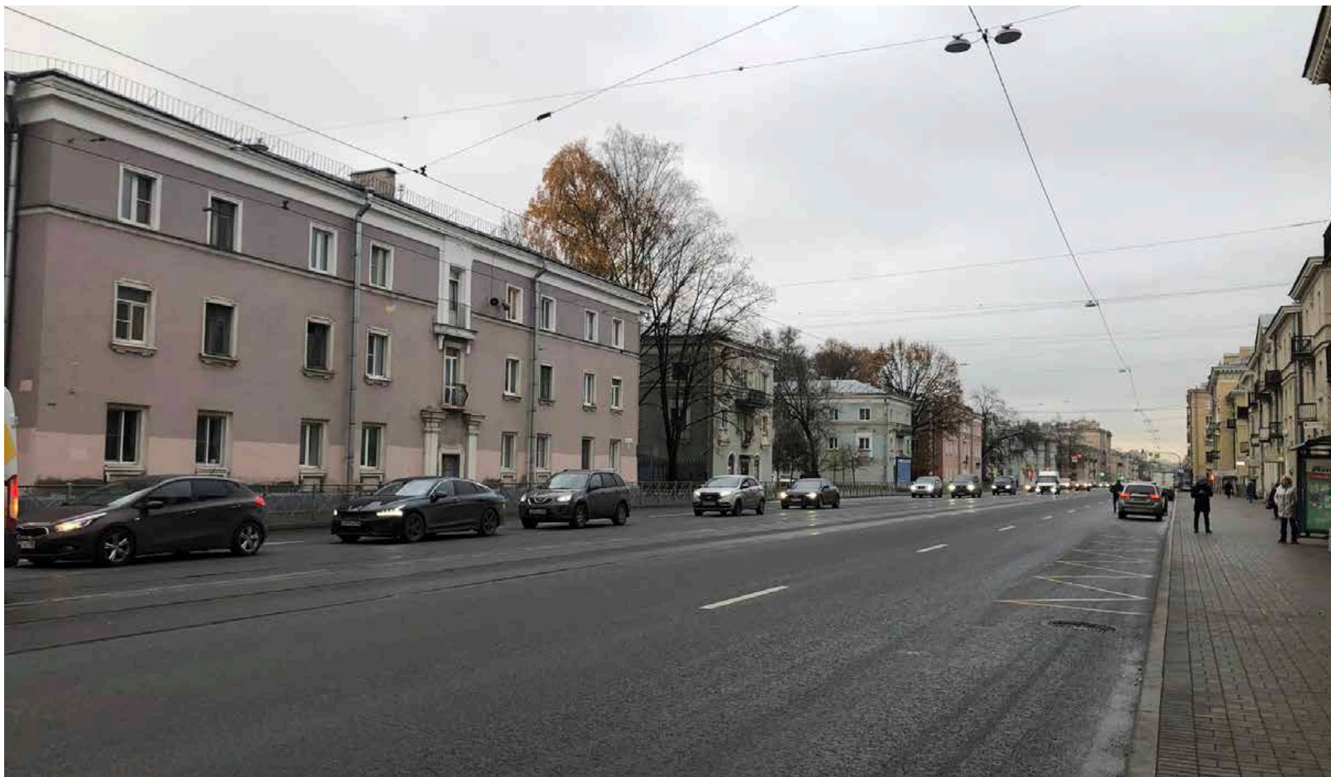
Территория, примыкающая к объекту культурного наследия регионального значения «Доходный дом П. И. Иванова» и прилегающая территория. Вид от пересечения Среднеохтинского пр. с Синявинской ул. в южном направлении. Дата фотофиксации: 02.10.2023.
