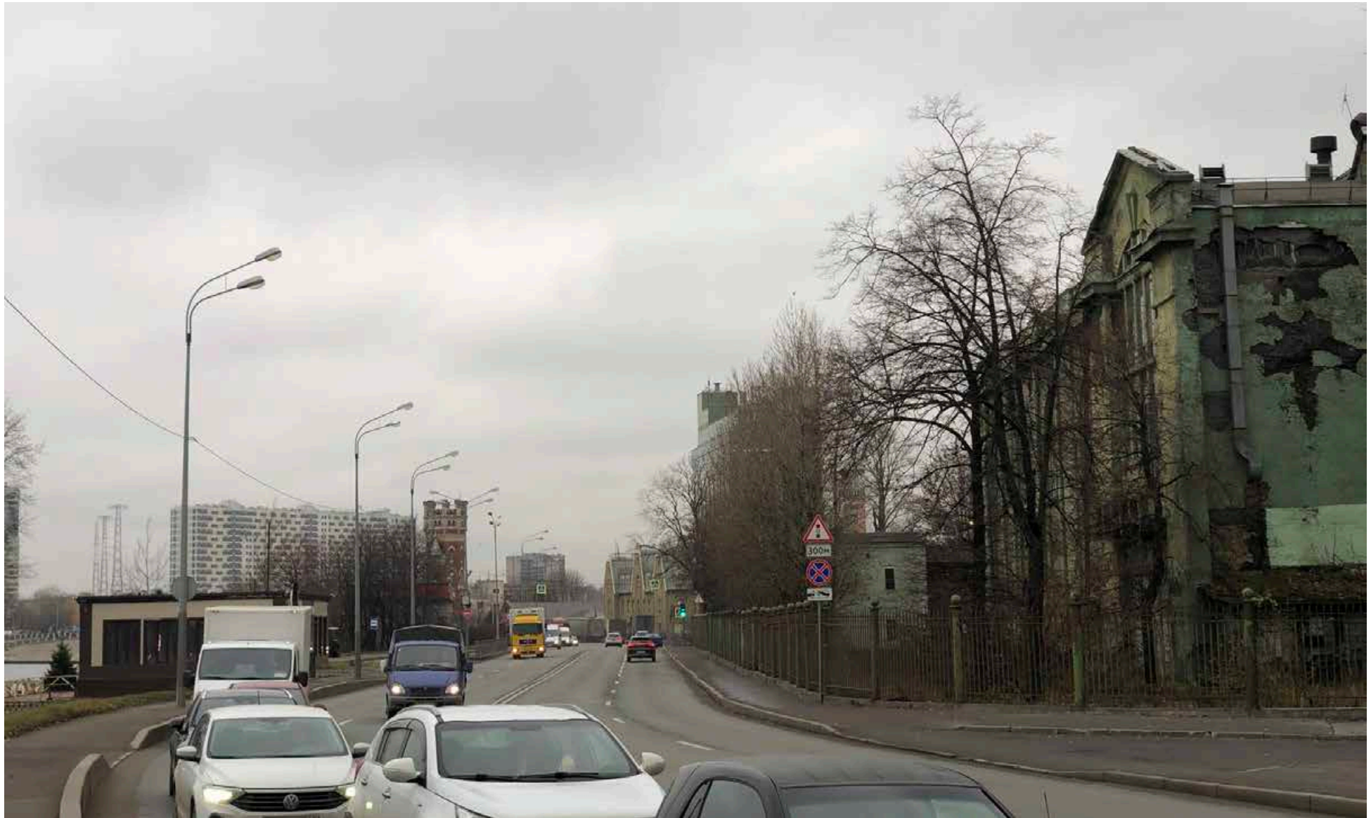
Объект культурного наследия регионального значения «ГРЭС «Красный Октябрь» (ТЭЦ № 5)» с прилегающей территорией. Вид вдоль Октябрьской наб. в северном направлении. Дата фотофиксации: 02.10.2023.
