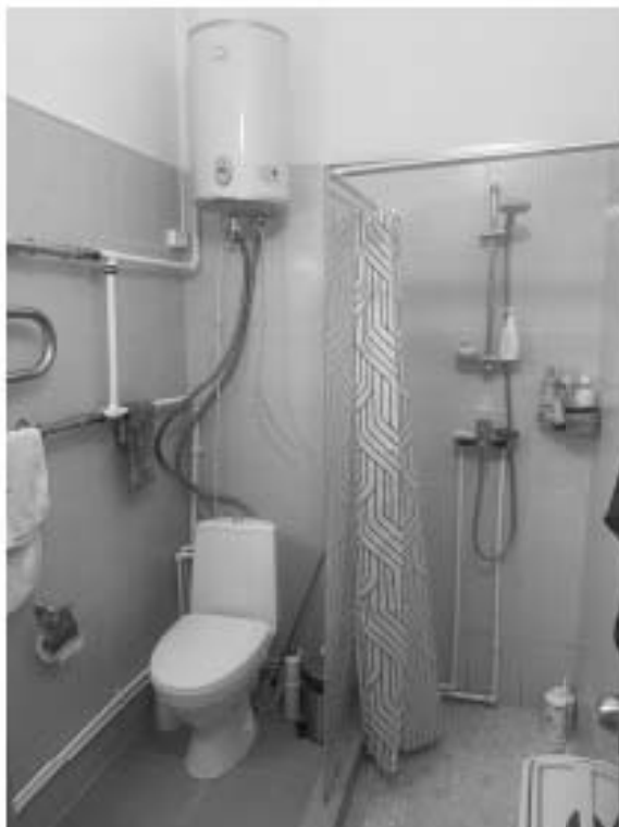
12. Совмещенный санузел квартиры №25 (часть помещения 9)
