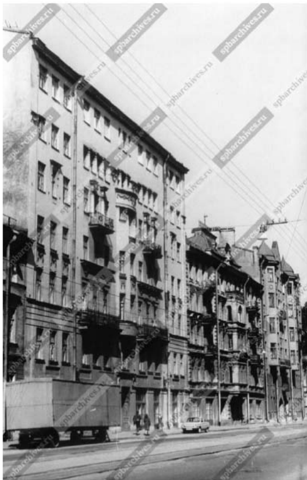
15. Перспектива 9-й линии Васильевского острова по линии жилых домов № 54-58 (слева направо). Дата съёмки: 12 июня 1987 г. ЦГАКФФД СПб Ар 217316
