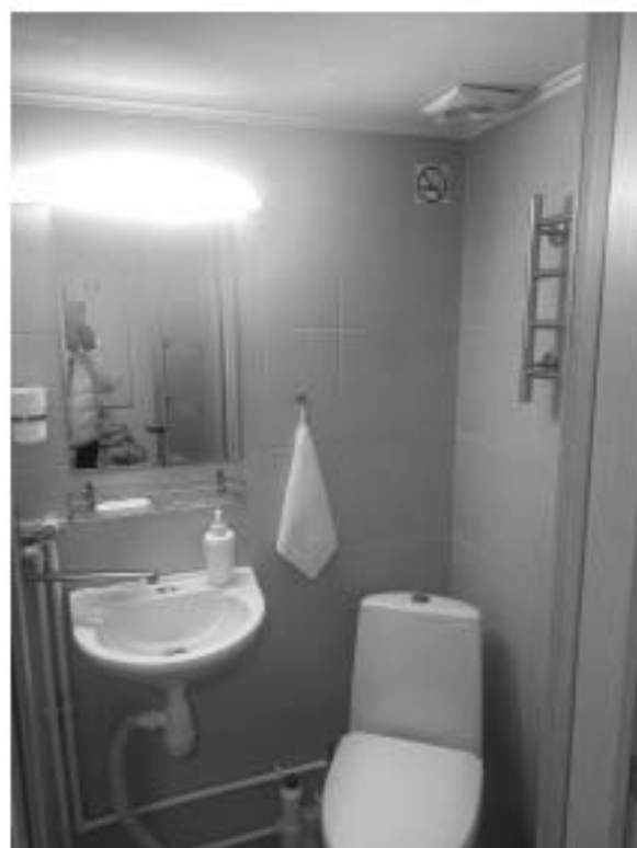
9. Совмещенный санузел квартиры №25 (часть помещения 4)
