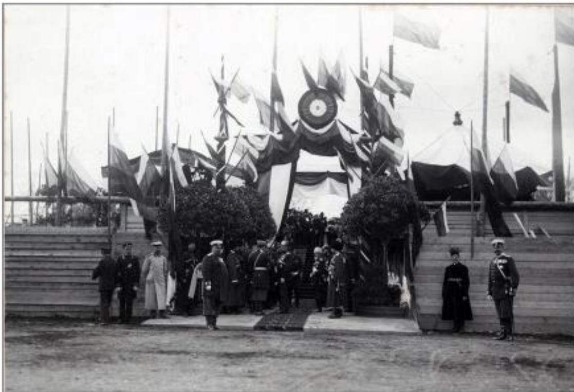
6. Царское Село. Торжественная закладка здания Реального училища 5 мая 1901 г. Фотография. https://www.citywalls.ru/photo101778.htmls=iiovfgniub05613muari9uqq2sb
