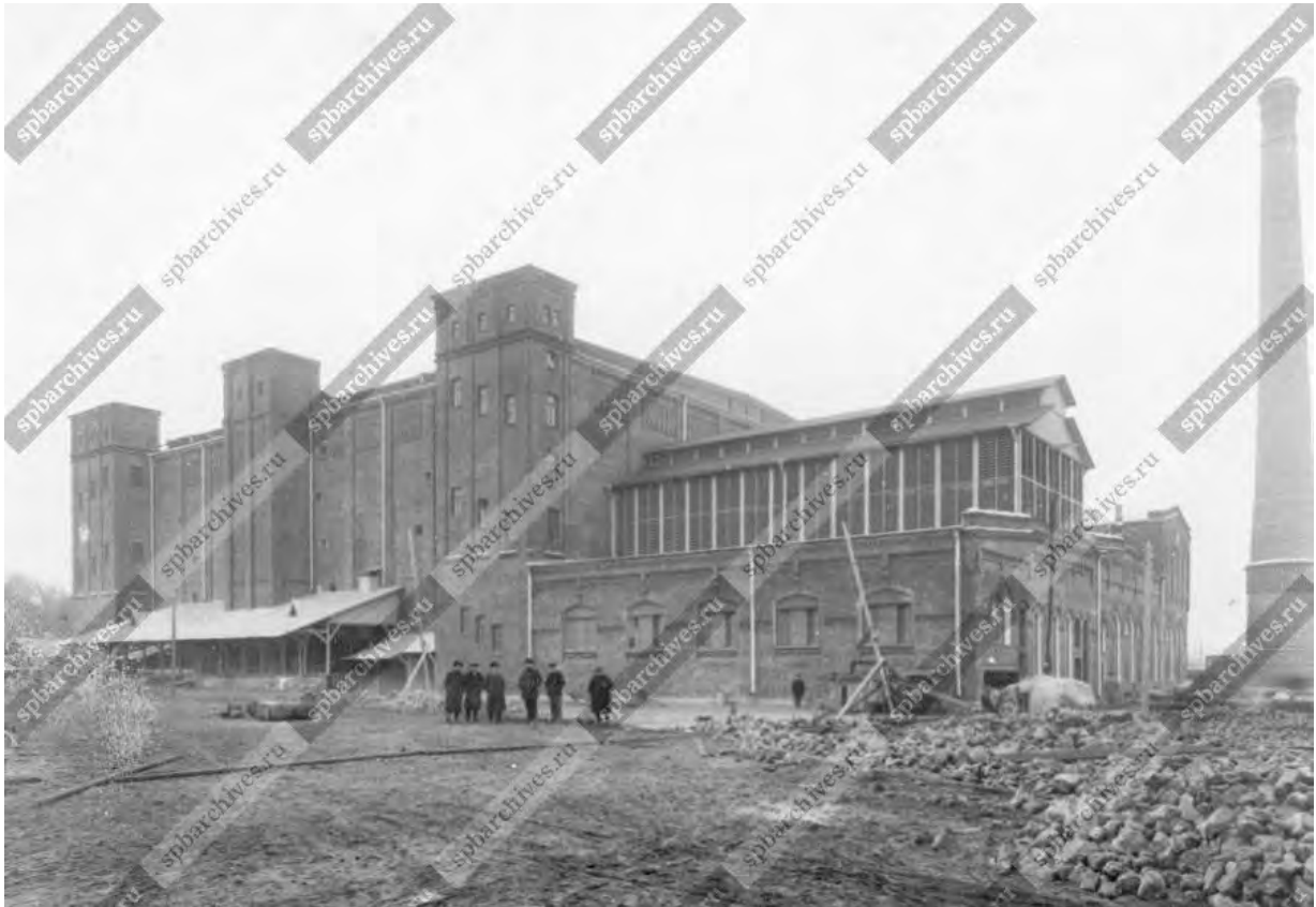
20. Новое здание склада-холодильника акционерного общества Петербургских товарных складов, холодильников и элеваторов – "завод льда" с суточным производством 4 тысячами пудов. Фотография ателье К.К. Буллы. 1913 г. // Источник: ЦГАКФФД СПб Фотодокумент Е 13744.
