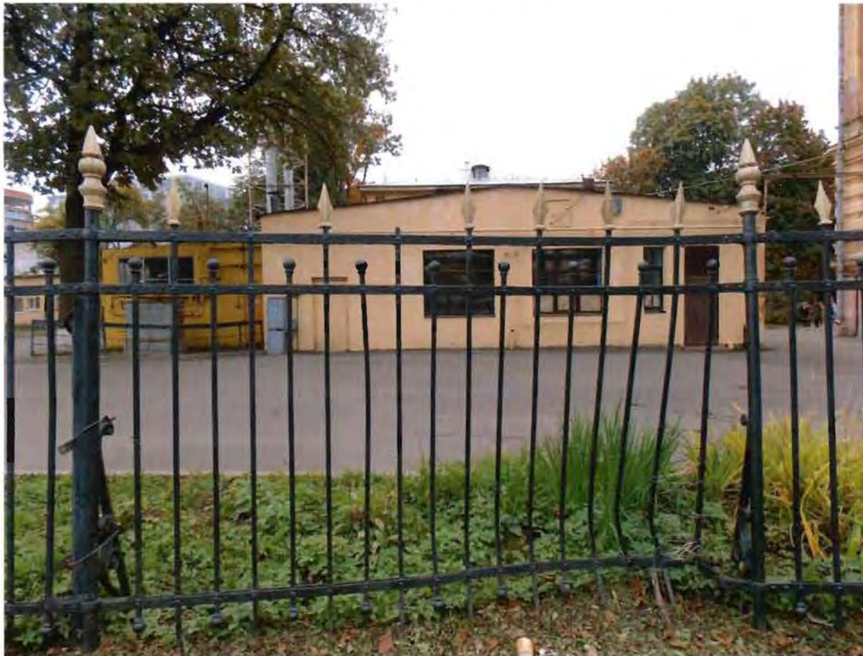
1. Фрагмент объекта культурного наследия. Вид с ул. Черниговская.
