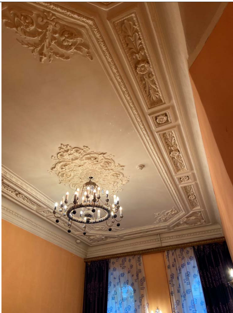
14. Дом Н.В.Чайковского. Помещение 2 этажа. Фрагмент.
