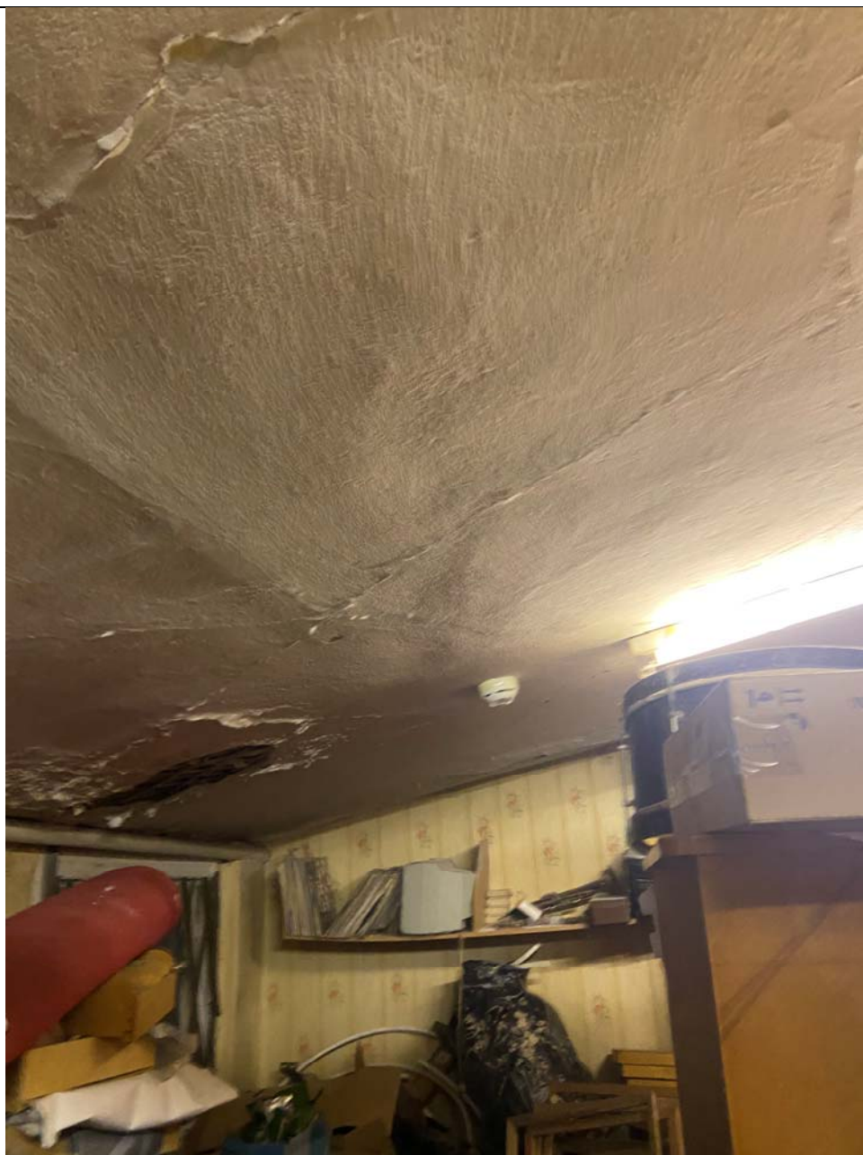
20. Дом Н.В. Чайковского. Помещения подвала. Фрагмент.
