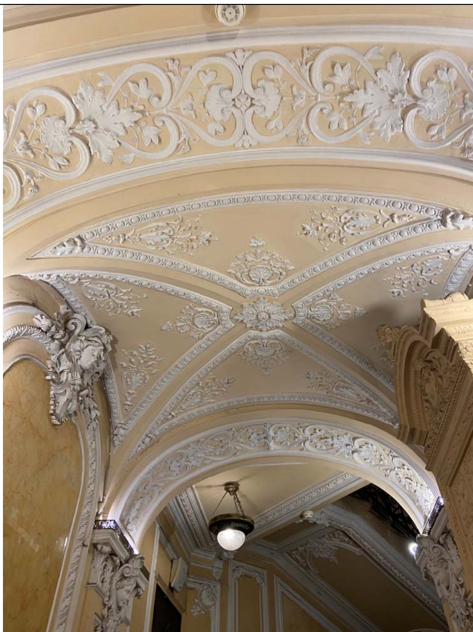
3. Дом Н.В.Чайковского. Оформление сводчатых перекрытий парадного входа.
