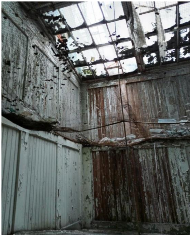
62. Объект культурного наследия федерального значения «Усадьба Демидовых» по адресу: г. Санкт-Петербург, пер. Гривцова, д. 5, лит. А (Гривцова пер., 1). Главный дом. Световой фонарь. Конструкции. Над помещение 3(Г)-9
