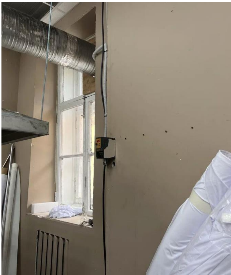
81. Объект культурного наследия федерального значения «Усадьба Демидовых» по адресу: г. Санкт-Петербург, пер. Гривцова, д. 5, лит. А (Гривцова пер., 1). Кегельбан. Фрагмент интерьера. Обшивка стен листами ГКЛ. Помещение 1(К)-9
