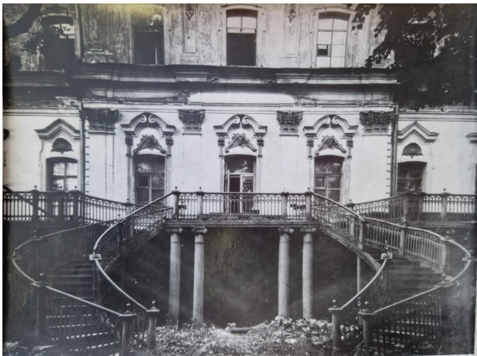
16. Усадьба Демидова. Главный дом. Садовый фасад. С фотографии 1910-1912 гг. (?). ЦГА НТД СПб. Ф. 488. Оп. 3-1. Д. 115. Л. 14.
