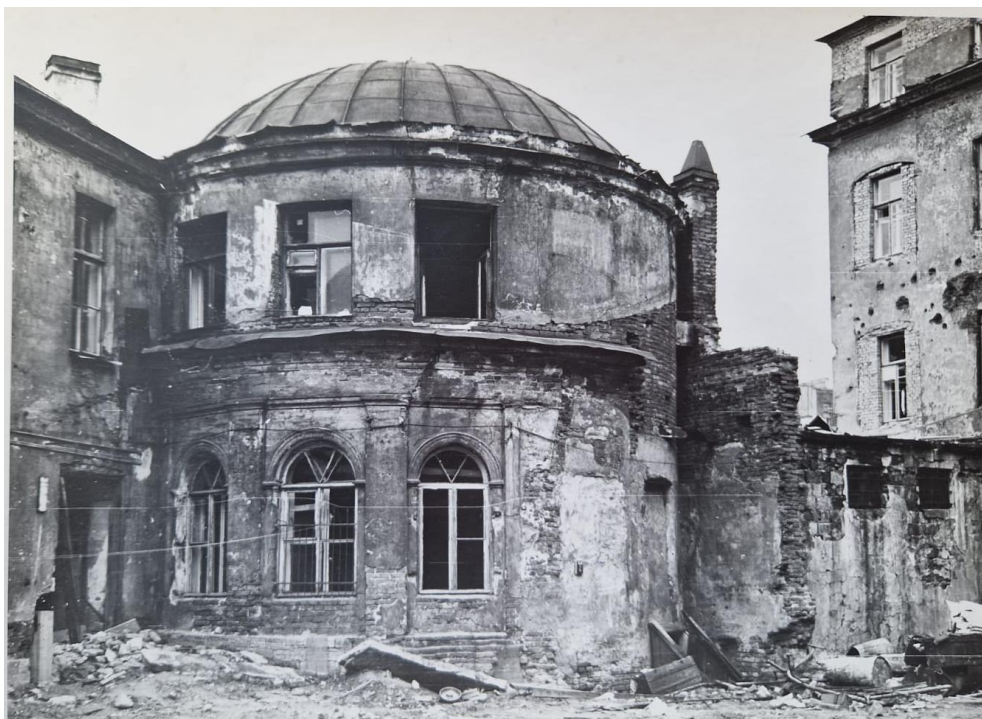
41. Усадьба Демидовых. Фрагмент южного фасада корпуса, находящегося на южной стороне большого двора. Фотография. 1964 г. ЦГА НТД СПб. Ф. 488. Оп. 3-1. Д. 115. Л. 25.
