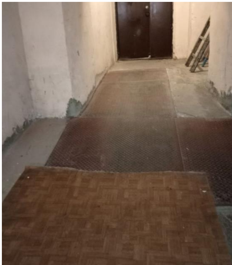
29. Объект культурного наследия федерального значения «Усадьба Демидовых» по адресу: г. Санкт-Петербург, пер. Гривцова, д. 5, лит. А (Гривцова пер., 1). Главный дом. Первый этаж. Коридор. Фрагмент интерьера. Бетонный пол, паркет в коридоре первого этажа. Помещение 1(Г)-50
