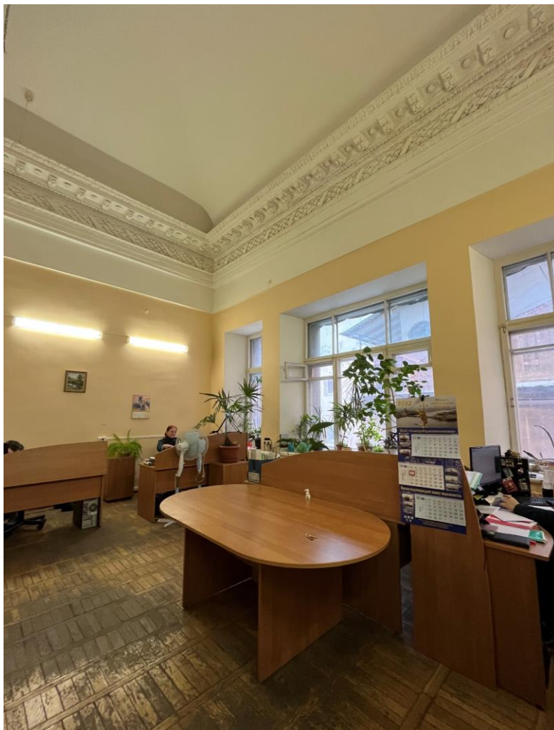
49. Объект культурного наследия федерального значения «Усадьба Демидовых» по адресу: г. Санкт-Петербург, пер. Гривцова, д. 5, лит. А (Гривцова пер., 1). Главный дом. Помещение второго этажа. Общий вид. Помещение 2(Г)-28
