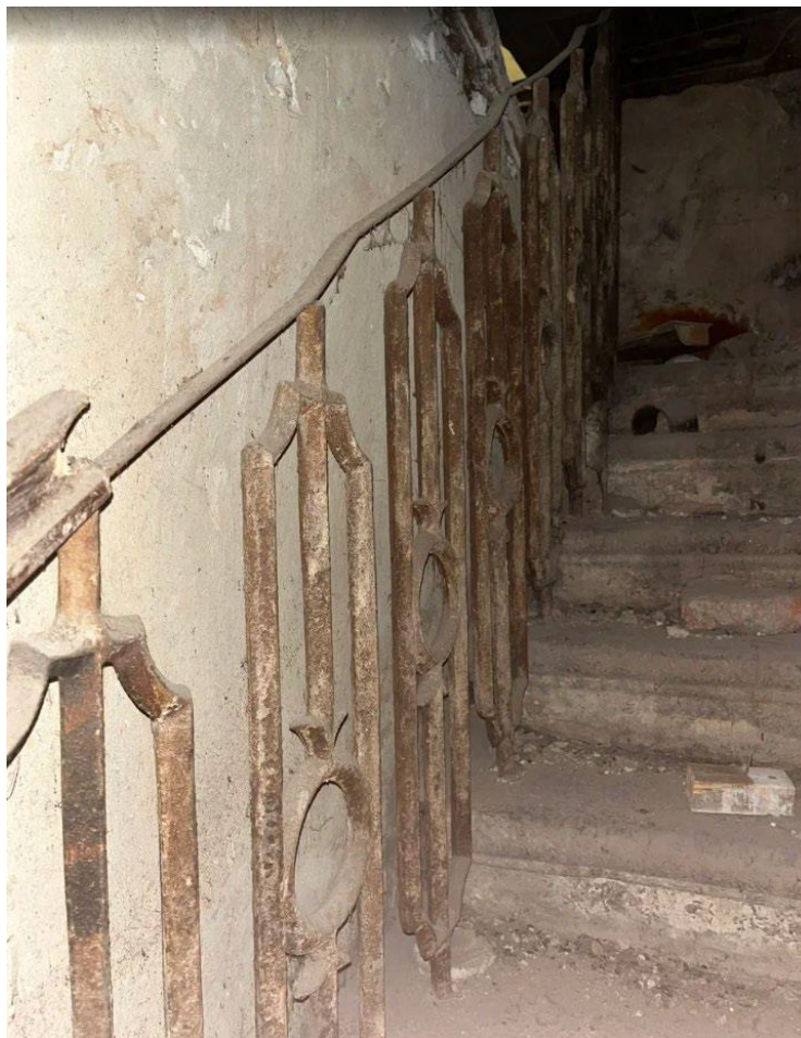
21. Объект культурного наследия федерального значения «Усадьба Демидовых» по адресу: г. Санкт-Петербург, пер. Гривцова, д. 5, лит. А (Гривцова пер., 1). Главный дом. Служебная лестница. Лестница ЛЗ. Ограждения и ступени лестничного марша
