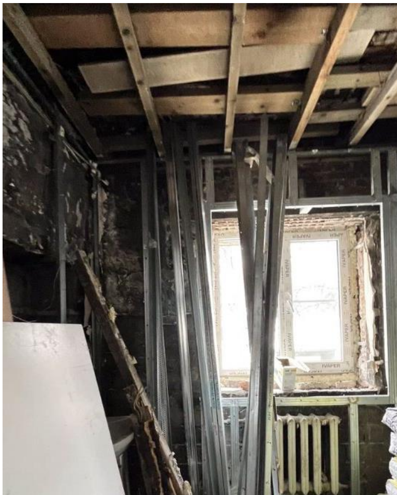
78. Объект культурного наследия федерального значения «Усадьба Демидовых» по адресу: г. Санкт-Петербург, пер. Гривцова, д. 5, лит. А (Гривцова пер., 1). Восточный флигель. Помещение первого этаж. Фрагмент интерьера. Помещение 1(В)-14
