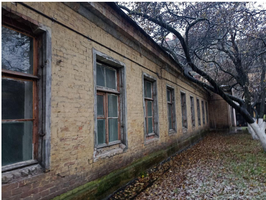
7. Объект культурного наследия федерального значения «Усадьба Демидовых» по адресу: г. Санкт-Петербург, пер. Гривцова, д. 5, лит. А (Гривцова пер., 1). Кегельбан восточный фасад
