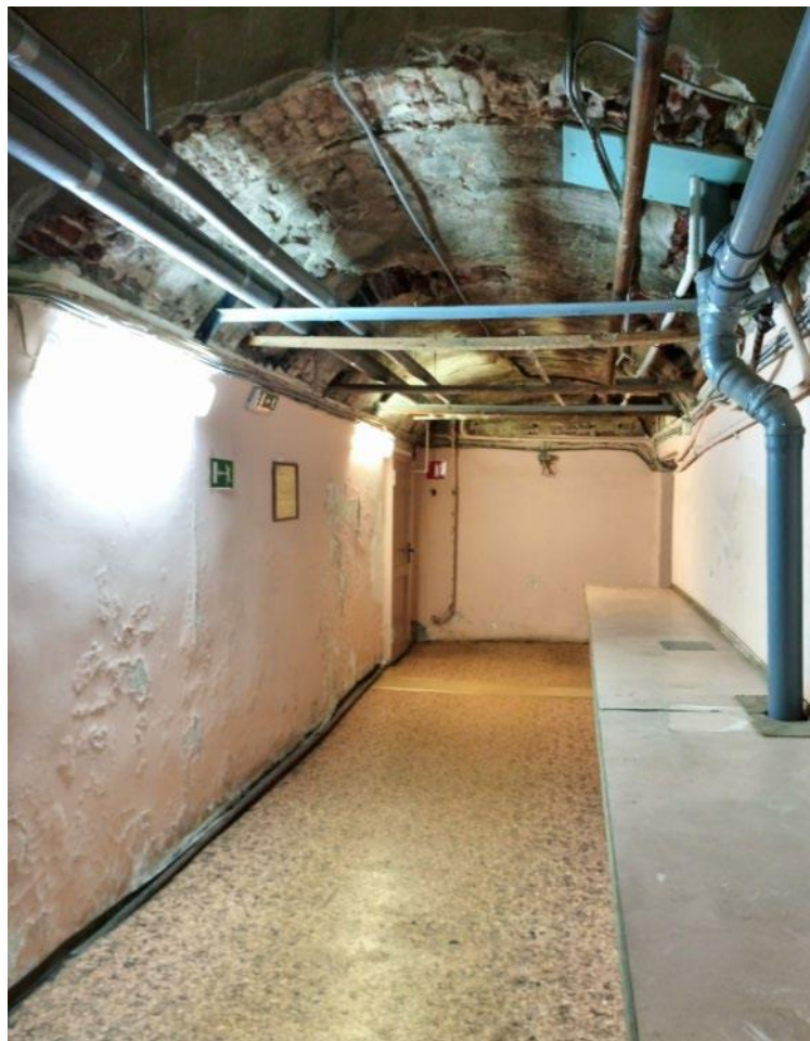
28. Объект культурного наследия федерального значения «Усадьба Демидовых» по адресу: г. Санкт-Петербург, пер. Гривцова, д. 5, лит. А (Гривцова пер., 1). Главный дом. Первый этаж. Коридор. Общий вид. Помещение 1(Г)-15
