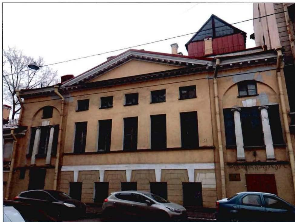
1. Общий вид восточного фасада объекта культурного наследия.
