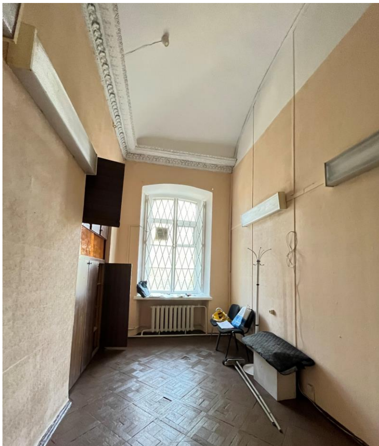
52. Объект культурного наследия федерального значения «Усадьба Демидовых» по адресу: г. Санкт-Петербург, пер. Гривцова, д. 5, лит. А (Гривцова пер., 1). Главный дом. Помещение второго этажа. Общий вид. Помещение 2(Г)-15
