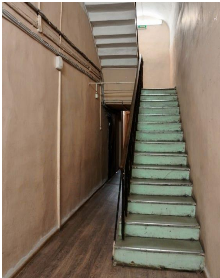
23. Объект культурного наследия федерального значения «Усадьба Демидовых» по адресу: г. Санкт-Петербург, пер. Гривцова, д. 5, лит. А (Гривцова пер., 1). Главный дом. Служебная лестница. Лестница ЛЗ в уровне второго этажа
