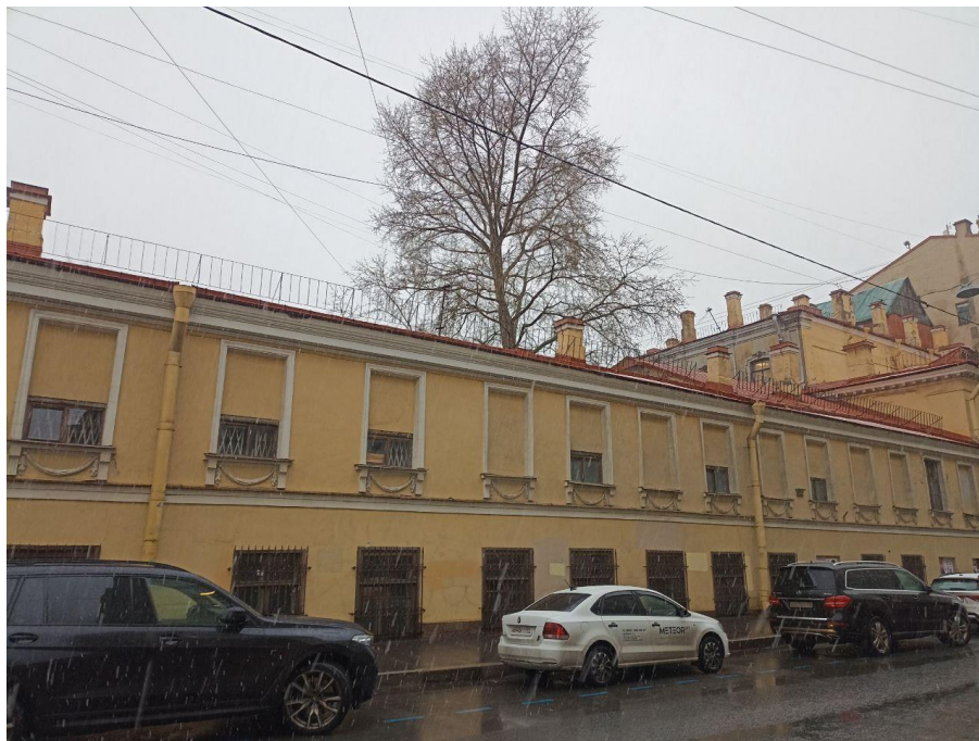
5. Объект культурного наследия федерального значения «Усадьба Демидовых» по адресу: г. Санкт-Петербург, пер. Гривцова, д. 5, лит. А (Гривцова пер., 1). Восточный флигель. Фасад со стороны Гривцова
