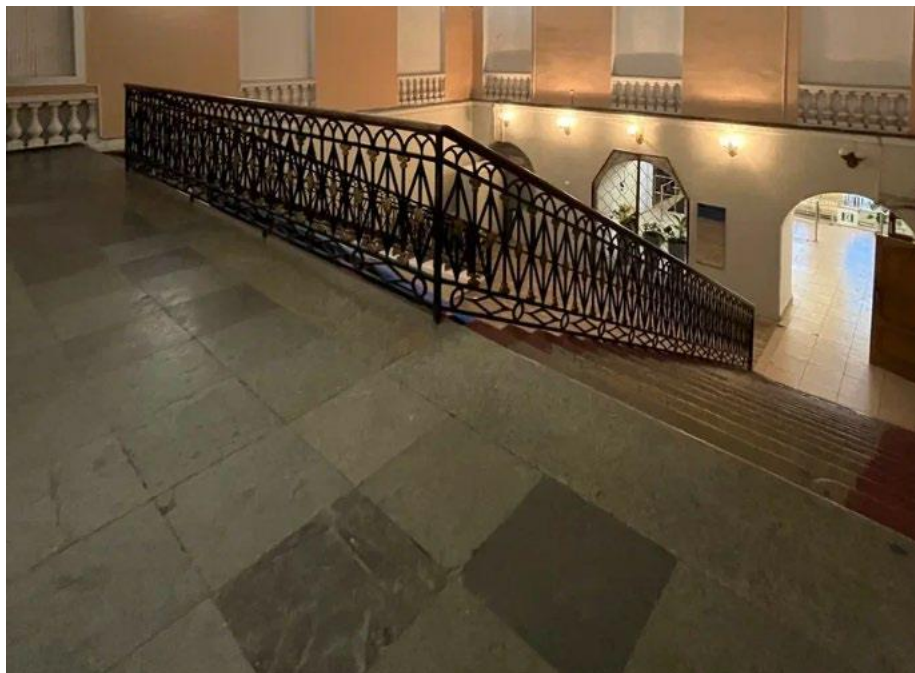
15. Объект культурного наследия федерального значения «Усадьба Демидовых» по адресу: г. Санкт-Петербург, пер. Гривцова, д. 5, лит. А (Гривцова пер., 1). Главный дом. Парадная лестница (Л1).Общий вид с площадки второго этажа. Помещение 1(Г)-6
