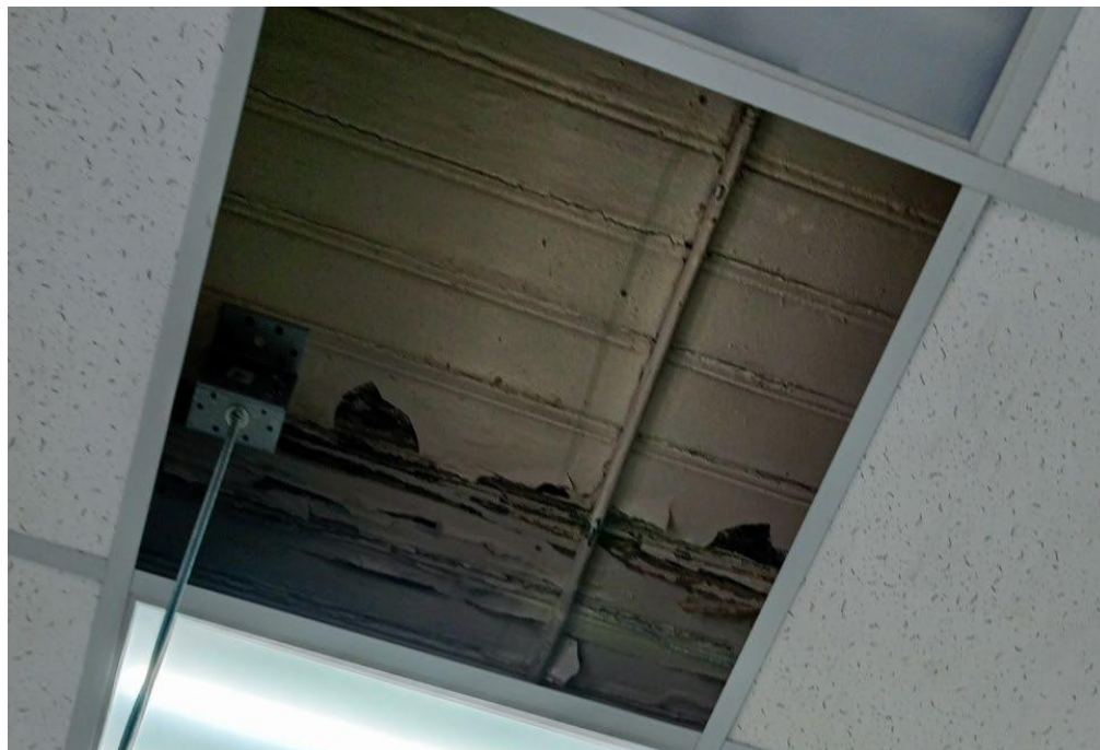
82. Объект культурного наследия федерального значения «Усадьба Демидовых» по адресу: г. Санкт-Петербург, пер. Гривцова, д. 5, лит. А (Гривцова пер., 1). Кегельбан. Фрагмент интерьера. Подшивка потолка
