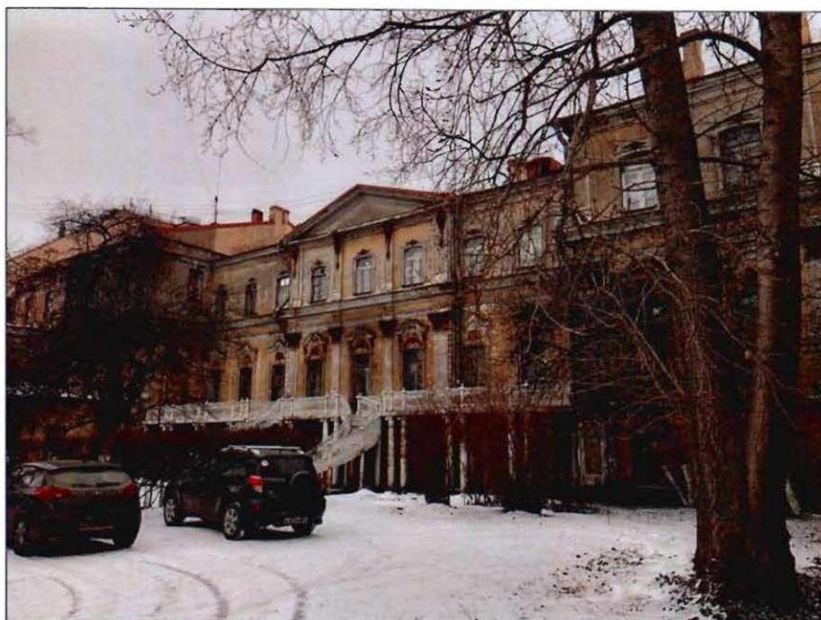
2. Общий вид на южный фасад объекта культурного наследия.
