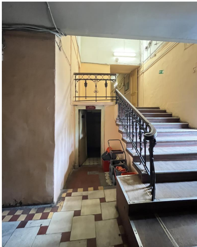
73. Объект культурного наследия федерального значения «Усадьба Демидовых» по адресу: г. Санкт-Петербург, пер. Гривцова, д. 5, лит. А (Гривцова пер., 1). Западный флигель. Помещение первого этажа.Общий вид. Помещение 1(3)-2
