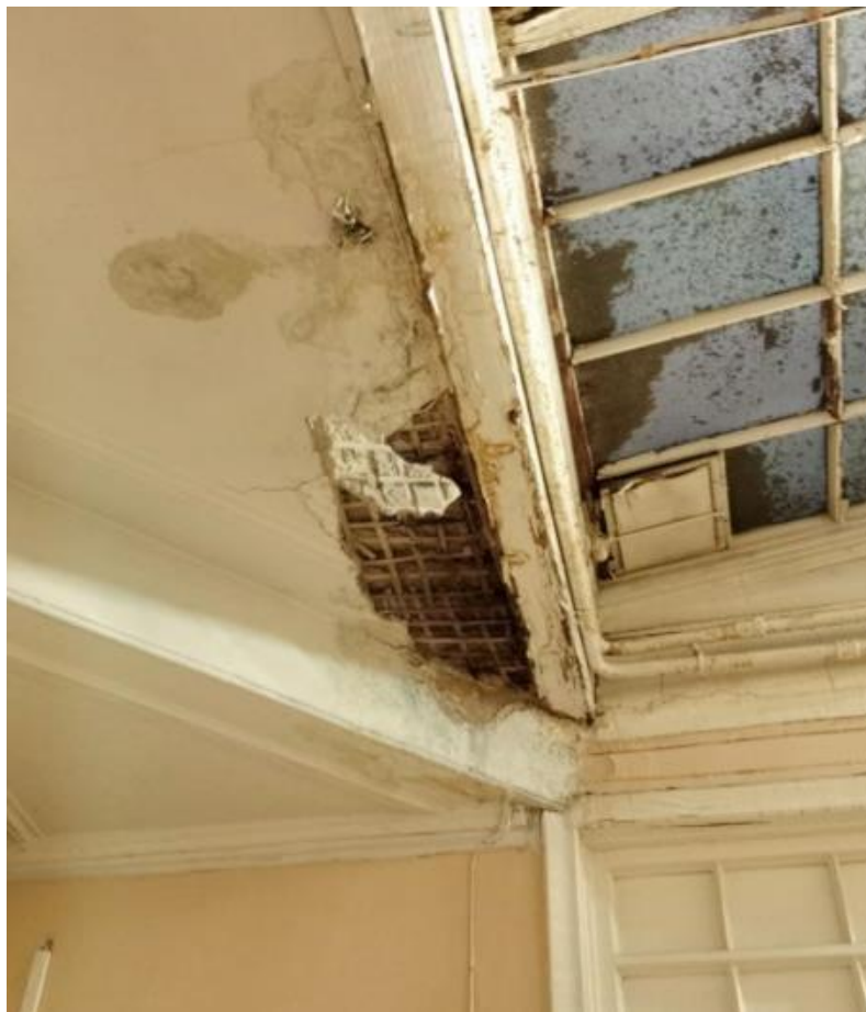
61. Объект культурного наследия федерального значения «Усадьба Демидовых» по адресу: г. Санкт-Петербург, пер. Гривцова, д. 5, лит. А (Гривцова пер., 1). Главный дом. Второй этаж. Помещение библиотеки. Перекрытие и световой фонарь. Фрагмент. Помещение 3(Г)-9
