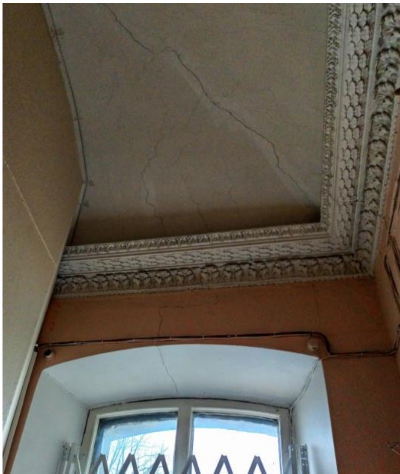
42. Объект культурного наследия федерального значения «Усадьба Демидовых» по адресу: г. Санкт-Петербург, пер. Гривцова, д. 5, лит. А (Гривцова пер., 1). Главный дом. Второй этаж. Коридор. Фрамент интерьера. Помещение 2(Г)-17. Лепной антаблемент
