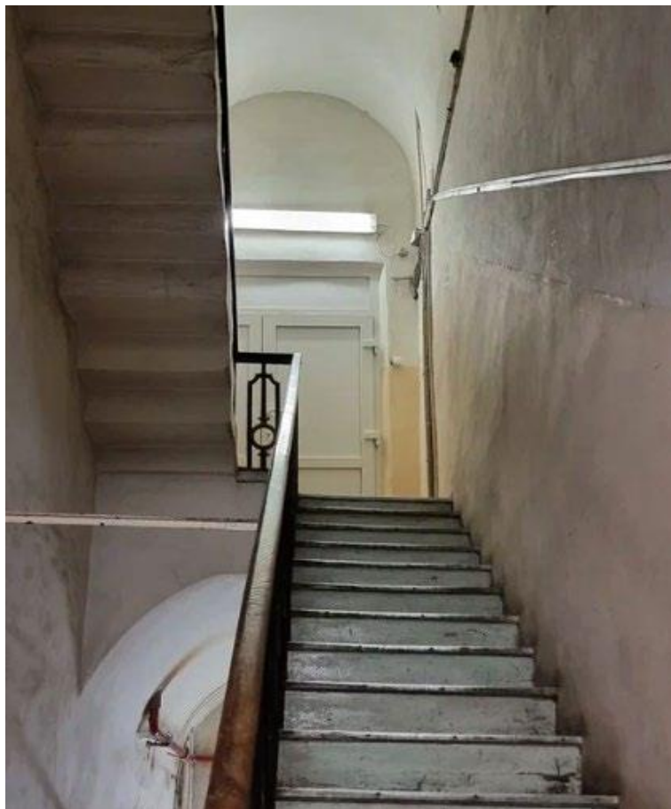
24. Объект культурного наследия федерального значения «Усадьба Демидовых» по адресу: г. Санкт-Петербург, пер. Гривцова, д. 5, лит. А (Гривцова пер., 1). Главный дом. Службная лестница. Лестница ЛЗ. Марши в уровне третьего этажа
