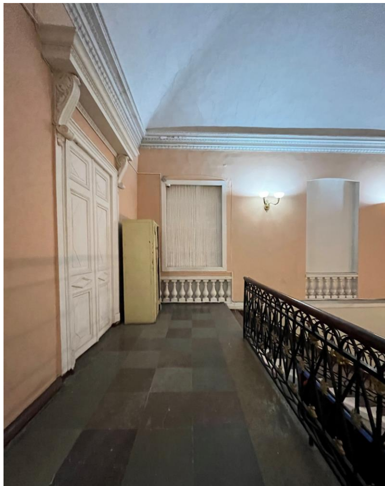
17. Объект культурного наследия федерального значения «Усадьба Демидовых» по адресу: г. Санкт-Петербург, пер. Гривцова, д. 5, лит. А (Гривцова пер., 1). Главный дом. Парадная лестница (Л1). Площадка второго этажа. Помещение 1(Г)-б
