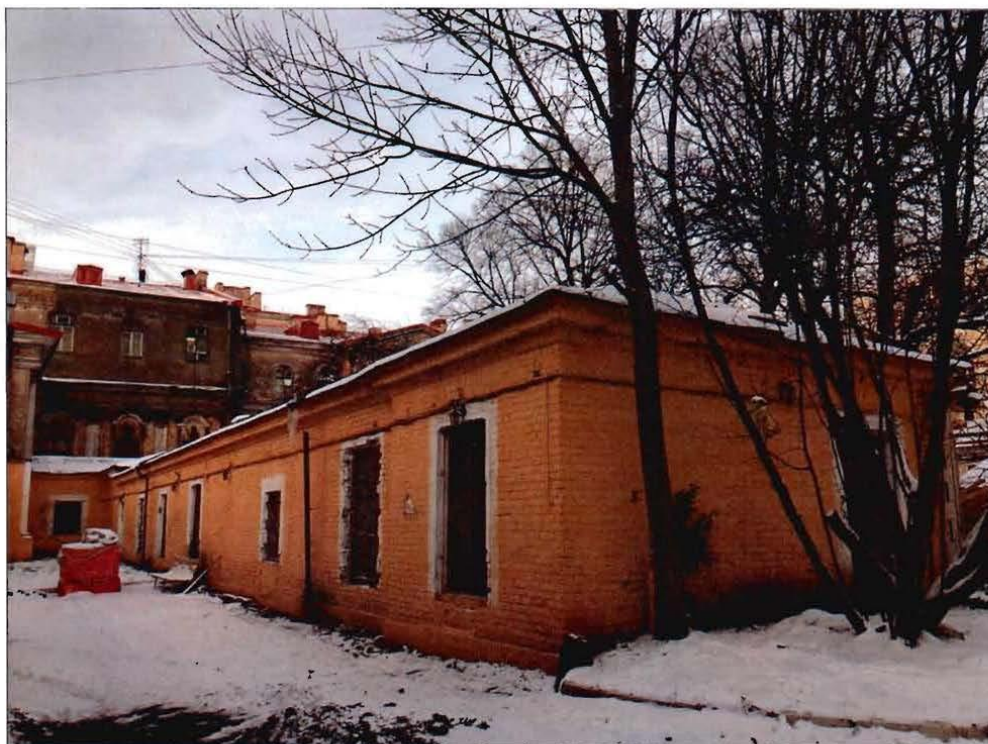
2. Общий вид на объект культурного наследия с юго-запада.
