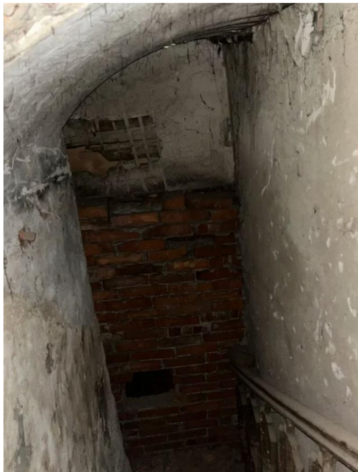
22. Объект культурного наследия федерального значения «Усадьба Демидовых» по адресу: г. Санкт-Петербург, пер. Гривцова, д. 5, лит. А (Гривцова пер., 1). Главный дом. Служебная лестница. Лестница ЛЗ. Закладка лестничной клетки в уровне первого этажа
