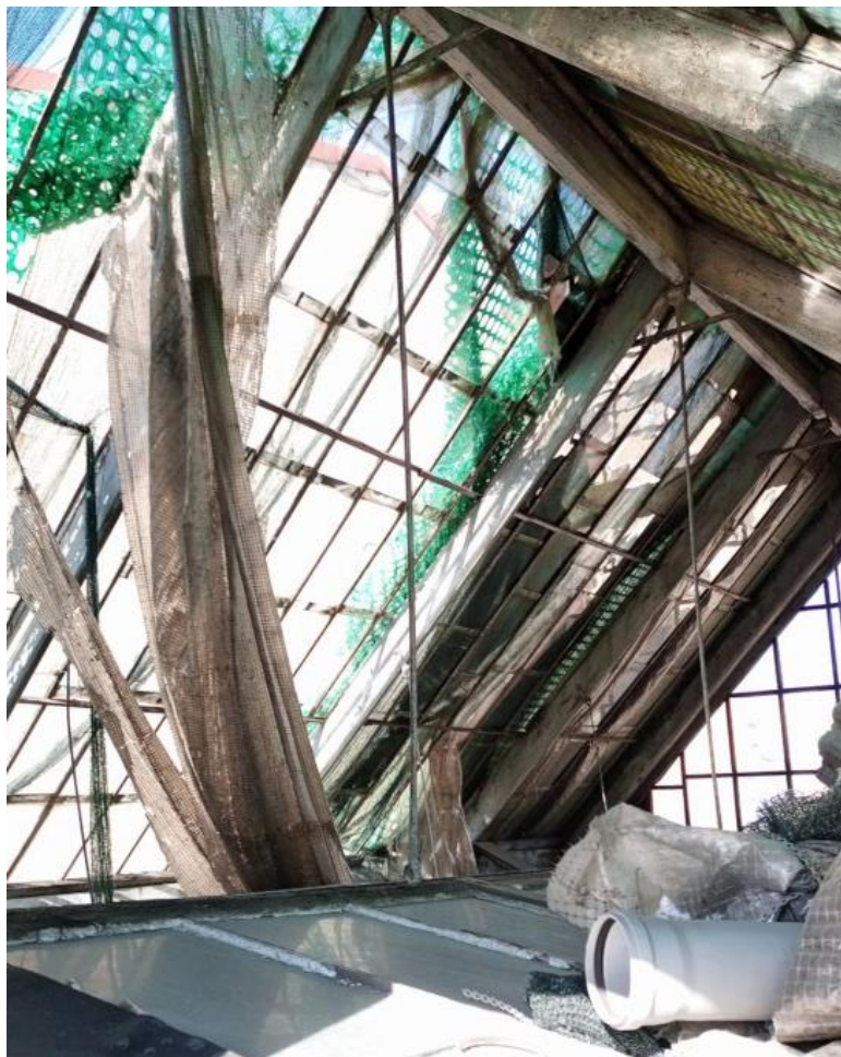
65. Объект культурного наследия федерального значения «Усадьба Демидовых» по адресу: г. Санкт-Петербург, пер. Гривцова, д. 5, лит. А (Гривцова пер., 1). Главный дом. Световой фонарь. Второй и третий ярусы остекления
