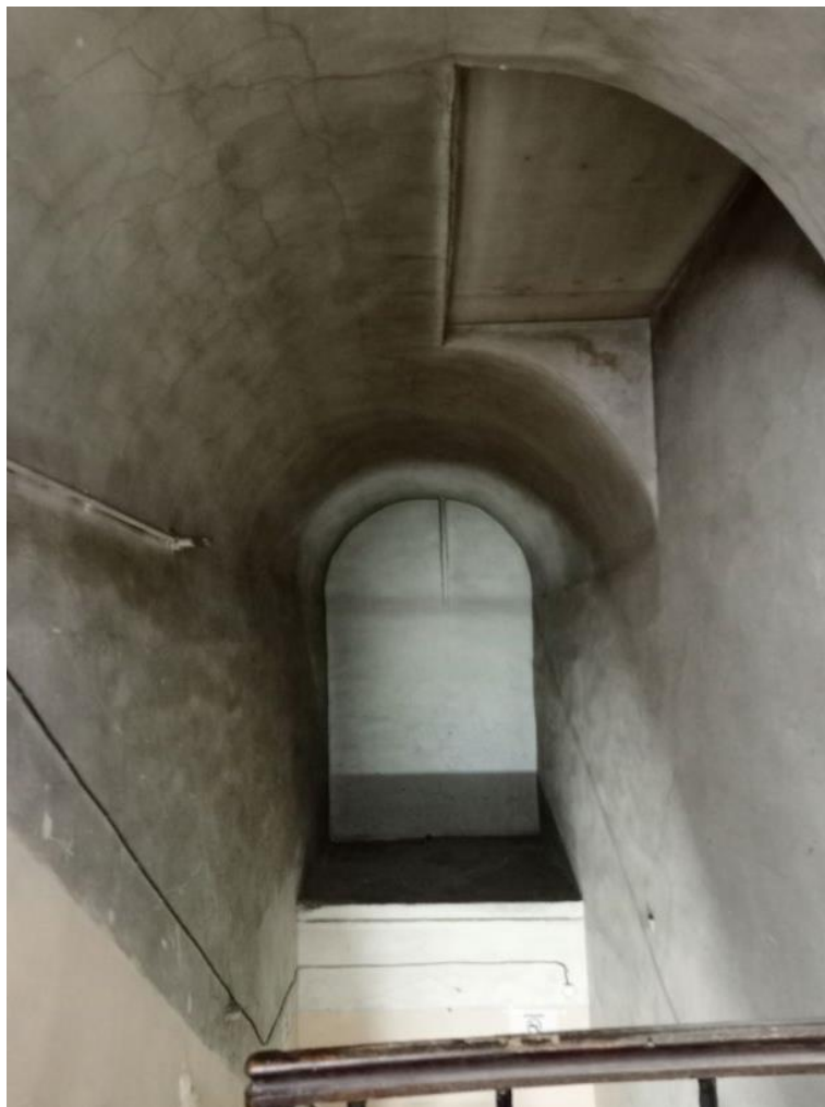
44. Объект культурного наследия федерального значения «Усадьба Демидовых» по адресу: г. Санкт-Петербург, пер. Гривцова, д. 5, лит. А (Гривцова пер., 1). Главный дом. Второй этаж. Свод перекрытия лестничной клетки
