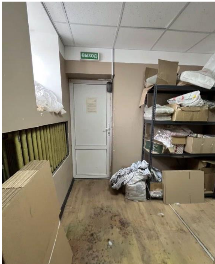
76. Объект культурного наследия федерального значения «Усадьба Демидовых» по адресу: г. Санкт-Петербург, пер. Гривцова, д. 5, лит. А (Гривцова пер., 1). Восточный флигель. Помещение цокольного этажа. Фрагмент интерьера (облицовка стен листами ГКЛ). Помещение 0(В)-2
