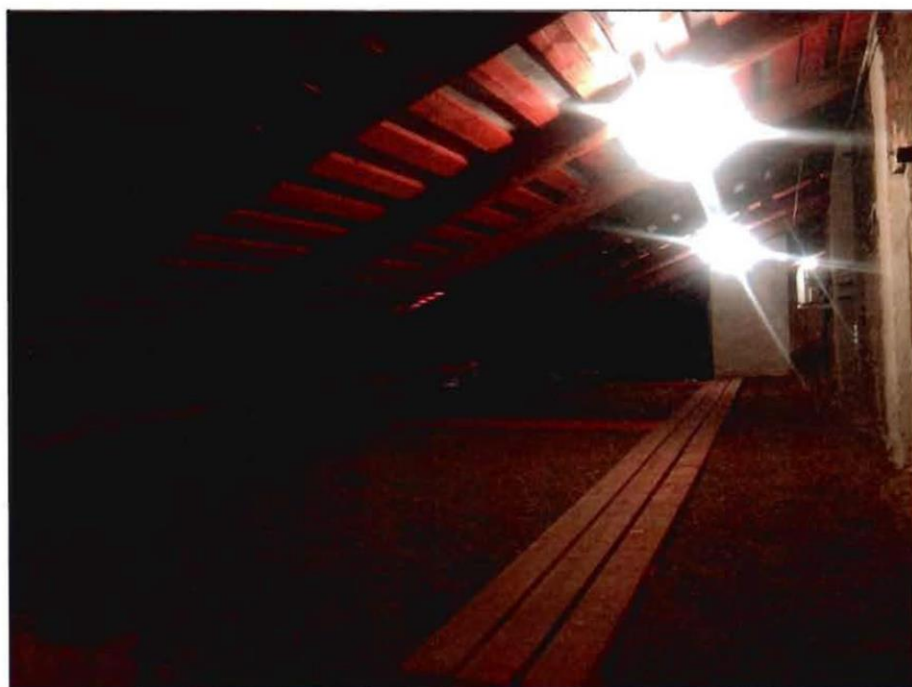
3. Стропильная система объекта культурного наследия.
