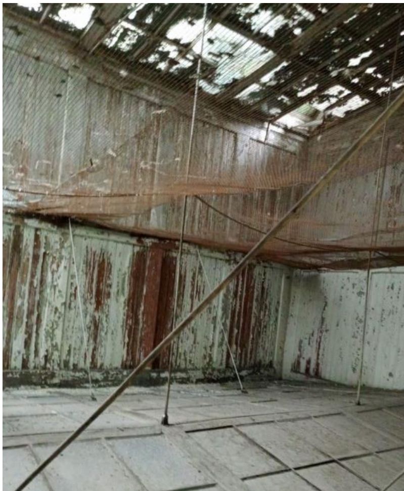
63. Объект культурного наследия федерального значения «Усадьба Демидовых» по адресу: г. Санкт-Петербург, пер. Гривцова, д. 5, лит. А (Гривцова пер., 1). Главный дом. Световой фонарь. Конструкции. Над помещением 3(Г)-9
