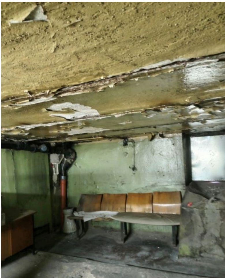
72. Объект культурного наследия федерального значения «Усадьба Демидовых» по адресу: г. Санкт-Петербург, пер. Гривцова, д. 5, лит. А (Гривцова пер., 1). Западный флигель. Помещение первого этажа. Общий вид. Помещение 1(3)-3
