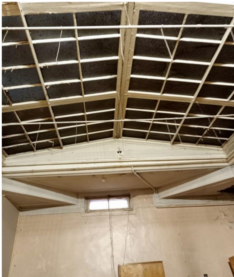
60. Объект культурного наследия федерального значения «Усадьба Демидовых» по адресу: г. Санкт-Петербург, пер. Гривцова, д. 5, лит. А (Гривцова пер., 1). Главный дом. Второй этаж. Помещение библиотеки. Перекрытие и световой фонарь. Общий вид. Помещение 3(Г)-9
