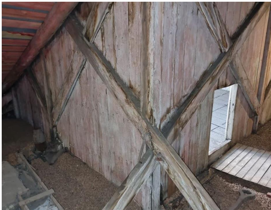
64. Объект культурного наследия федерального значения «Усадьба Демидовых» по адресу: г. Санкт-Петербург, пер. Гривцова, д. 5, лит. А (Гривцова пер., 1). Главный дом. Световой фонарь. Вид на стены
