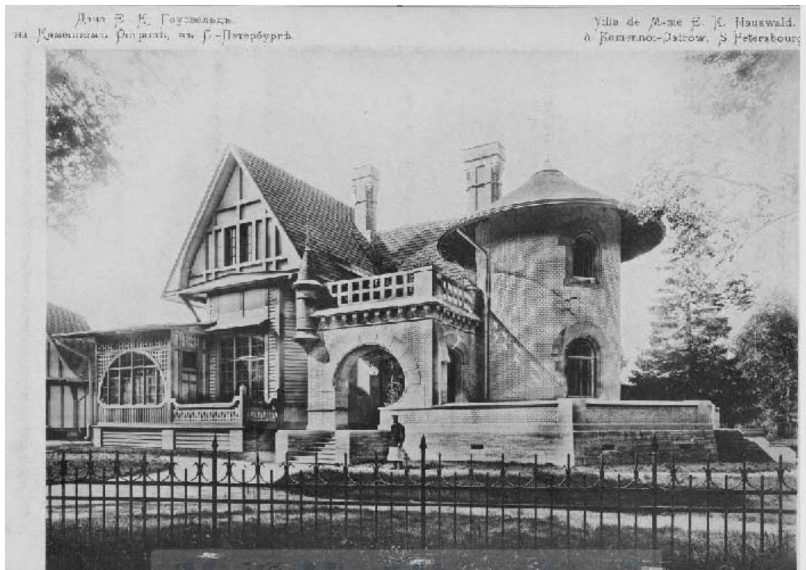
Илл. 29. Дача Е.К. Гаусвальд на Каменном острове в С-Петербурге. Журнал «Зодчий», 1900 г., № 12, л. 56.
