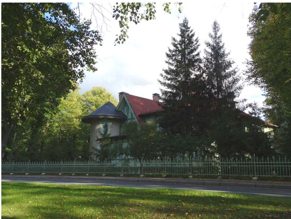
Фото 2. Вид на территорию объекта культурного наследия регионального значения «Особняк Гаусвальд Е.К.» с западной стороны. Съемка 06.09.2023 г. Трушковский В.Э.
