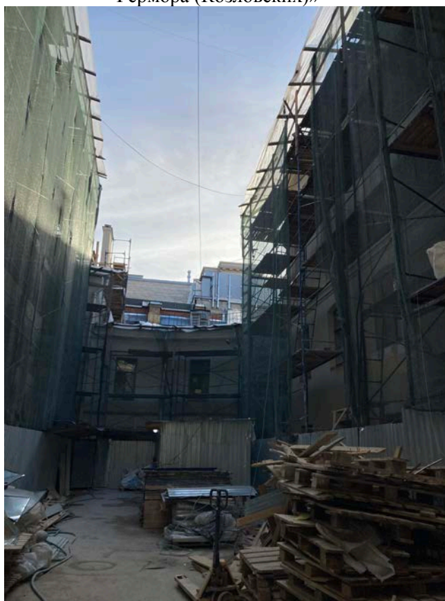
Фото 4. Фрагмент дворового фасада выявленного объекта культурного наследия «Особняк В.В. Фермора (Козловских)»
