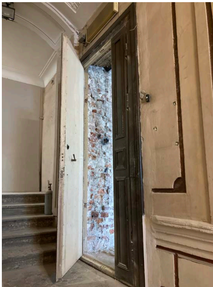
Фото 6. Интерьер квартиры № 1 выявленного объекта культурного наследия «Особняк В.В. Фермора (Козловских)», вход в квартиру
