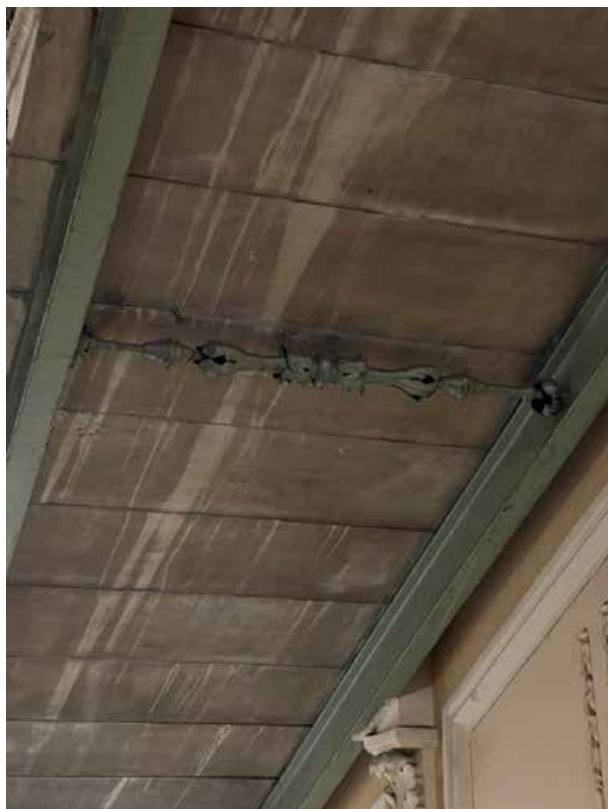
53. Металлическая декоративная стязка между двутаврами лестничного марша с цветочными и растительными элементами.
