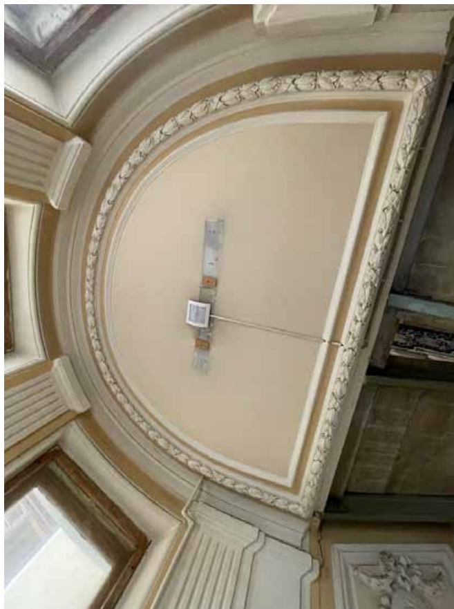
85. Оформление плафона потолка лестничной площадки между четвертым и пятым этажами аналогичное оформлению плафонов потолка лестничных площадок этажами ниже.
