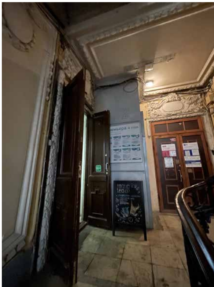
27. Общий вид площадки второго этажа лестничной клетки.
