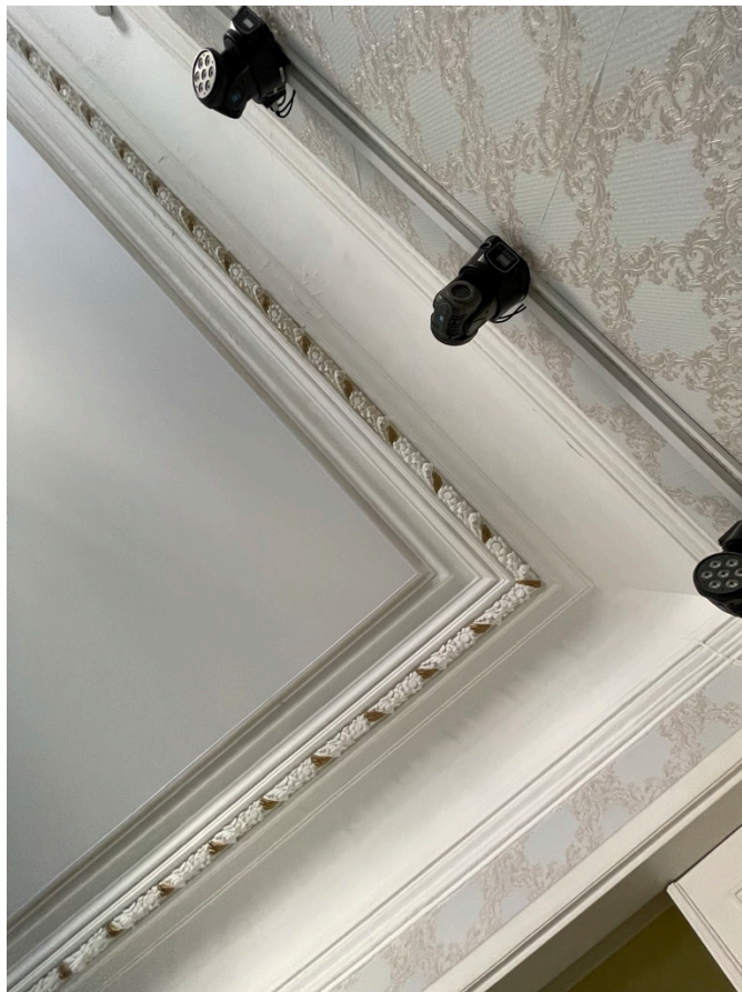
159. Фрагмент оформления плафона потолка помещения 26(Н)-4.
