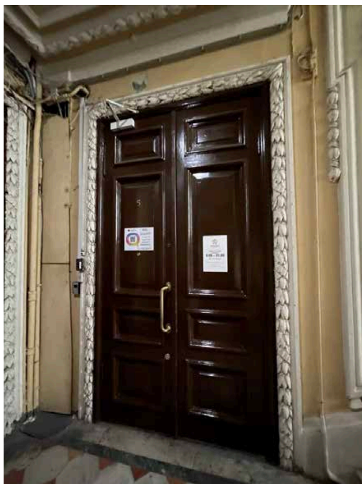
66. Дверной проем в помещении 22-Н(1). Оформление проема аналогичное проемам на этаже.
