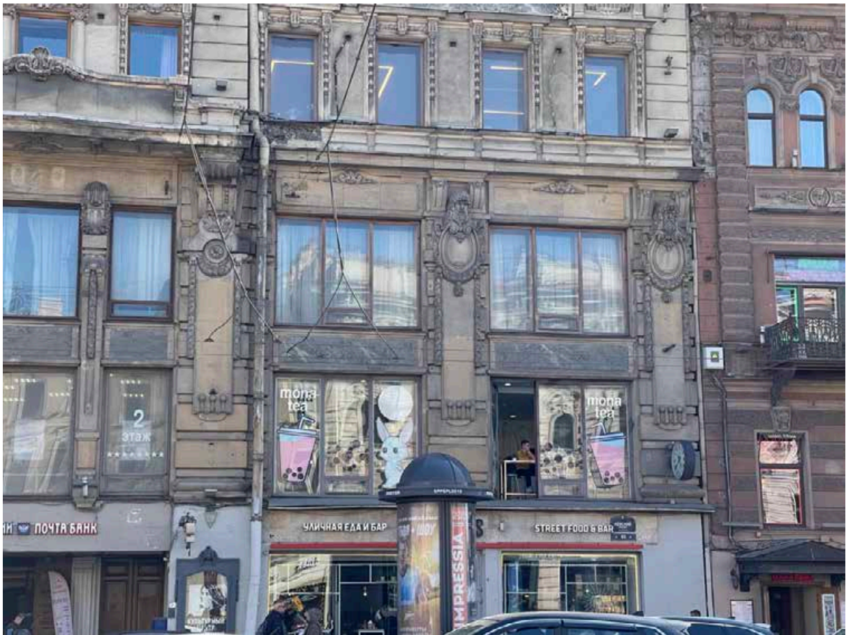
5. Фрагмент лицевого фасада с Невского проспекта.
