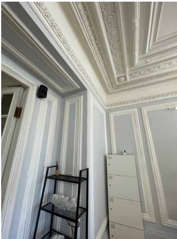
97. Фрагмент оформления стен помещения 23-Н(2) профилированными стенными панелями.
