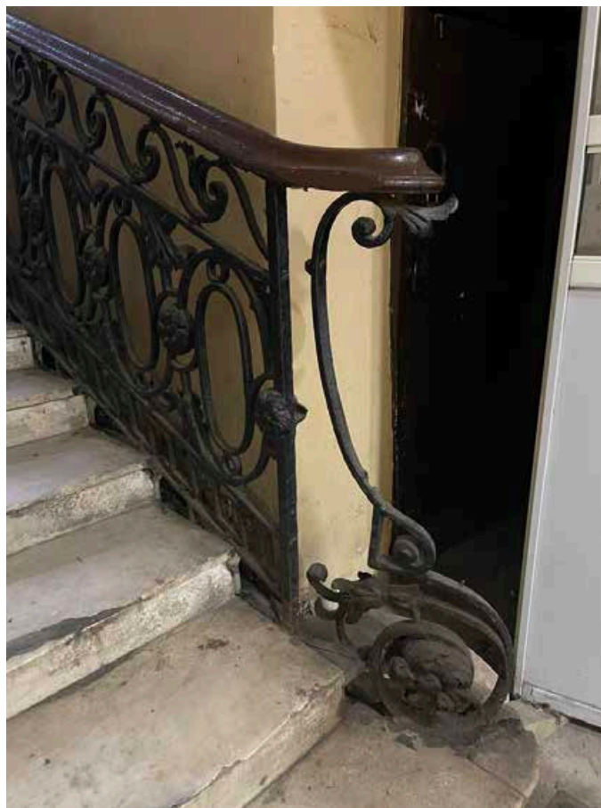
14. Ограждение лестничного марша – металлическое кованое с растительными элементами. Поручень деревянный профилированный, завершается горизонтальным завитком.
