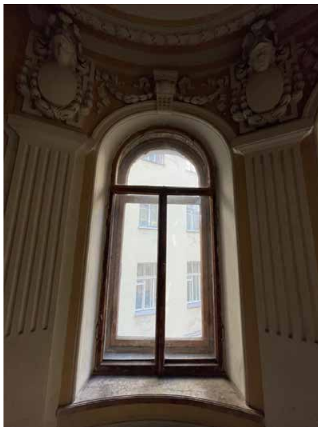
57. Оконный проем круглого ризалита в восточную сторону. Лестничная площадка между третьим и четвертым этажами.
