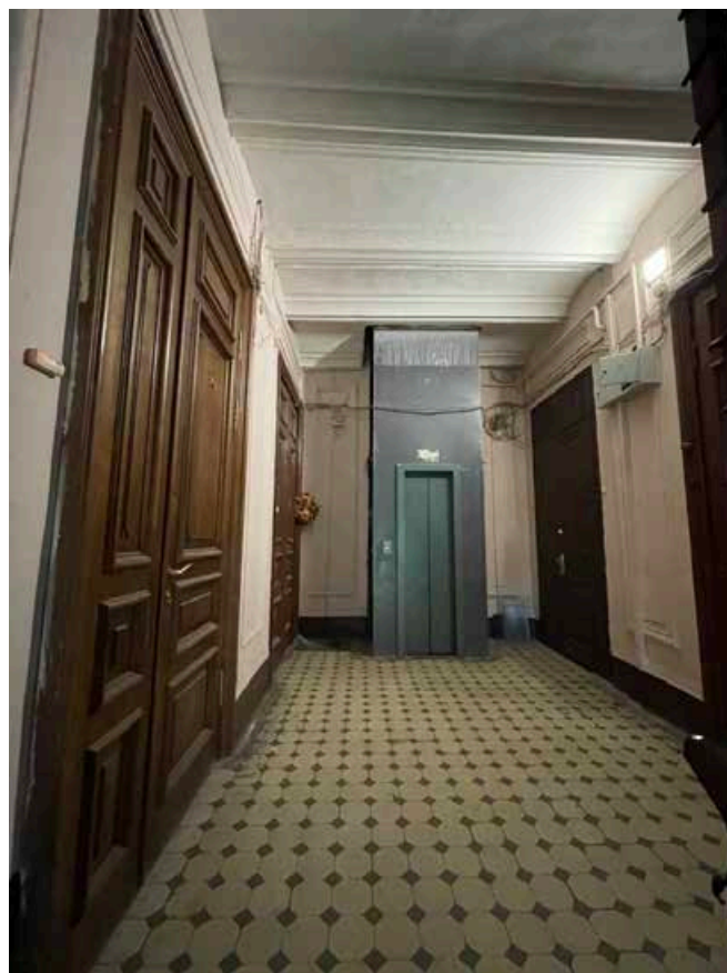
202. Общий вид лестничной площадки мансардного этажа.
