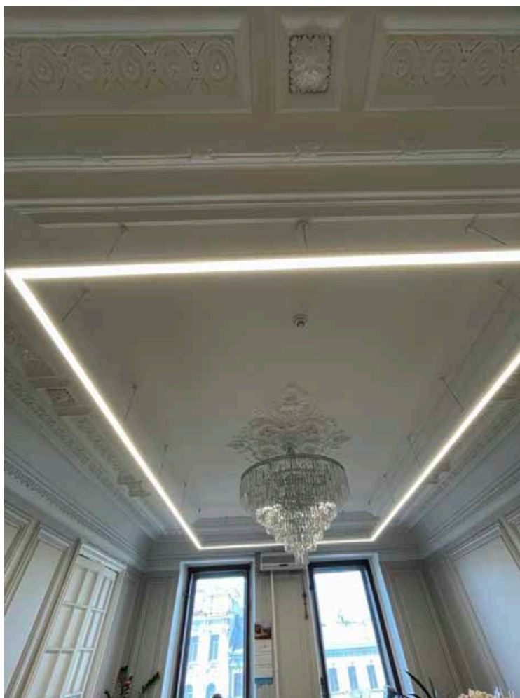
73. Общий вид оформления плафона потолка помещения 12-Н(7).
