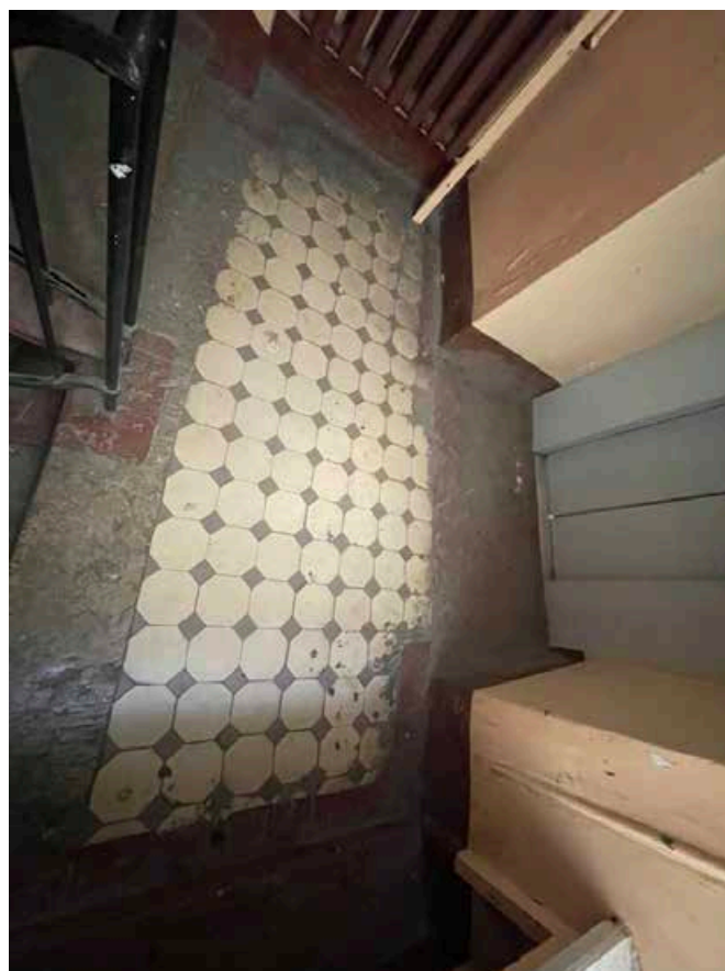
218. Покрытие пола аналогичной метлахской плиткой на лестничной площадке между вторым и третьим этажами лестничной клетки западного фасада.
