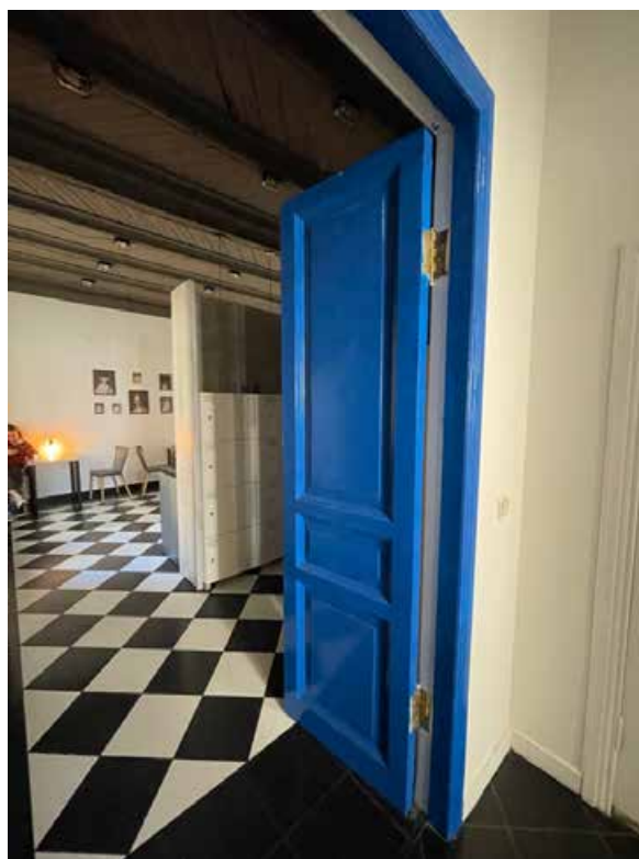
112. Дверной проем и заполнение в помещение 23-Н(4). Проем оформлен профилированным наличником. Заполнение двустворчатое деревянное, каждая створка поделена на 3 филенки. Заполнение окрашено в синий цвет со стороны помещения 23-Н(5).
