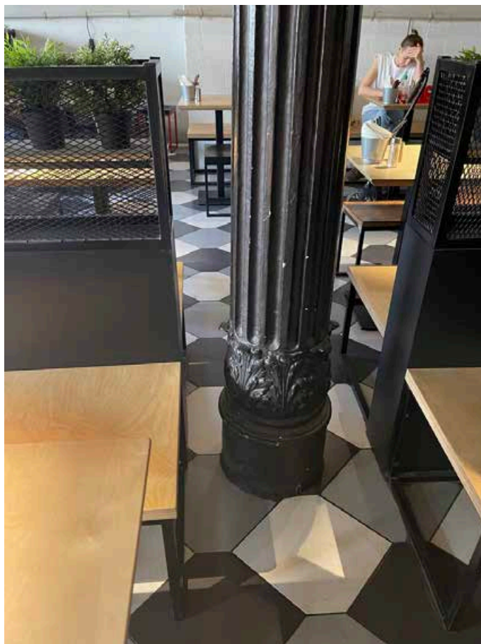
209. База колонны в помещении 2-Н(1).
