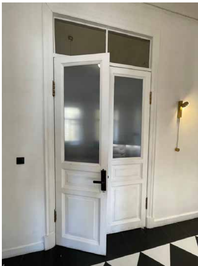
93. Дверной проем в помещении 23-Н(3). Проем оформлен профилированным наличником. Дверное заполнение двустворчатое деревянное с остекленной фрамугой, каждая створка поделена на три филенки, большая из них остеклена.
