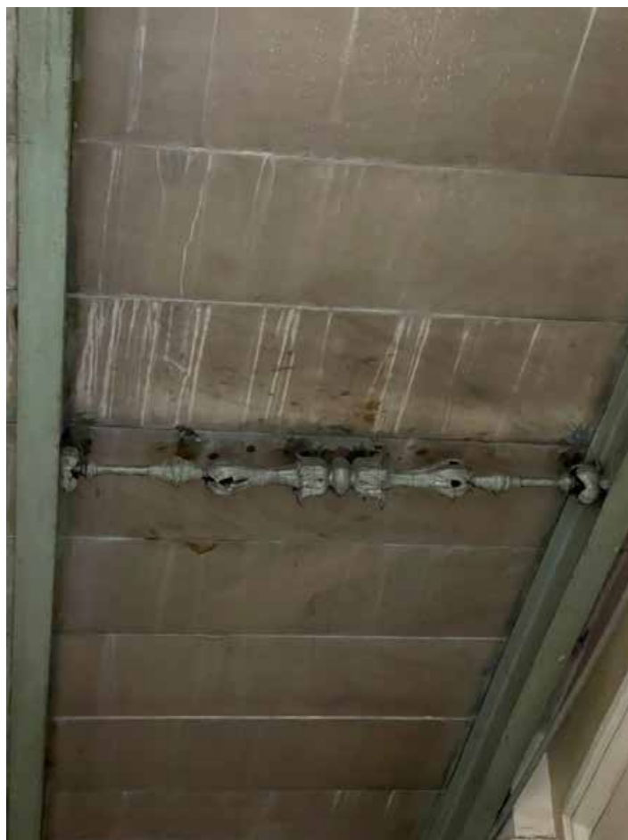
48. Металлическая декоративная стяжка между двутаврами лестничного марша с цветочными и растительными элементами.
