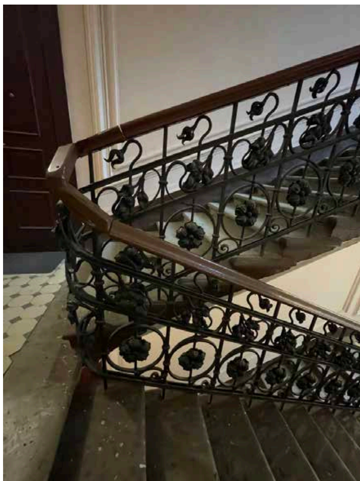
196. Фрагмент лестничного кованного металлического ограждения.
