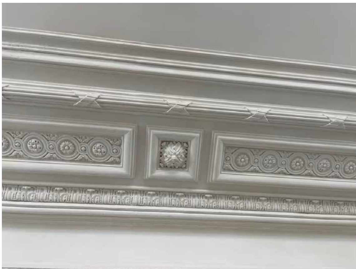
102. Фрагмент оформления плафона потолка помещения 23-Н(2) многоуровневым карнизом.
