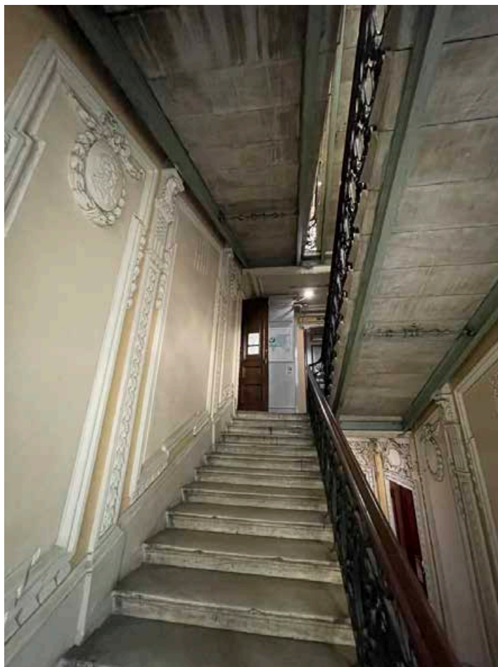
61. Общий вид лестничного марша между третьим и четвертым этажами.
