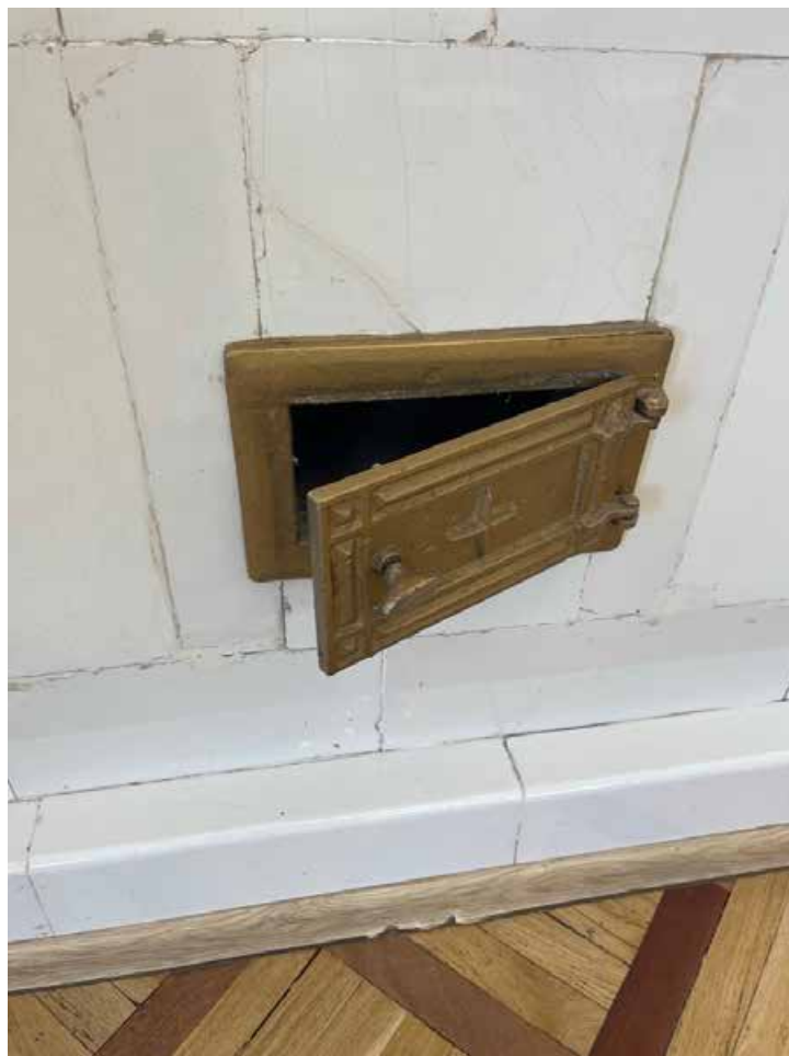
103. Металлическая дверца печи в помещении 23-Н(2).
