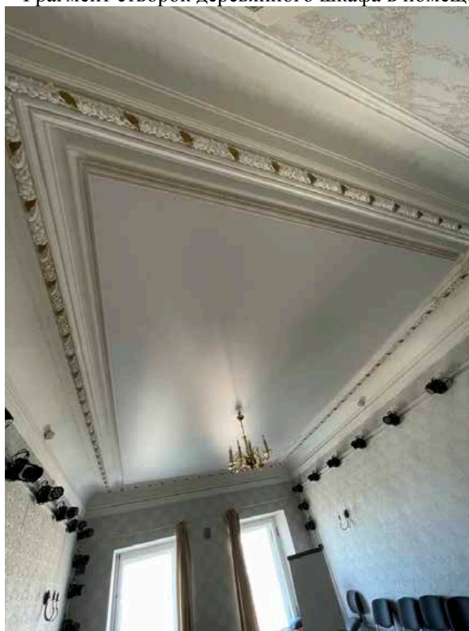
158. Оформление плафона потолка в помещении 26(Н)-4 падугой, карнизом в виде растительной гирлянды и профилированным карнизом.
