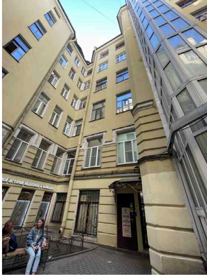
23. Общий вид угла западного и южного фасадов северного двора.
