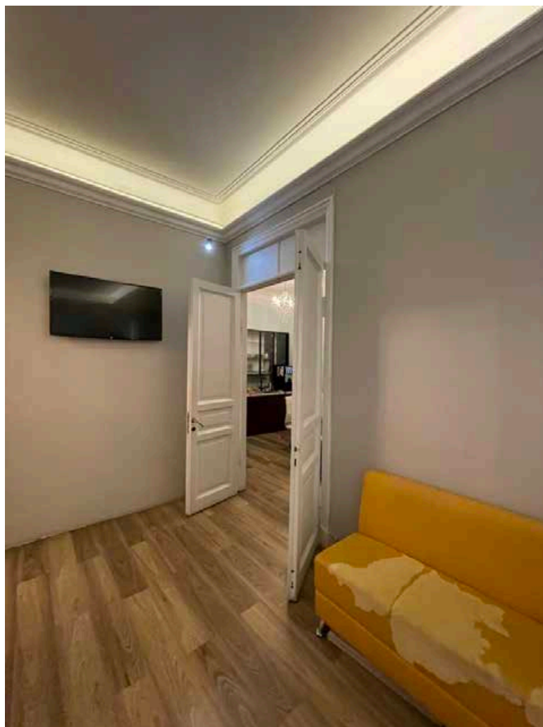
69. Фрагмент помещения 12-Н(1). Вход в помещение 12-Н(5).
