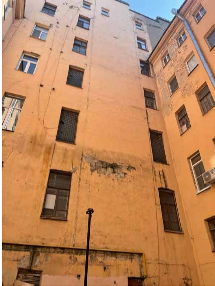
37. Сохранились три оконных заполнения со стеклянными кирпичами Фальконье.
