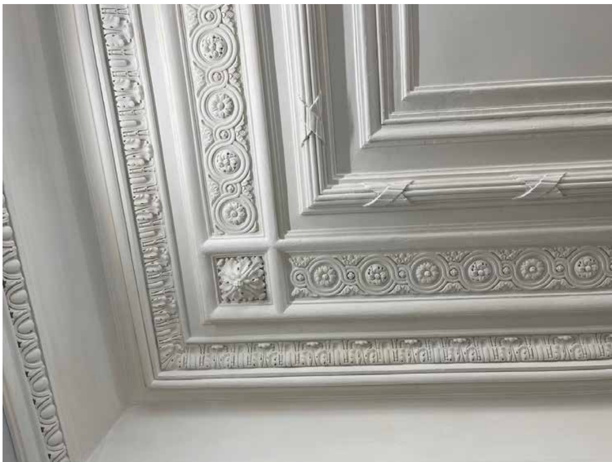
101. Фрагмент оформления плафона потолка помещения 23-Н(2) многоуровневым карнизом.
