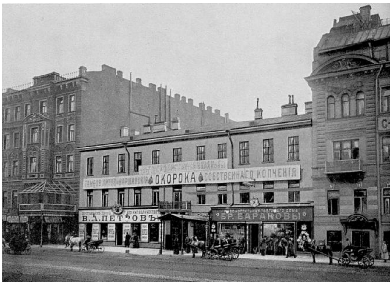
29. Общий вид фасада дома №65 по Невскому проспекту до перестройки.
