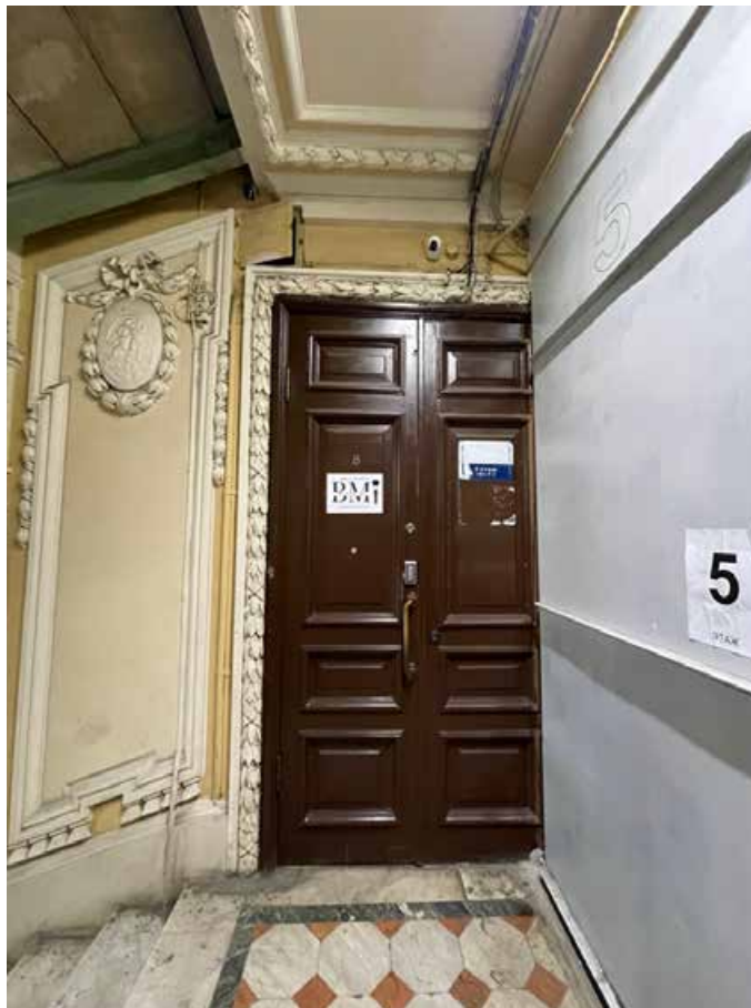
89. Дверной проем в помещение 23-Н(1). Оформление и заполнение проема аналогично проемам и заполнению на этом же этаже. Имеются значительные утраты наличника дверного проема в связи с устройством лифтовой шахты.
