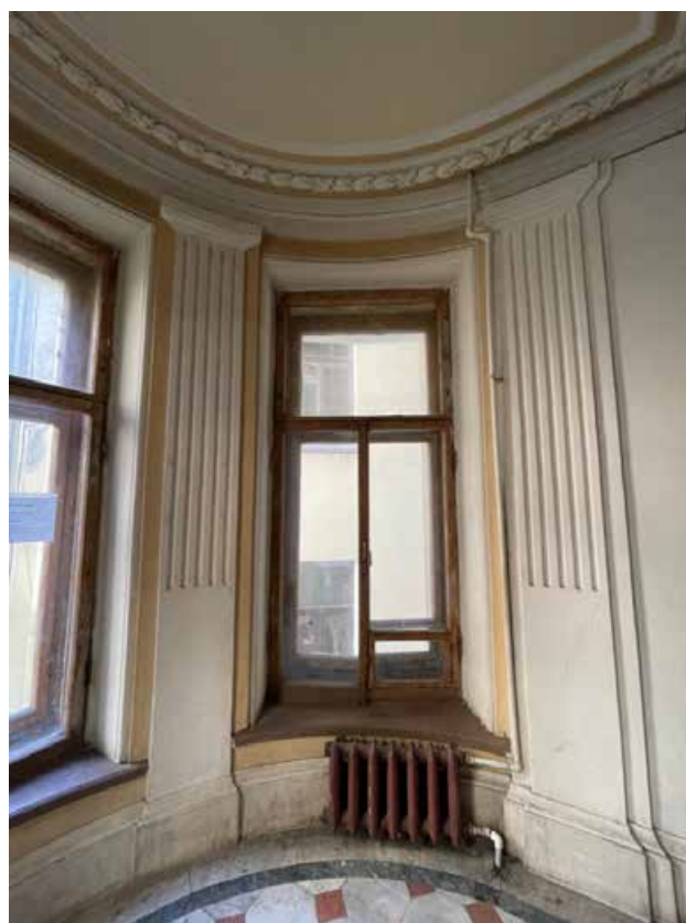
84. Оконный проем круглого ризалита лестничной площадки между четвертым и пятым этажами. Вид в западную сторону.
