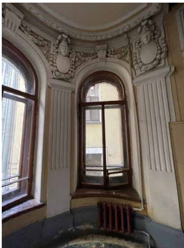
44. Оконный проем круглого ризалита в западную сторону. Лестничная площадка между вторым и третьим этажами. Простенки между окнами оформлены каннелированными частично пилястрами с плоскими капителями.
