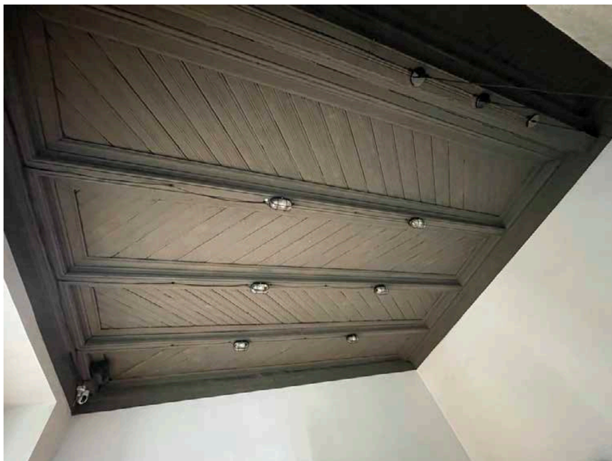
114. Обшивка потолка помещения 23-Н(4).
