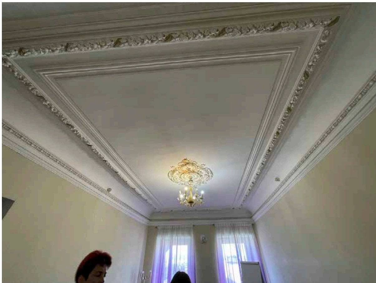
151. Общий вид оформления плафона потолка в помещении 26(Н)-5.
