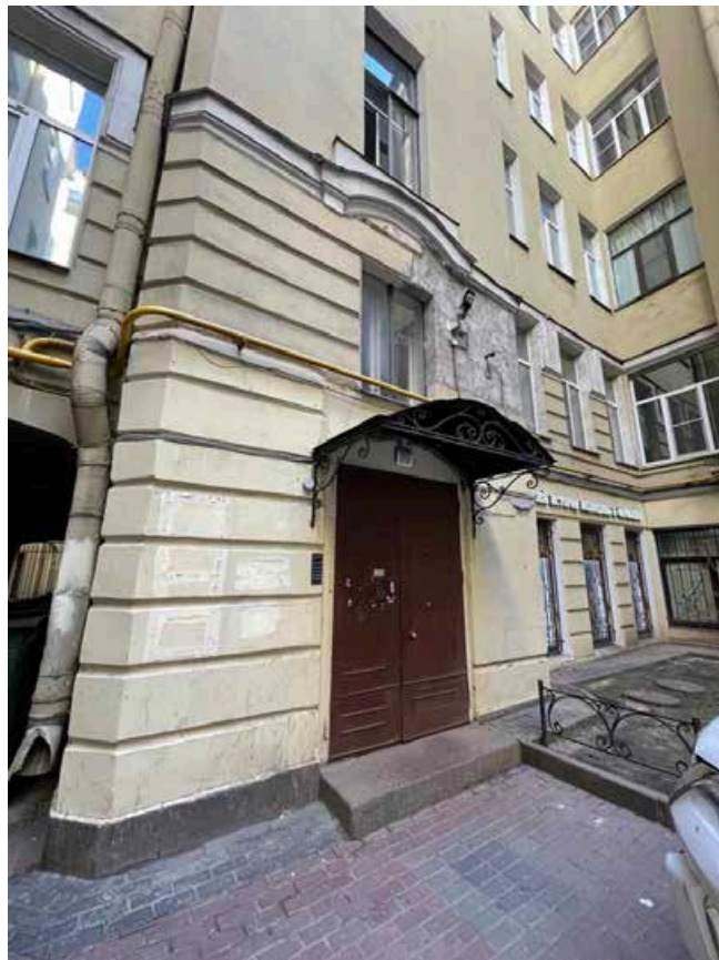
24. Дверной проем западнее воротного проезда в южный двор (южный ризалит северного двора, ведущий в лестничную клетку).
