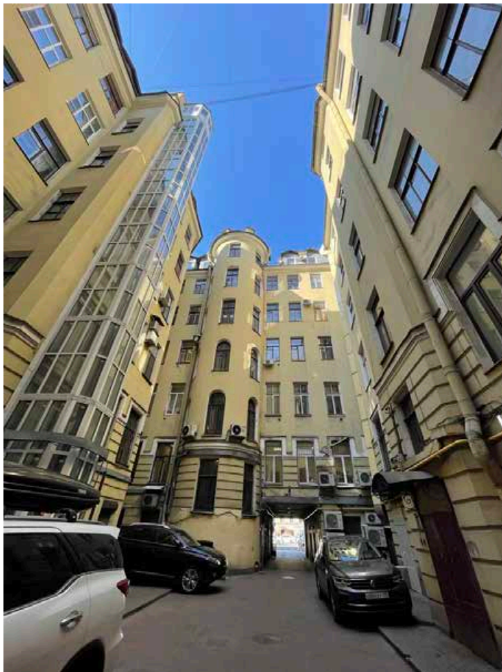
25. Общий вид на западный, восточный и северный фасады северного двора.
