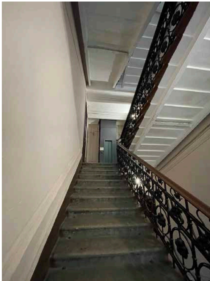
195. Общий вид лестничного марша с четвертого на пятый этаж.
