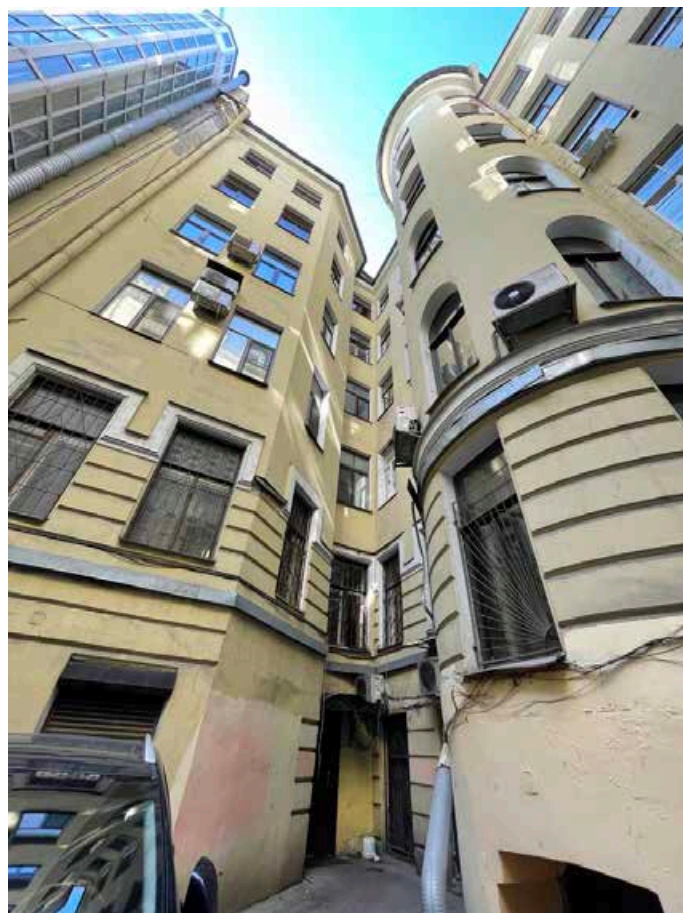
20. Общий вид угла северного и западного фасадов северного двора.
