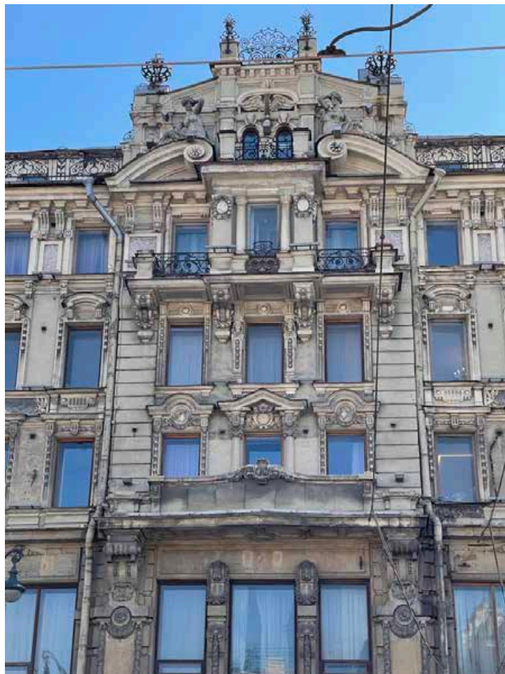
2. Фрагмент лицевого фасада с Невского проспекта.
