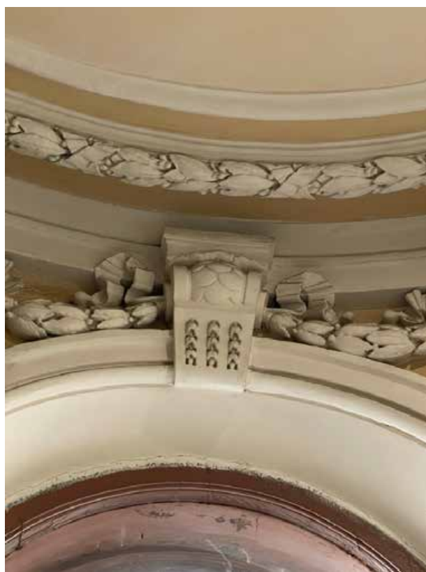
46. Замковый камень над оконным проемом с цветочными гирляндами в каннелюрах, лентами, волютами, стилизованным бутоном и капителью.
