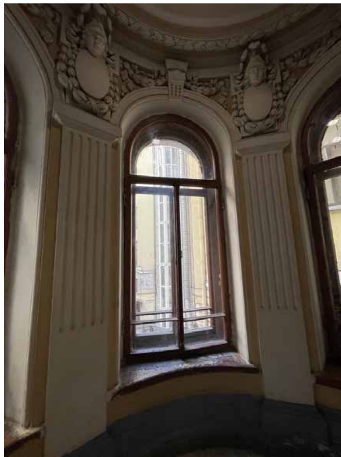
43. Оконный проем круглого ризалита в южную сторону. Лестничная площадка между вторым и третьим этажами.
