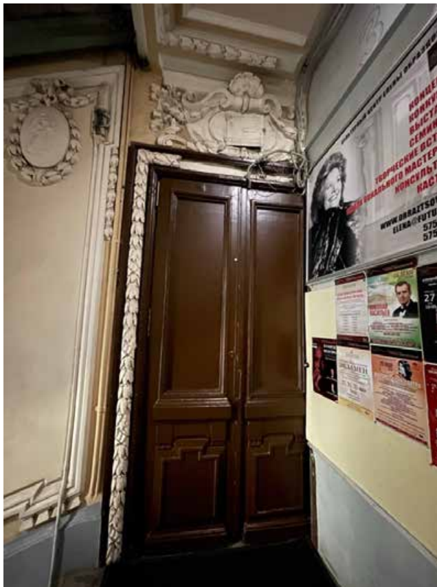
49. Дверной проем в помещении 10-Н(1). Декоративное оформление проема аналогично оформлению проема этажом ниже. Заполнение – деревянное двустворчатое, каждая створка делится на две филенки, нижняя филенка сложной формы.
