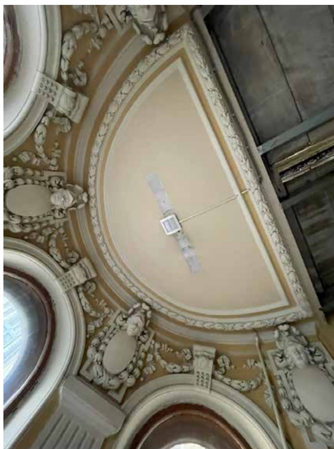
60. Оформление плафона потолка лестничного марша между третьим и четвертым этажами.
