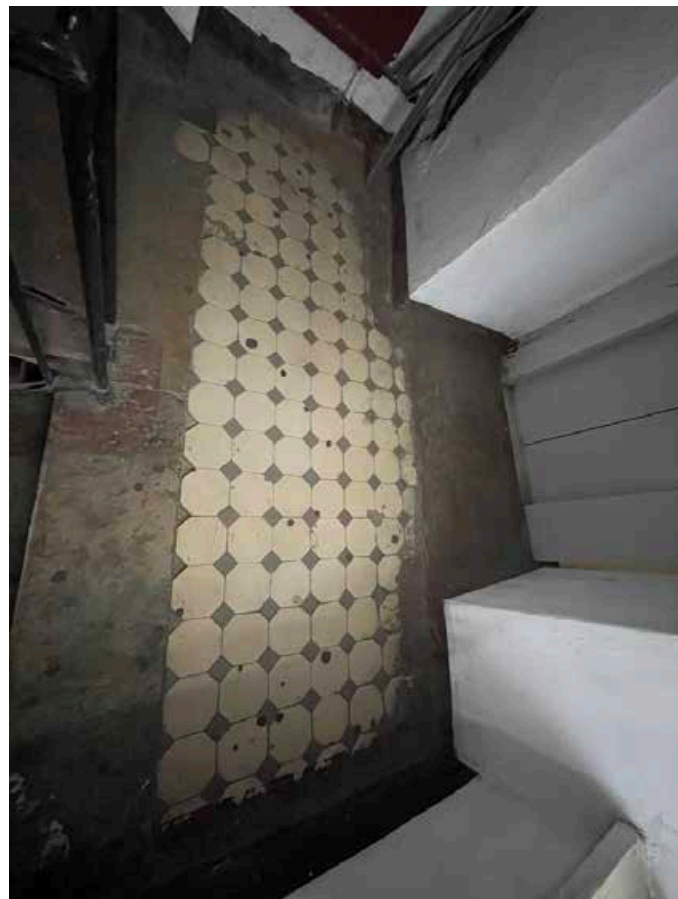
214. Покрытие пола аналогичной метлахской плиткой на площадке второго этажа.
