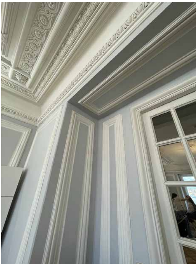
96. Оформление проема помещения 23-Н(2) профилированными панелями. Фрагмент многоуровневого карниза потолка.
