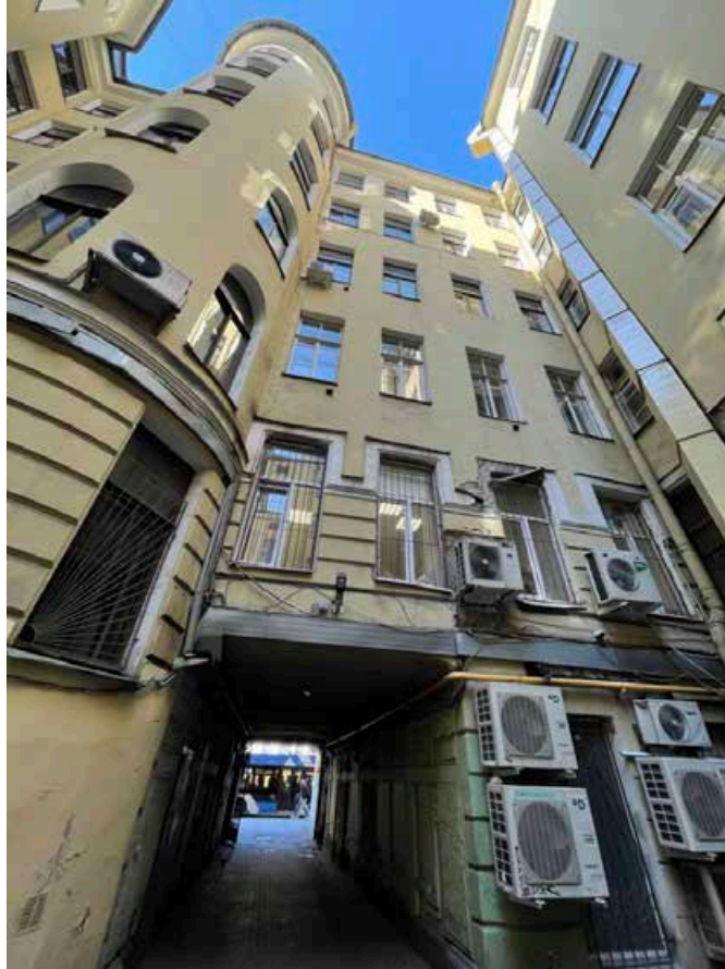
17. Общий вид северного фасада северного двора.
