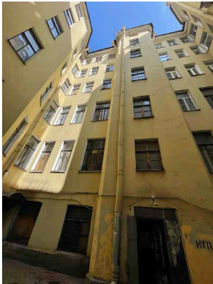
31. Общий вид северного фасада южного двора.
