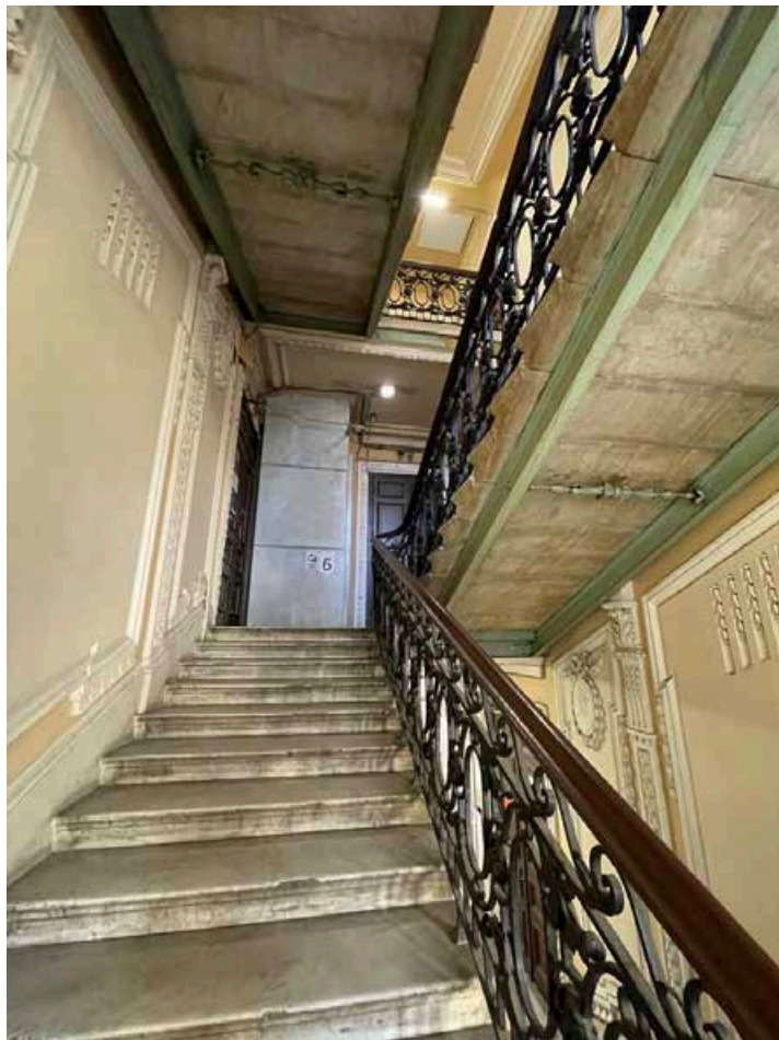
131. Общий вид лестничного марша с пятого на шестой этаж.
