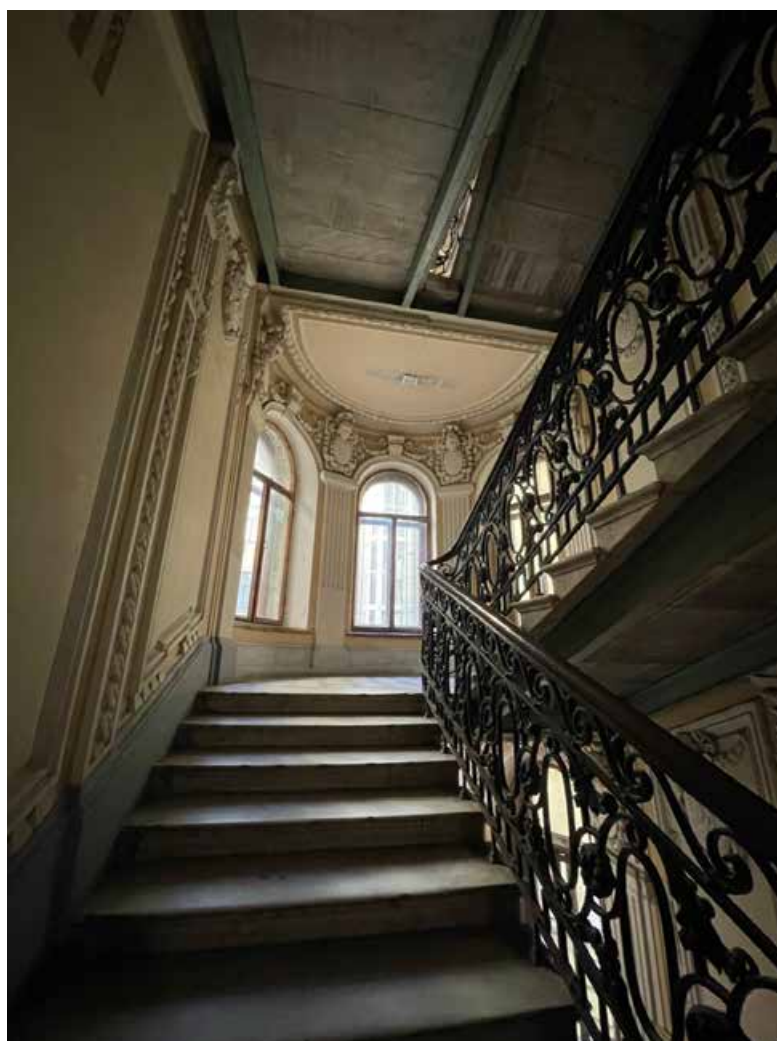
54. Общий вид лестничной площадки между третьим и четвертым этажами.
