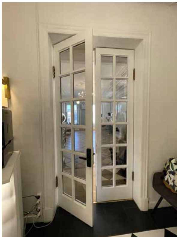
95. Дверной проем в помещении 23-Н(2). Проем оформлен профилированным наличником. Дверные заполнения остекленные филленчатые (каждая створка на 12 филенок).
