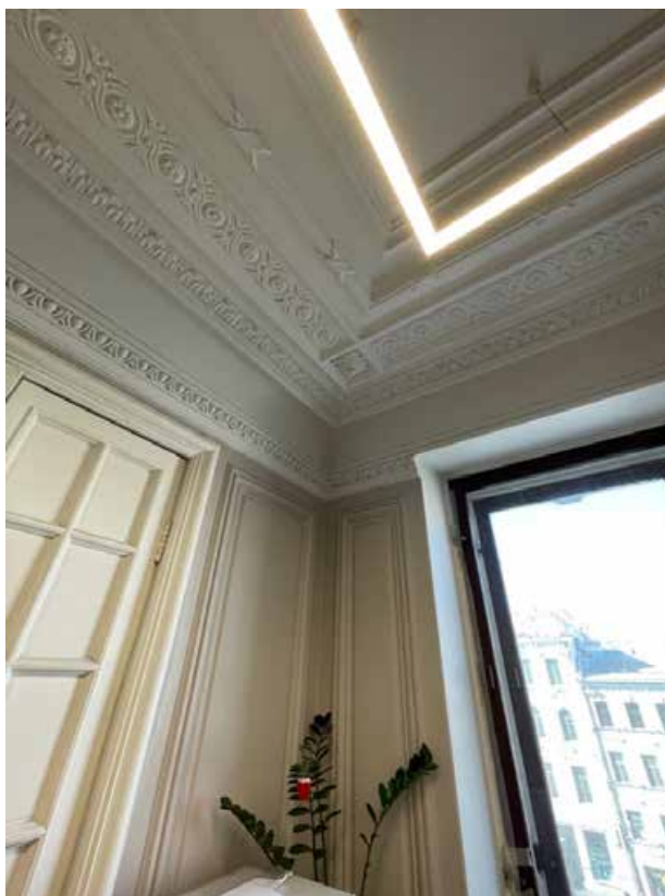
77. Углы помещения 12-Н(7) также оформлены профилированными стенными панелями. Фрагмент многоуровневого карниза плафона потолка.
