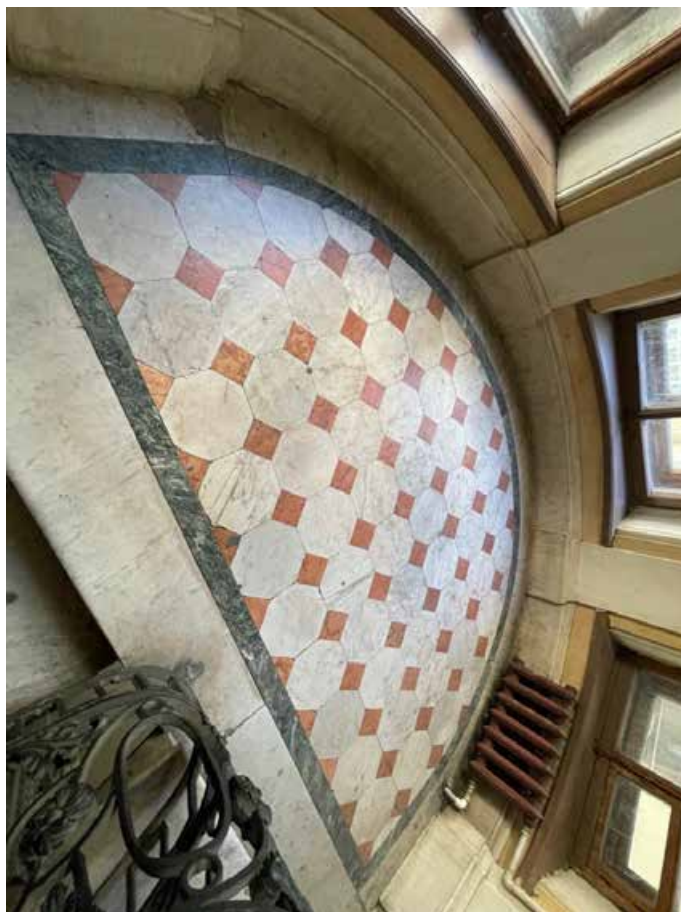
81. Оформление пола лестничной площадки между четвертым и пятым этажами аналогично оформлению лестничных площадок этажами ниже. Утраты напольного покрытия минимальные.
