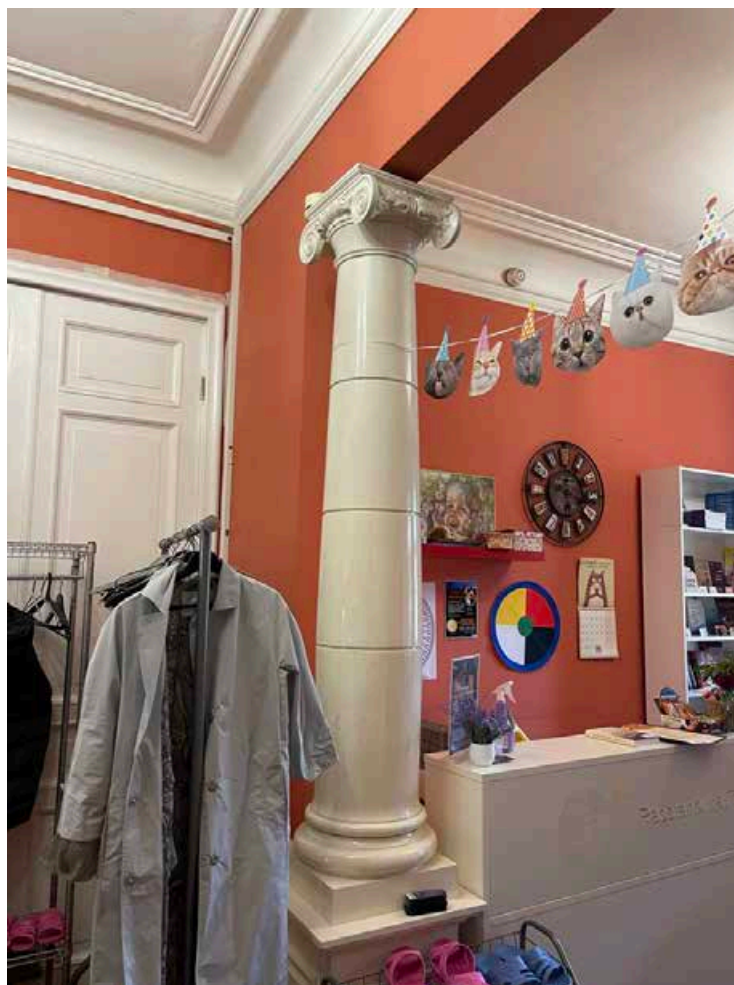
161. Общий вид колонны в помещении 26(Н)-1.
