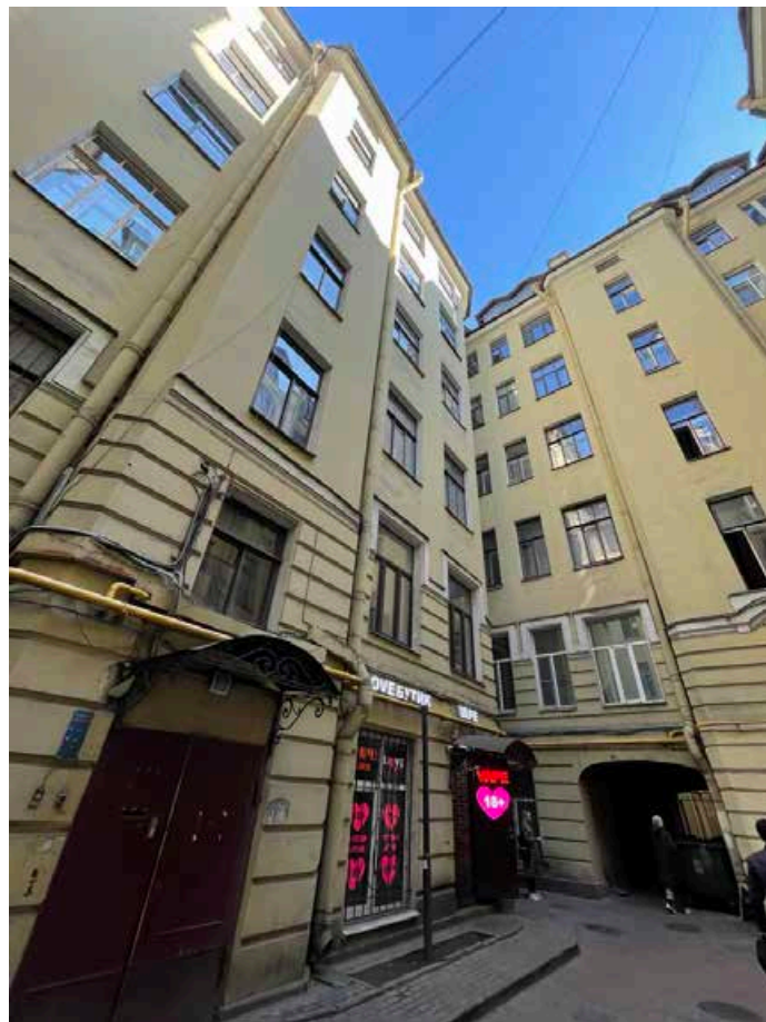
22. Общий вид угла южного и восточного фасадов северного двора.
