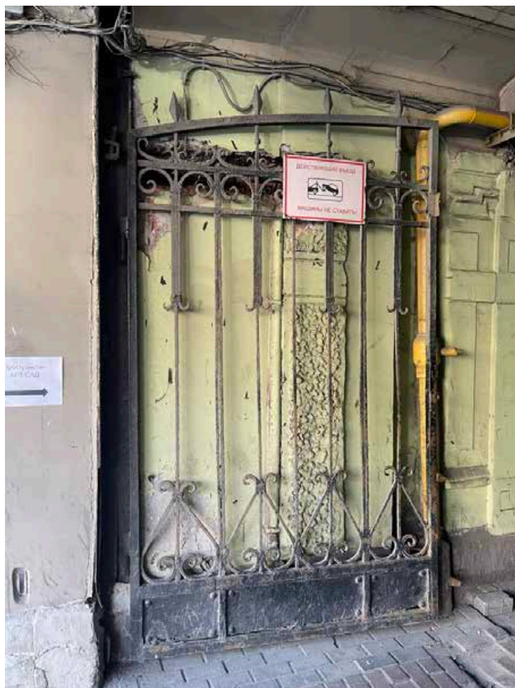
12. Левая створка кованых ворот арочного проезда со стороны Невского проспекта.
