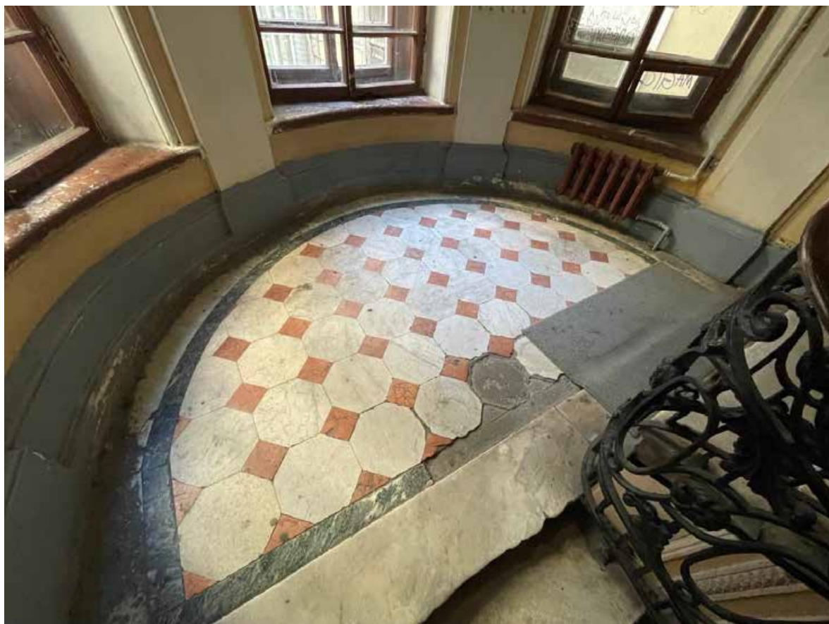
41. Покрытие лестничной площадки между вторым и третьим этажами – восьмигранная плитка мраморная красного и белого цвета, простой бордюр зеленого мрамора. Имеются утраты.
