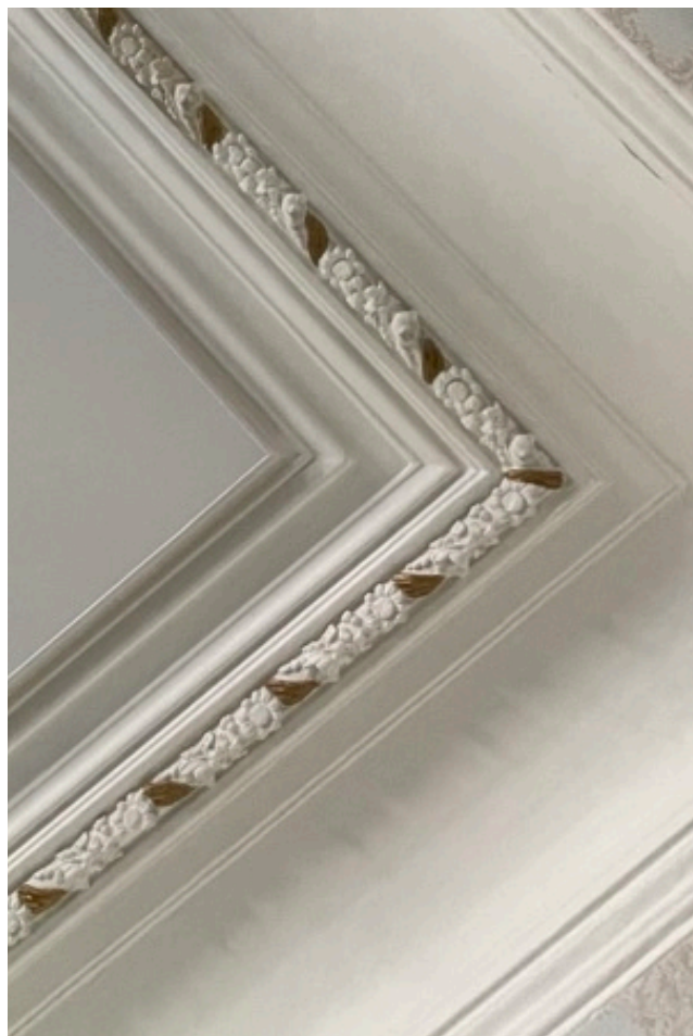
160. Фрагмент оформления плафона потолка помещения 26(Н)-4.
