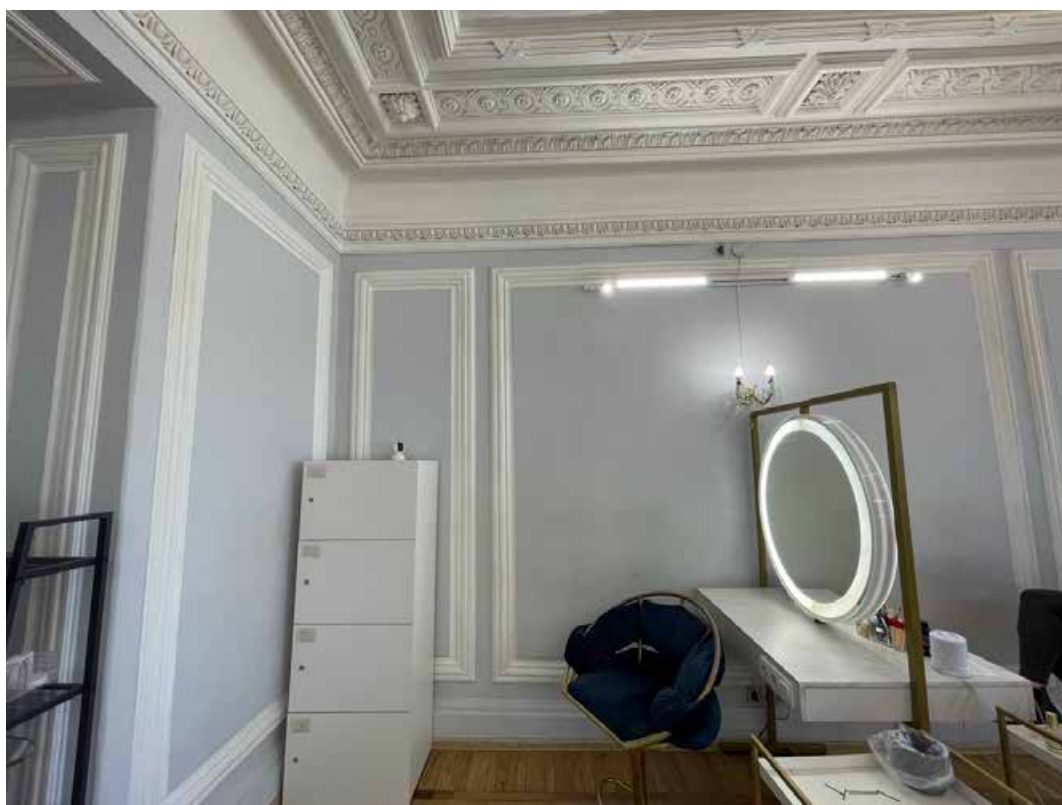
98. Фрагмент оформления стен помещения 23-Н(2) профилированными стенными панелями.
