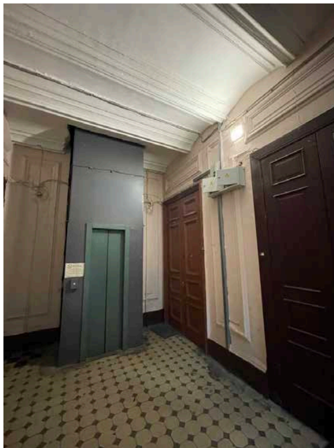
197. Общий вид лестничной площадки пятого этажа.
