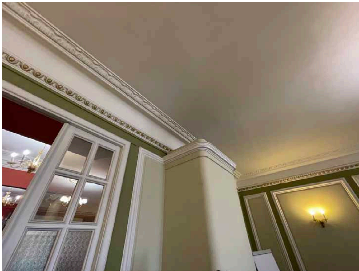
139. Печь квадратная в плане в помещении 26(Н)-2. Завершается профилированным карнизом. Печь оштукатурена и покрашена в светло-зеленый цвет аналогично стенам в помещении.
