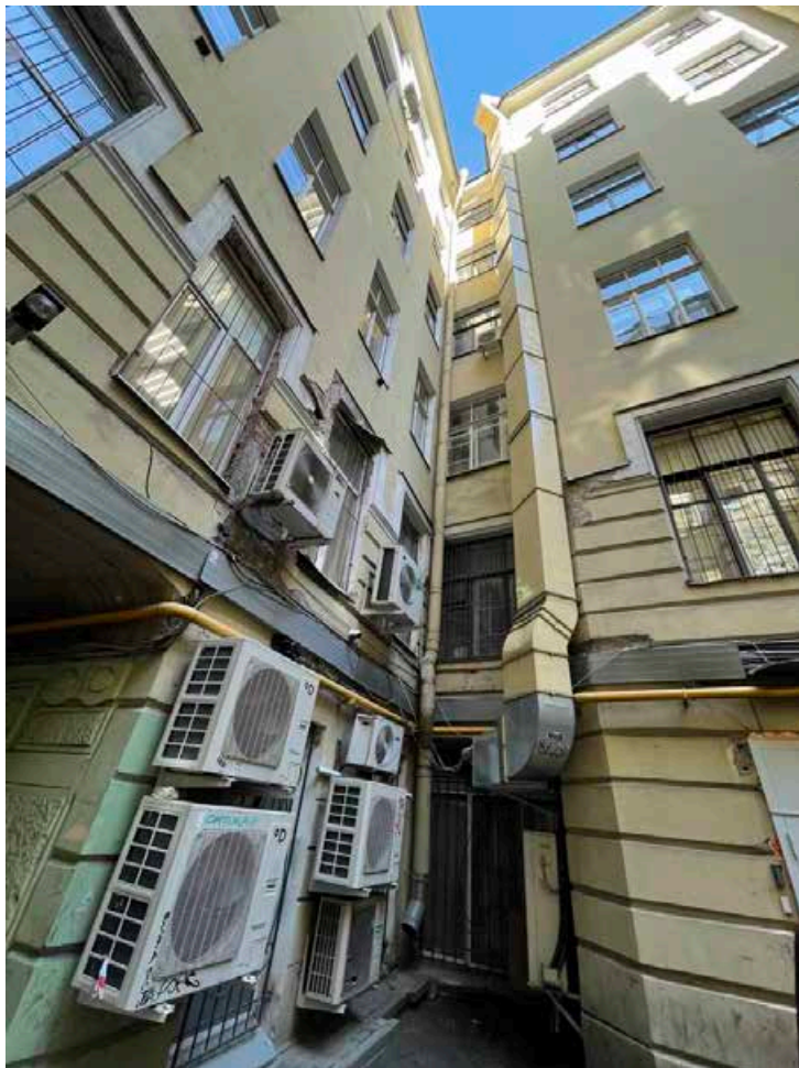
18. Общий вид угла северного и восточного фасадов северного двора.
