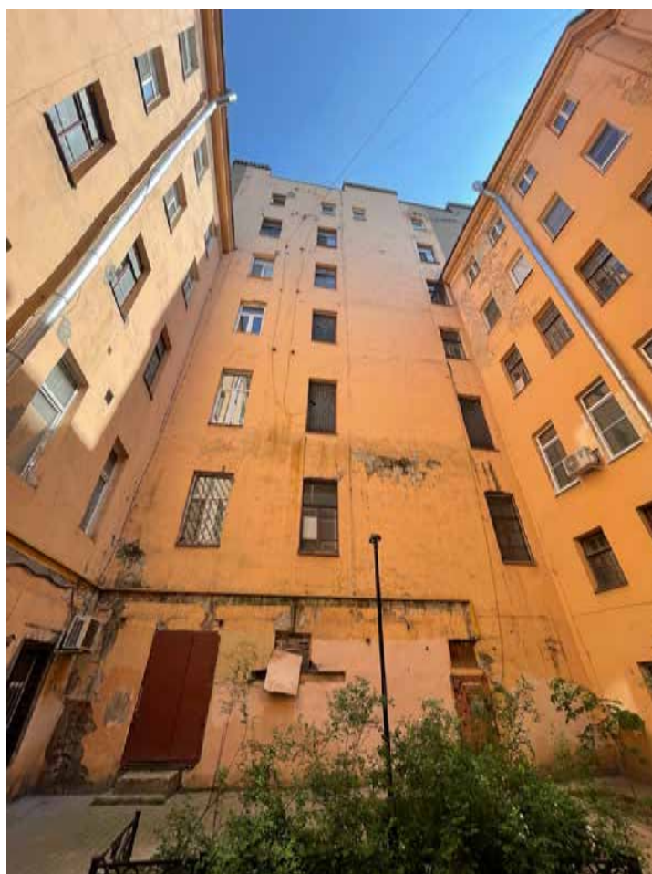
36. Общий вид западного фасада.
