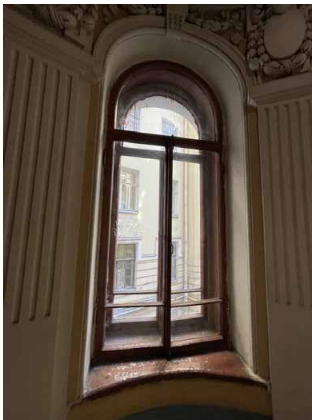
42. Оконный проем круглого ризалита в восточную сторону. Лестничная площадка между вторым и третьим этажами.
