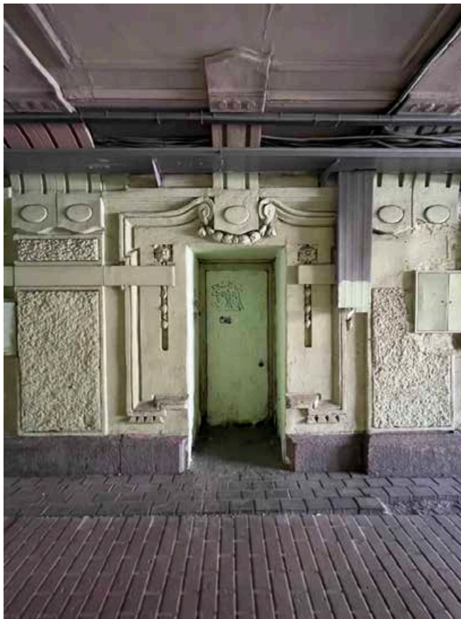
15. Дверной проем и декоративное оформление западной стены воротного проезда со стороны Невского проспекта.
