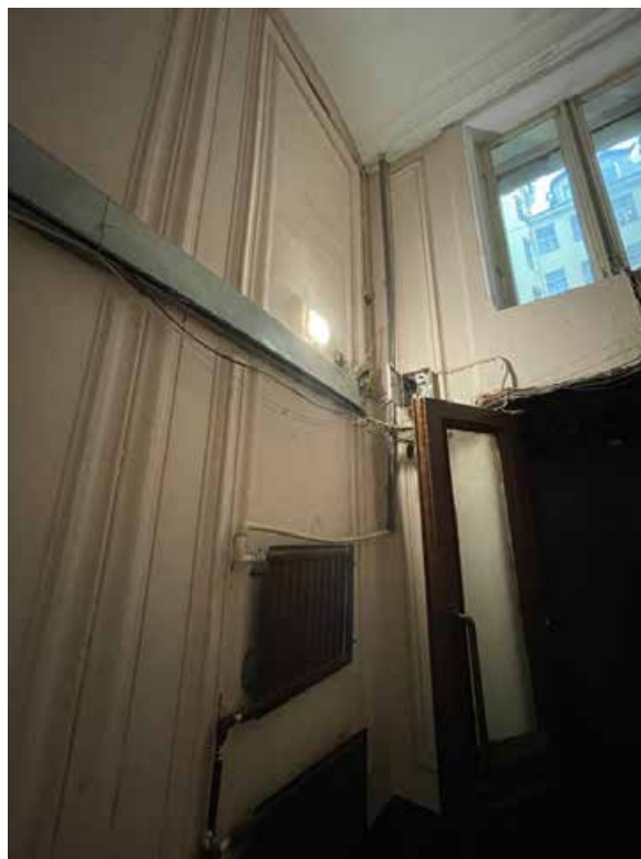
181. Оформление стен лестничной клетки профилированными панелями.
