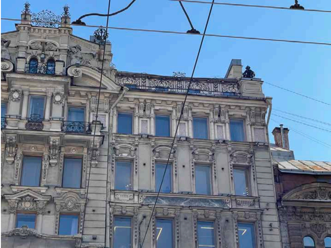
7. Фрагмент лицевого фасада с Невского проспекта.
