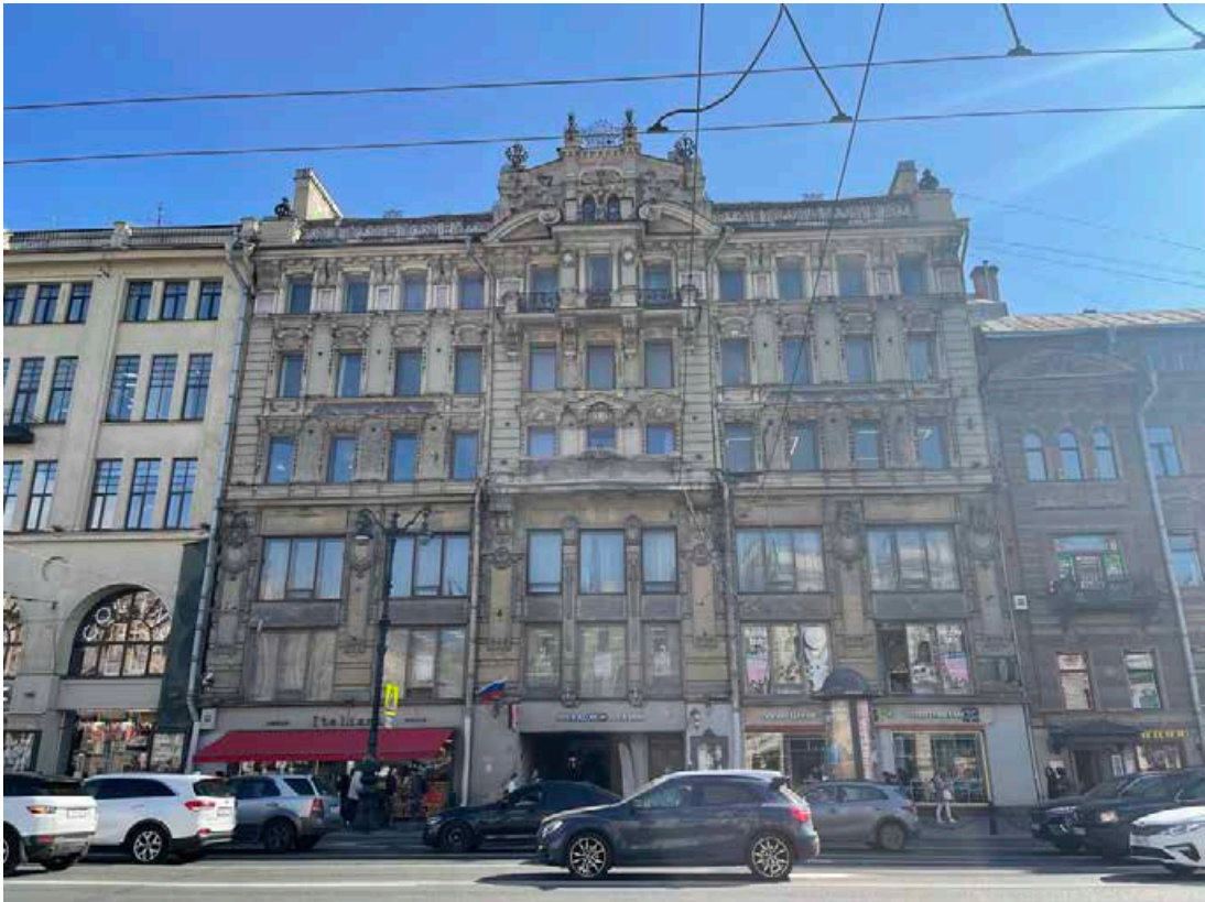
1. Общий вид лицевого фасада с Невского проспекта.
