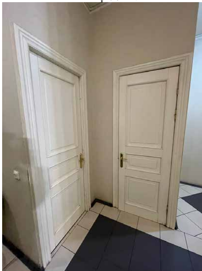
124. Дверные проемы в помещении 25(Н)-3. Проемы оформлены профилированными наличниками. Заполнения одностворчатые, каждая створка поделена на 3 филенки.
