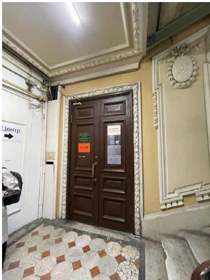
87. Дверной проем в помещении 25-Н(1). Оформление проема аналогично оформлению проема этажом ниже. Заполнение двустворчатое деревянное, каждая створка делится на 4 филенки.
