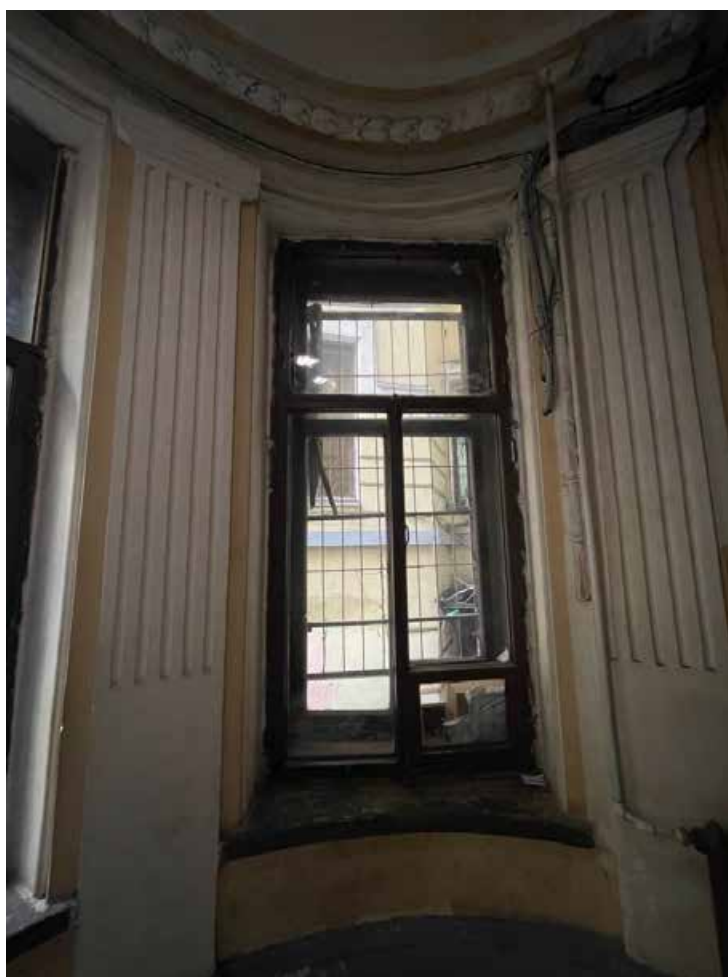
21. Оконный проем круглого ризалита лестничной клетки между первым и вторым этажами в западную сторону.
