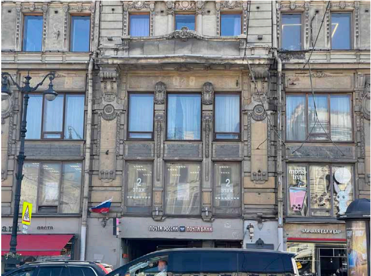
3. Фрагмент лицевого фасада с Невского проспекта.
