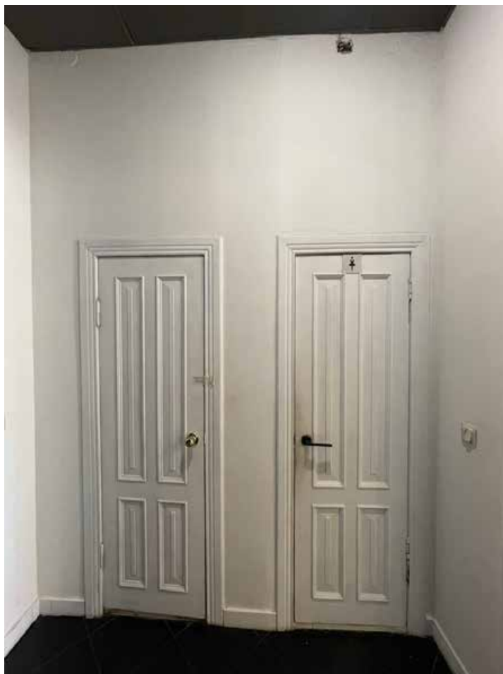
111. Дверные проемы в помещения 23-Н(6) и 23-Н(7). Проемы оформлены профилированными наличниками. Заполнения одностворчатые, поделены на 4 вертикальных филенки.
