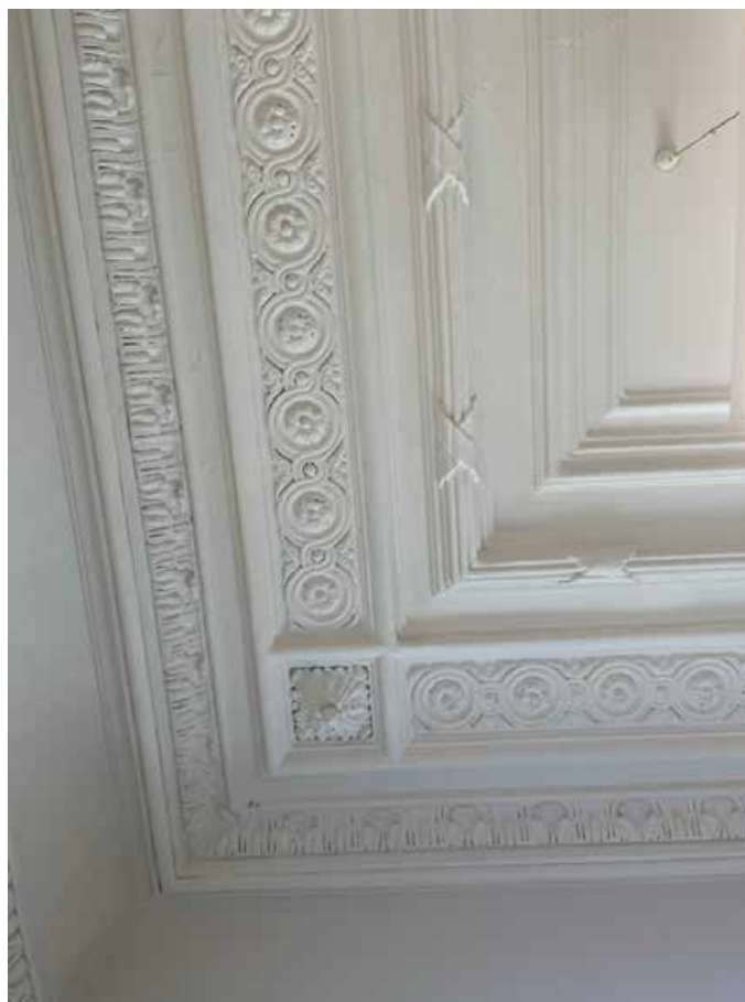
78. Многоуровневый карниз плафона потолка помещения 12-Н(7) выполнен рядами листьев аканта, цветочными розетками, лентами и простыми профилированными карнизами.
