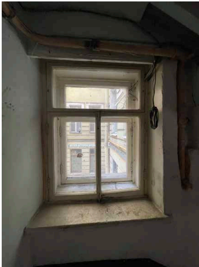
215. Оконный проем на лестничной площадке второго этажа (вид на юг). Лестничная клетка западного фасада.
