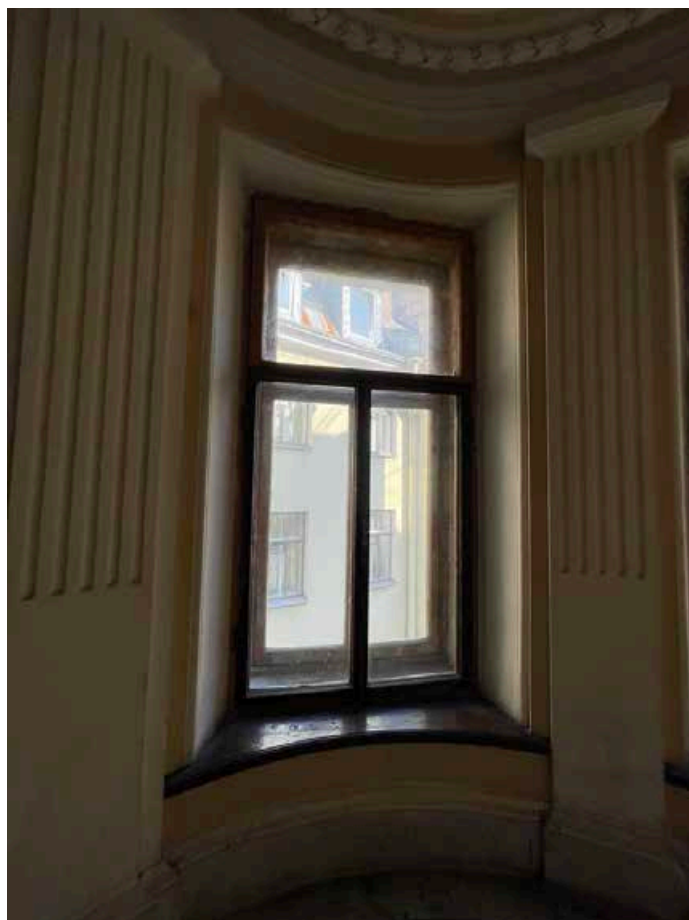
128. Оконный проем круглого ризалита лестничной площадки между пятым и шестым этажами. Вид в восточную сторону.
