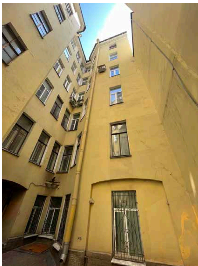
32. Общий вид восточного фасада южного двора.
