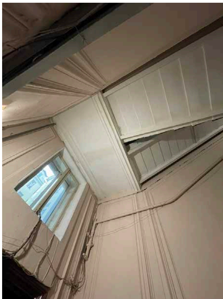
180. Потолки лестничных площадок оформлены в виде сводов Монье.
