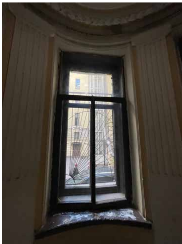
20. Оконный проем круглого ризалита лестничной клетки между первым и вторым этажами в южную сторону.
