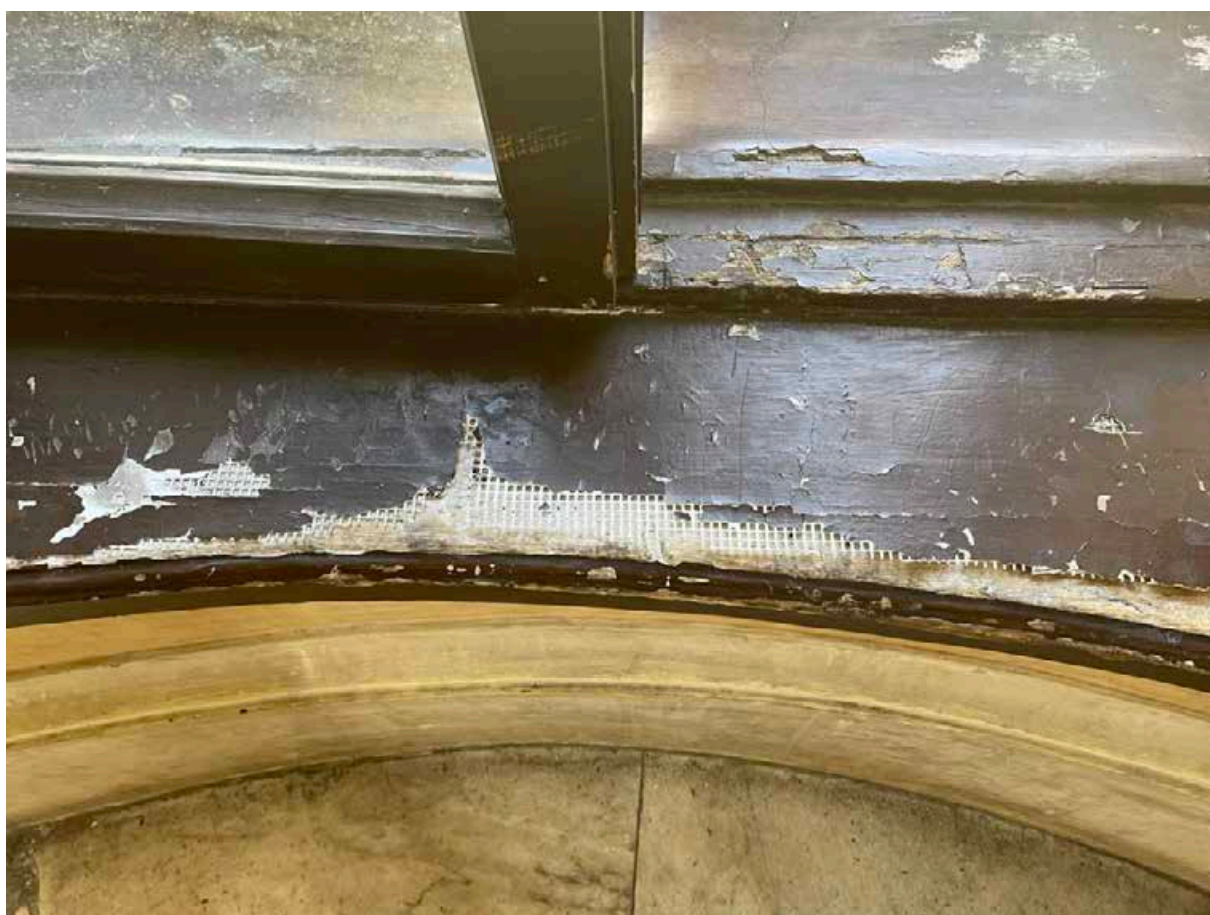
164. Поздняя окраска подоконных досок оконных проемов круглого ризалита лестничной площадки между шестым и мансардным этажами. Вид в восточную сторону.
