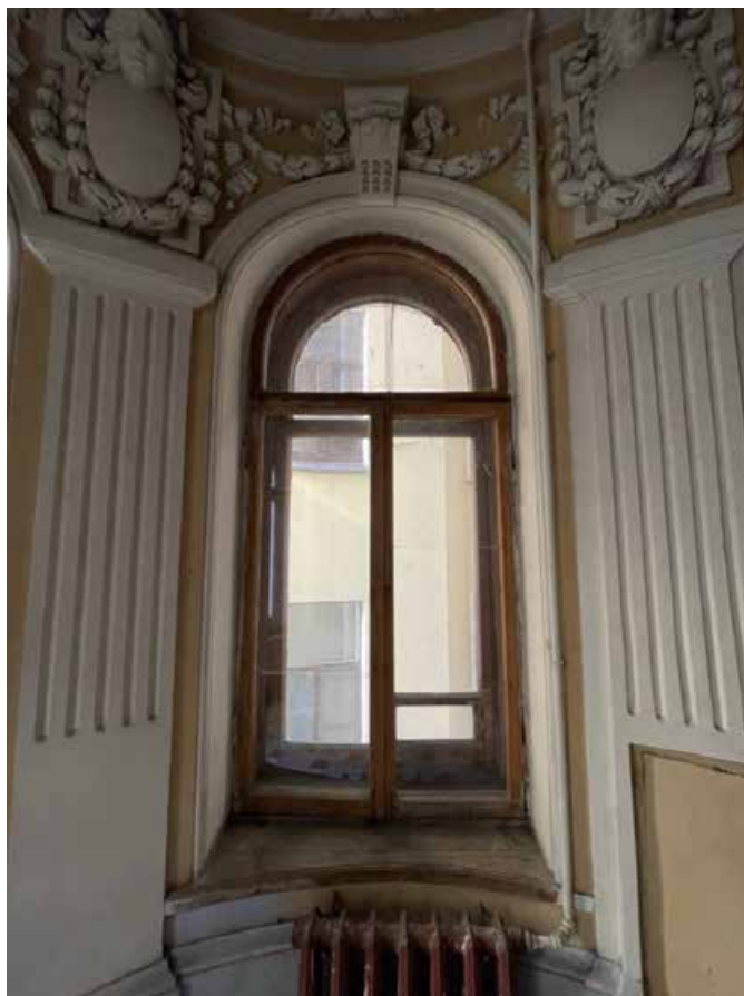
59. Оконный проем круглого ризалита в западную сторону. Лестничная площадка между третьим и четвертым этажами.
