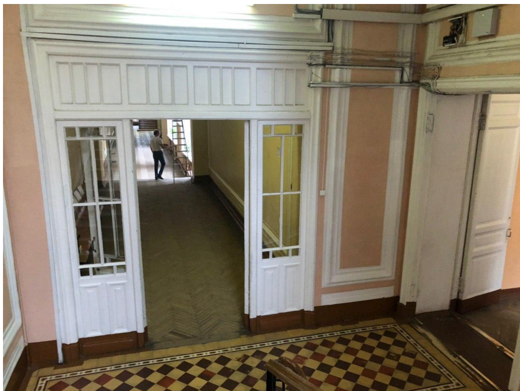
39. Здание Петровского коммерческого училища Санкт-Петербургского купеческого общества (с флигелями, сквером, металлической оградой). 2-й этаж. Лестница. Штиглиц М.С. 30.11.2020.
