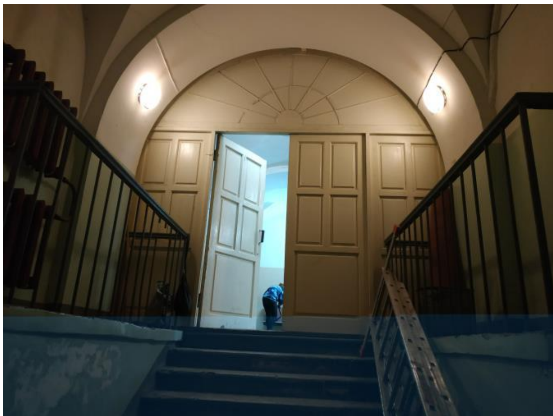
27. Здание Петровского коммерческого училища Санкт-Петербургского купеческого общества (с флигелями, сквером, металлической оградой). 1-й этаж. Лестница. Штиглиц М.С. 30.11.2020.
