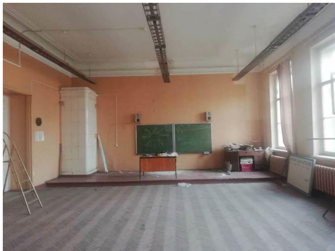
46. Здание Петровского коммерческого училища Санкт-Петербургского купеческого общества (с флигелями, сквером, металлической оградой). 3-й этаж. Аудитории. Штиглиц М.С. 30.11.2020.
