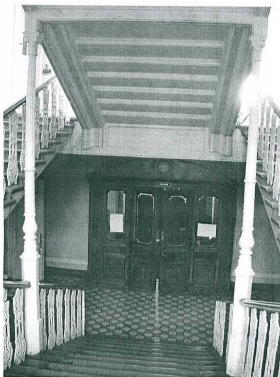
4. Парадная лестница. Площадка 1-го этажа.
