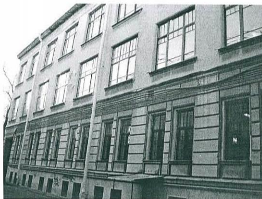
24. Фасад дворового корпуса.
