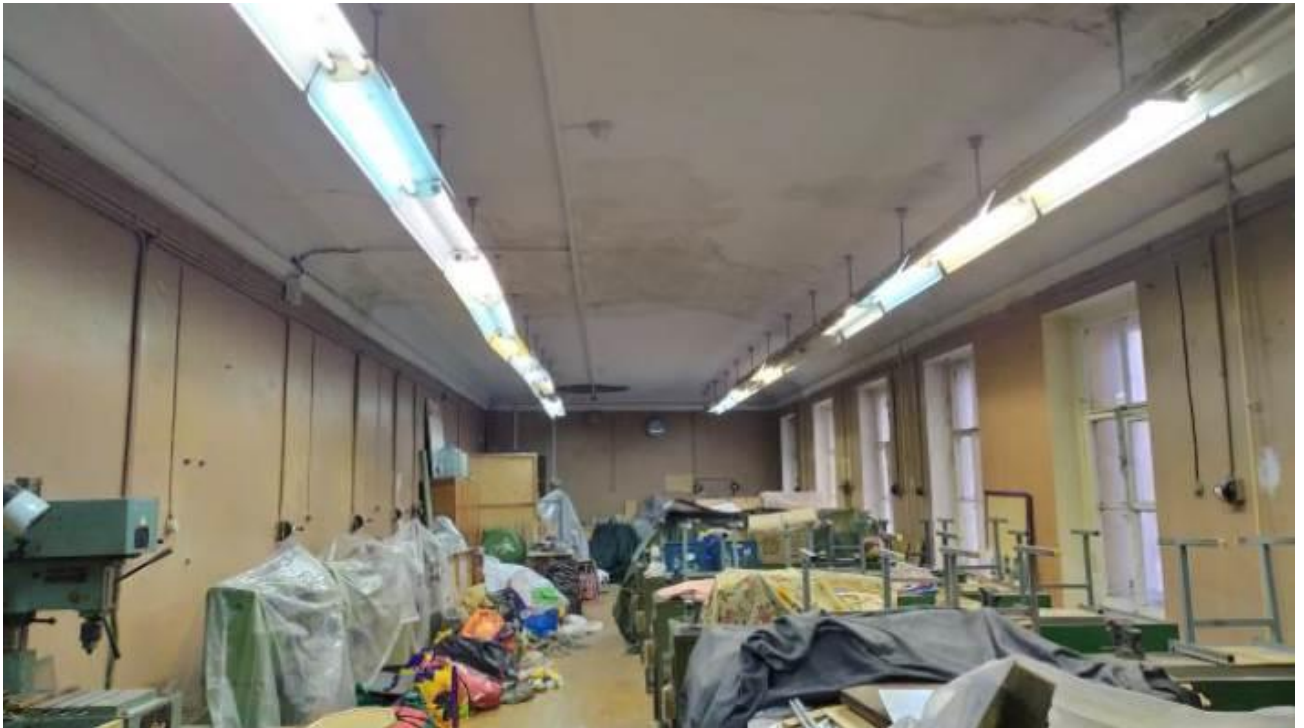
24. Здание Петровского коммерческого училища Санкт-Петербургского купеческого общества (с флигелями, сквером, металлической оградой). 1-й этаж. Аудитории. Штиглиц М.С. 30.11.2020.
