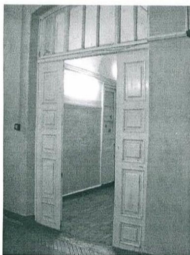
14. Перегородка с дверным заполнением между коридорами.
