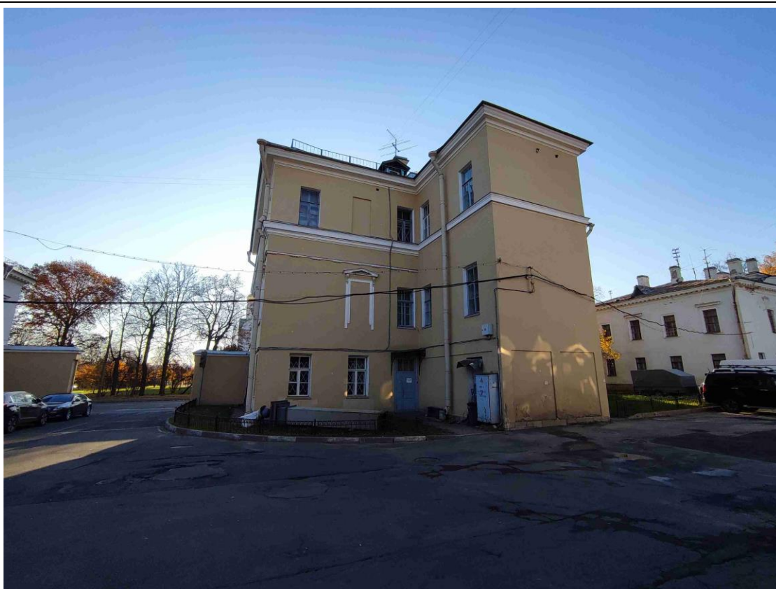
6. Общий вид северо-западного дворового фасада с лестничным ризалитом объекта культурного наследия федерального значения «Управление городское с оградой и воротами».
