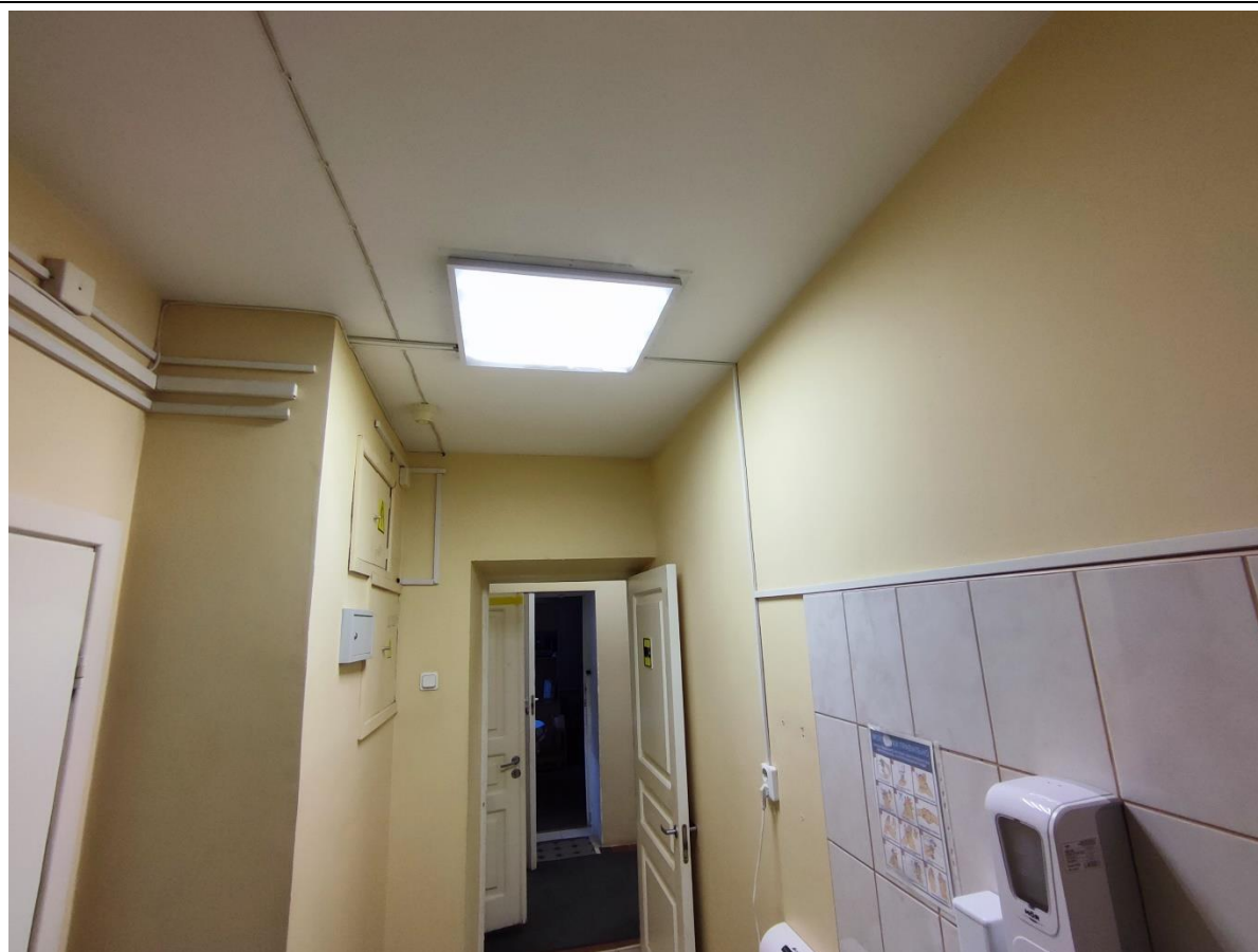
16. Общий вид пом. 1-Н (9) в уровне 1-го этажа.
