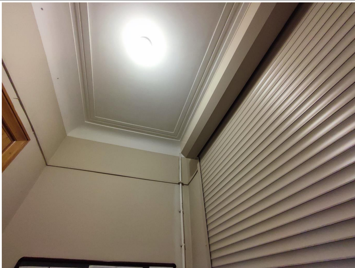
10. Фрагмент пом. 1-Н (1) в уровне 1-го этажа.
