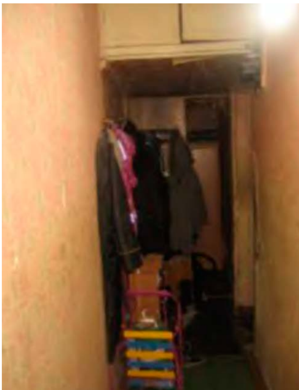
10. Помещение №7 квартиры №3 в уровне 2-го этажа объекта культурного наследия регионального значения «Дом, где в 1906 г. находилась явочная квартира РСДРП». 20.08.2021.
