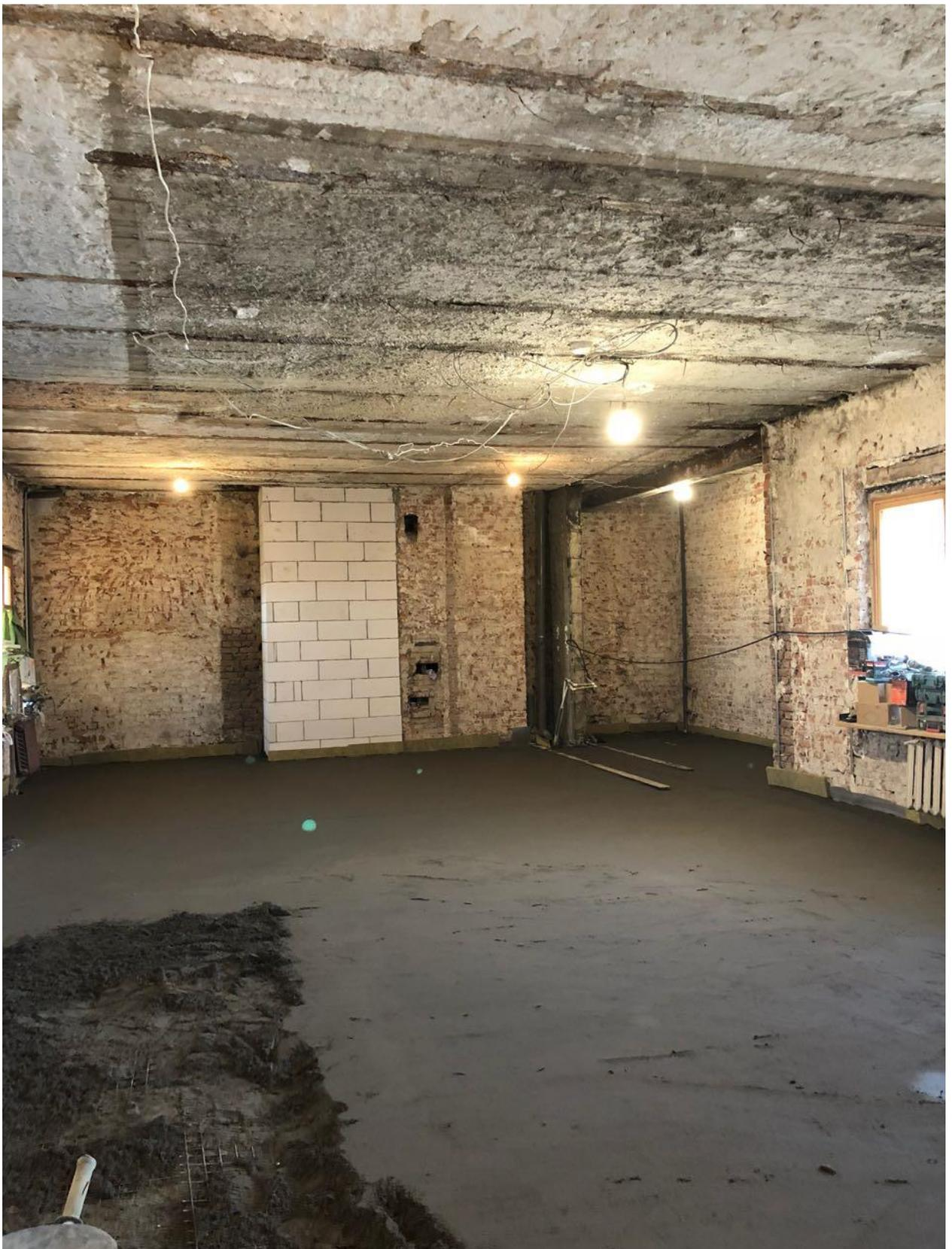
Фото 5. Общий вид пом. № 124(3-14). Ненесущие деревянные перегородки по большей части демонтированы.
