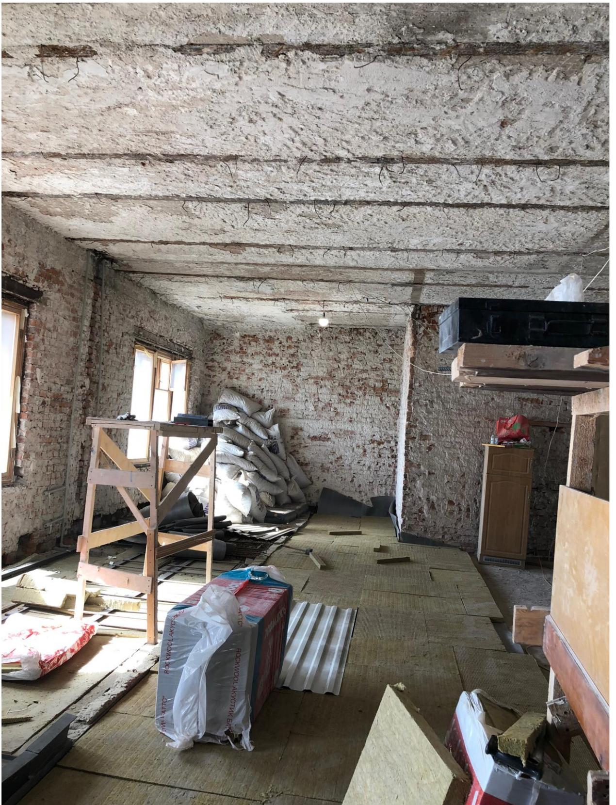
Фото 4. Общий вид пом. № 124(1-3). Несущие деревянные перегородки демонтированы.
