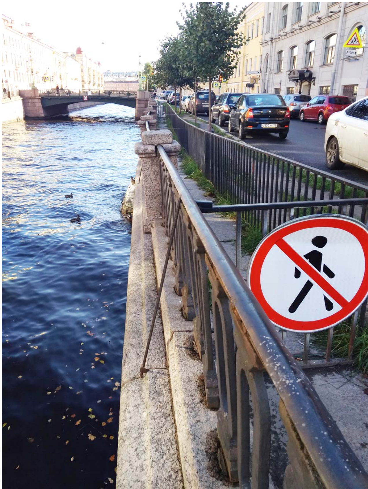
Фото 8. Набережная канала Грибоедова. Фрагмент ограждения и облицовки стенки набережной.
