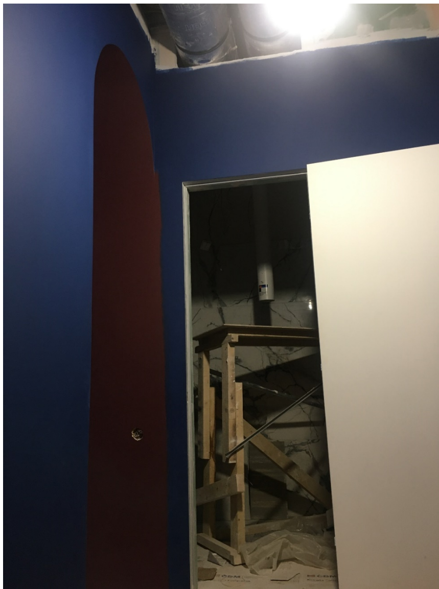
Фото №11. Коридор. Вид на второй санузел.
