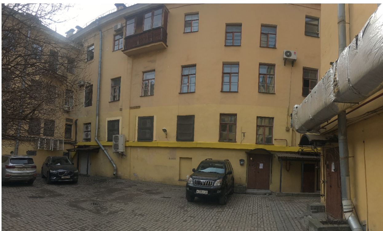
Фото №2. Дворовой фасад. Вход в подъезд.
