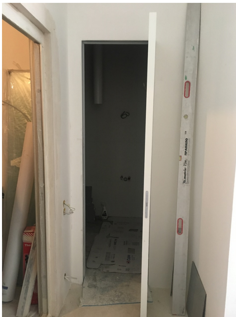
Фото №6. Помещение санузла.
