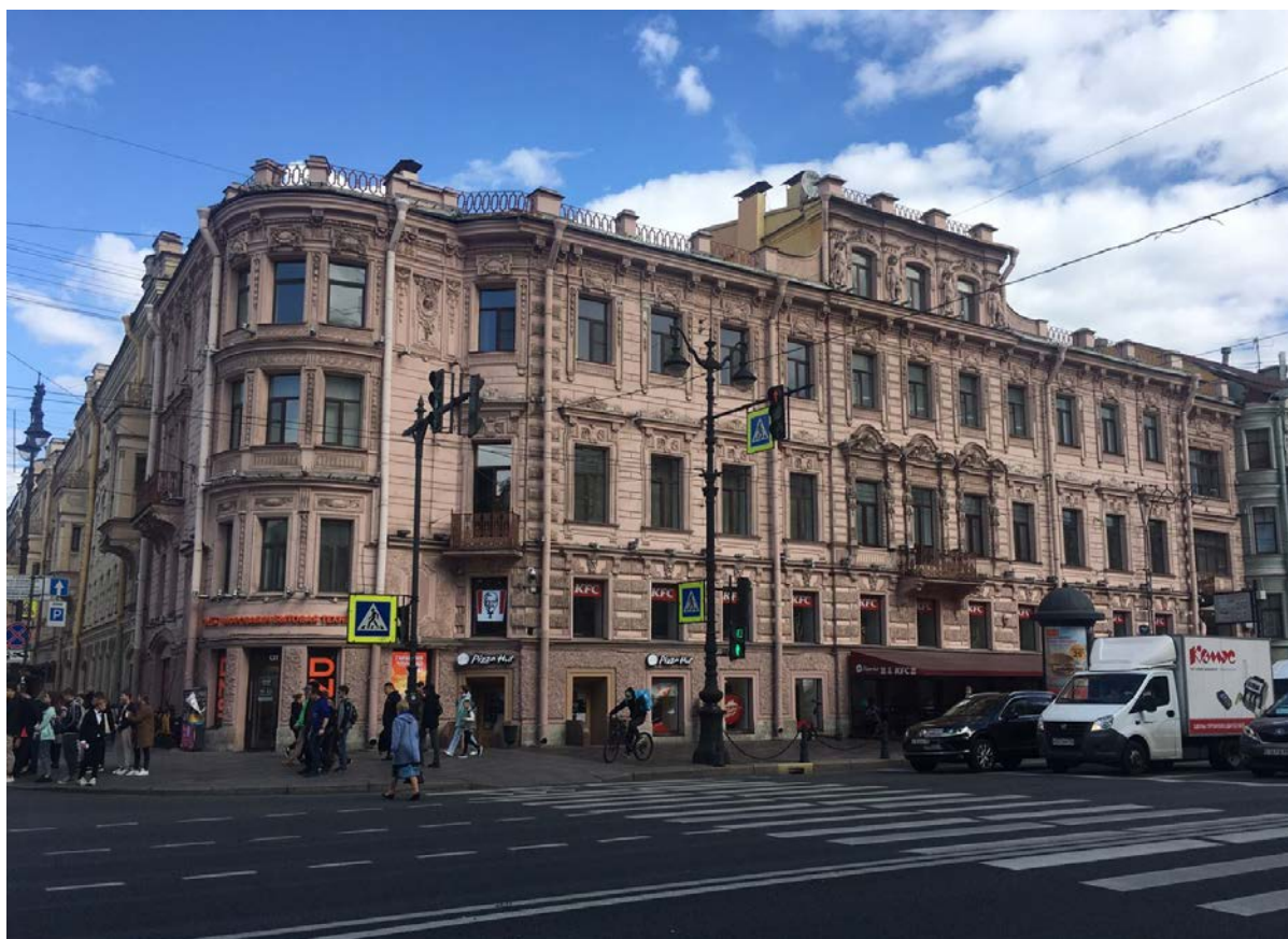
Фото №1. Вид на фасад здания по Невскому пр.
