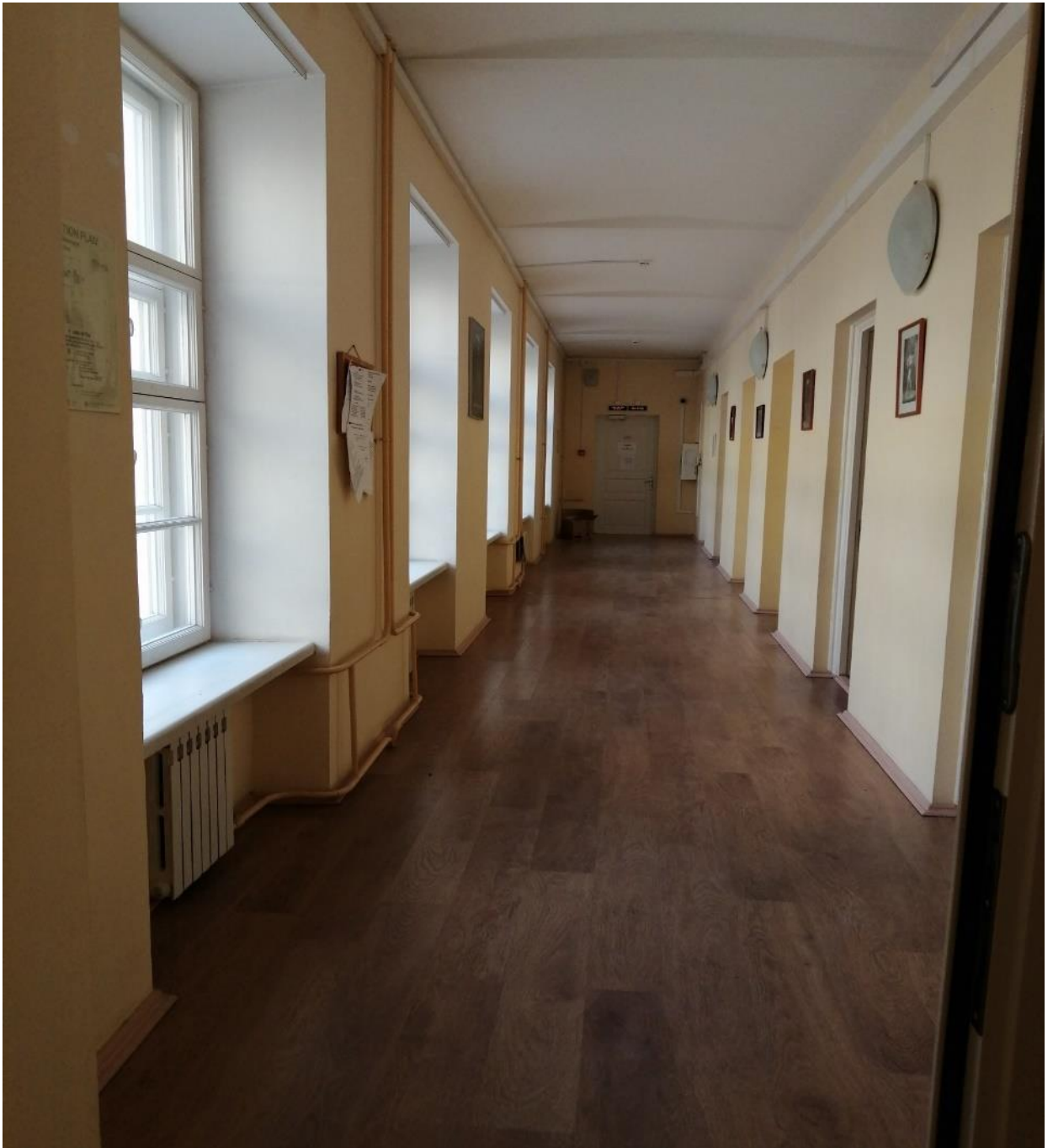
Фото 18. Объект культурного наследия федерального значения «Дирекция императорских театров», расположенный по адресу: Санкт-Петербург, Зодчего Росси ул., 2 Островского пл., 6 Ломоносова пл., 4, в составе объекта культурного наследия федерального значения «Ансамбль улицы Зодчего Росси», расположенного по адресу: Санкт-Петербург, Зодчего Росси ул., 1-3, 2, Островского пл., 6,11, Ломоносова пл., 1,2,4, Торговый пер., 2 . Помещение 87-Н. Рекреация.
