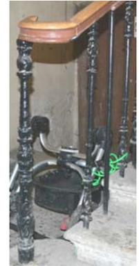
парадная лестница (Л-2) – местоположение (крайняя южная ось северного лицевого корпуса); тип (двухмаршевая), конструкция (по металлическим косоурам), габариты; вид материала ступеней (лещадная плита);
