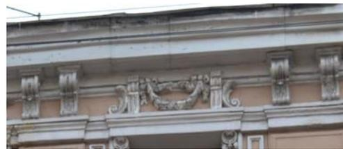
венчающий профилированный карниз на парных кронштейнах с растительным орнаментом, с лепными композициями из провисающей лавровой гирлянды с лентами между стилизованными каннелированными кронштейнами с воллютообразными завитками;
