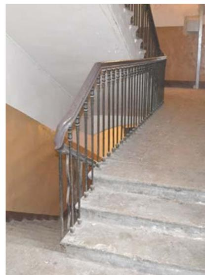
исторические лестницы – местоположение, тип (двухмаршевые – Л-5, Л-9) трехмаршевая – Л-6, конструкция (по металлическим косоурам), габариты; материал ступеней (лещадная плита); лестничное ограждение – материал (черный металл), техника исполнения (литье);
