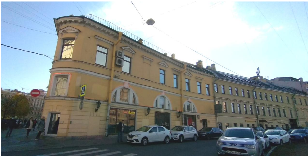
3. Северо-западные фасады флигелей («Дом Терешиных», «Дом Фалевых») по набережной канала Грибоедова (дом 56-58).
