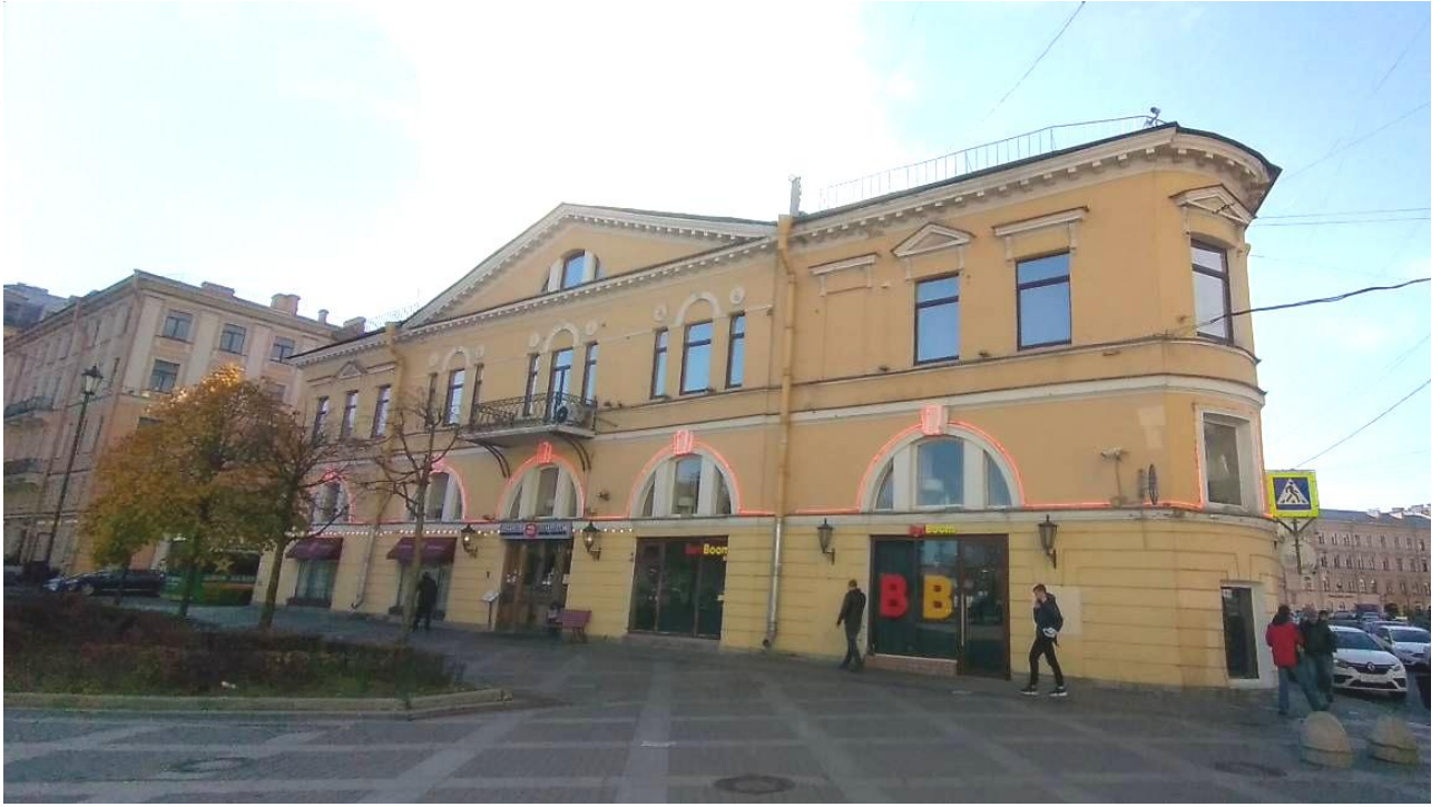
1. Лицевой флигель дома 56 («Дом Терешиных»). Вид на лицевой северо-восточный фасад со стороны Сенной площади.
