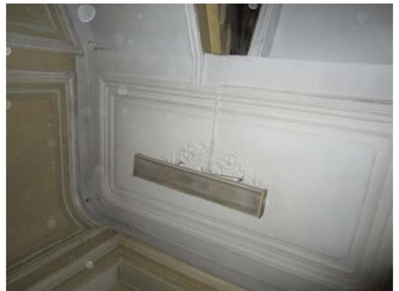
оконный проем лестничной клетки парадной лестницы в уровне 6 этажа оформлен профилированным наличником с замковым камнем, с фигурной филенкой в верхней части с цветочными гирляндами
