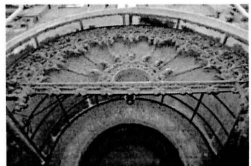
дверное заполнение главного входа – материал (дерево), двустворчатое, полусветлое, с остекленной фрамугой, в нижней части – прямоугольные филенки, профилированные прямые полочки, декорированные «алмазной» гранью, верхней части – мелкая расстекловка (стекло с фацетом);
