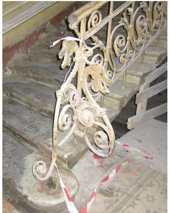
трехмаршевая лестница северного дворового корпуса (2ЛК) со ступенями лещадной плиты, металлическим ограждением в виде вертикальных прутьев, с деревянным поручнем;
