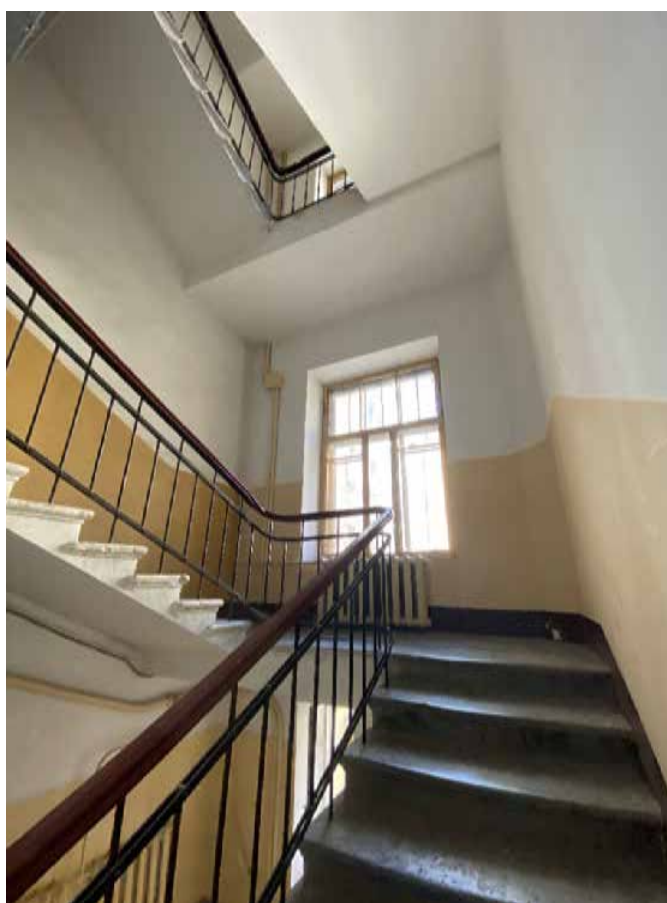
Фото 86. Лестничная клетка Л4 в уровне между 2-м и 3-м этажами.
