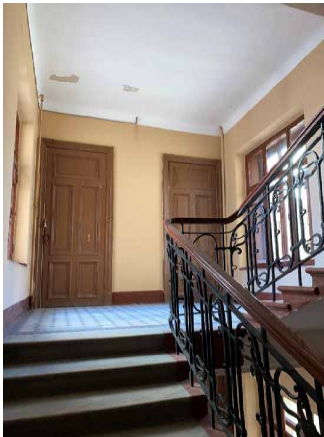
Фото 76. Лестничная клетка ЛЗ в уровне 5-го этажа.
