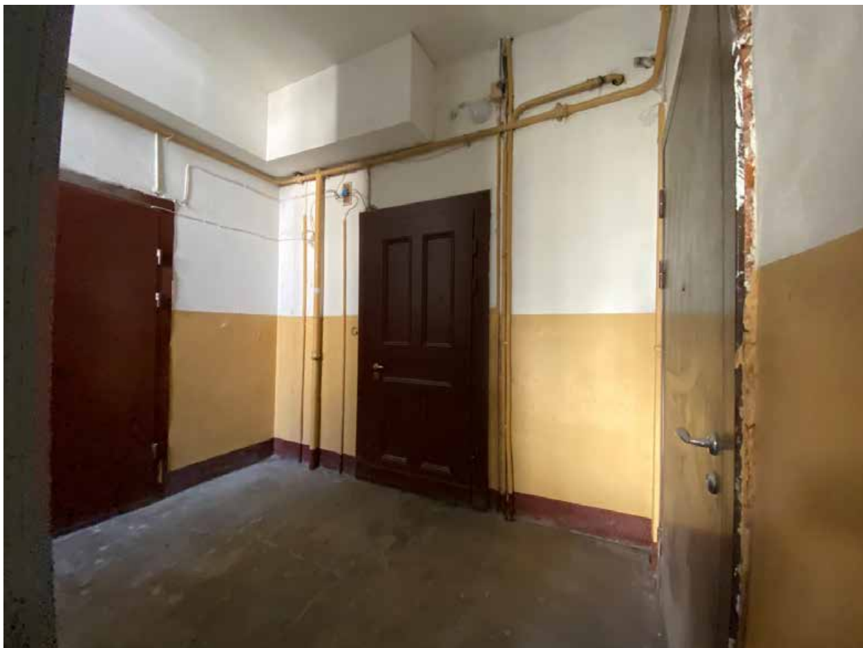
Фото 88. Лестничная клетка Л4 в уровне 3-го этажа.
