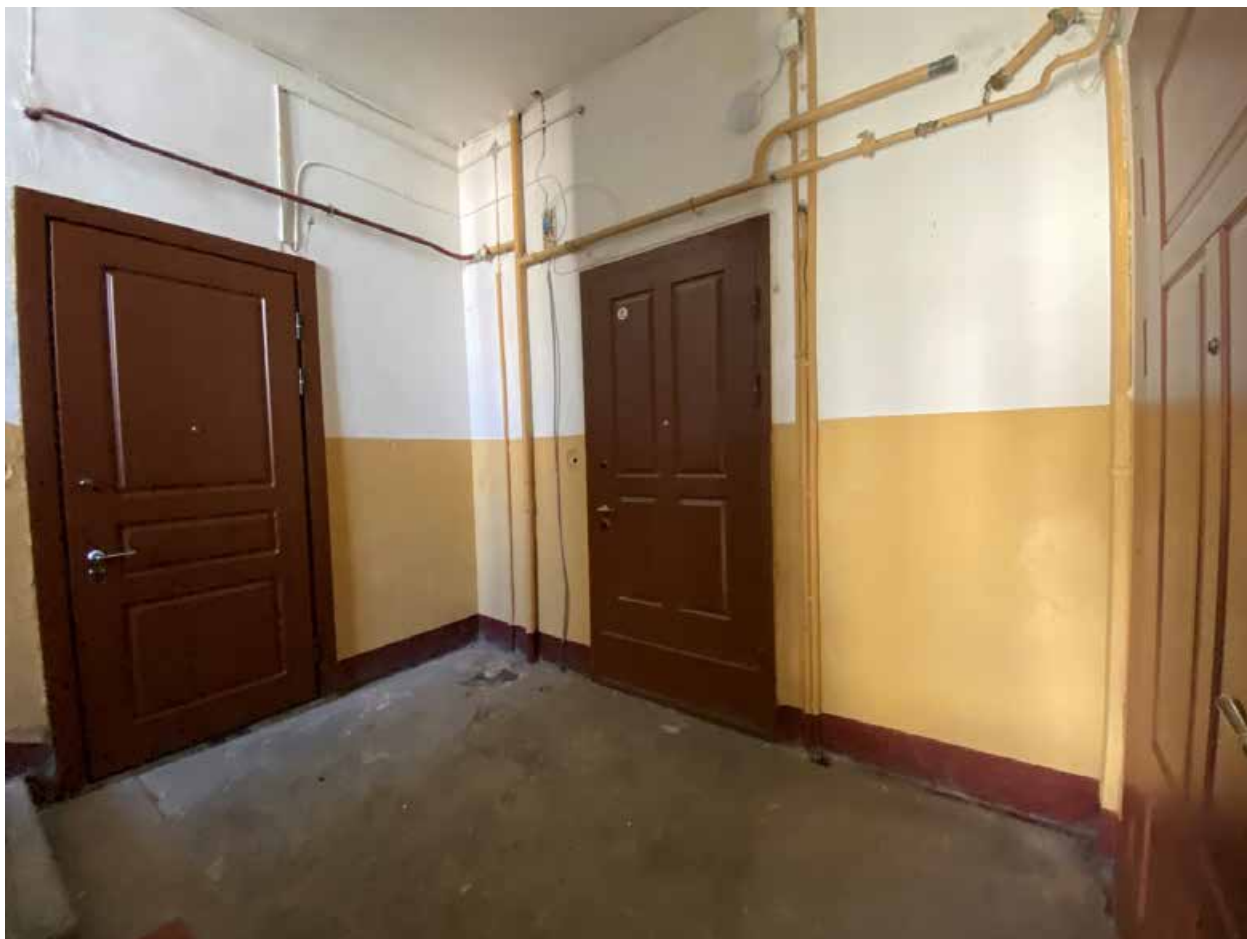
Фото 91. Лестничная клетка Л4 в уровне 4-го этажа.
