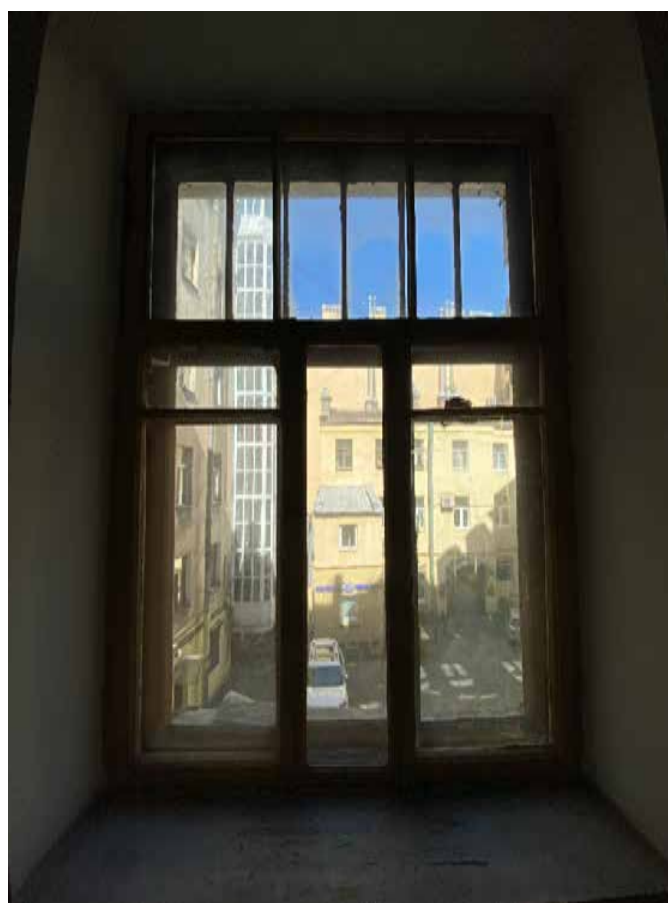
Фото 87. Историческое деревянное оконное заполнение.
