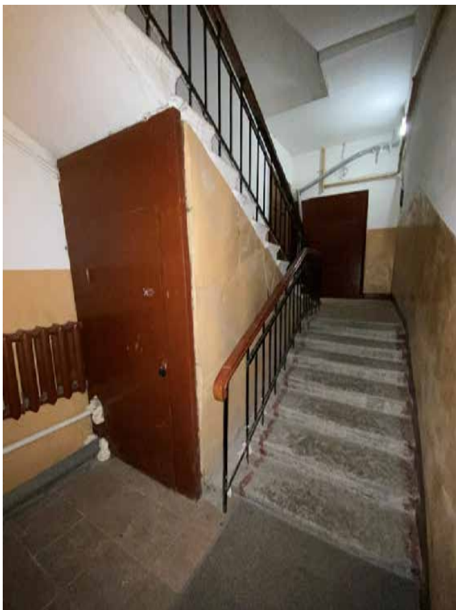
Фото 50. Лестничная клетка Л2 в уровне 1-го этажа.
