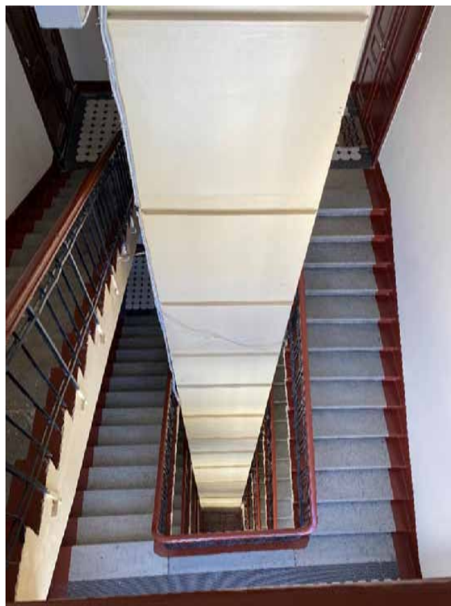
Фото 113. Общий вид лестничного объема.
