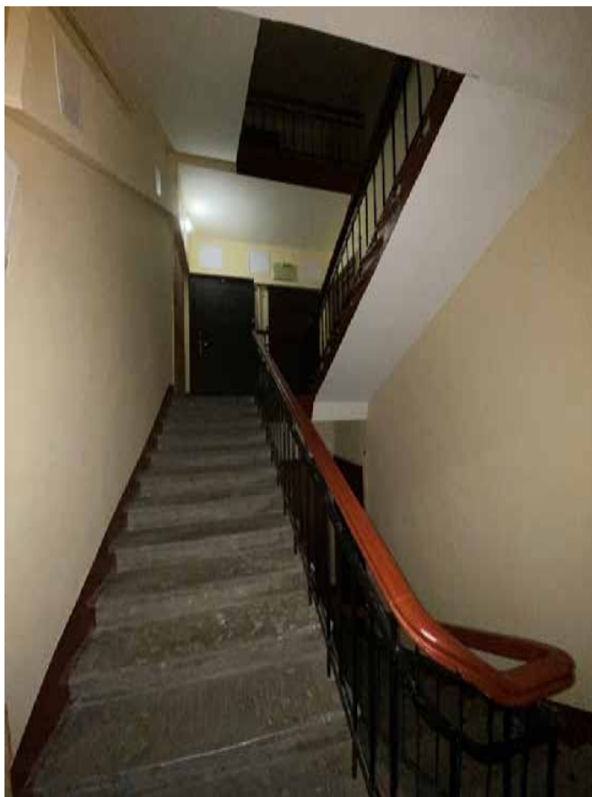
Фото 49. Лестничная клетка Л1 в уровне 6-го этажа.
