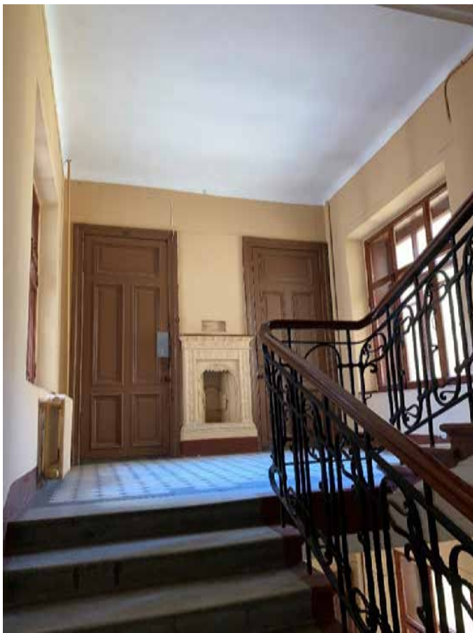
Фото 73. Лестничная клетка ЛЗ в уровне 4-го этажа.
