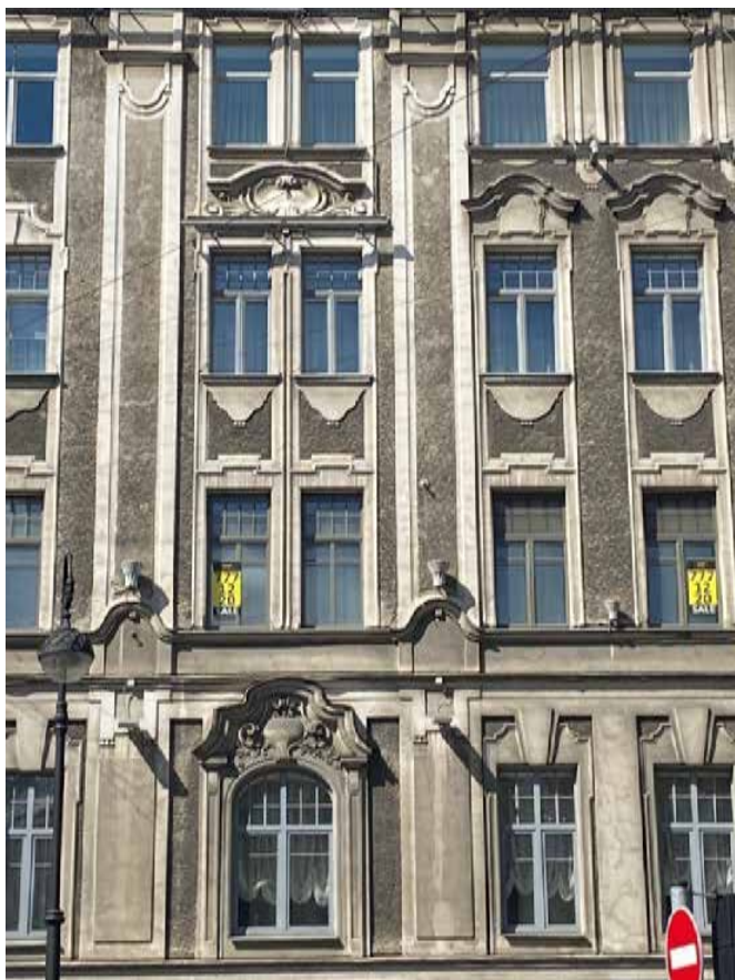
Фото 19. Оформление оконных проемов
