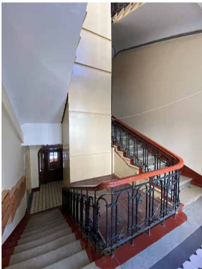
Фото 101. Лестничная клетка Л5 в уровне между 1-м и 2-м этажами.
