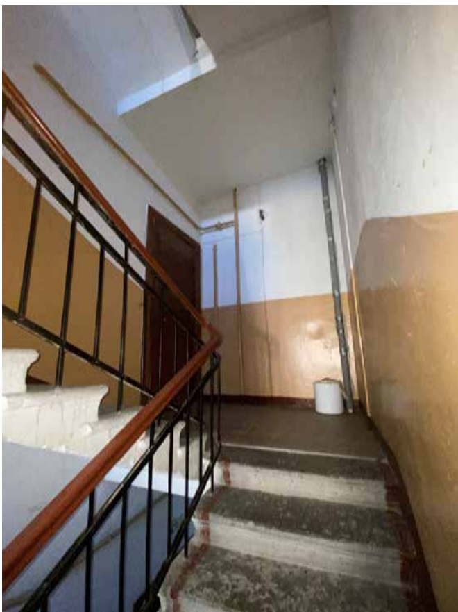
Фото 54. Лестничная клетка Л2 в уровне 3-го этажа.
