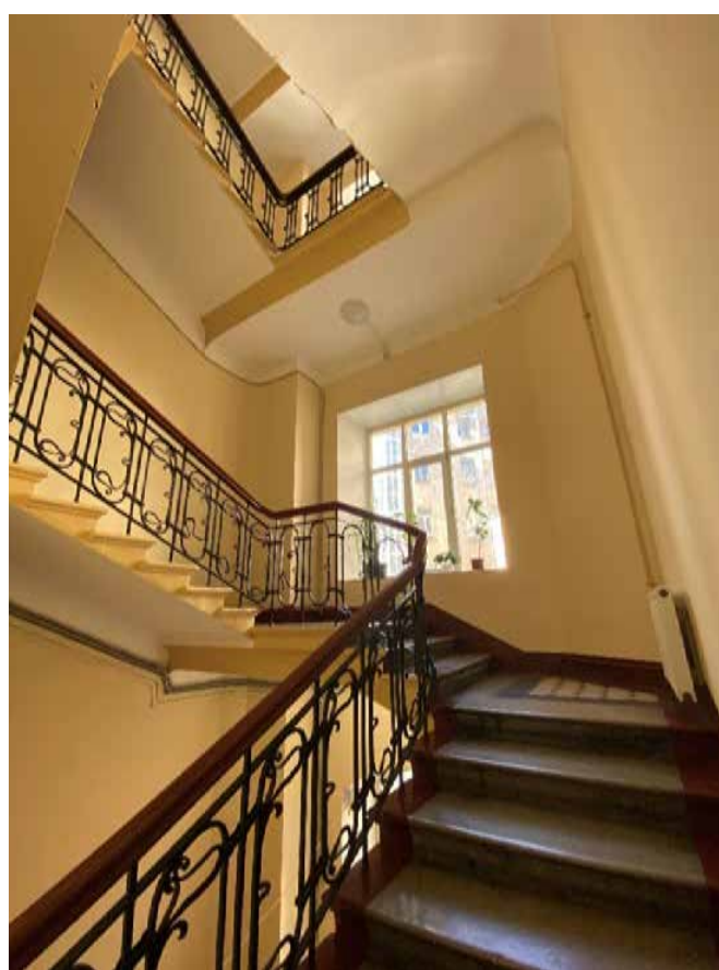
Фото 105. Лестничная клетка Л5 в уровне между 2-м и 3-м этажами.
