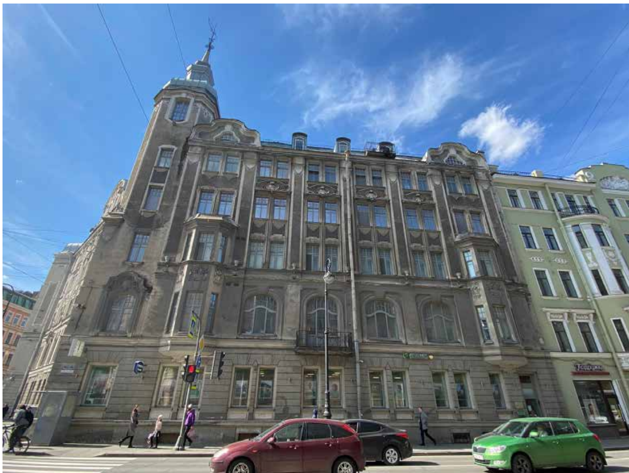
Фото 3. Северо-восточный лицевой фасад, выходящий на Каменноостровский проспект.
