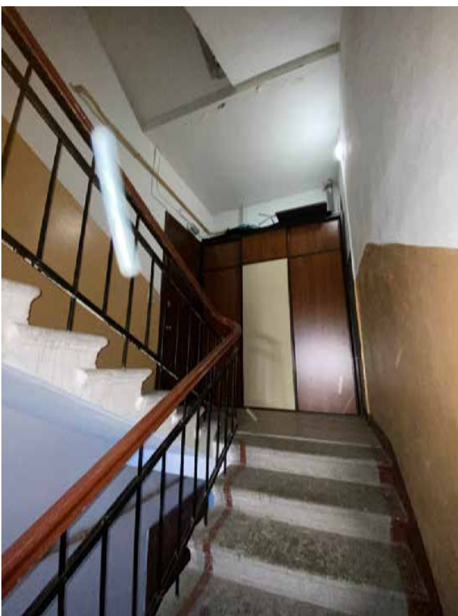
Фото 56. Лестничная клетка Л2 в уровне 4-го этажа.
