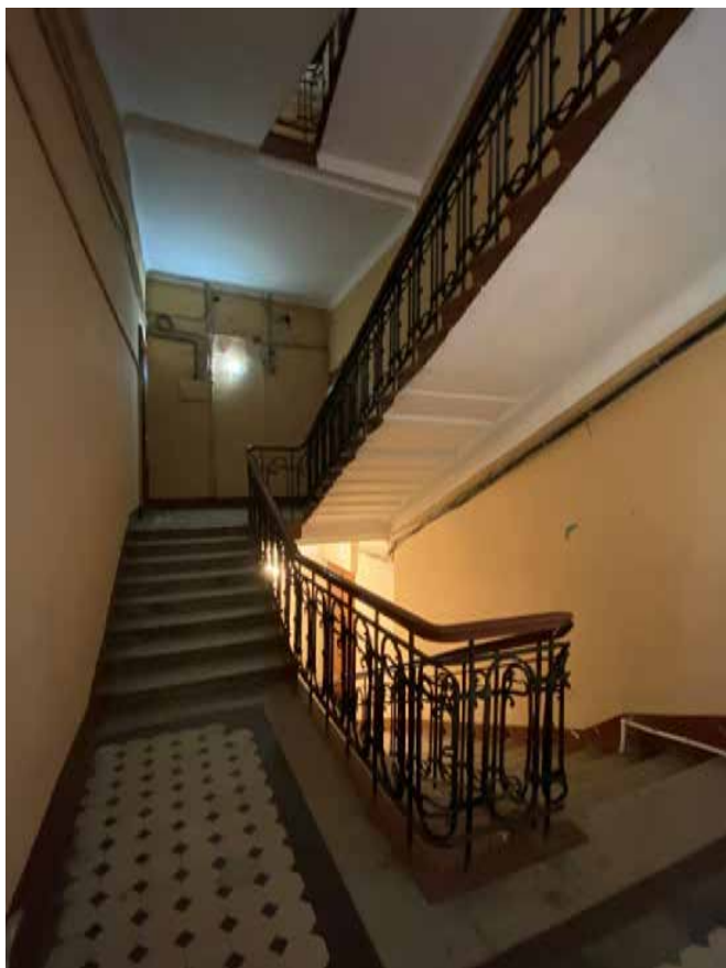
Фото 68. Лестничная клетка ЛЗ в уровне 2-го этажа.
