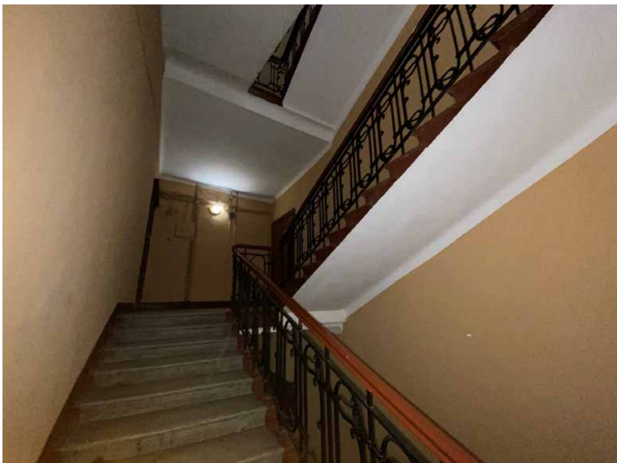
Фото 72. Лестничная клетка ЛЗ в уровне 3-го этажа.
