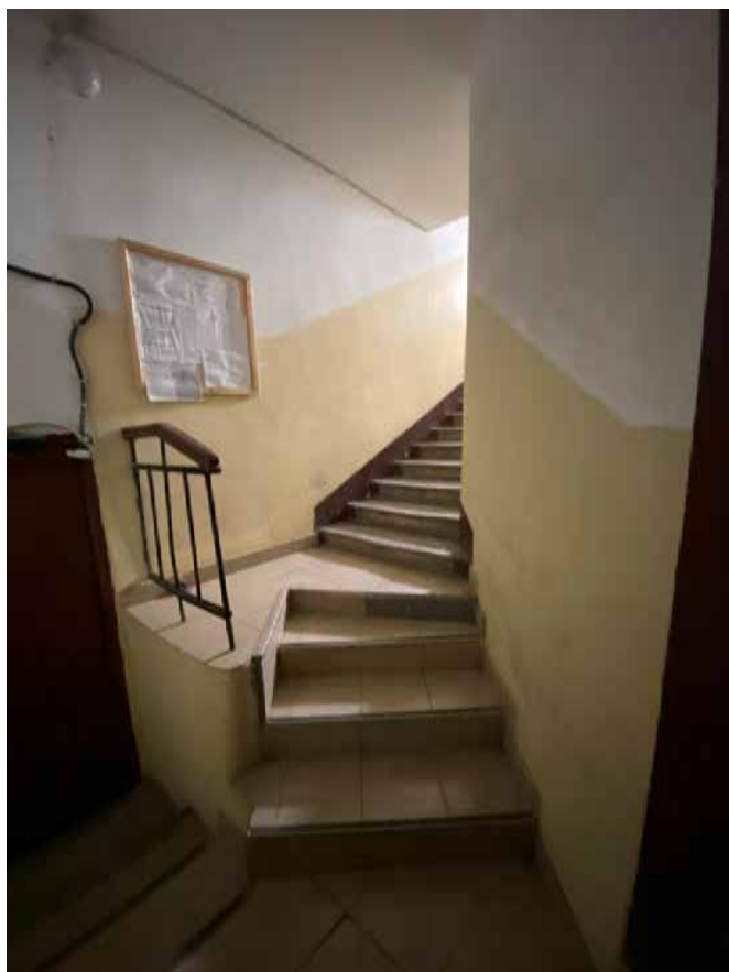
Фото 81. Вестибюль лестничной клетки Л4.
