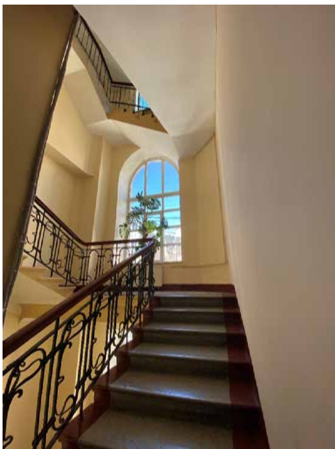
Фото 109. Лестничная клетка Л5 в уровне между 4-м и 5-м этажами.
