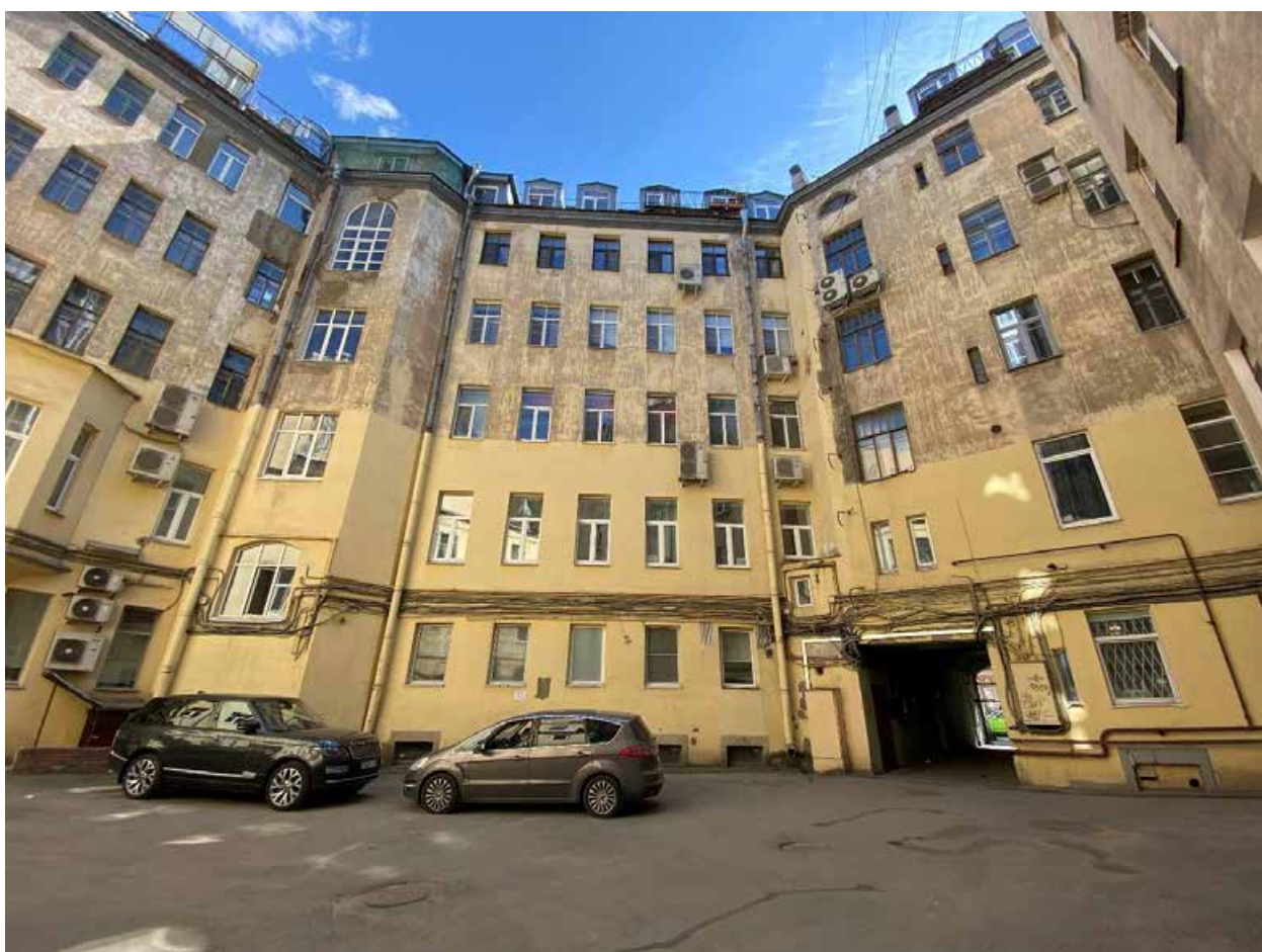
Фото 27. Северо-западный и западный дворовые фасады лицевого корпуса.
