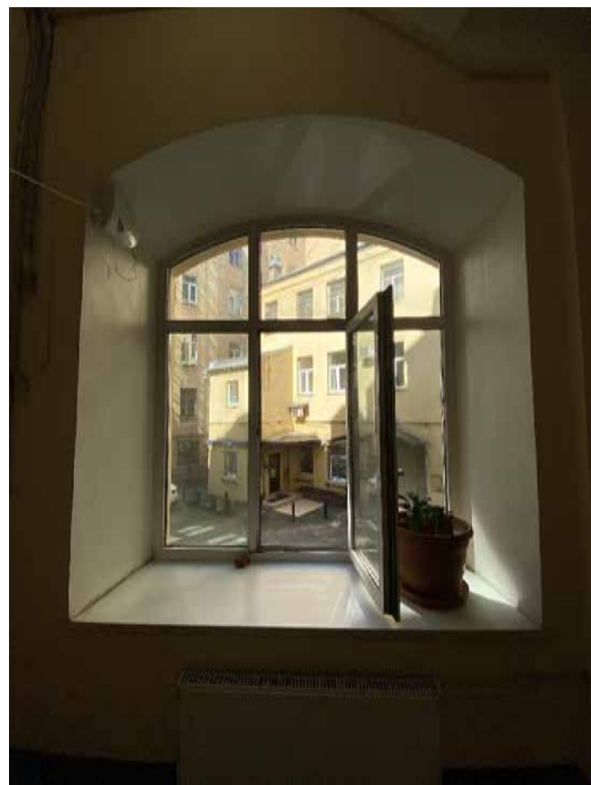
Фото 102. Современные оконные заполнения на лестничной клетке Л5.
