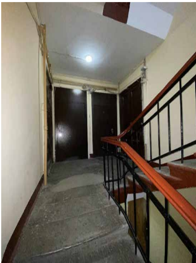
Фото 42. Лестничная клетка Л1 в уровне 2-го этажа.
