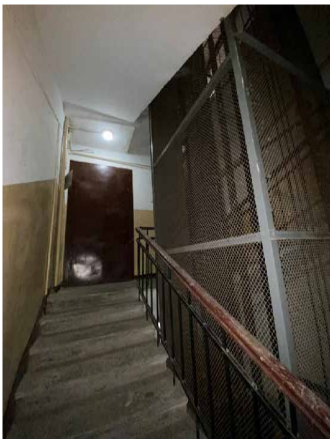
Фото 116. Лестничная клетка Лб в уровне 2-го этажа.
