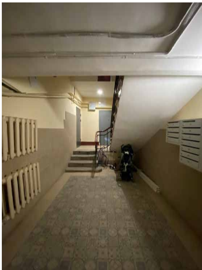
Фото 36. Вестибюль лестничной клетки Л1. Общий вид.
