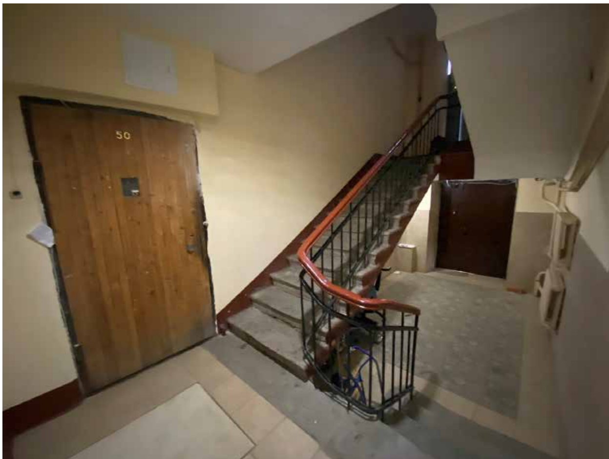
Фото 39. Лестничная клетка Л1 в уровне 1-го этажа.
