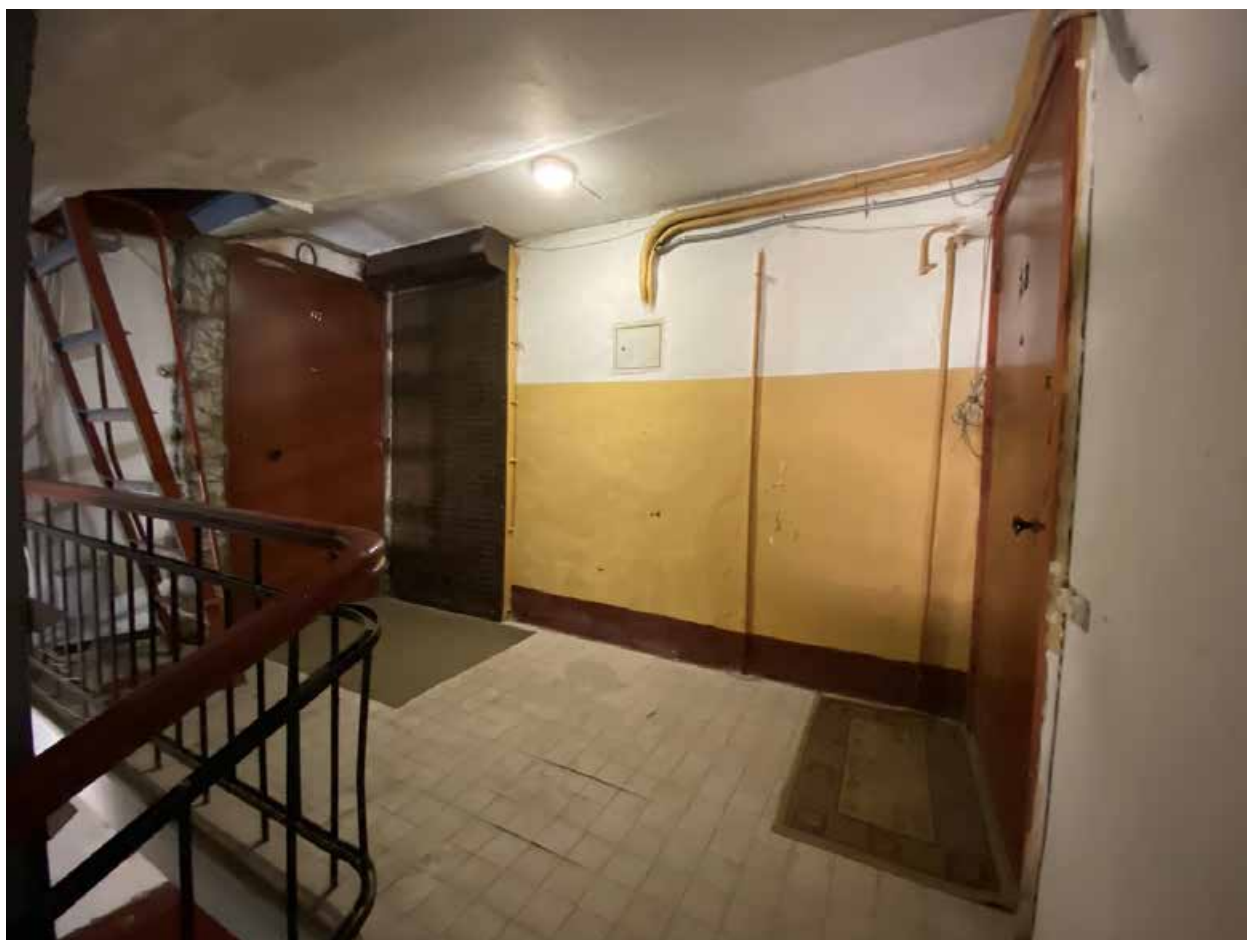
Фото 95. Лестничная клетка Л4 в уровне мансардного этажа.
