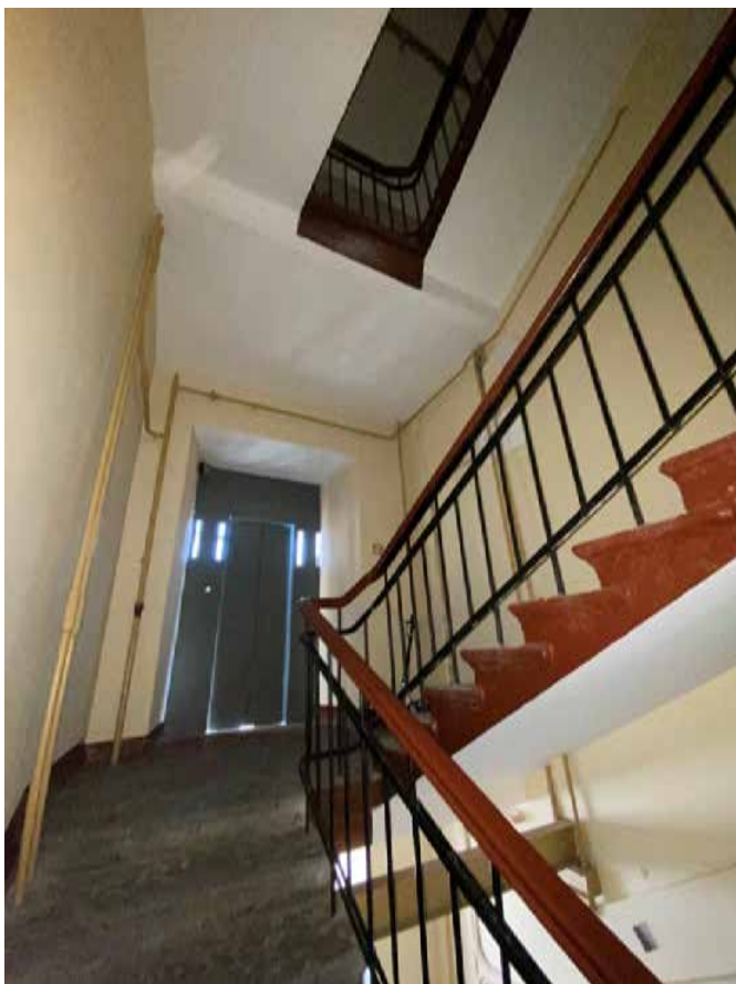
Фото 48. Лестничная клетка Л1 в уровне между 5-м и 6-м этажами.
