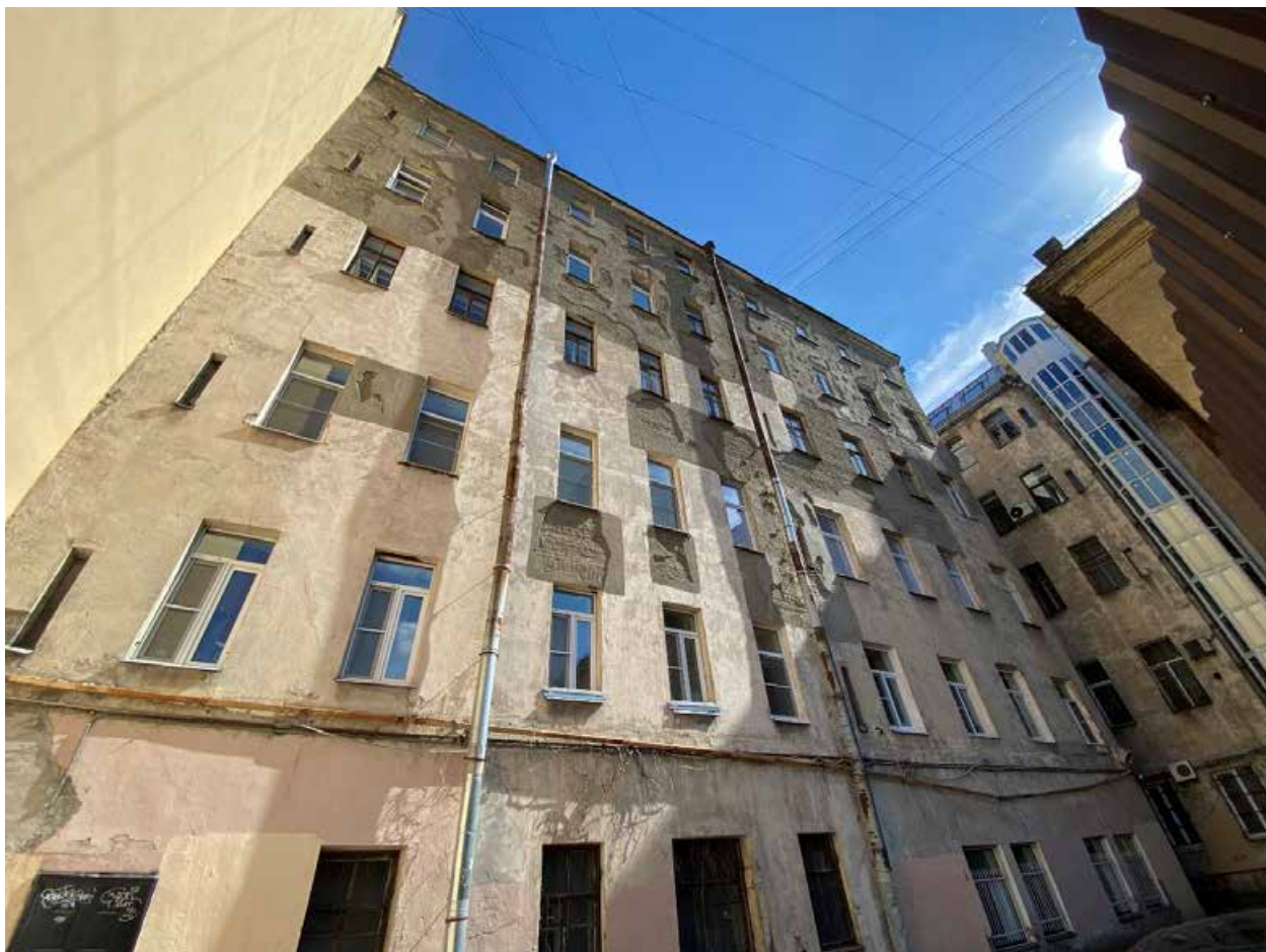
Фото 33. Юго-западный фасад дворового флигеля.
