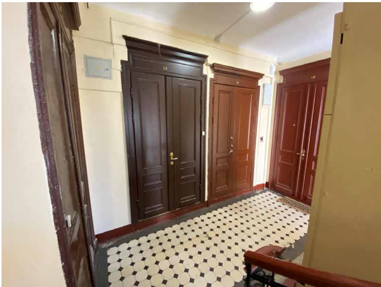
Фото 111. Лестничная клетка Л5 в уровне 5-го этажа.
