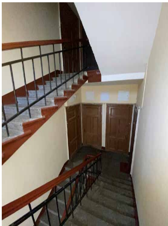
Фото 45. Лестничная клетка Л1 в уровне 4-го этажа.
