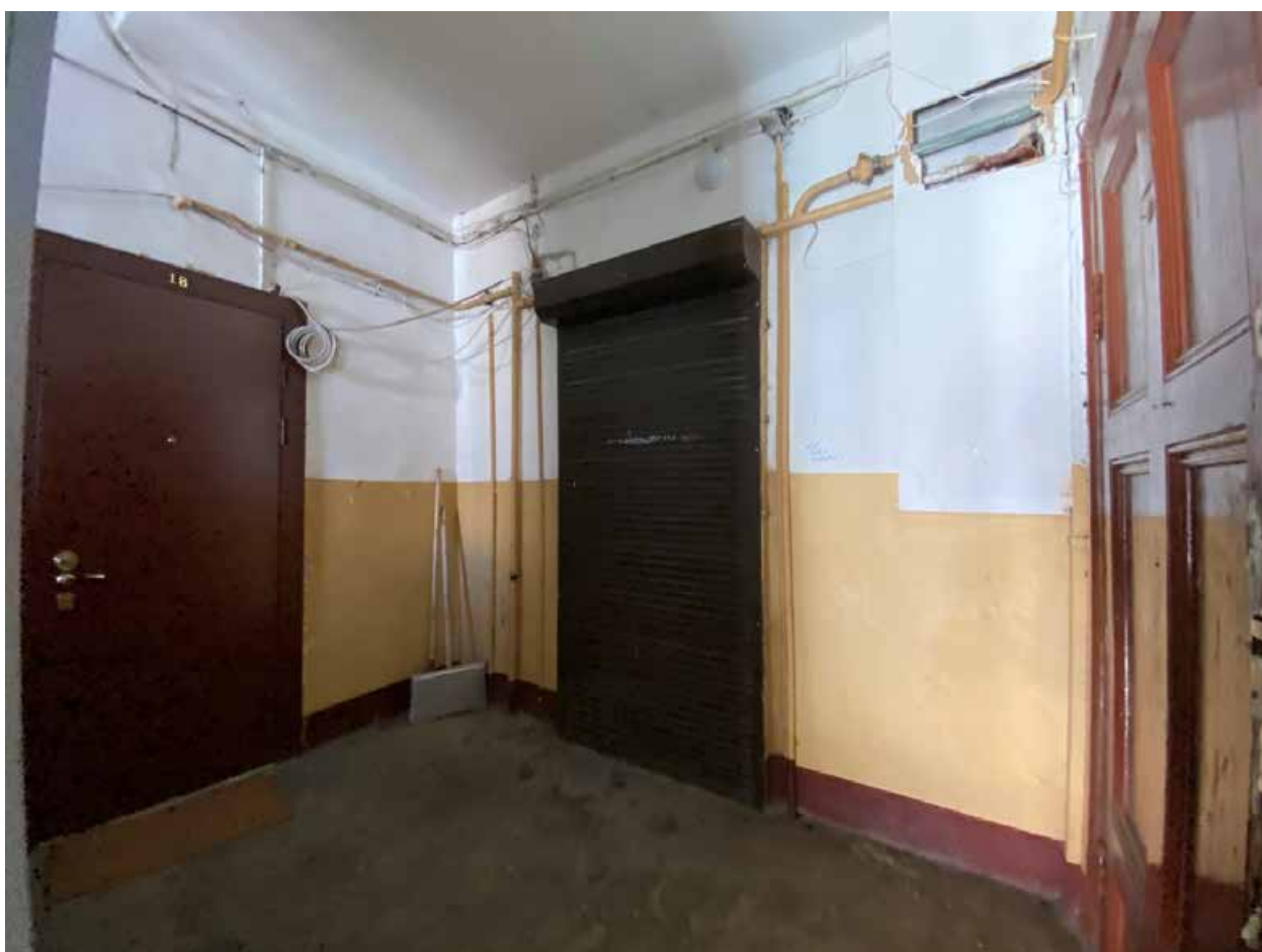
Фото 92. Лестничная клетка Л4 в уровне 5-го этажа.
