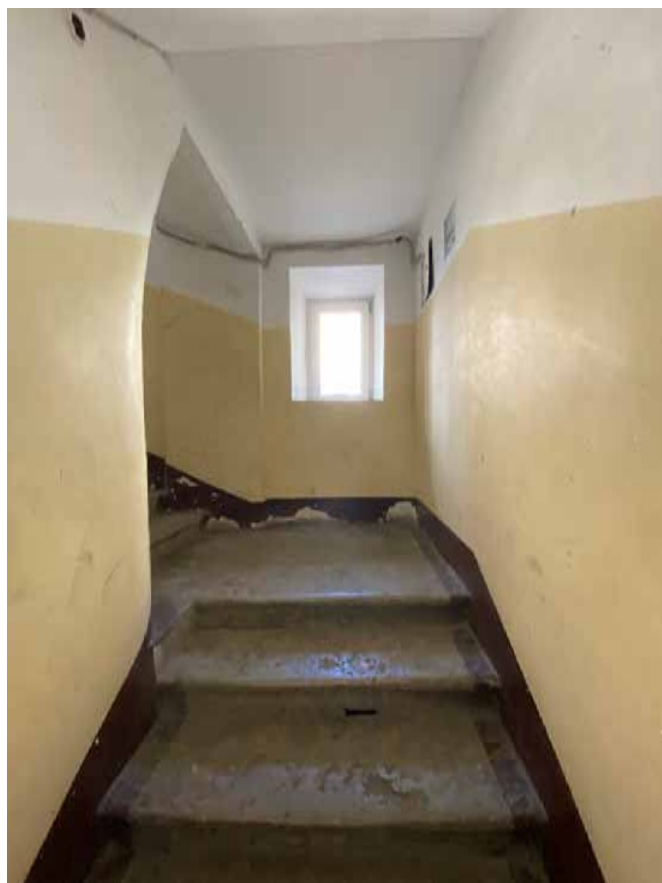
Фото 82. Вестибюль лестничной клетки Л4.
