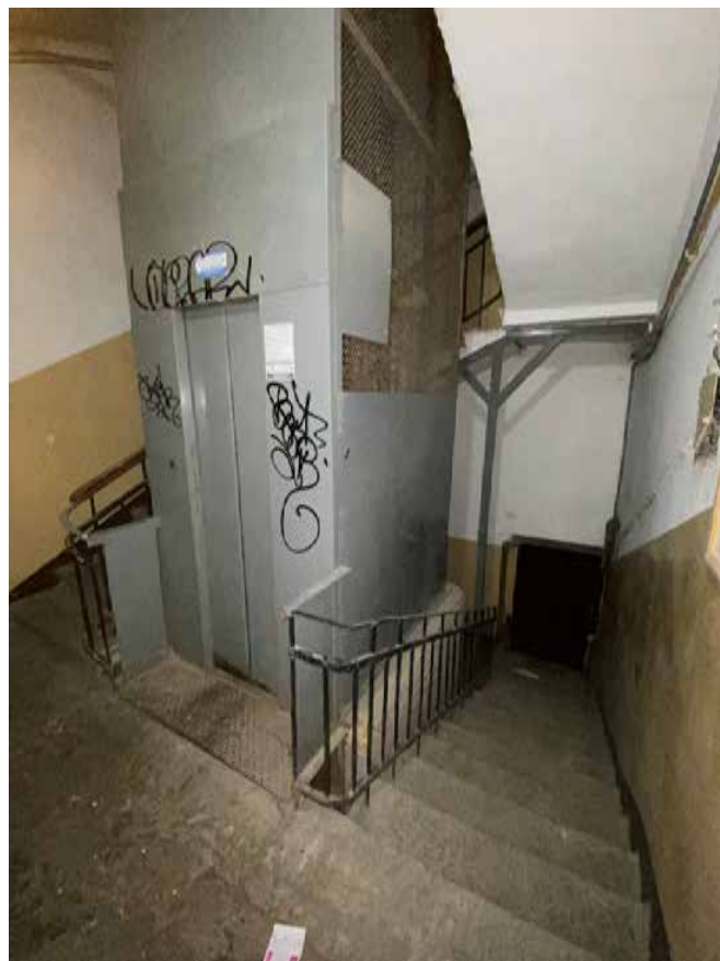
Фото 115. Лестничная клетка Лб в уровне 1-го этажа.
