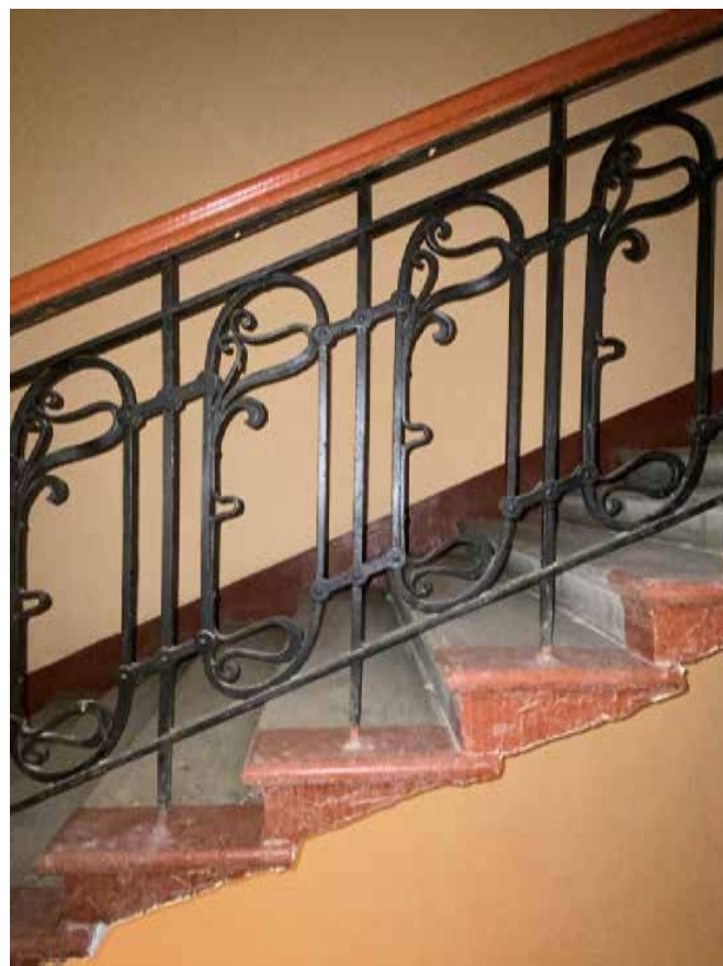
Фото 65. Ограждение маршей лестничной клетки ЛЗ.
