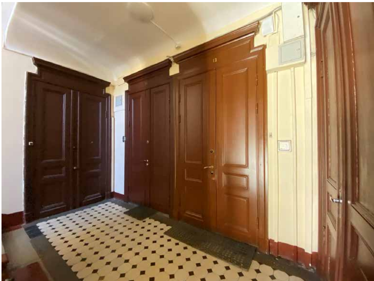
Фото 108. Лестничная клетка Л5 в уровне 4-го этажа.
