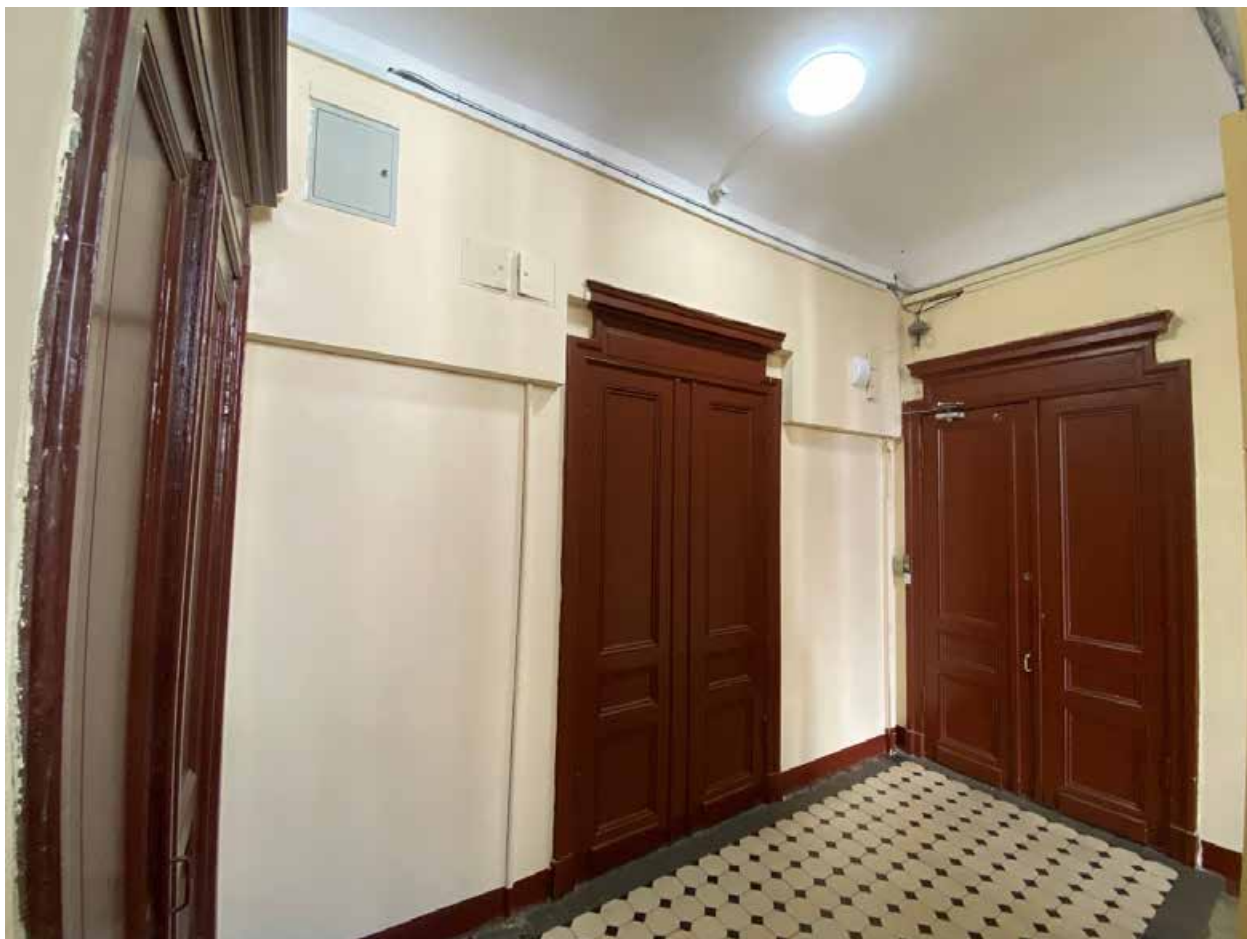
Фото 103. Лестничная клетка Л5 в уровне 2-го этажа.
