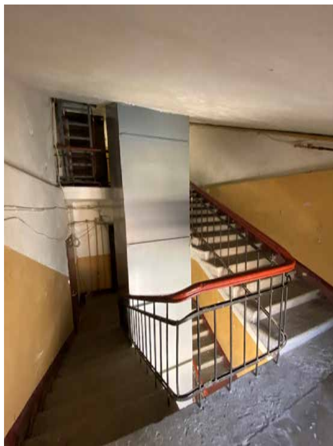
Фото 94. Лестничная клетка Л4 в уровне между 5-м и мансардным этажами.
