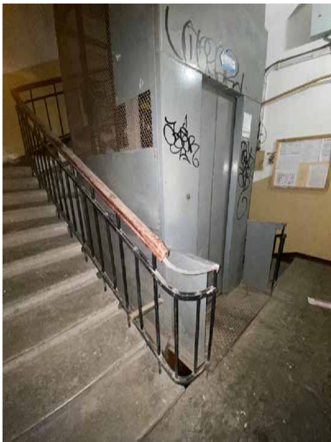
Фото 114. Лестничная клетка Лб в уровне 1-го этажа.
