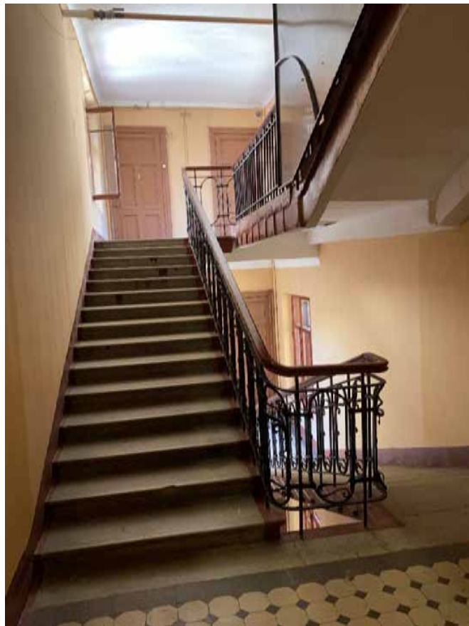
Фото 78. Лестничная клетка ЛЗ в уровне мансардного этажа.
