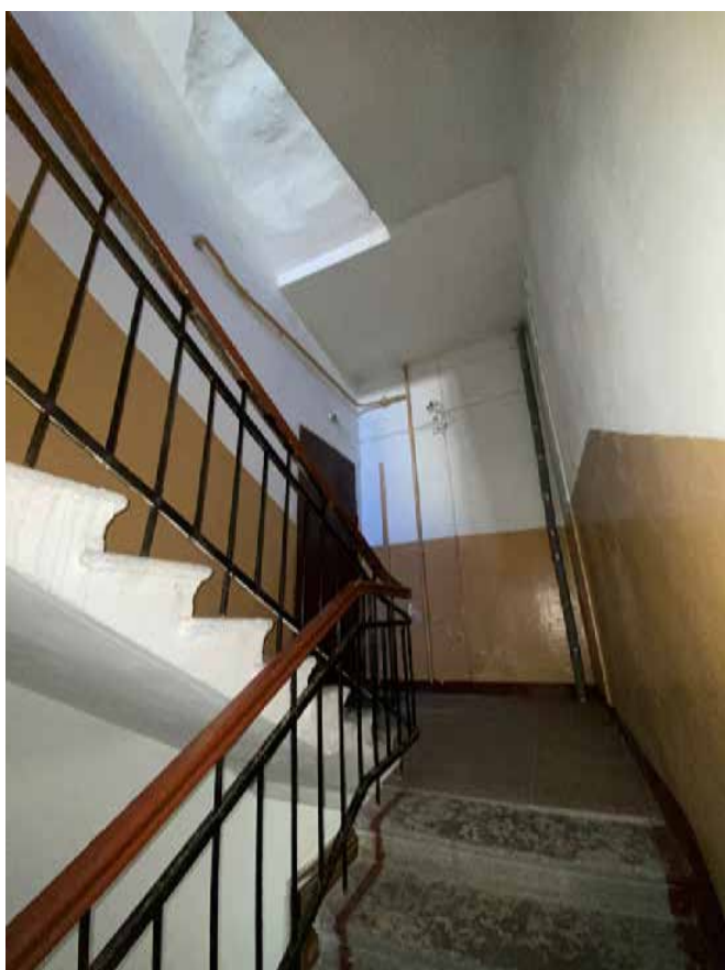
Фото 52. Лестничная клетка Л2 в уровне 2-го этажа.
