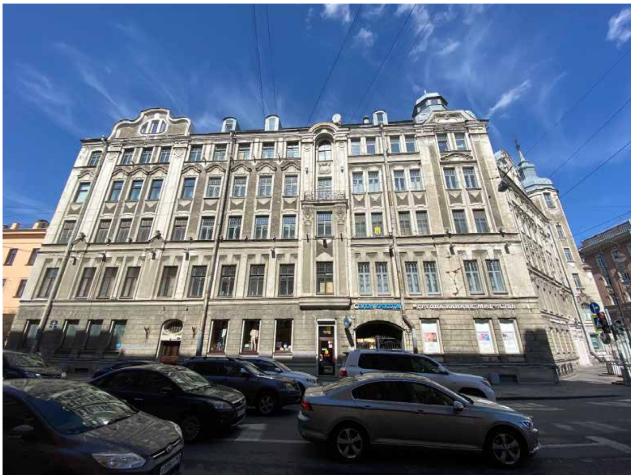
Фото 5. Юго-восточный лицевой фасад, выходящий на улицу Мира.
