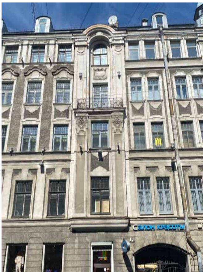
Фото 21. Уплощенный эркер на уровне 2–3-го этажей, завершенный балконом на уровне 4-го этажа.
