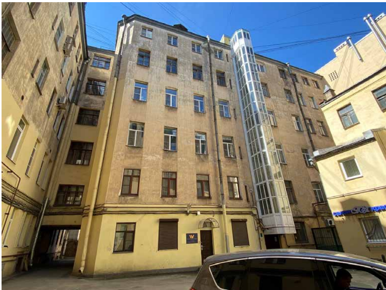
Фото 28. Северо-восточный дворовой фасад флигеля.
