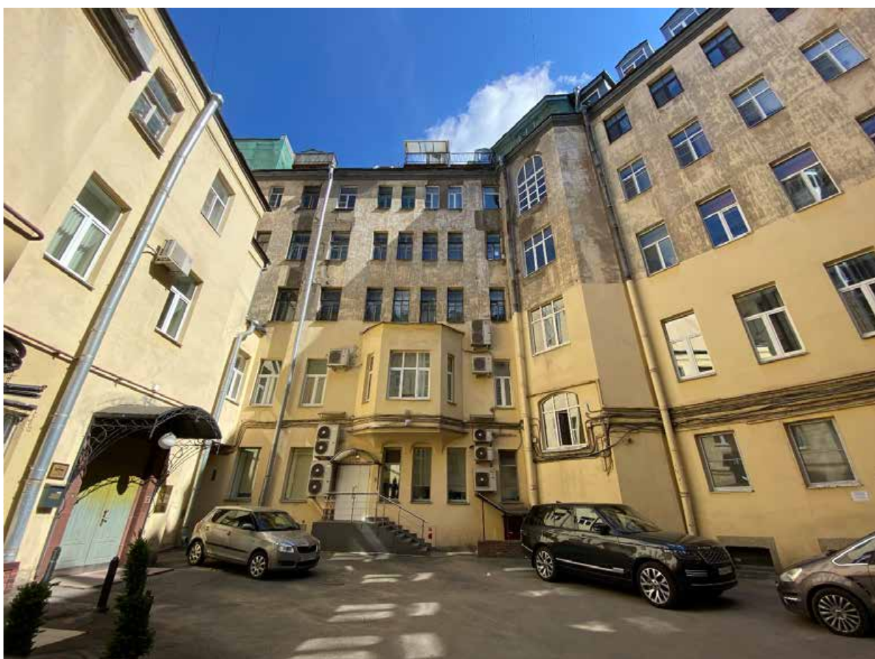
Фото 29. Юго-западный дворовой фасад лицевого корпуса.
