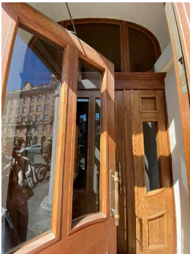
Фото 96. Парадная лестничная клетка Л5. Тамбур.
