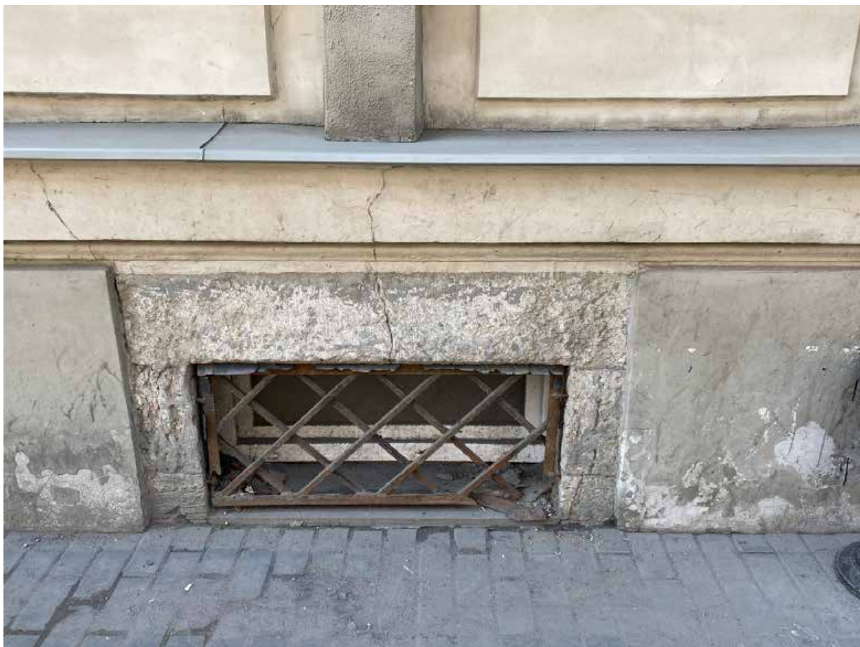
Фото 16. Оконные проемы подвала, оформленные гладкими наличниками.
