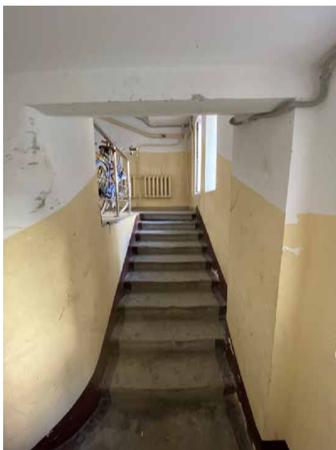
Фото 83. Вестибюль лестничной клетки Л4.
