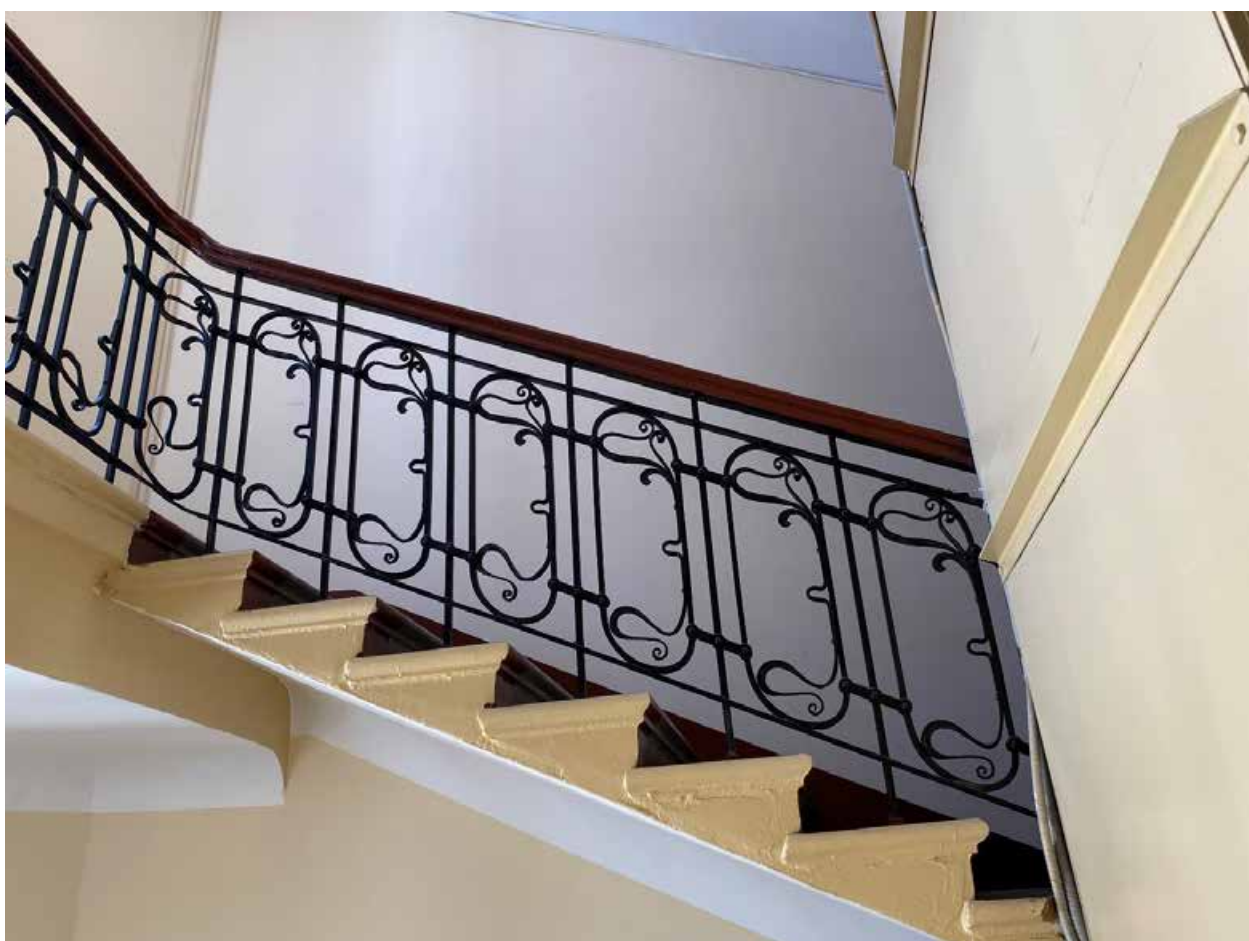
Фото 107. Ограждение маршей лестничной клетки Л5.
