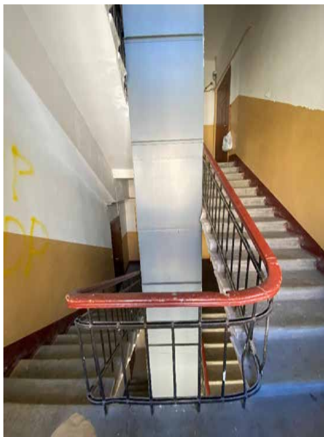
Фото 90. Лестничная клетка Л4 в уровне между 3-м и 4-м этажами.
