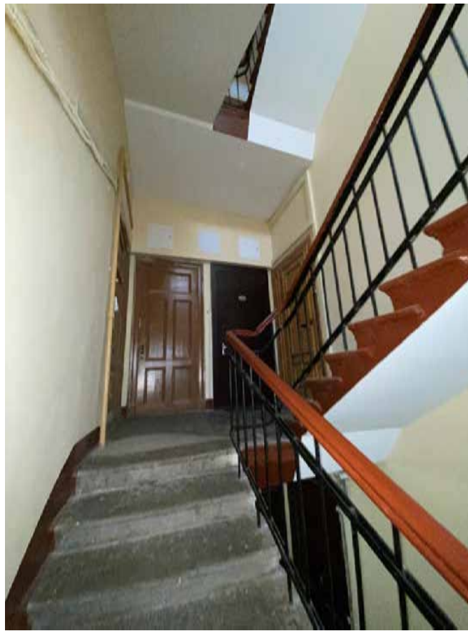
Фото 43. Лестничная клетка Л1 в уровне 3-го этажа.
