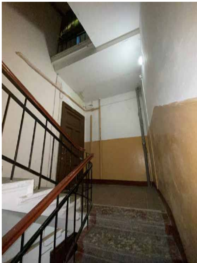
Фото 58. Лестничная клетка Л2 в уровне 5-го этажа.
