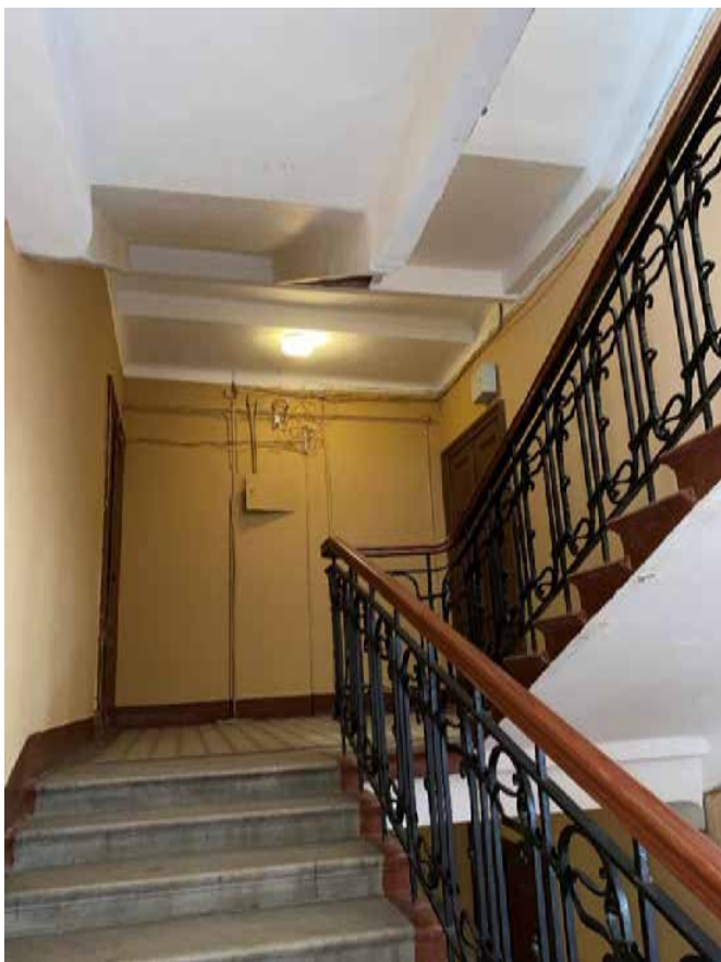
Фото 77. Лестничная клетка ЛЗ в уровне 5-го этажа.
