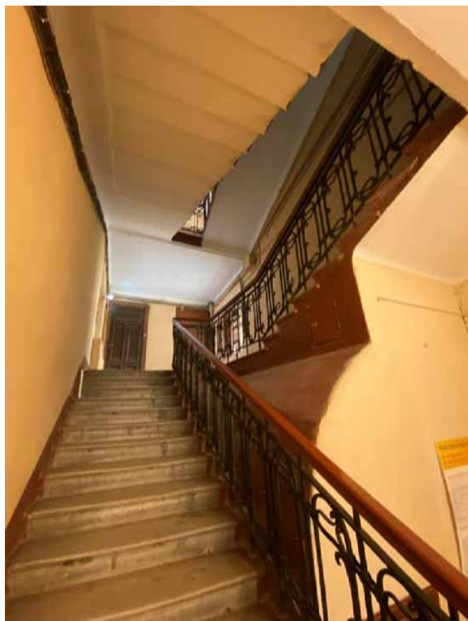
Фото 64. Лестничная клетка ЛЗ в уровне между 1-м и 2-м этажами.
