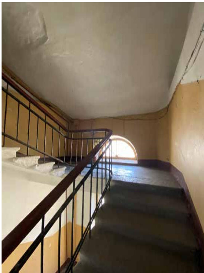
Фото 93. Лестничная клетка Л4 в уровне между 5-м и мансардным этажами.
