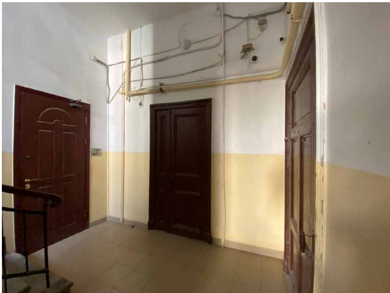
Фото 85. Лестничная клетка Л4 в уровне 2-го этажа.
