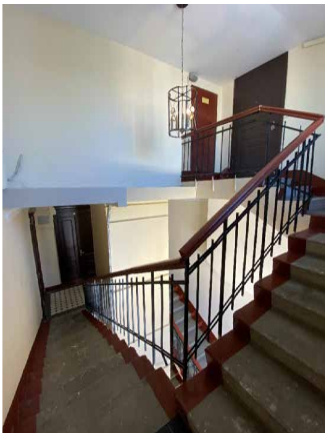
Фото 112. Лестничная клетка Л5 в уровне мансардного этажа.
