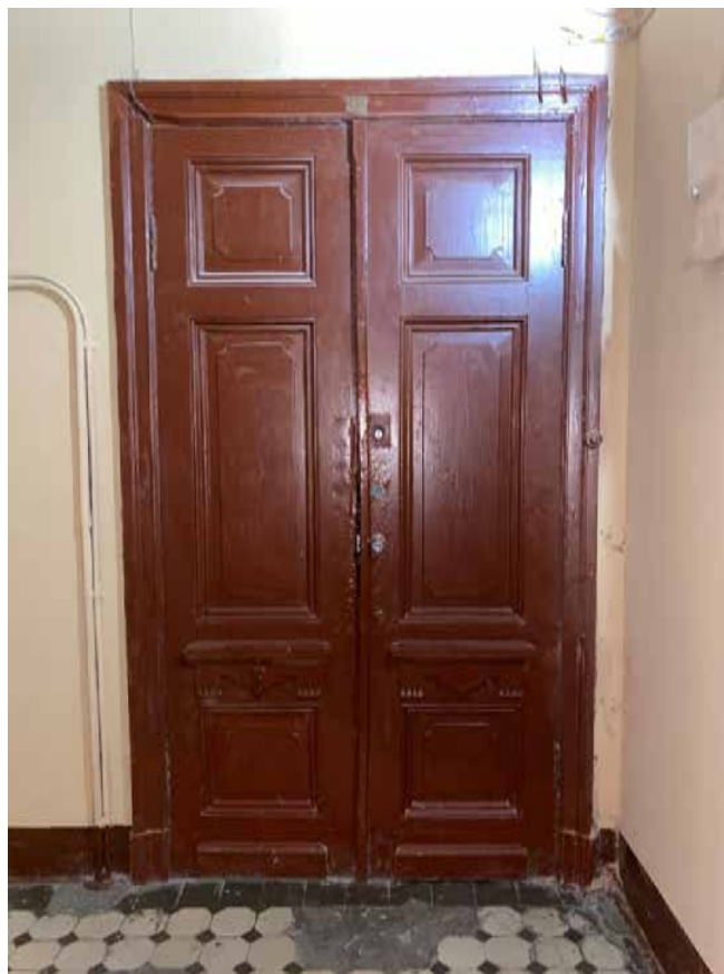
Фото 69. Историческое деревянное двустворчатое дверное заполнение.
