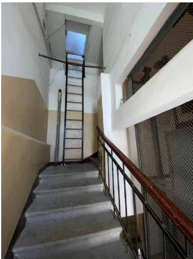
Фото 120. Лестничная клетка Л6 в уровне мансардного этажа.
