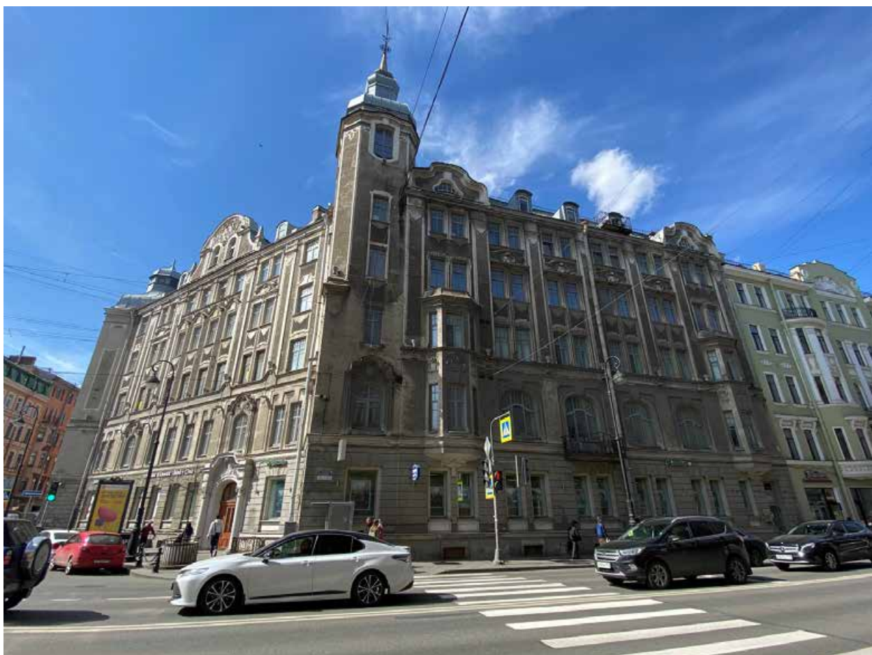
Фото 4. Угловой вид северо-восточного и восточного лицевых фасадов.
