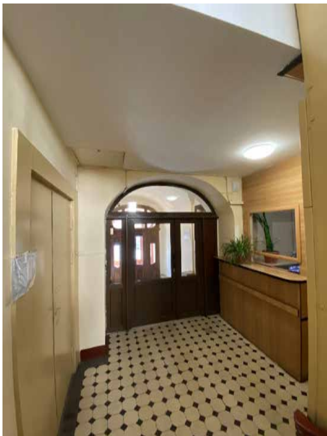
Фото 99. Парадная лестничная клетка Л5. Вестибюль.
