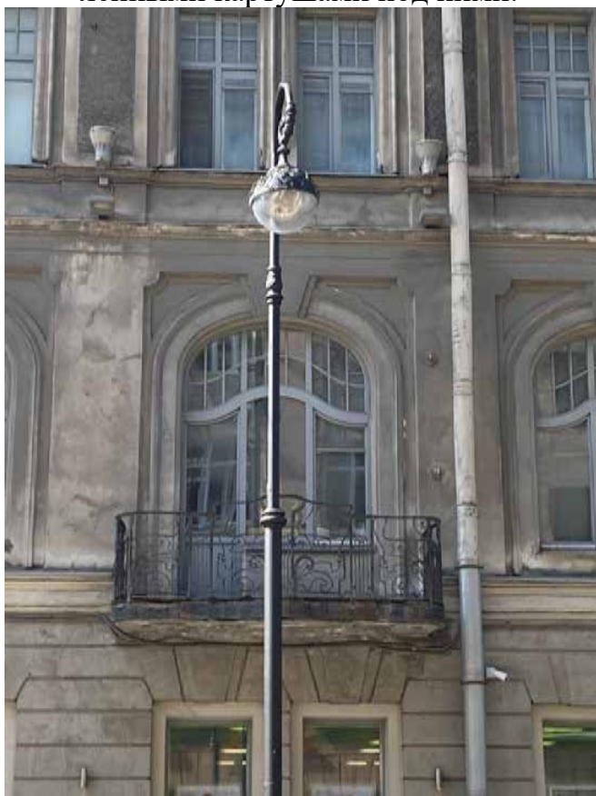
Фото 14. Балкон в уровне 2-го этажа центральной части фасада с историческим кованым ограждением.
