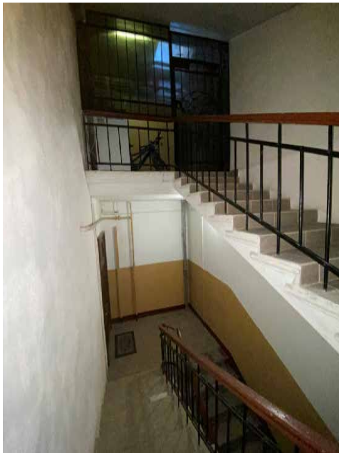
Фото 60. Лестничная клетка Л2 в уровне мансардного этажа.
