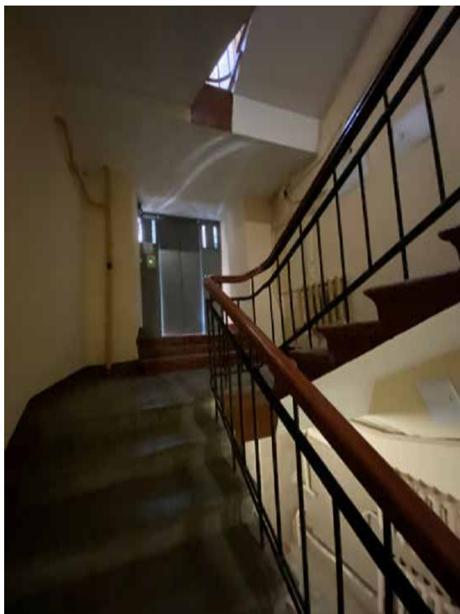
Фото 40. Лестничная клетка Л1 в уровне между 1-м и 2-м этажами.
