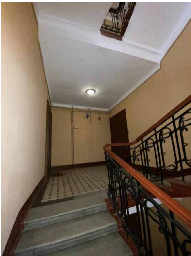
Фото 75. Лестничная клетка ЛЗ в уровне 4-го этажа.
