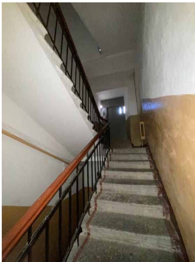
Фото 51. Лестничная клетка Л2 в уровне между 1-м и 2-м этажами.
