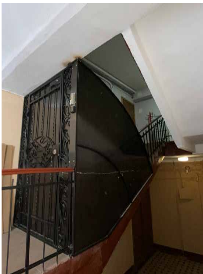
Фото 80. Лестничная клетка ЛЗ в уровне мансардного этажа.
