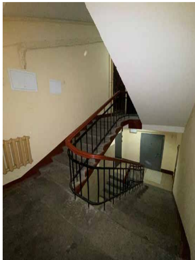
Фото 41. Лестничная клетка Л1 в уровне между 1-м и 2-м этажами.
