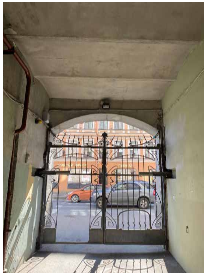
Фото 24. Прусские своды воротного проезда лицевого фасада по ул. Мира.
