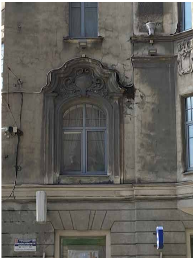
Фото 12. Оконные проемы объема башни на уровне 2-го этажа с полуциркульным завершением, декорированные сандриками сложной конфигурации, с лепными картушами под ними.
