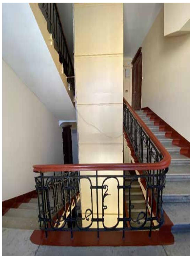
Фото 110. Лестничная клетка Л5 в уровне между 4-м и 5-м этажами.
