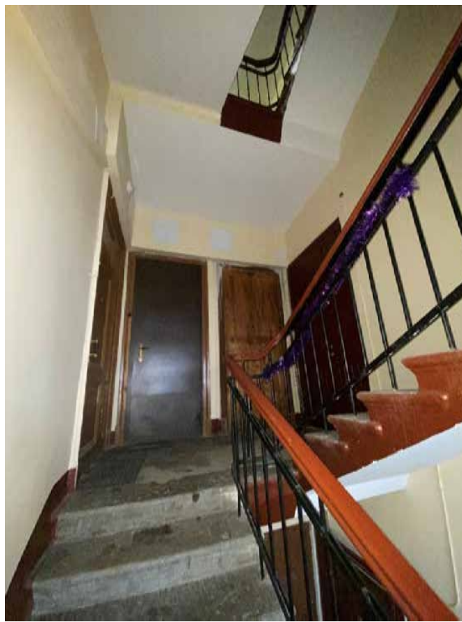
Фото 47. Лестничная клетка Л1 в уровне 5-го этажа.
