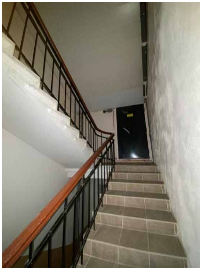
Фото 59. Лестничная клетка Л2 в уровне между 5-м и мансардным этажами.
