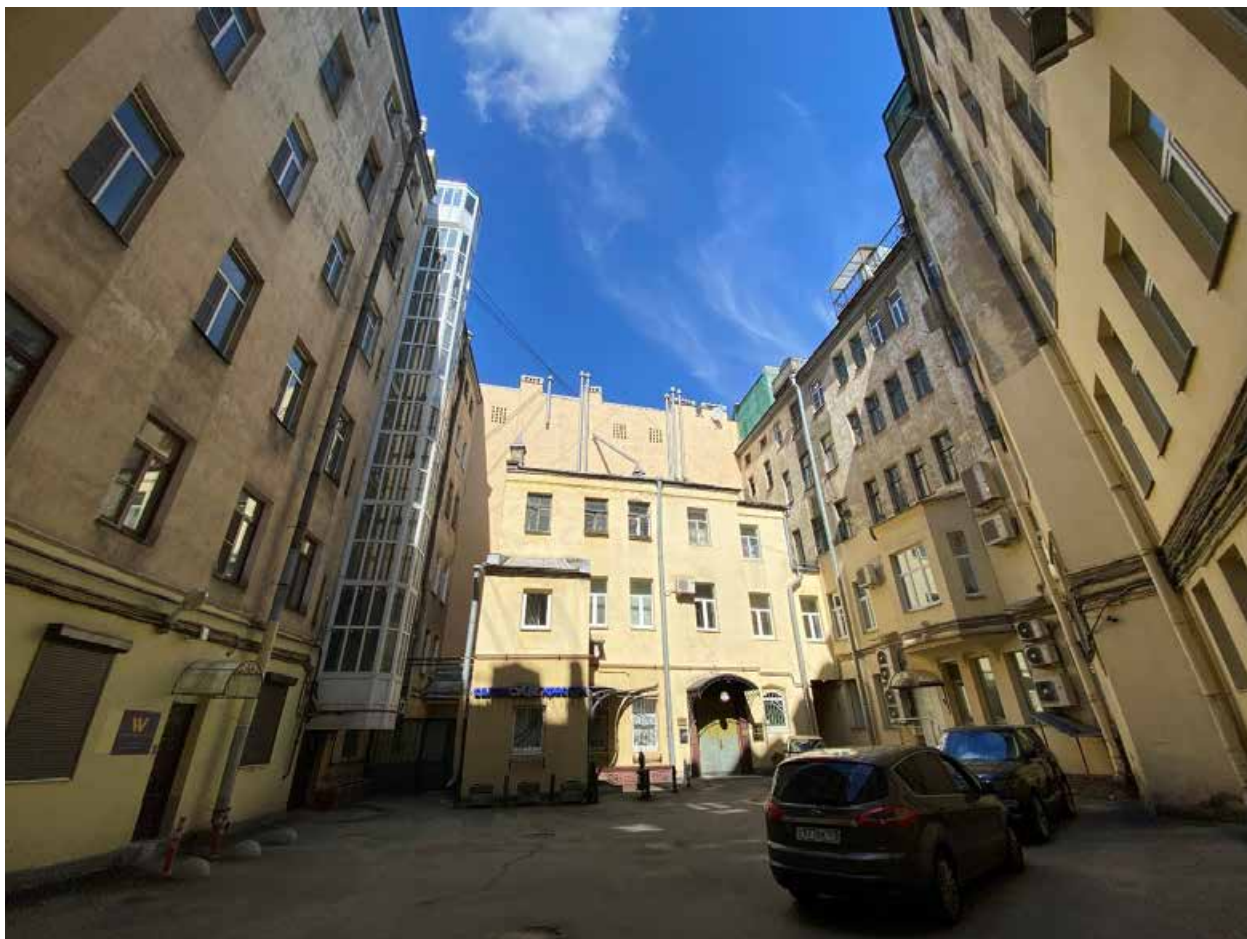
Фото 26. Юго-восточный дворовой фасад флигеля.
