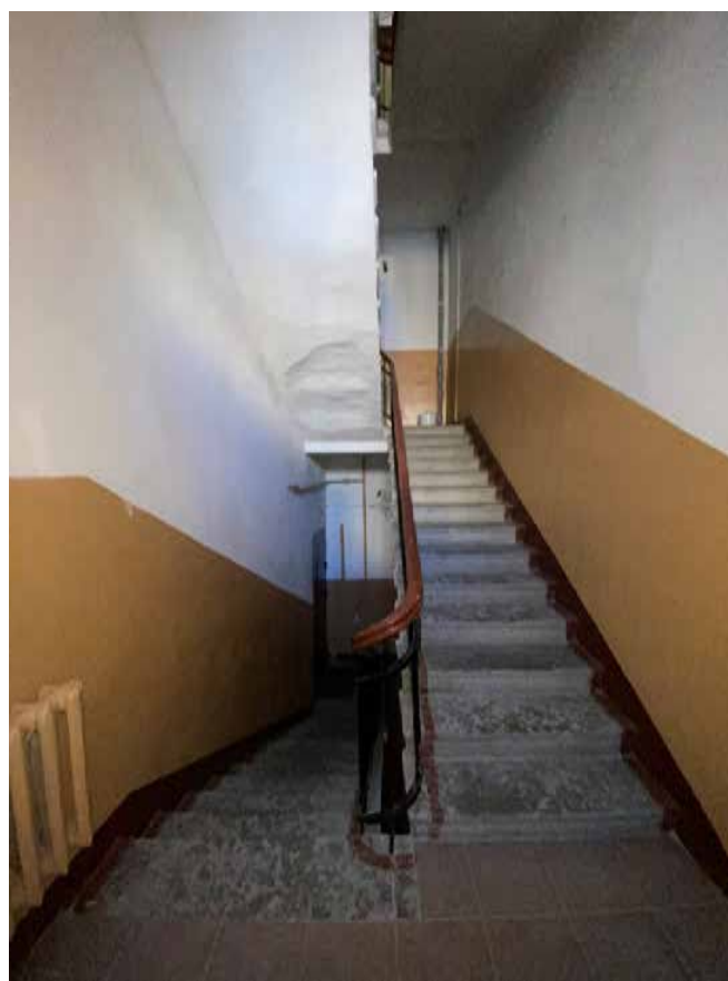
Фото 53. Лестничная клетка Л2 в уровне между 2-м и 3-м этажами.
