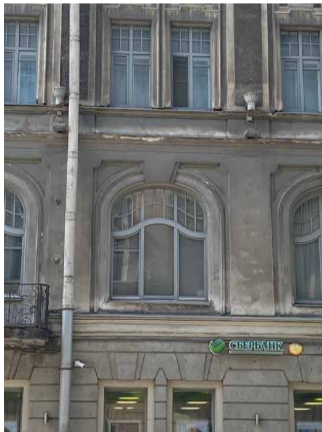
Фото 13. Оформление оконных проемов в уровне 2-го этажа фигурными наличниками и замковыми камнями.
