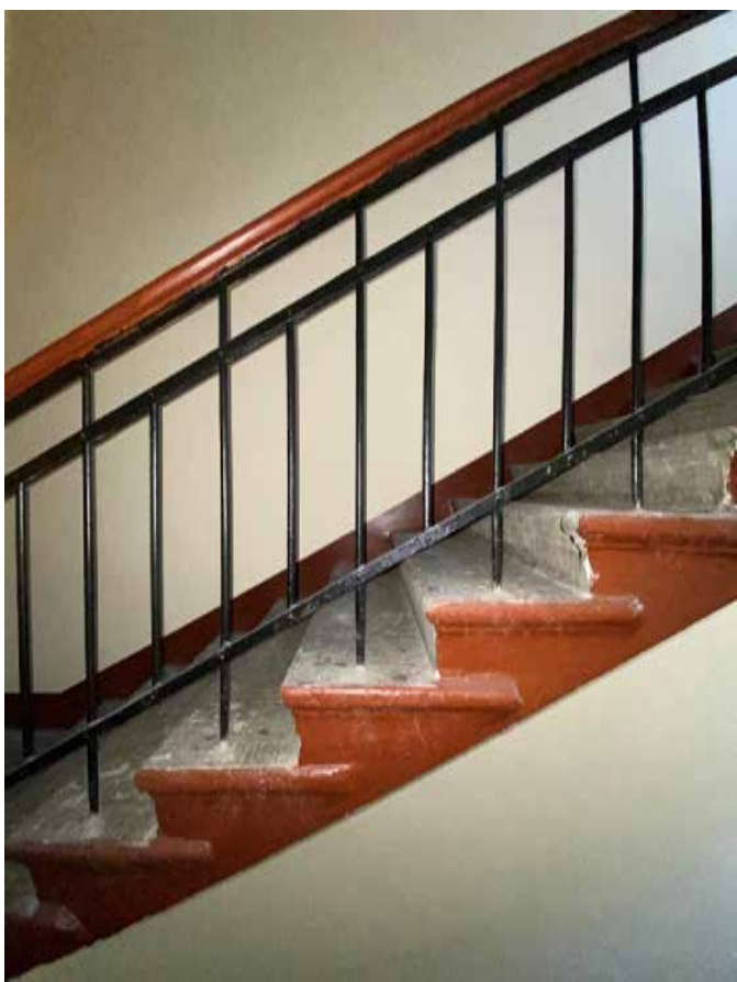
Фото 44. Ограждение маршей лестничной клетка Л1.
