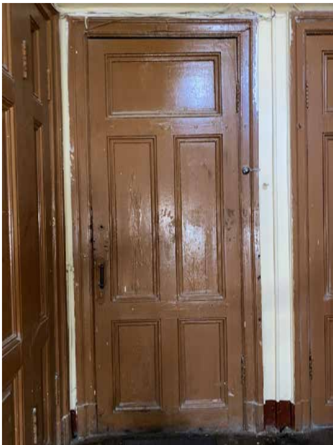
Фото 46. Историческое деревянное дверное заполнение, оформленное филенками.
