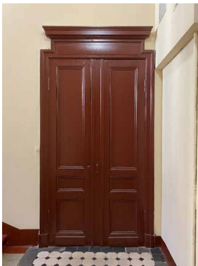
Фото 104. Историческое деревянное дверное заполнение.
