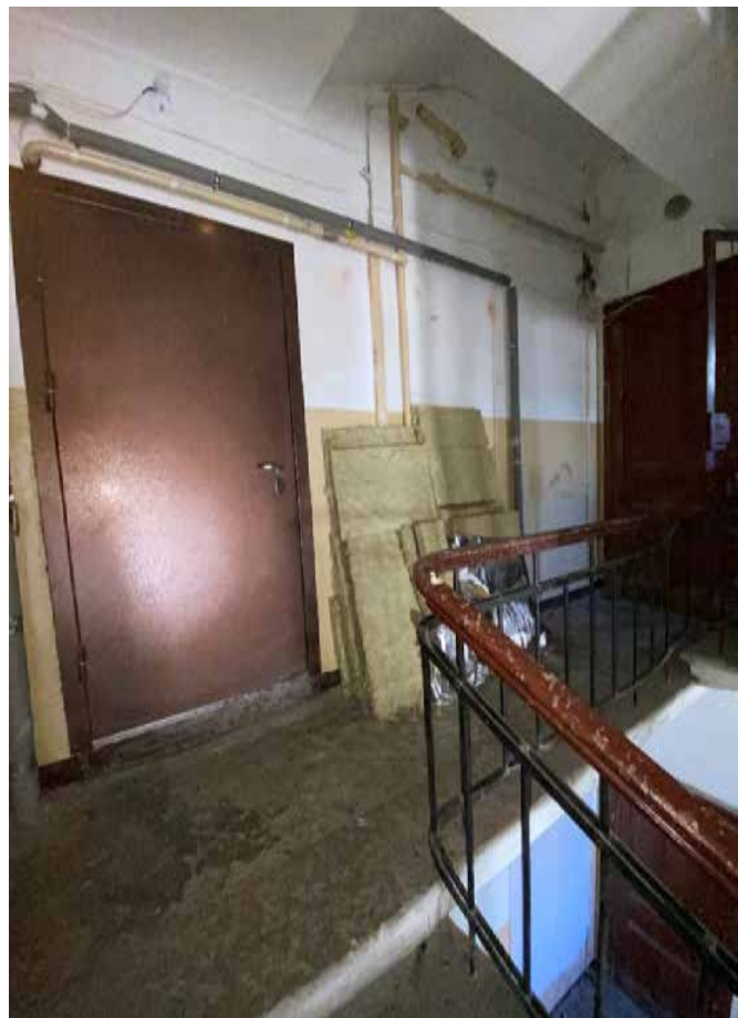
Фото 119. Лестничная клетка Л6 в уровне 5-го этажа.
