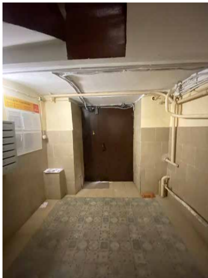
Фото 37. Современное входное дверное заполнение лестничной клетки Л1.
