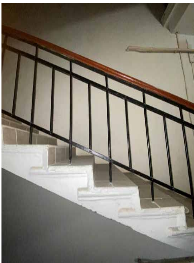
Фото 57. Ограждение маршей лестничной клетки Л2.
