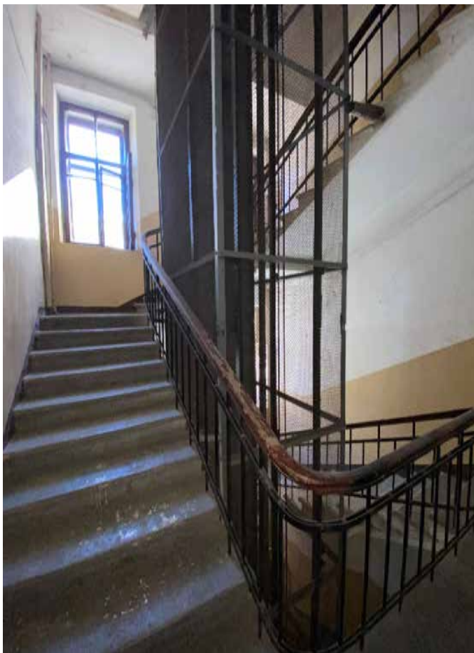
Фото 118. Лестничная клетка Л6 в уровне между 3-м и 4-м этажами.
