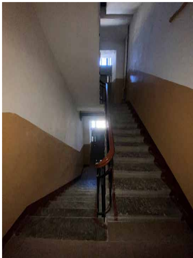
Фото 55. Лестничная клетка Л2 в уровне 3-го этажа.
