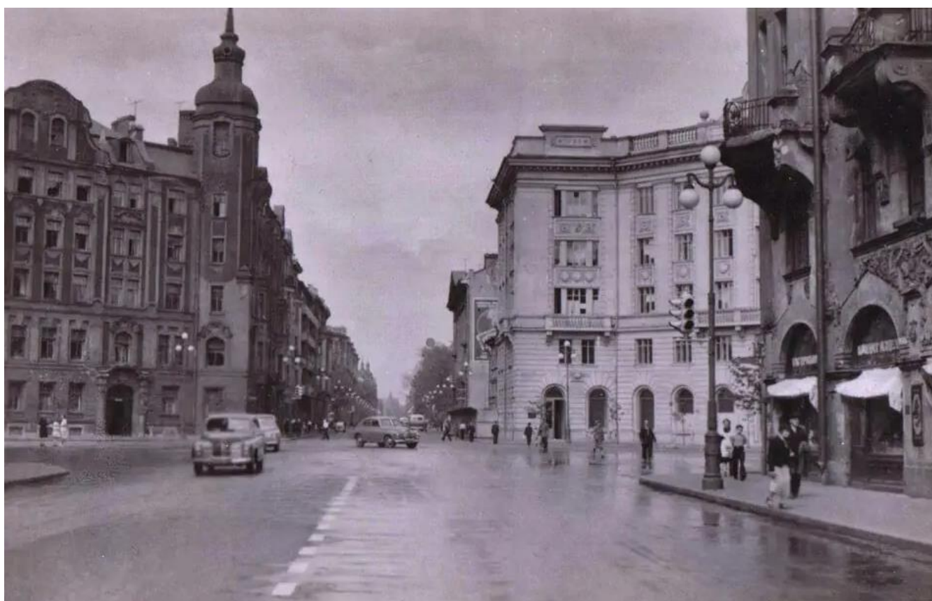
Илл. 43. Доходный дом М.М. Горбова. Кировский пр., Санкт-Петербург, Петроградский район, Петроградский остров, 1963 г. // Электронный ресурс: http://livejournal.com/
