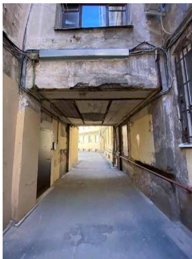
Фото 32. Плоское перекрытие воротного проезда дворового флигеля.
