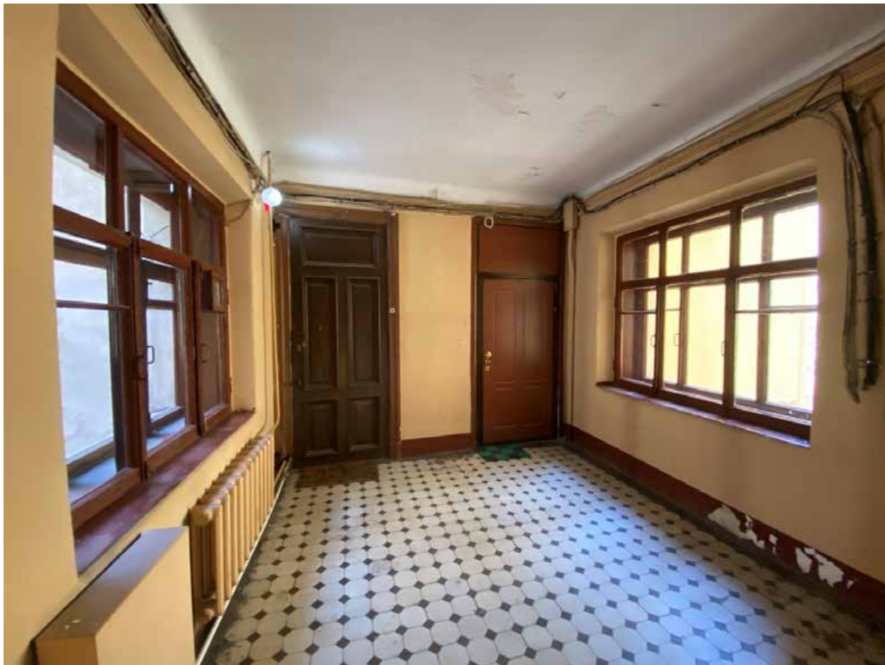
Фото 66. Лестничная клетка ЛЗ в уровне 2-го этажа.
