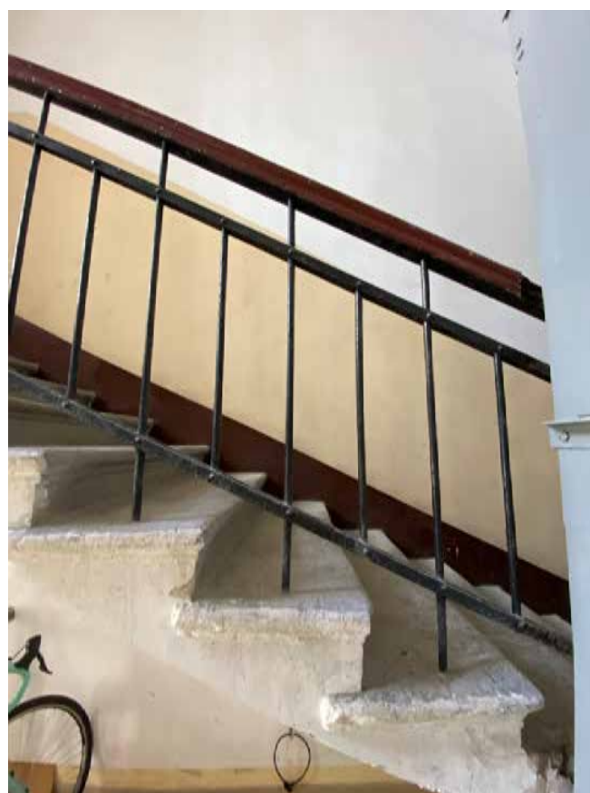
Фото 84. Ограждение маршей лестничной клетки Л4.
