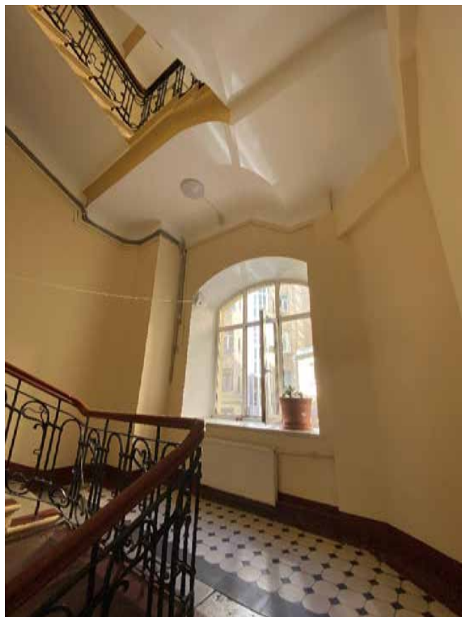
Фото 100. Лестничная клетка Л5 в уровне между 1-м и 2-м этажами.
