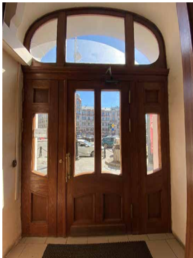
Фото 97. Парадная лестничная клетка Л5. Входное деревянное заполнение.
