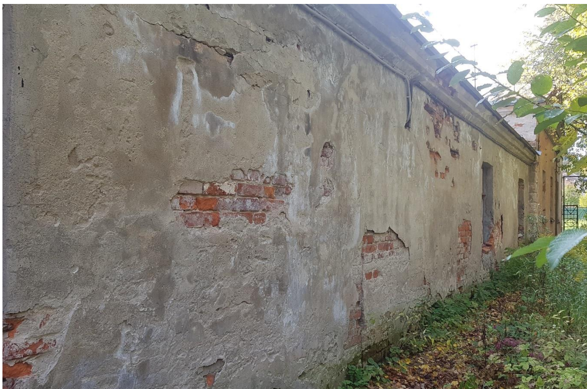
Фото 11. Фасад в осях 12-1. Правое крыло.
