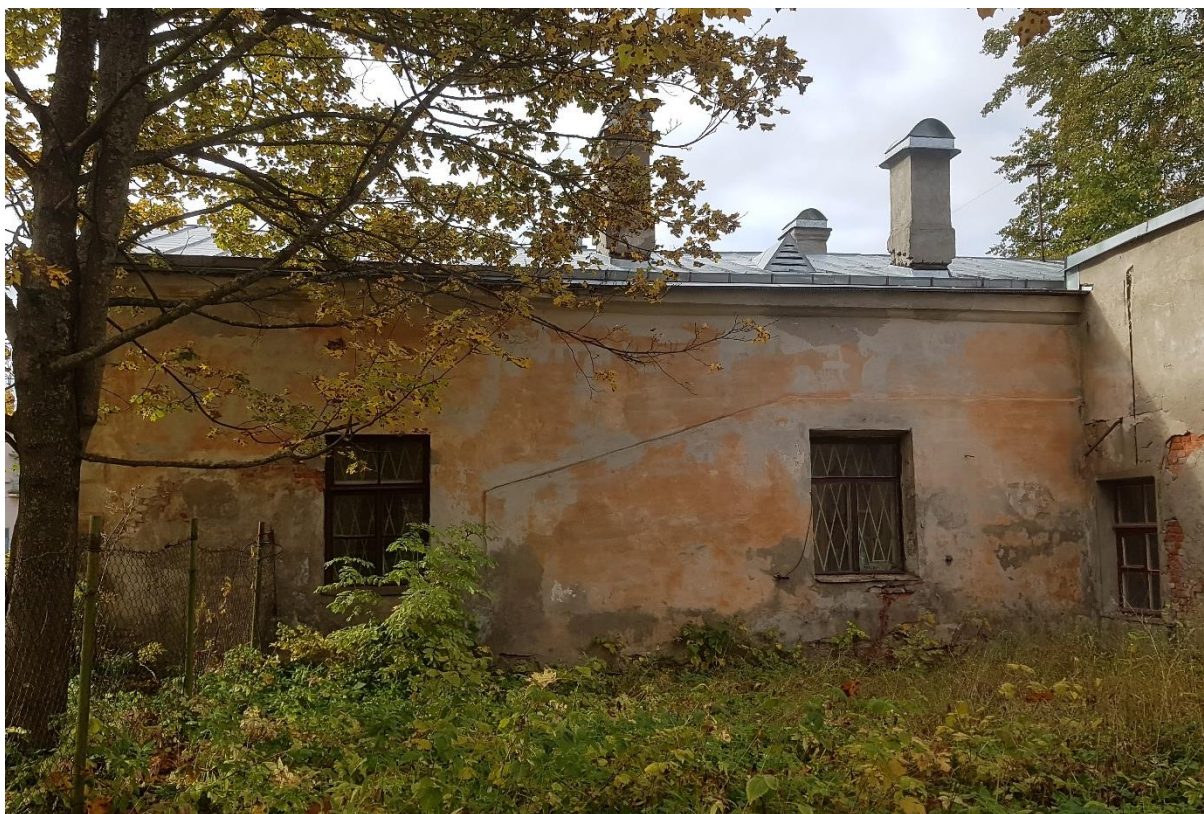
Фото 21. Фасад в осях А-Г.
