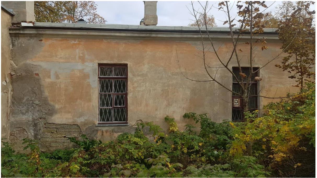
Фото 15. Фасад в осях Г-А.
