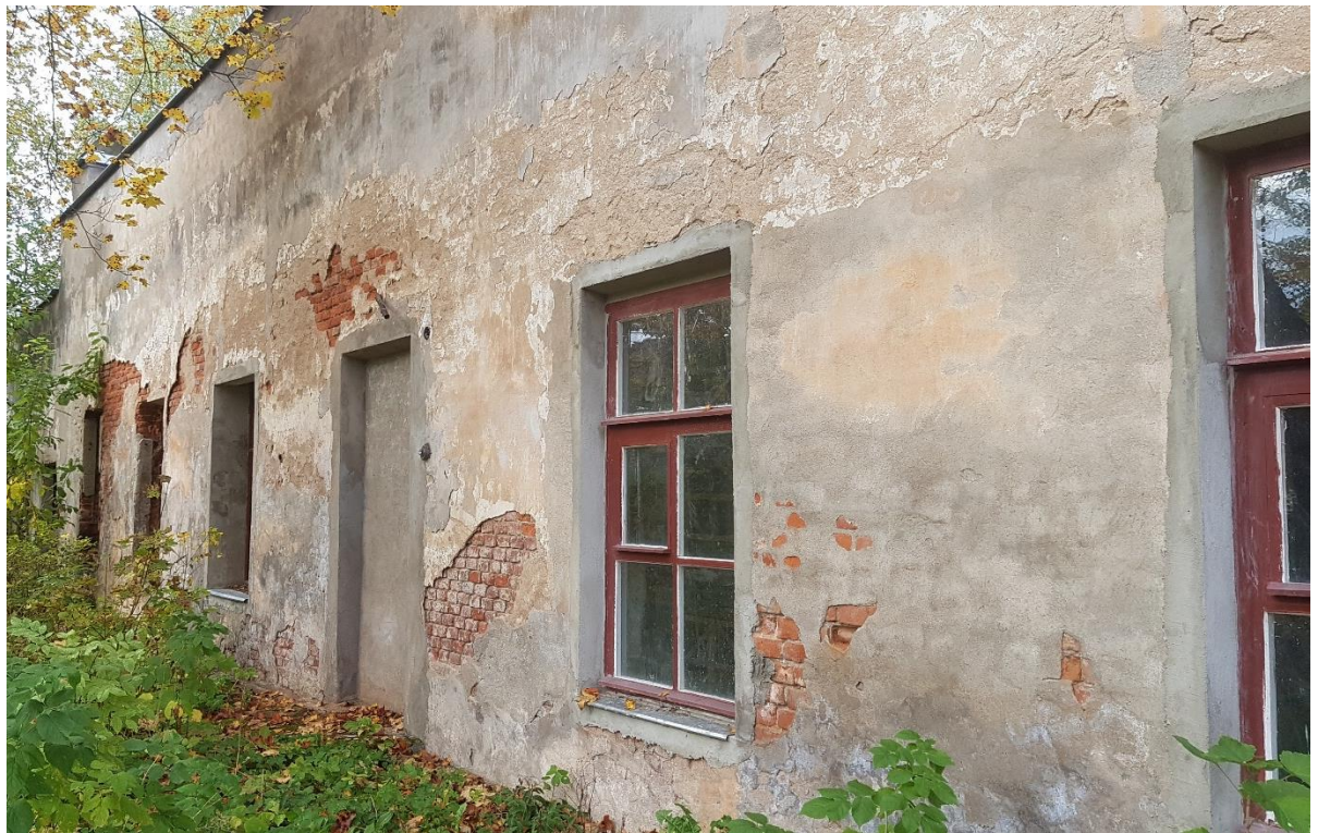
Фото 18. Фасад в осях 1-12.
