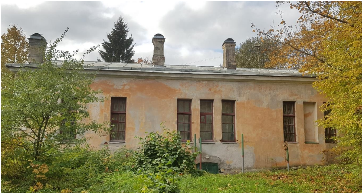
Фото 3. Фасад в осях А-Д.
