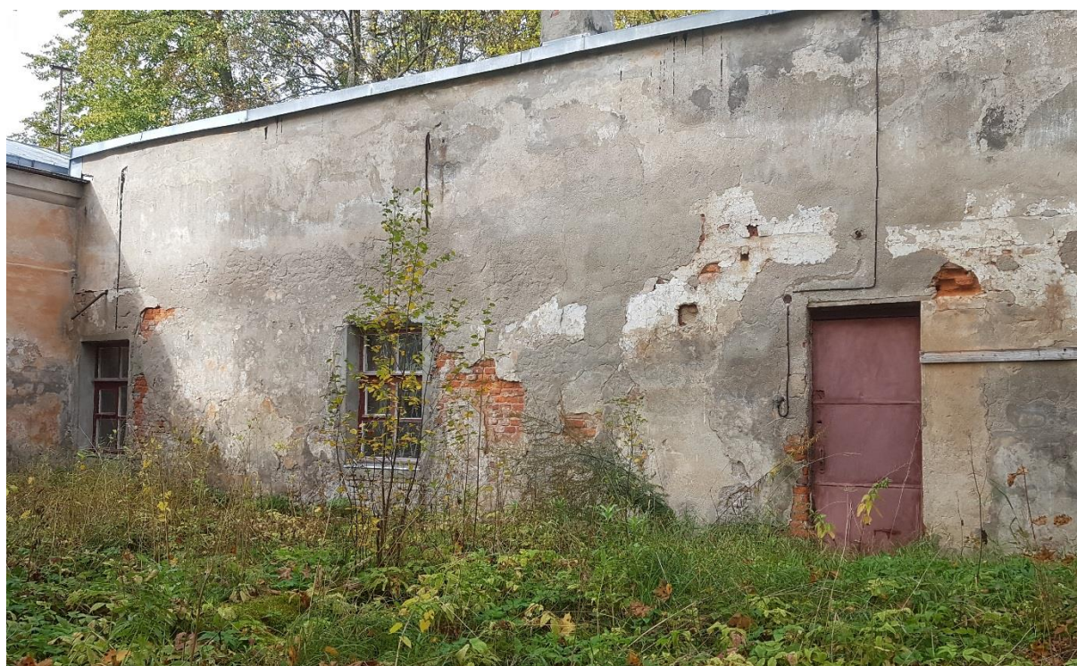
Фото 20. Фасад в осях 1-12.
