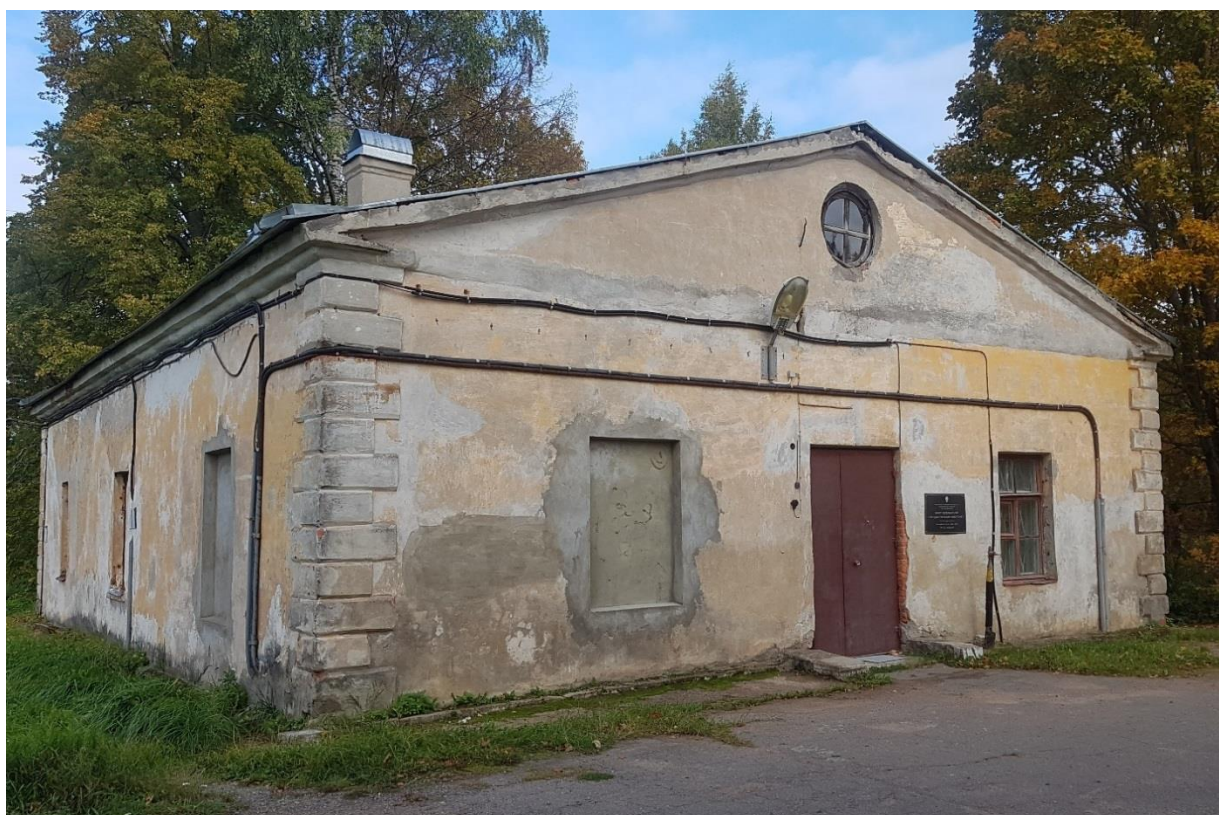
Фото 22. Фасад в осях 1-2.
