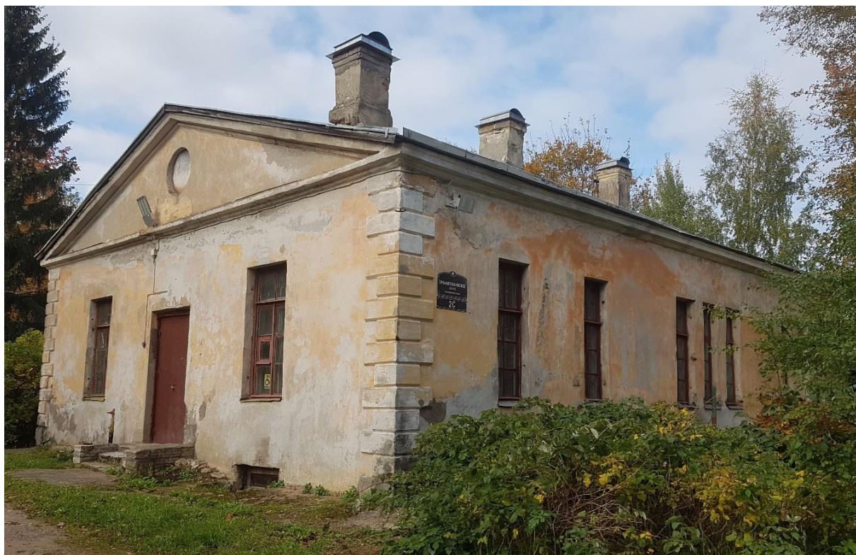
Фото 2. Фасад в осях 11-12, фасад в осях А-Д.
