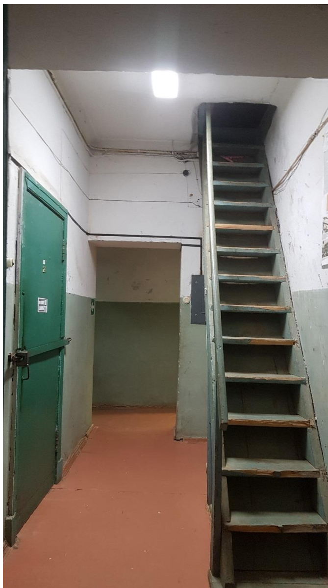
Фото 33. Коридор (пом. 1). Вид на деревянную лестницу.
