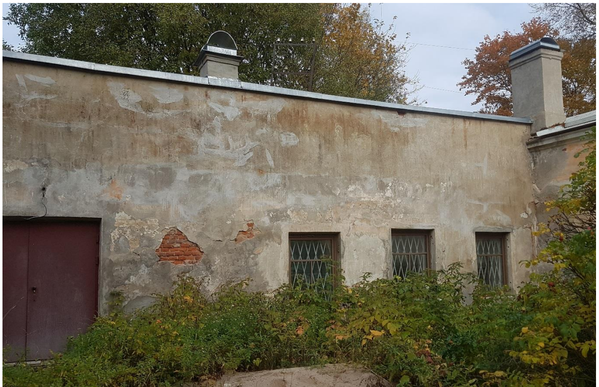
Фото 16. Фасад в осях 1-12.
