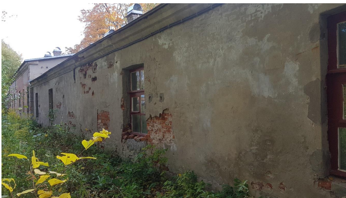
Фото 10. Фасад в осях 12-1. Правое крыло.
