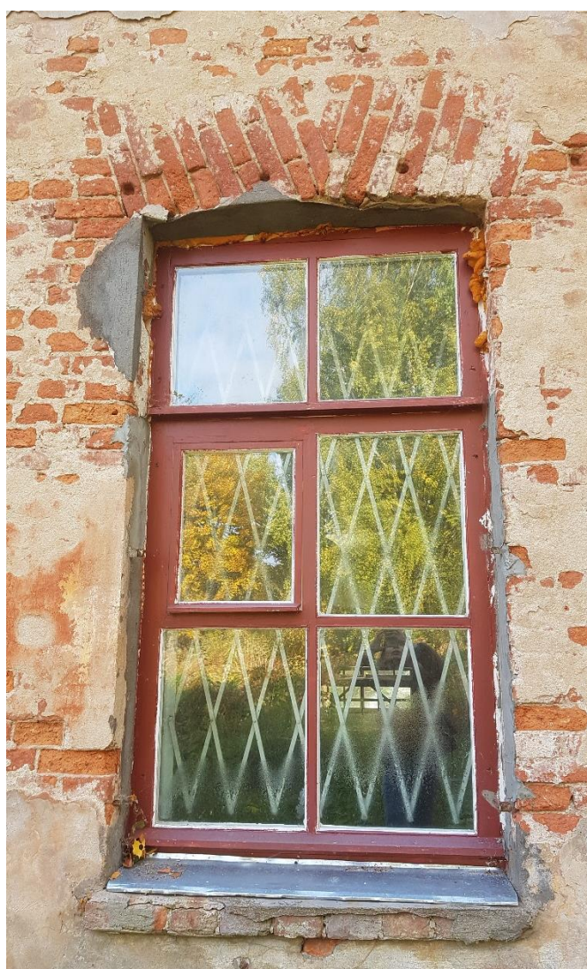
Фото 8. Оконный проем. Фасад в осях 12-1.
