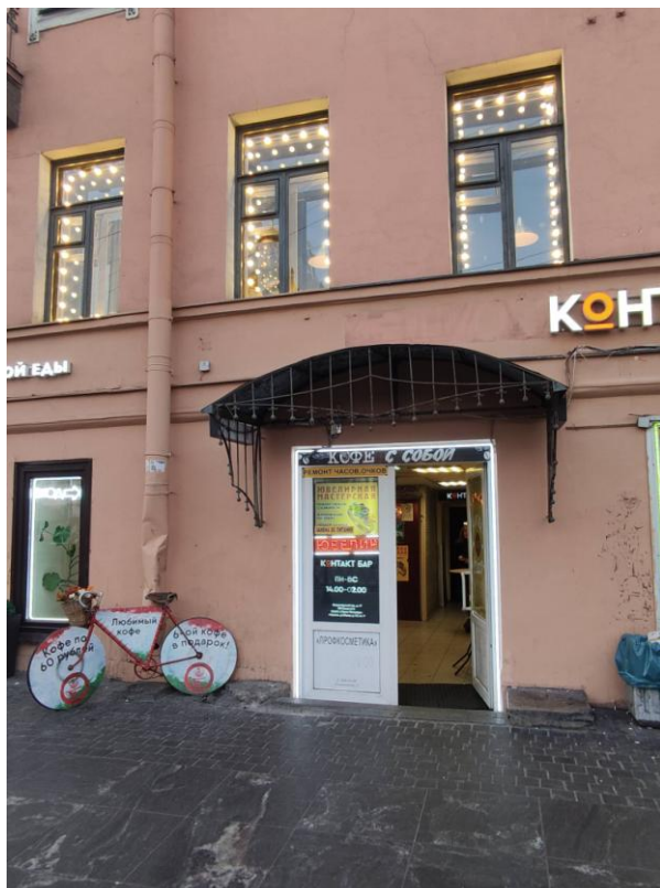
Фото 5. Фрагмент лицевого фасада объекта культурного наследия регионального значения «Дом Общества Санкт-Петербургского частного ломбарда», входное дверное заполнение пом. 1-Н
