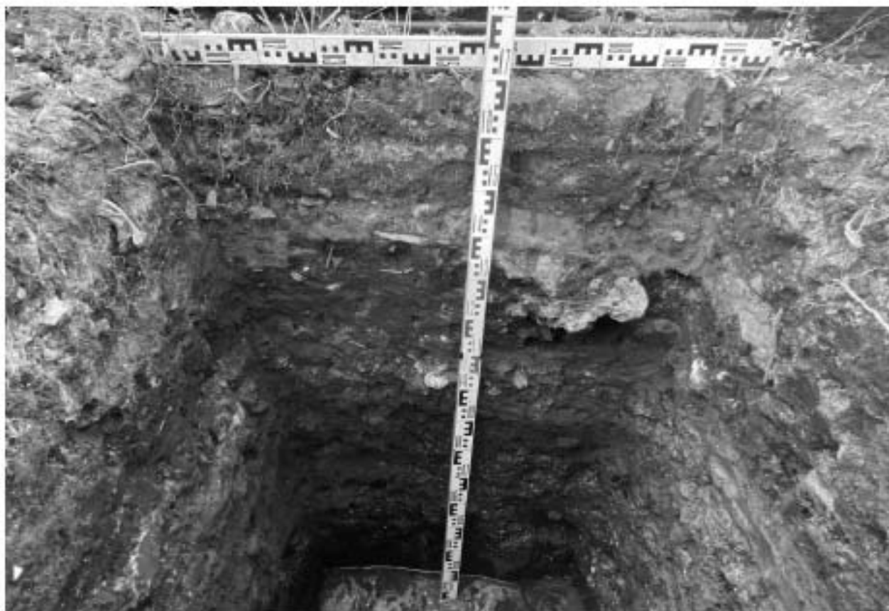
Илл. 29. г. Санкт-Петербург, муниципальное образование Большая Охта, Салтыковская дорога, участок 17 (кад. № 78:11:0604302:1139). Шурф. Северная стенка. Вид с юга.
