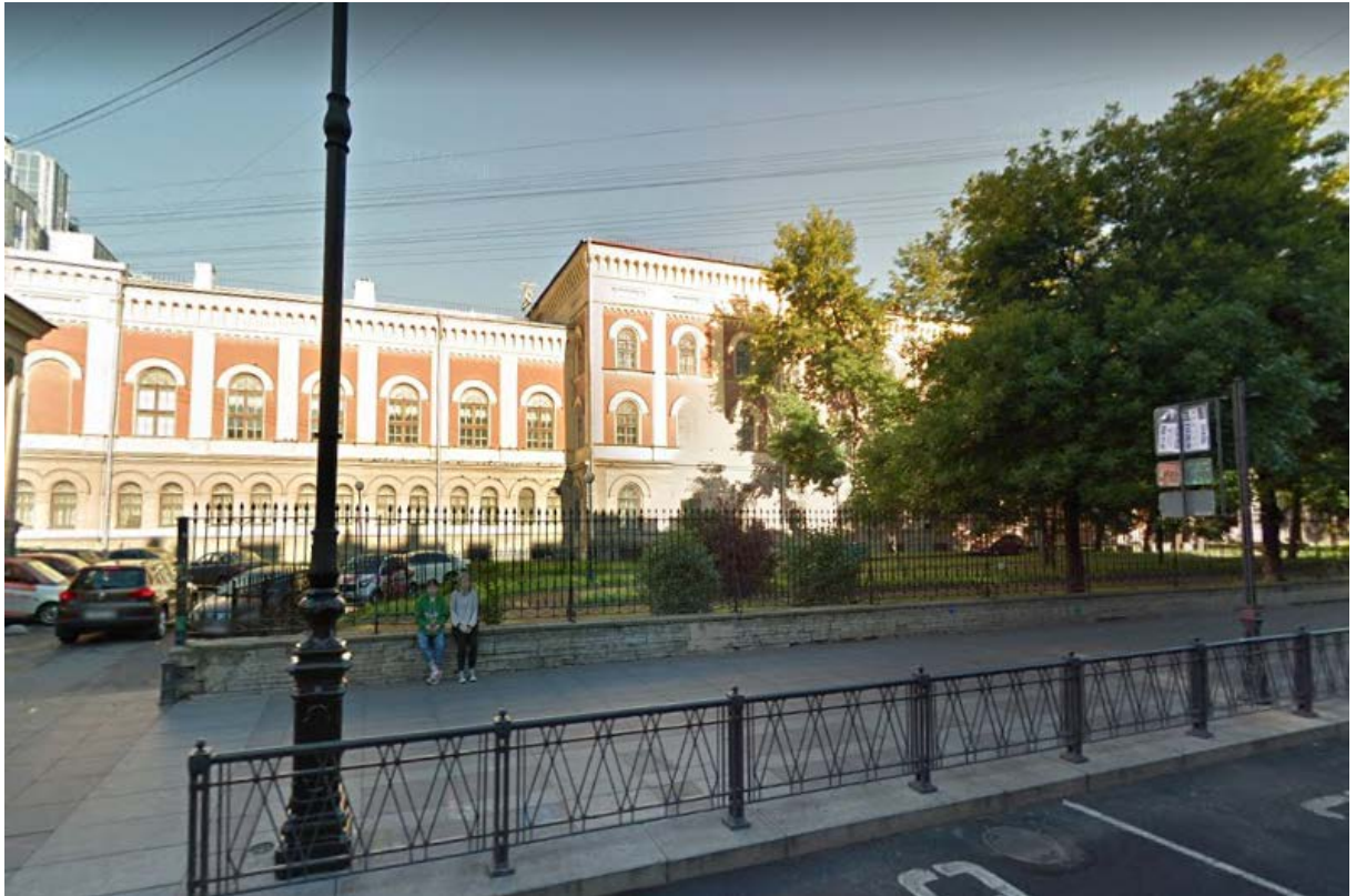
Илл. 1. Общий вид здания. Лицевой фасад с ул. Восстания. Фото 20.08.2018 г.
