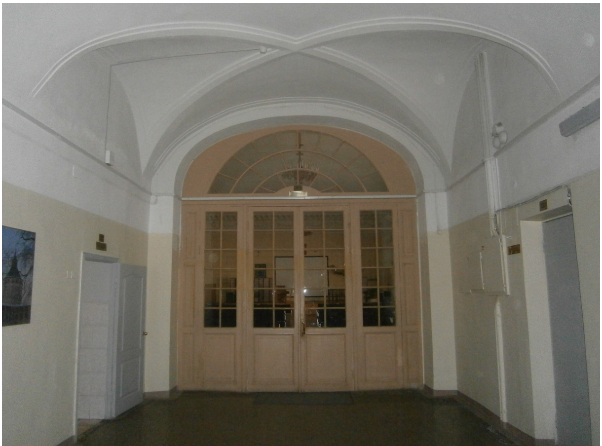
Илл. 8. Заполнения дверного проема (вход в актовый зал снаружи). Фото 20.08.2018 г.
