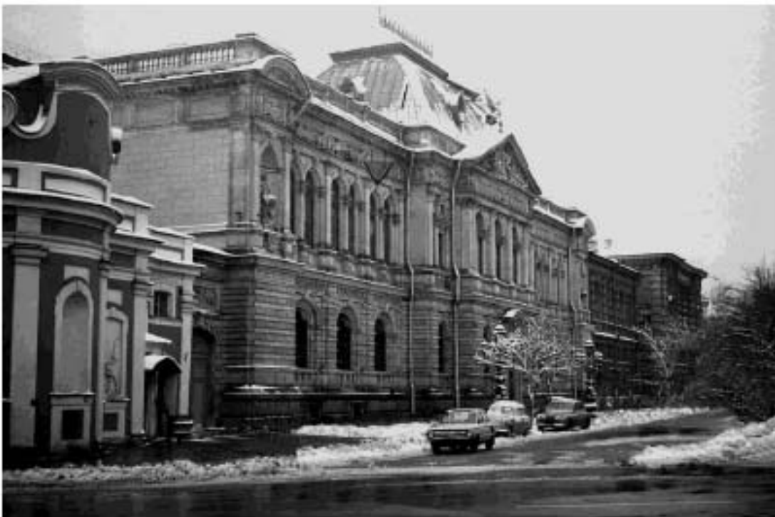
Илл. 43. Общий вид здания бывш. Музея ЦУТР. Вид с юго-восточной стороны. 1973 г.
