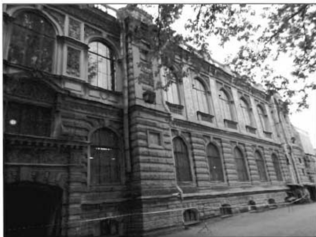
7. Северный дворовый фасад. Общий вид.
