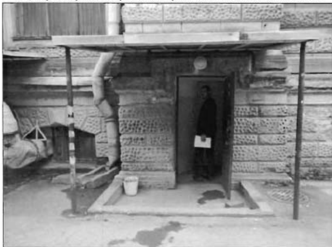
9. Северный дворовый фасад. Фрагмент.
