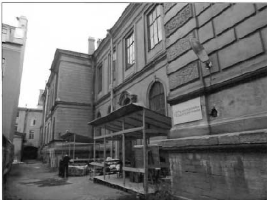
6. Южный дворовый фасад. Общий вид.
