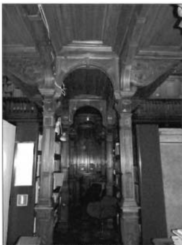
39. Помещение № 1-Н (271). Деревянные колонны.
