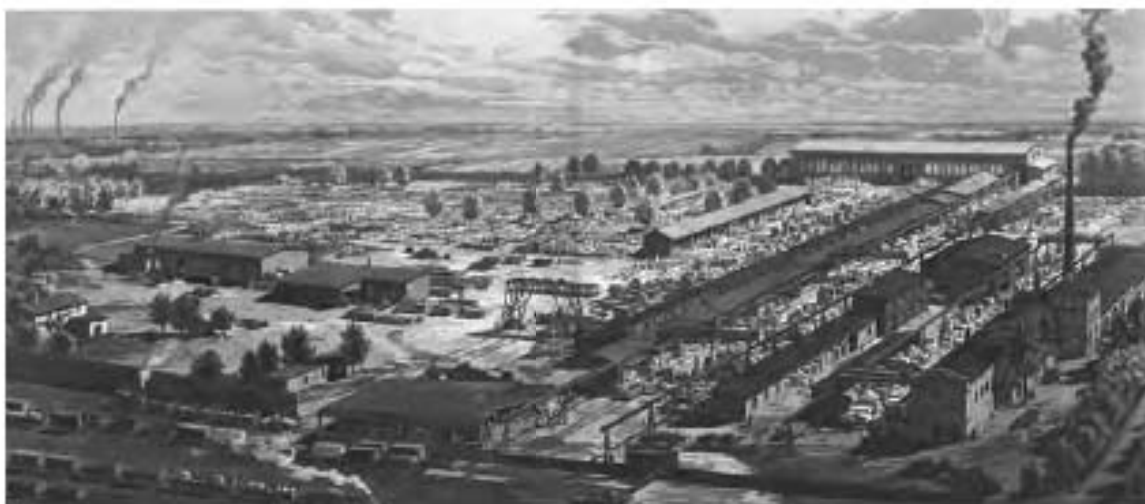
Илл. 20. Общий вид производственной площадки камнеобрабатывающей фабрики «Цейдлер & Виммель» («Zeidler & Wimmel») в Бюндлау в Силезии (Германия, в наст. вр. – Болеславец, Польша)
