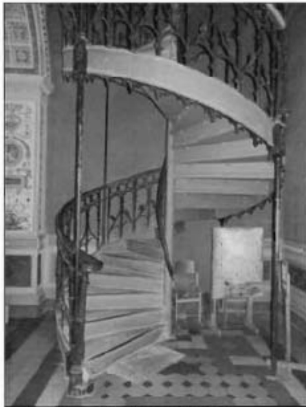
18. Помещение № 1-Н (285). Лестница.
