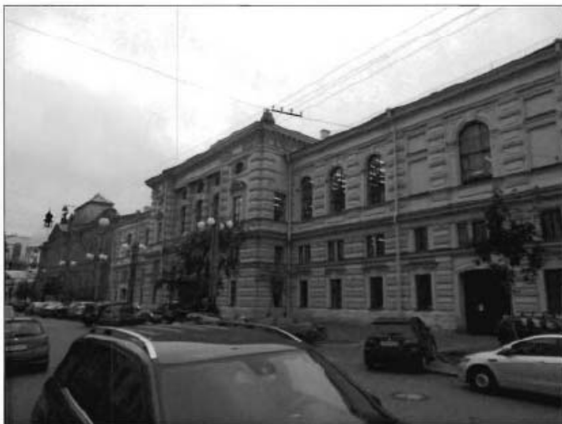
28. Лицевой фасад. Общий вид.
