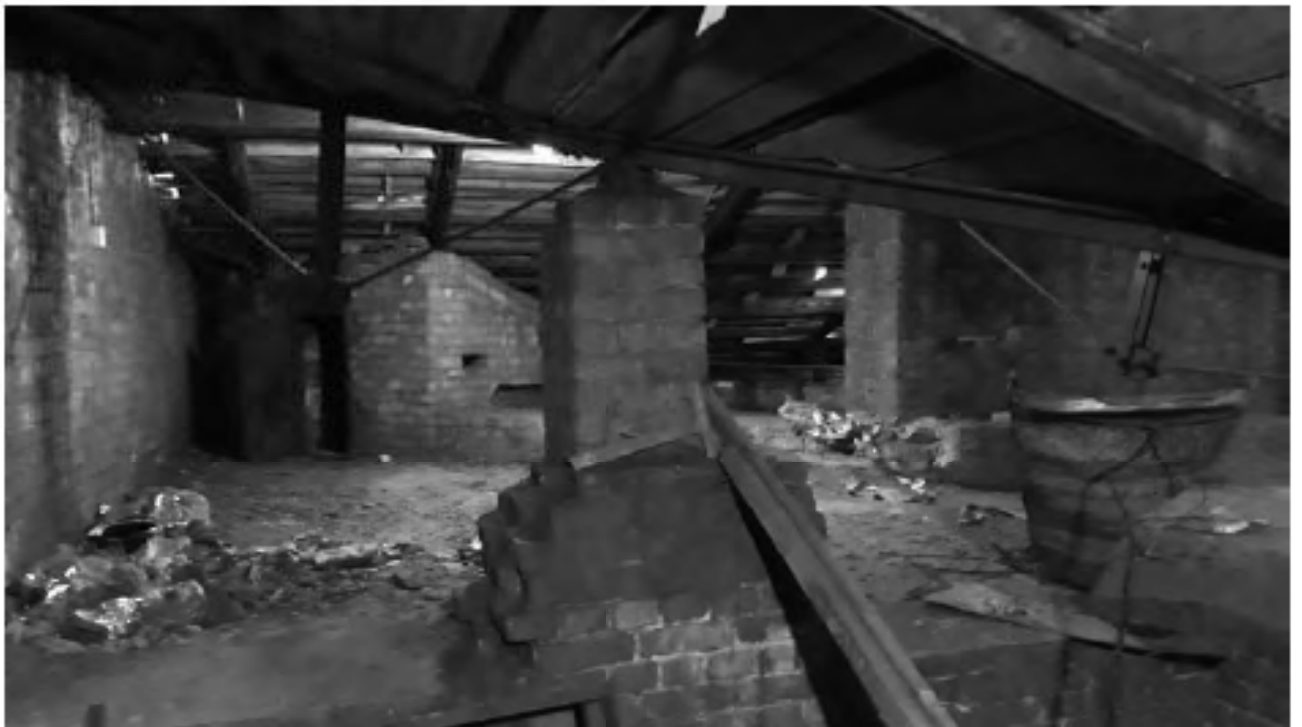
Фото 5. Объект культурного наследия федерального значения "Центральное училище технического рисования и музей Штиглица А.Л" по адресу: Санкт-Петербург, Соляной пер., д. 13-15, лит. А. Кровля и медный купол здания Музея
