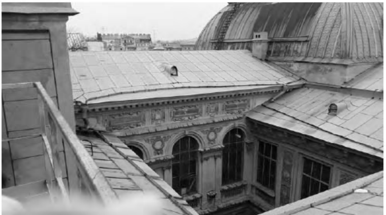
Фото 14. Объект культурного наследия федерального значения "Центральное училище технического рисования и музей Штиглица А.Л" по адресу: Санкт-Петербург, Соляной пер., д. 13-15, лит. А. Кровля и медный купол здания Музея
