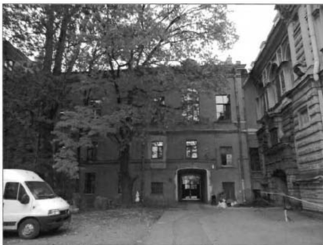
31. Восточный дворовый фасад. Общий вид.
