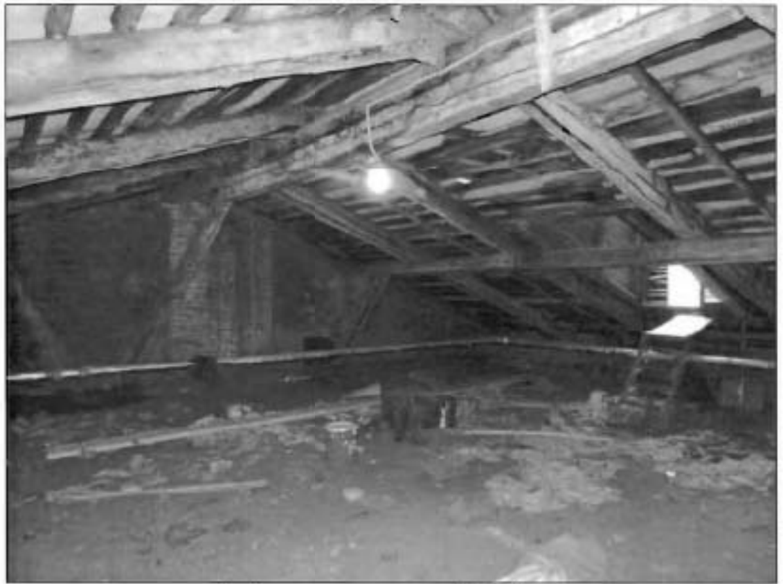
35. Стропильная система. Общий вид.
