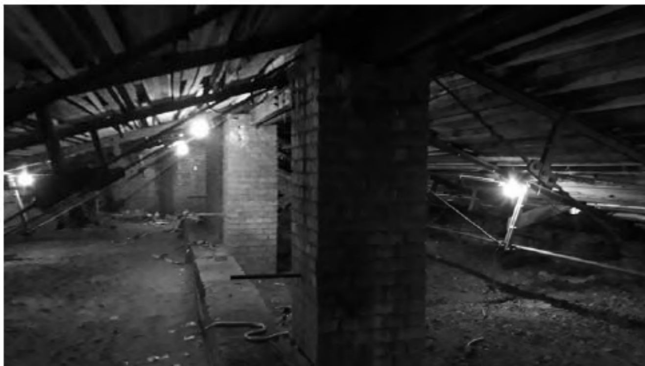
Фото 4. Объект культурного наследия федерального значения "Центральное училище технического рисования и музей Штиглица А.Л" по адресу: Санкт-Петербург, Соляной пер., д. 13-15, лит. А. Кровля и медный купол здания Музея
