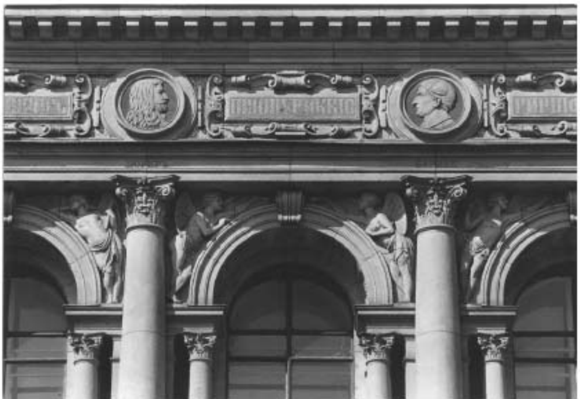
Илл. 49. Здание бывш. Музея ЦУТР. Скульптурное оформление оконных проемов 2-го этажа и фриза. Фронтальный вид с востока. 1979 г. Архив КГИОП
