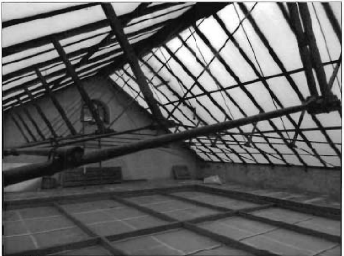
36. Металлические фермы над световым фонарем парадной лестницы.
