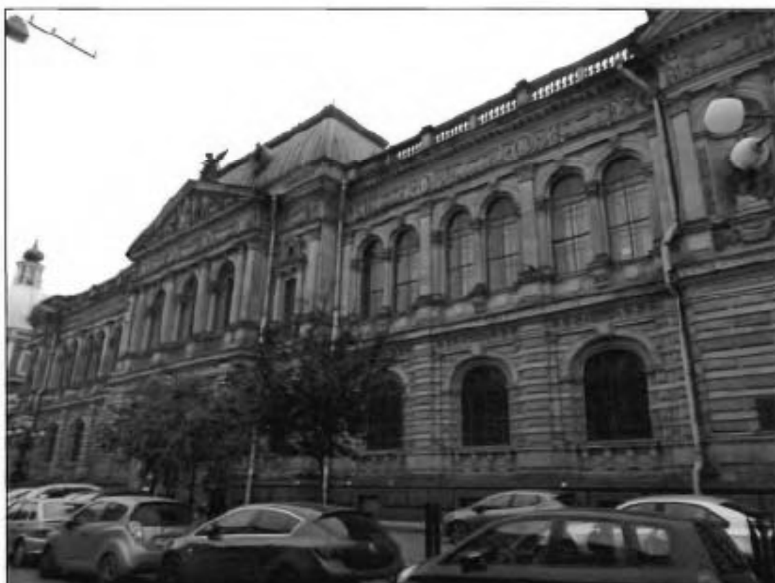
1. Общий вид с северо-востока.
