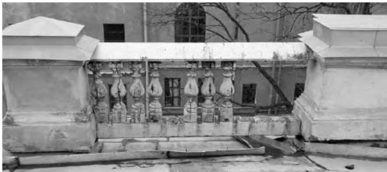
Фото 10. Объект культурного наследия федерального значения "Центральное училище технического рисования и музей Штиглица А.Л" по адресу: Санкт-Петербург, Соляной пер., д. 13-15, лит. А. Кровля и медный купол здания Музея
