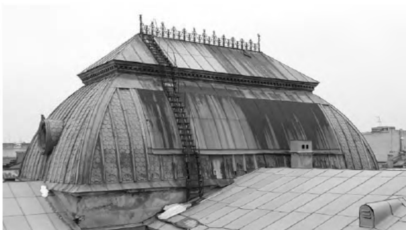
Фото 15. Объект культурного наследия федерального значения "Центральное училище технического рисования и музей Штиглица А.Л" по адресу: Санкт-Петербург, Соляной пер., д. 13-15, лит. А. Кровля и медный купол здания Музея
