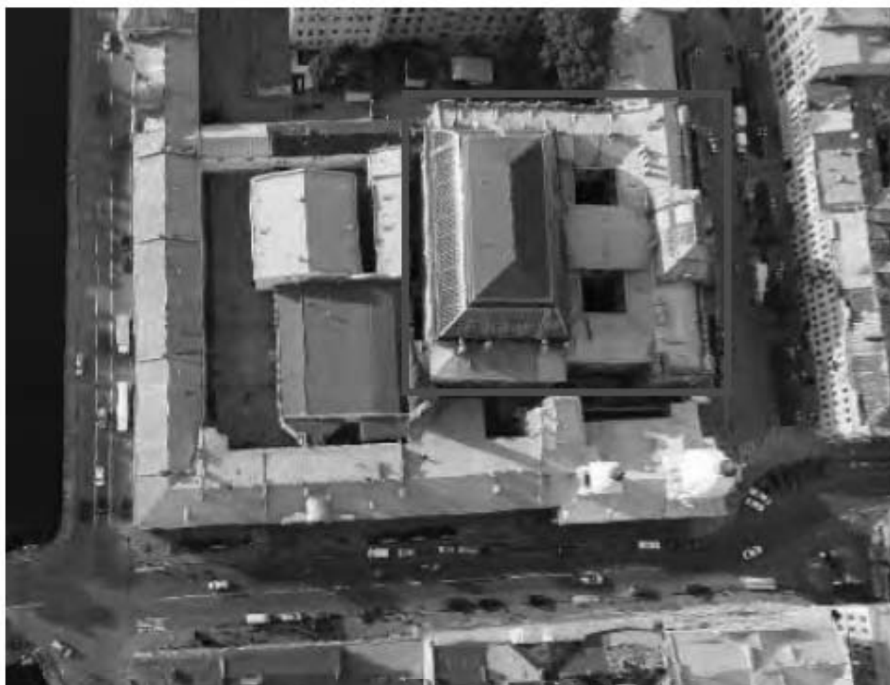
Фото 1. Объект культурного наследия федерального значения "Центральное училище технического рисования и музей Штиглица А.Л" по адресу: Санкт-Петербург, Соляной пер., д. 13-15, лит. А. Кровля и медный купол здания Музея
