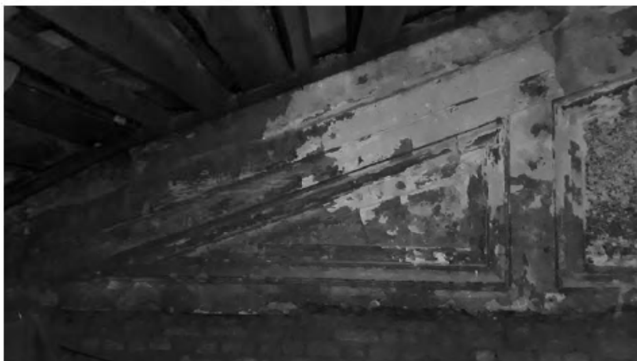
Фото 6. Объект культурного наследия федерального значения "Центральное училище технического рисования и музей Штиглица А.Л" по адресу: Санкт-Петербург, Соляной пер., д. 13-15, лит. А. Кровля и медный купол здания Музея
