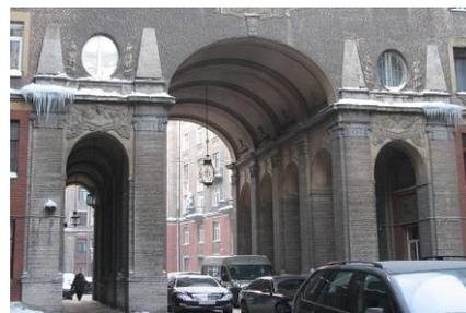
фонарь – количество (два), местоположение (центральная часть воротных проездов), конструкция (подвесной, в форме сложного многогранника), способ крепления (на центральной цепи и растяжках), вид материала (черный металл), техника исполнения (ковка);
