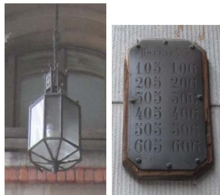
фонари – количество (двадцать два), местоположение (фланкируют дверные проемы), конструкция (подвесной, в форме восьмигранника с шишечкой на конце, на стержне цепи, с тремя цепями крепящиеся к стене львиными маскаронами), способ крепления (на цепи), вид материала (черный металл), техника исполнения (ковка);
