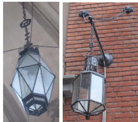
фонари – количество (восемь), местоположение (боковые части воротного проезда), конструкция (подвесной, в форме восьмигранника с шишечкой на конце), способ крепления (на цепи), вид материала (черный металл), техника исполнения (ковка);
