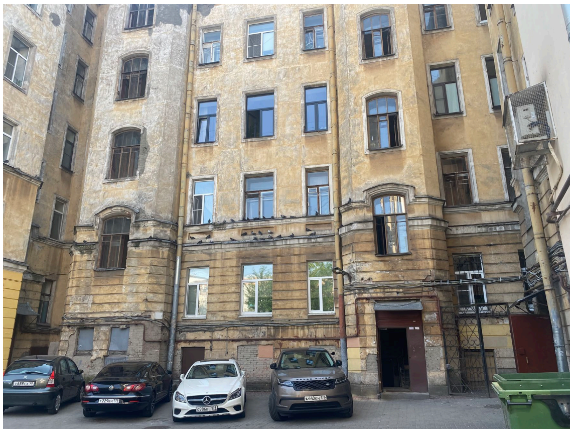
5. Вид с восточной стороны на дворовой фасад.
