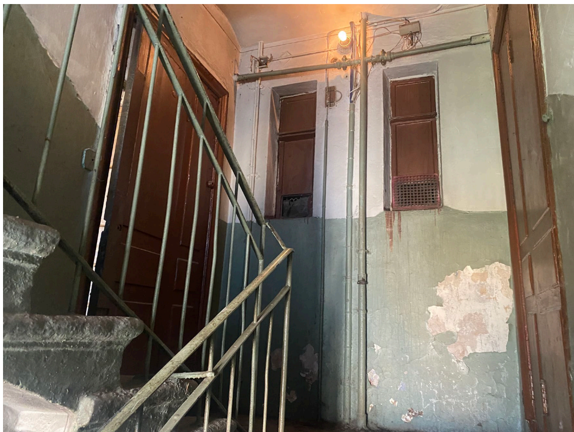
28. Лестничная клетка со стороны черной лестницы.
