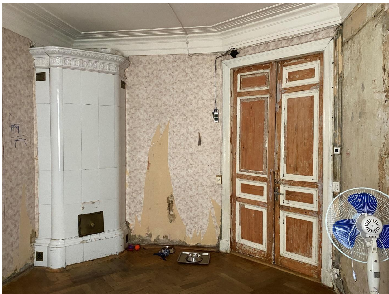
Фото 19. Помещение № 3. Комната. Вид с запада.
