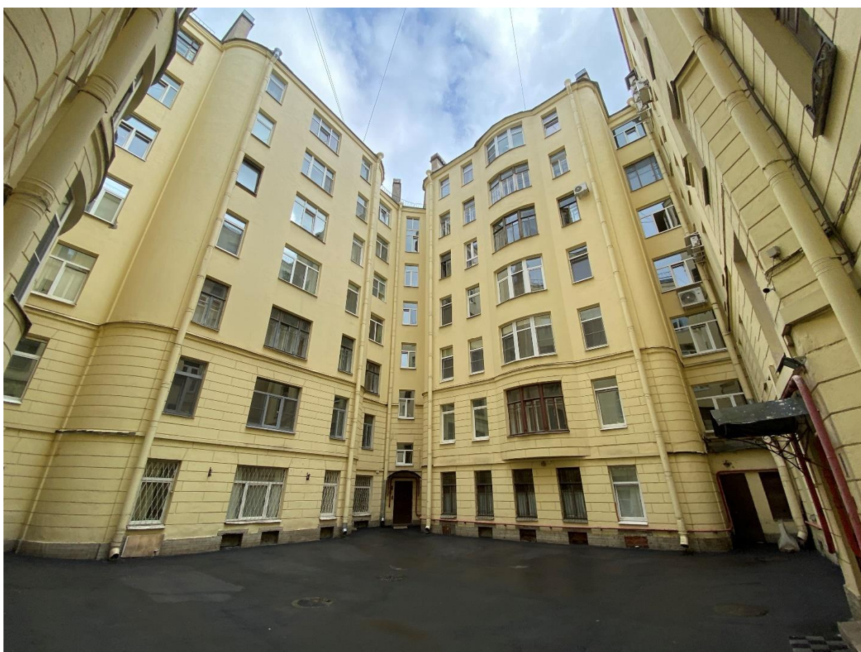
Фото 10. Северо-западный и юго-западный дворовые фасады южного двора.
