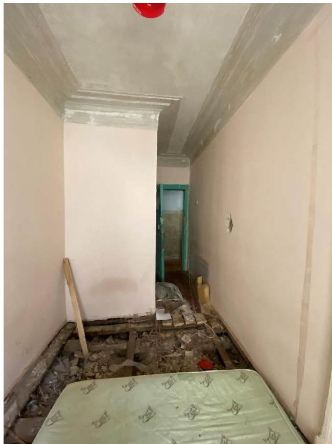
Фото 25. Помещение № 5. Комната. Вид с северо-запада.
