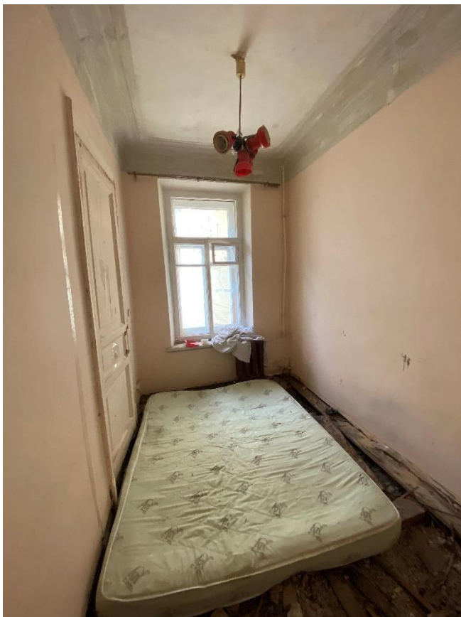
Фото 24. Помещение № 5. Комната. Вид с юго-востока.
