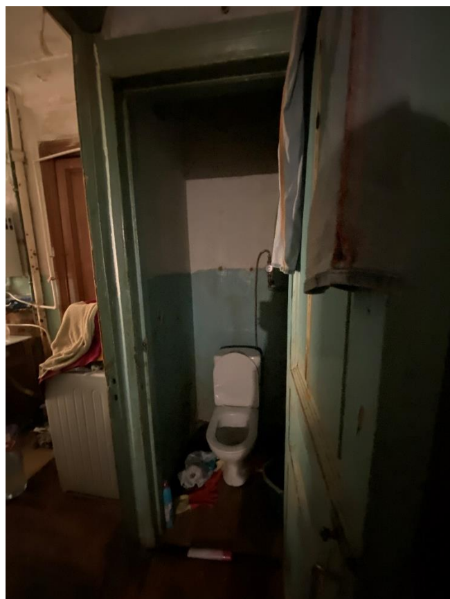
Фото 27. Помещение № 9. Туалет. Вид с юго-запада.
