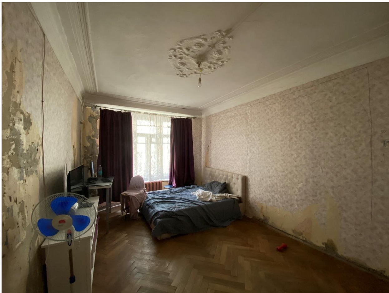
Фото 18. Помещение № 3. Комната. Вид с юго-востока.
