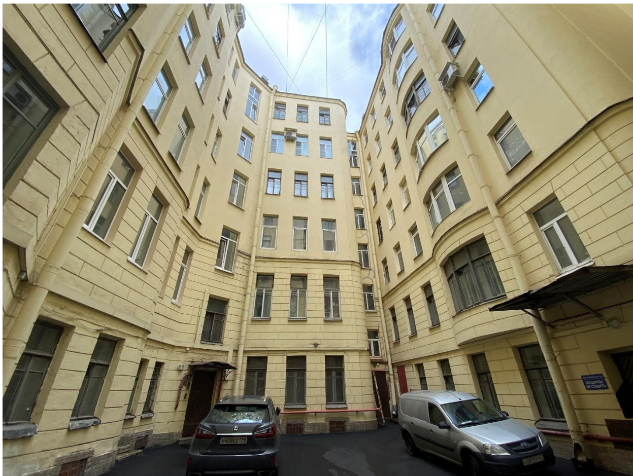
Фото 7. Юго-западный дворовый фасад северного двора.
