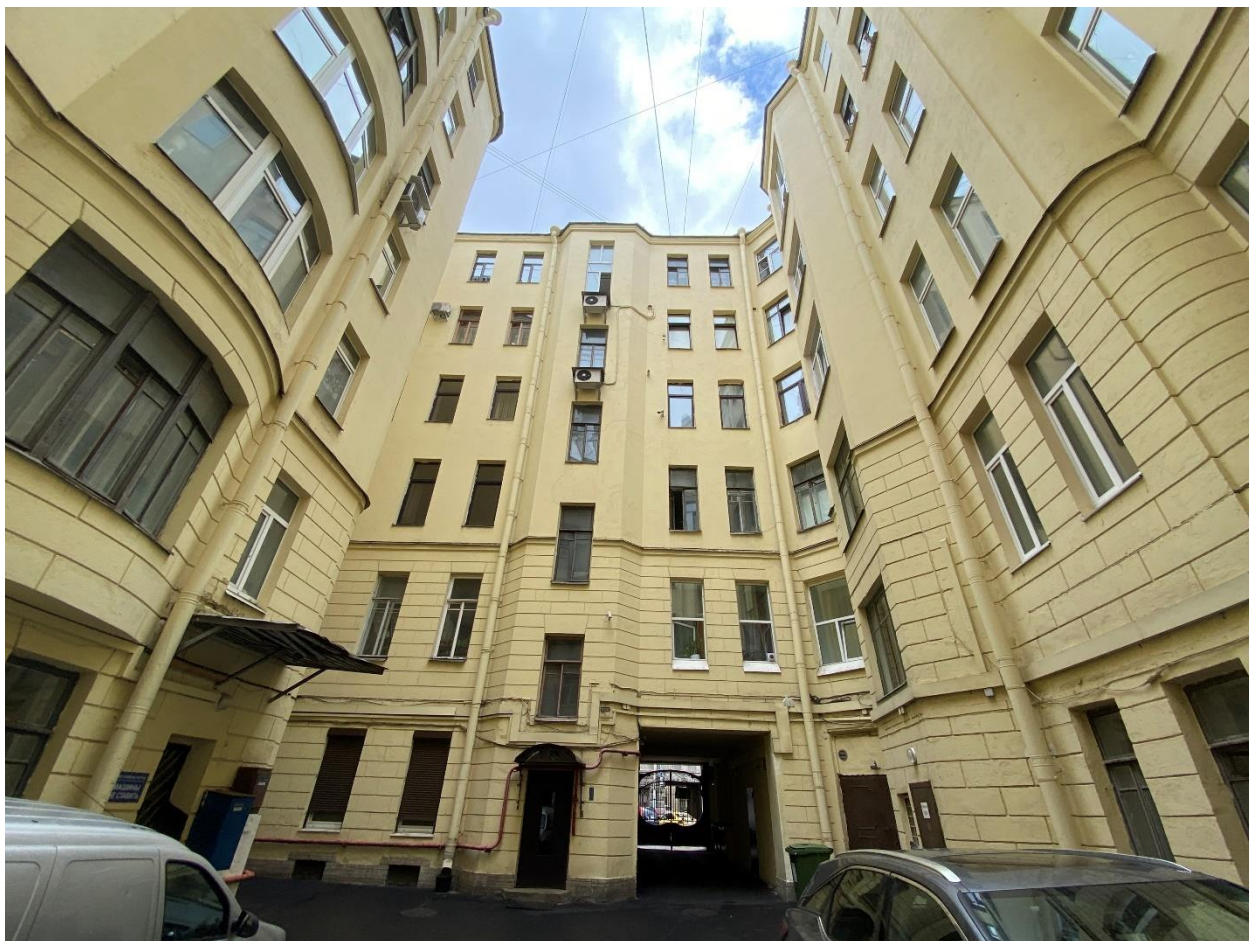
Фото 9. Северо-восточный дворовый фасад северного двора.
