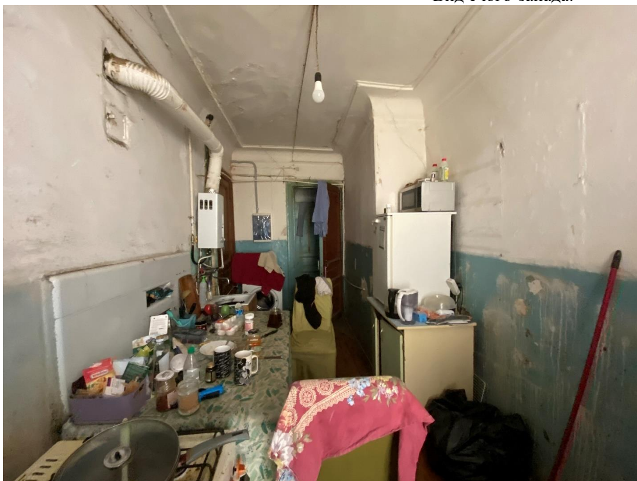
Фото 30. Помещение № 8. Кухня. Вид с северо-запада.
