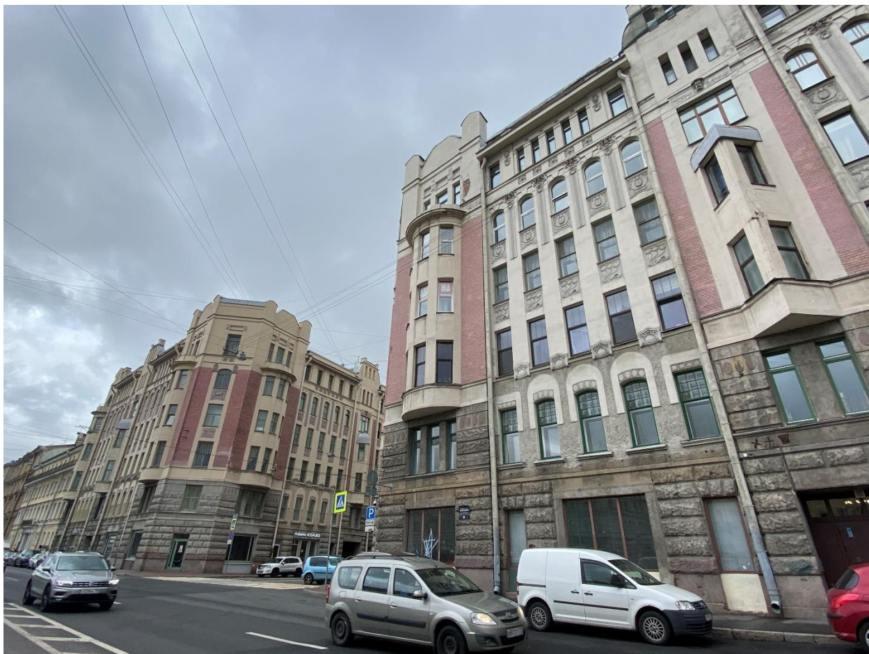
Фото 3. Общий вид объекта в перспективе застройки набережной реки Фонтанки с юго-запада.
