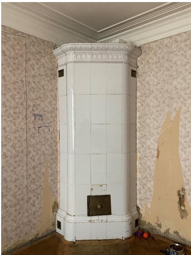
Фото 20. Помещение № 3. Комната. Угловая одноярусная на цоколе печь. Вид с запада.
