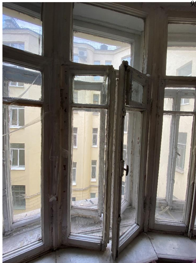
Фото 21. Помещение № 3. Комната. Существующие деревянные оконные заполнения. Вид с юго-востока.
