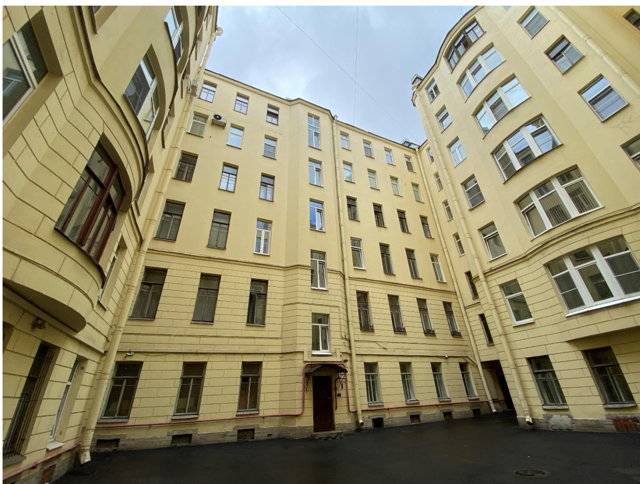
Фото 12. Северо-восточный дворовый фасад южного двора.
