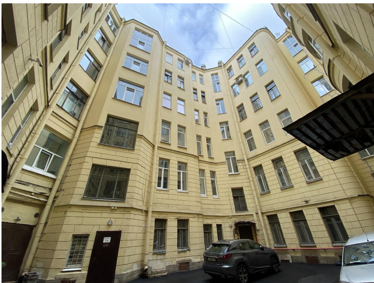
Фото 8. Юго-восточный дворовый фасад северного двора.
