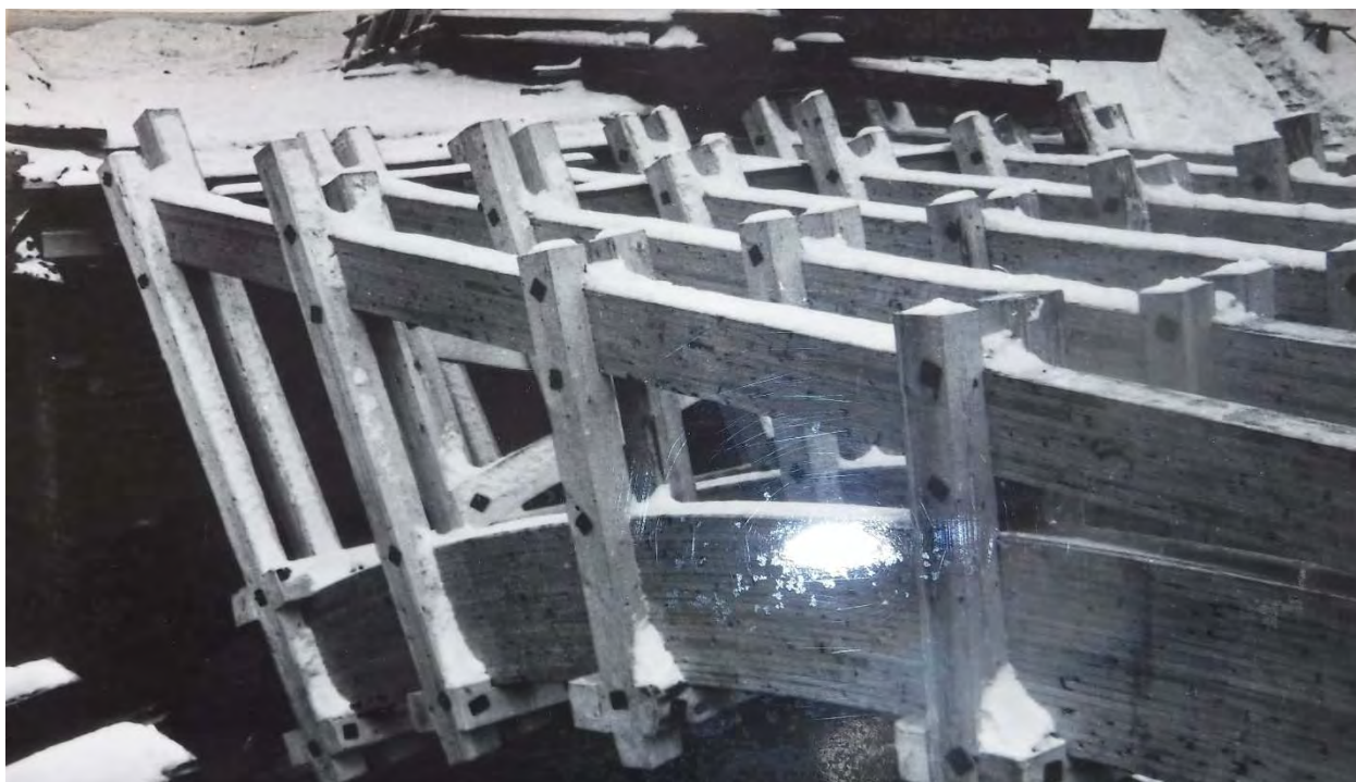
Ил. 25. Лаврский 2-й мост. Реконструкция. 1981.
