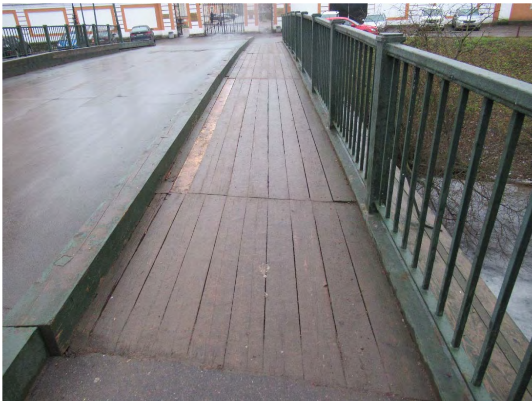
7. Объект культурного наследия регионального значения «Лаврский 2-ой мост» по адресу: г. Санкт-Петербург, через реку Монастырку по Лаврскому проезду. Вид на мостового покрытия (дощатого настила) низовой части моста. (Дата съемки 01.12.2020)
