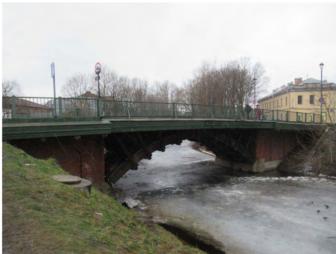
14. Объект культурного наследия регионального значения «Лаврский 2-ой мост» по адресу: г. Санкт-Петербург, через реку Монастырку по Лаврскому проезду. Вид на верховую часть моста и конструкцию из шести деревянных клееных арок. (Дата съемки 01.12.2020)
