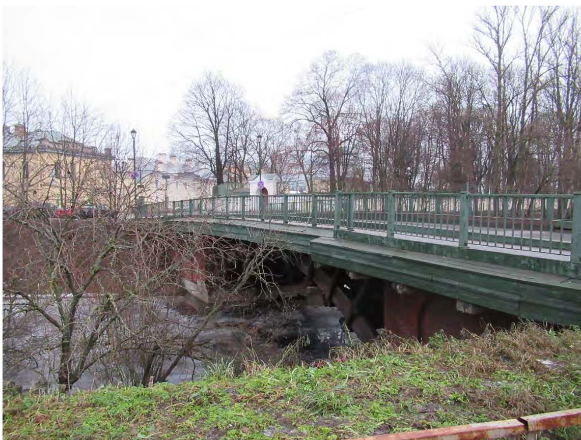
9. Объект культурного наследия регионального значения «Лаврский 2-ой мост» по адресу: г. Санкт-Петербург, через реку Монастырку по Лаврскому проезду. Вид на низовую часть моста от Епархиальной просфорной. (Дата съемки 01.12.2020)
