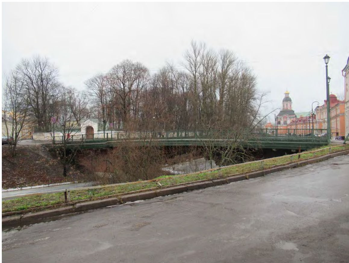
11. Объект культурного наследия регионального значения «Лаврский 2-ой мост» по адресу: г. Санкт-Петербург, через реку Монастырку по Лаврскому проезду. Вид на мост от Епархиальной просфорной. (Дата съемки 01.12.2020)
