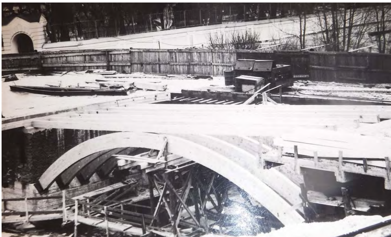
Ил. 24. Лаврский 2-й мост. Реконструкция. 1981.
