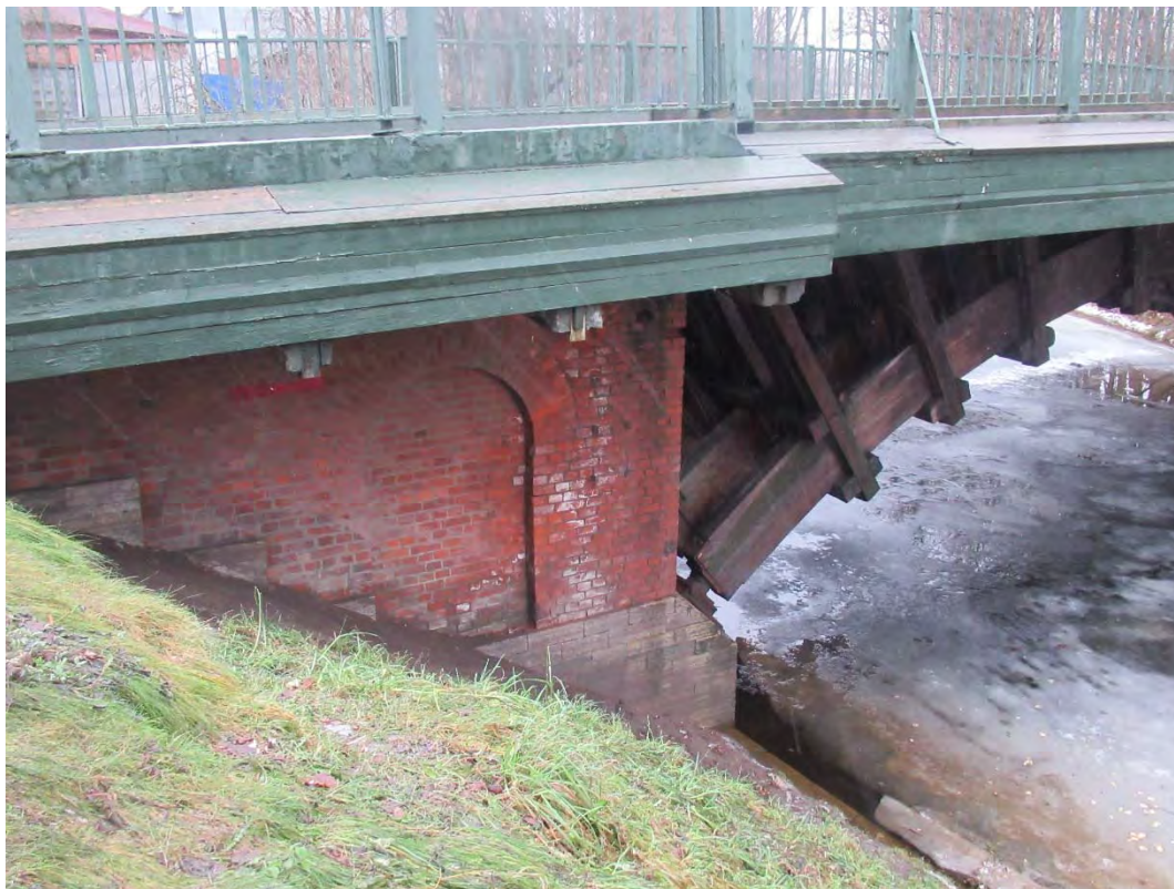
15. Объект культурного наследия регионального значения «Лаврский 2-ой мост» по адресу: г. Санкт-Петербург, через реку Монастырку по Лаврскому проезду. Вид на кирпичную опору (устой) и фрагмент конструкции из шести деревянных клееных арок. (Дата съемки 01.12.2020)
