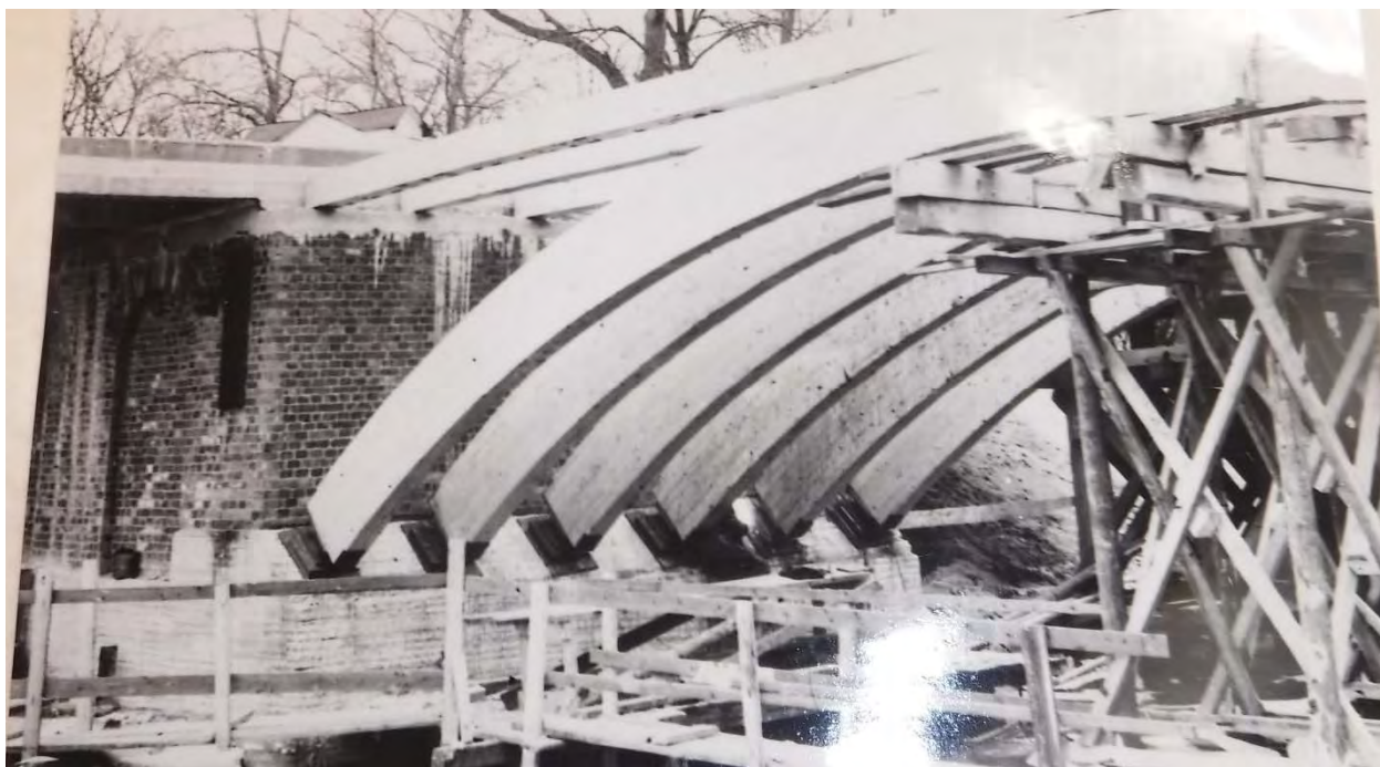
Ил. 23. Лаврский 2-й мост. Конструкции пролетных строений. 1981.
