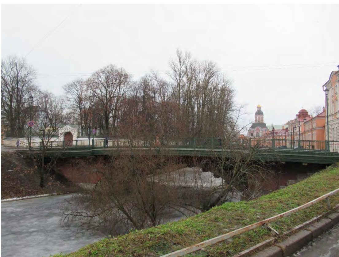
10. Объект культурного наследия регионального значения «Лаврский 2-ой мост» по адресу: г. Санкт-Петербург, через реку Монастырку по Лаврскому проезду. Вид на низовую часть моста от Епархиальной просфорной. (Дата съемки 01.12.2020)
