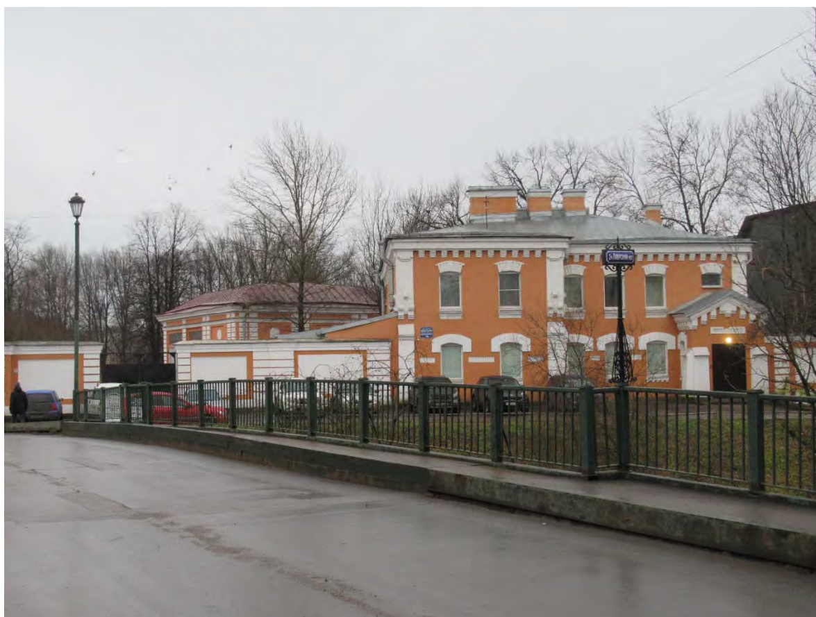
2. Объект культурного наследия регионального значения «Лаврский 2-ой мост» по адресу: г. Санкт-Петербург, через реку Монастырку по Лаврскому проезду. Вид на низовую часть моста и Епархиальную просфорную. (Дата съемки 01.12.2020)
