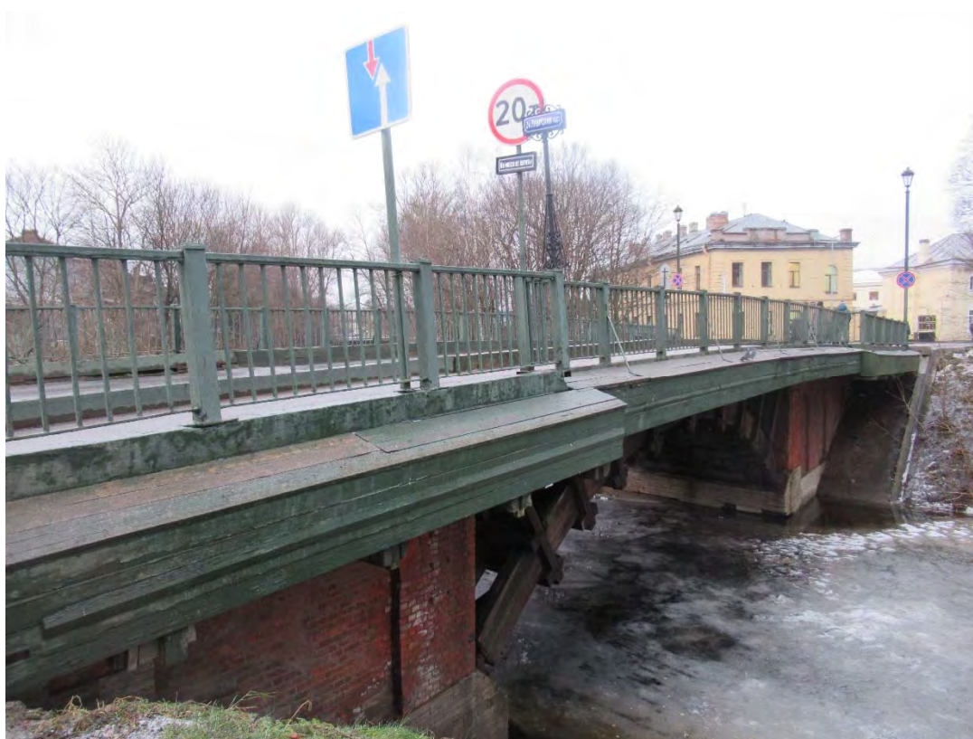
32. Объект культурного наследия регионального значения «Лаврский 2-ой мост» по адресу: г. Санкт-Петербург, через реку Монастырку по Лаврскому проезду. Вид на дощатый карниз верховой части моста от Северо-Западной башни (ризницы). (Дата съемки 01.12.2020)
