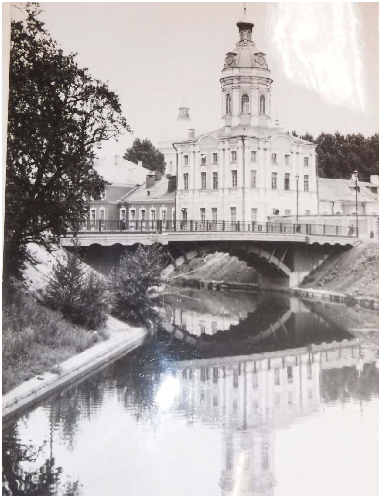
Ил. 26. Фасад Лаврского 2-го моста. 80-е гг. XX в.
