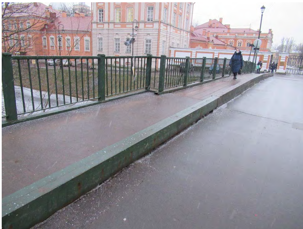
33. Объект культурного наследия регионального значения «Лаврский 2-ой мост» по адресу: г. Санкт-Петербург, через реку Монастырку по Лаврскому проезду. Вид на перильную ограду, тротуар и колесоотбойное ограждение верховой части моста. (Дата съемки 01.12.2020)
