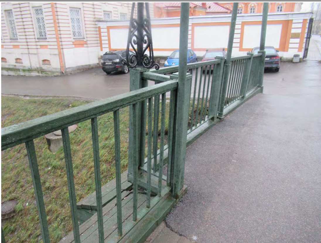
19. Объект культурного наследия регионального значения «Лаврский 2-ой мост» по адресу: г. Санкт-Петербург, через реку Монастырку по Лаврскому проезду. Вид на перильную ограду верховой части моста. (Дата съемки 01.12.2020)
