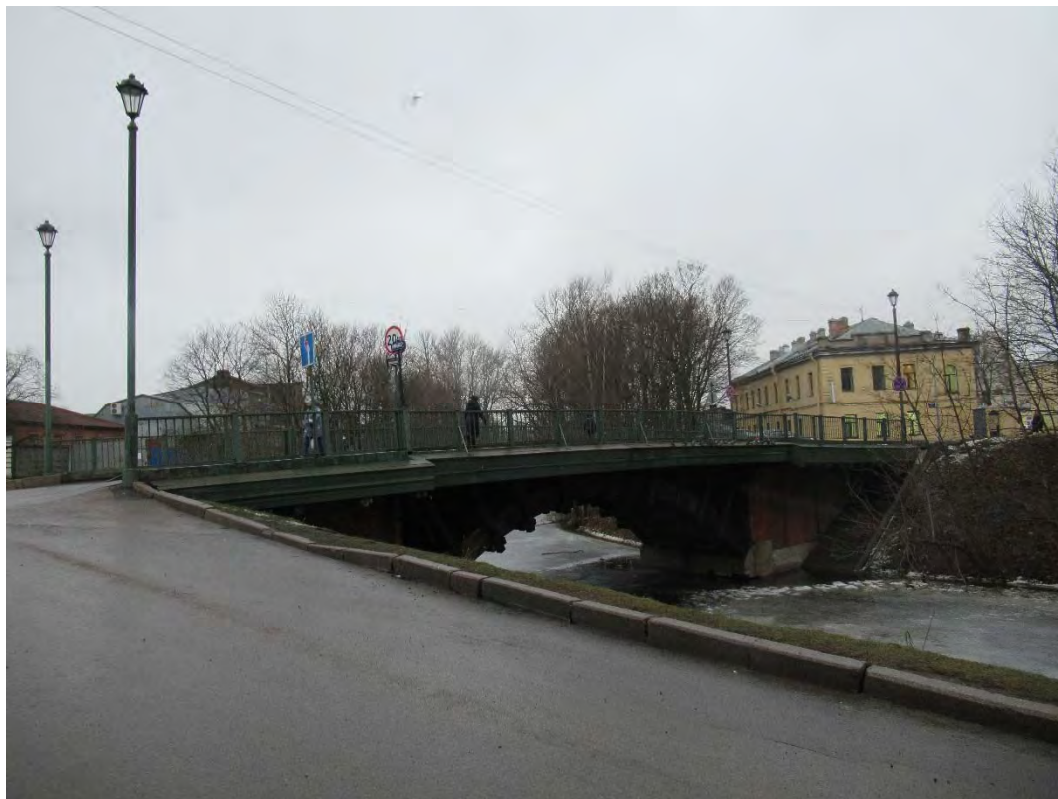
13. Объект культурного наследия регионального значения «Лаврский 2-ой мост» по адресу: г. Санкт-Петербург, через реку Монастырку по Лаврскому проезду. Вид на верховую часть моста от Северо-Западной башни (ризницы) Александро-Невской Лавры. (Дата съемки 01.12.2020)
