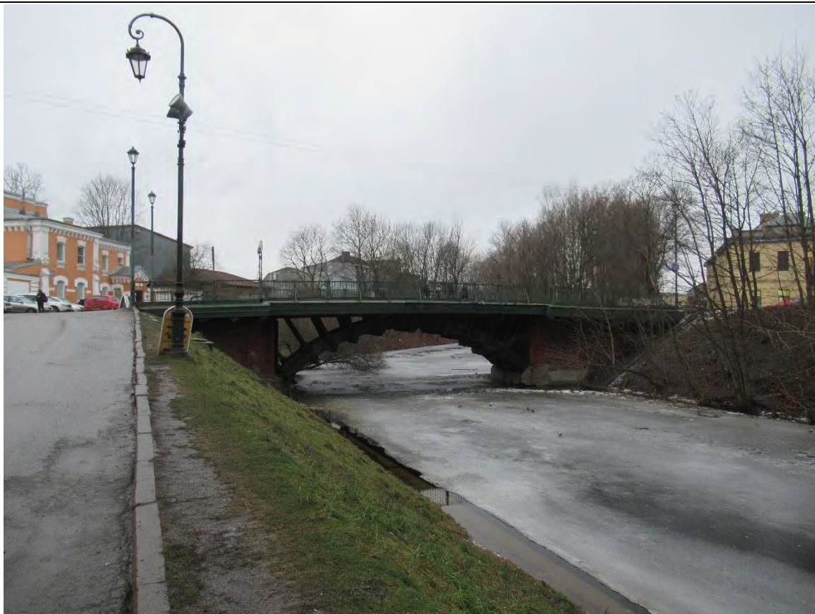
36. Объект культурного наследия регионального значения «Лаврский 2-ой мост» по адресу: г. Санкт-Петербург, через реку Монастырку по Лаврскому проезду. Вид на верховую часть моста от Северо-Западной башни (ризницы). (Дата съемки 01.12.2020)
