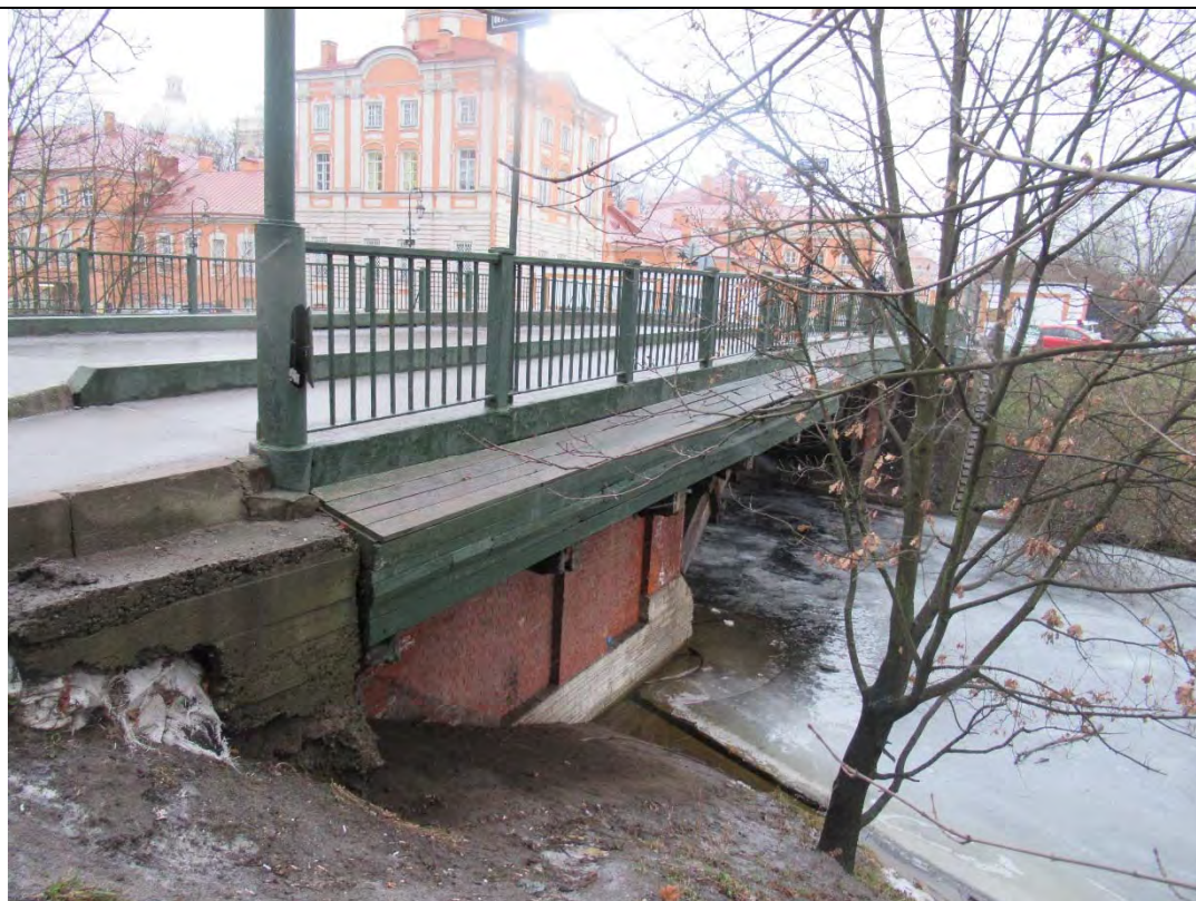
21. Объект культурного наследия регионального значения «Лаврский 2-ой мост» по адресу: г. Санкт-Петербург, через реку Монастырку по Лаврскому проезду. Вид на низовую часть моста от Монастырской больницы в Конюшенном дворе Александро-Невской лавры. (Дата съемки 01.12.2020)
