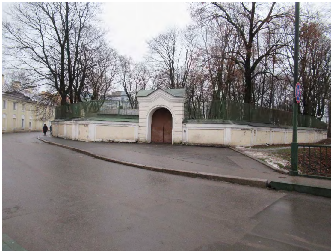
4. Объект культурного наследия регионального значения «Лаврский 2-ой мост» по адресу: г. Санкт-Петербург, через реку Монастырку по Лаврскому проезду. Вид на ограду Тихвинского кладбища с низовой части моста. (Дата съемки 01.12.2020)
