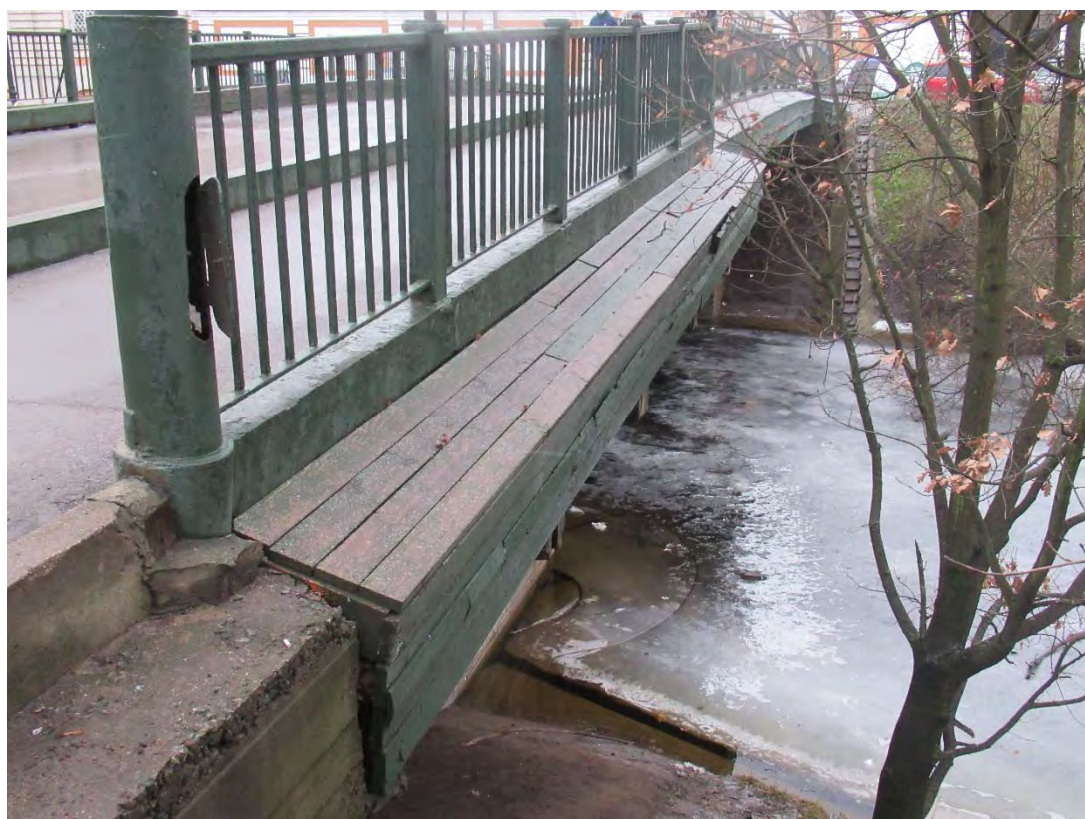
26. Объект культурного наследия регионального значения «Лаврский 2-ой мост» по адресу: г. Санкт-Петербург, через реку Монастырку по Лаврскому проезду. Вид на дощатый карниз низовой части моста от Монастырской больницы в Конюшенном дворе Александро-Невской лавры. (Дата съемки 01.12.2020)
