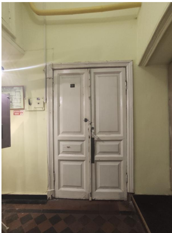
Фото 26. Лестничная площадка (на отм. +7.800), входное заполнение в квартиру
