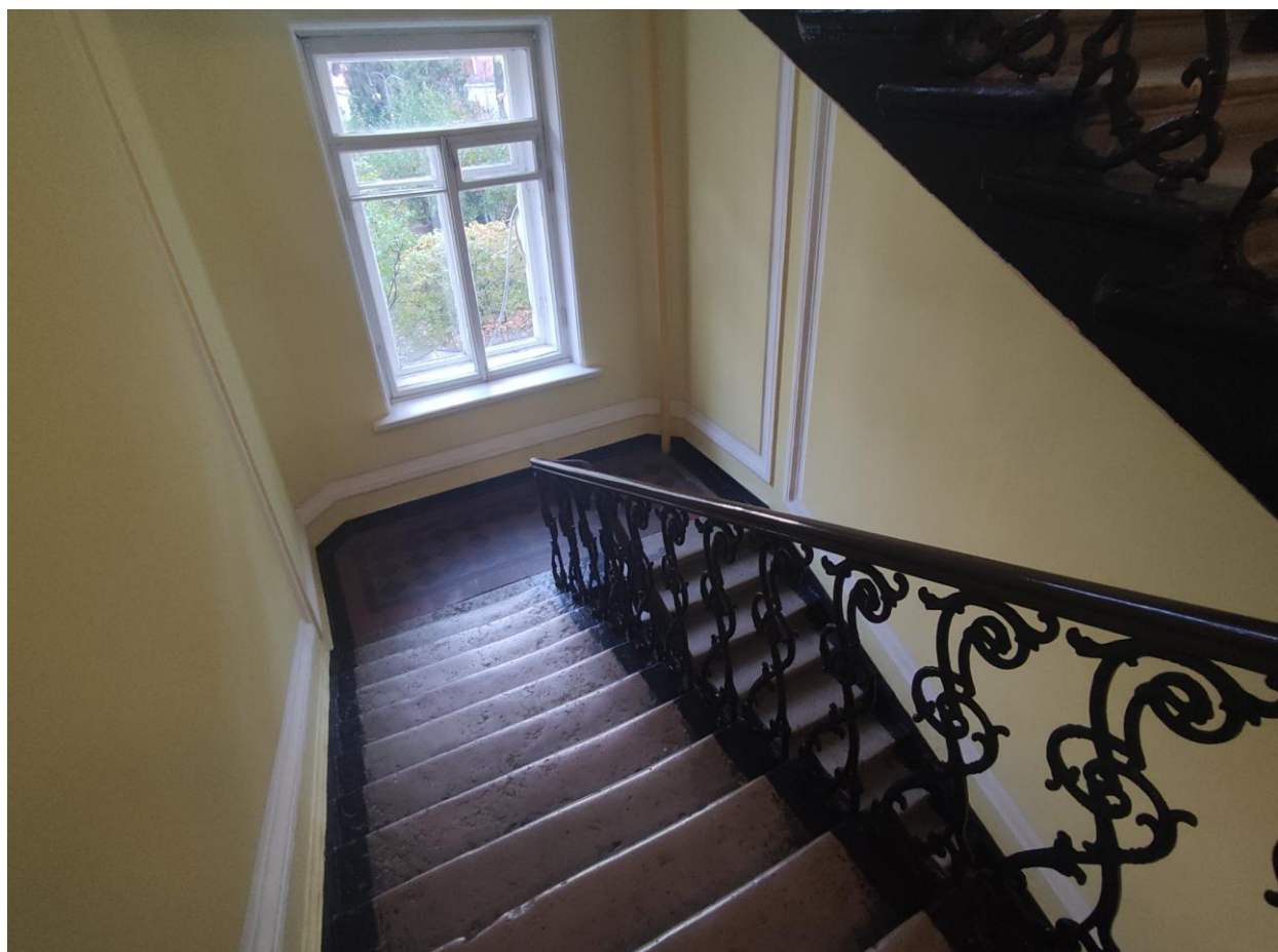
Фото 24. Лестничная площадка (на отм. +7.800)
