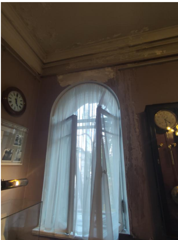
Фото 30. Интерьер квартиры, ч.п. 3, оконное заполнение
