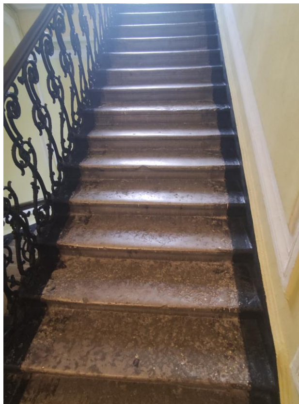
Фото 19. Лестничная площадка, ступени лестницы
