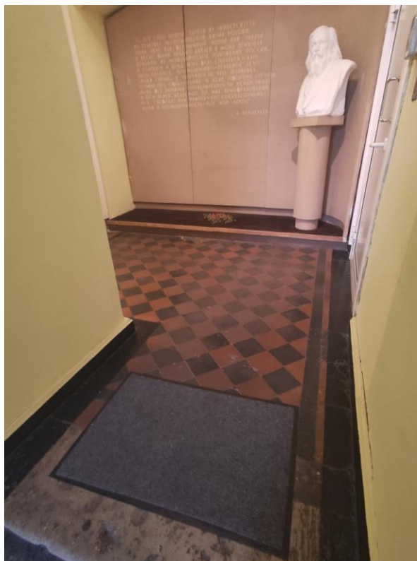
Фото 25. Лестничная площадка (на отм. +7.800), напольная плитка
