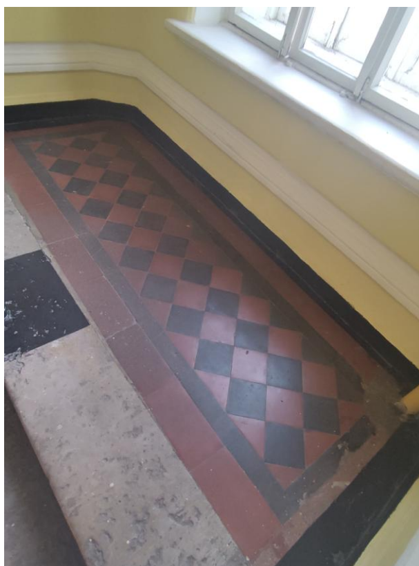
Фото 20. Лестничная площадка (на отм. +5.800), напольная плитка
