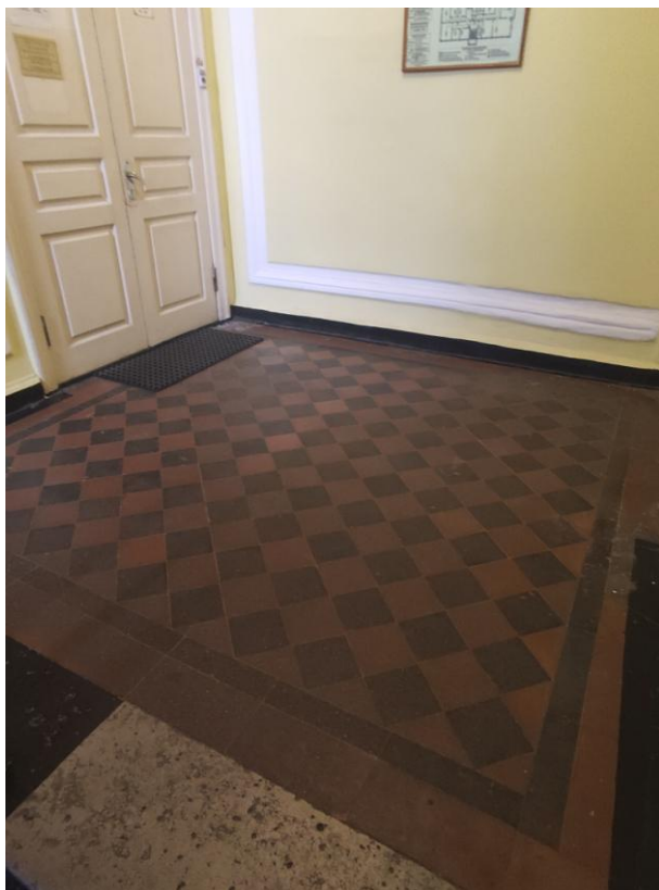
Фото 18. Лестничная площадка (на отм. +3.900), напольная плитка
