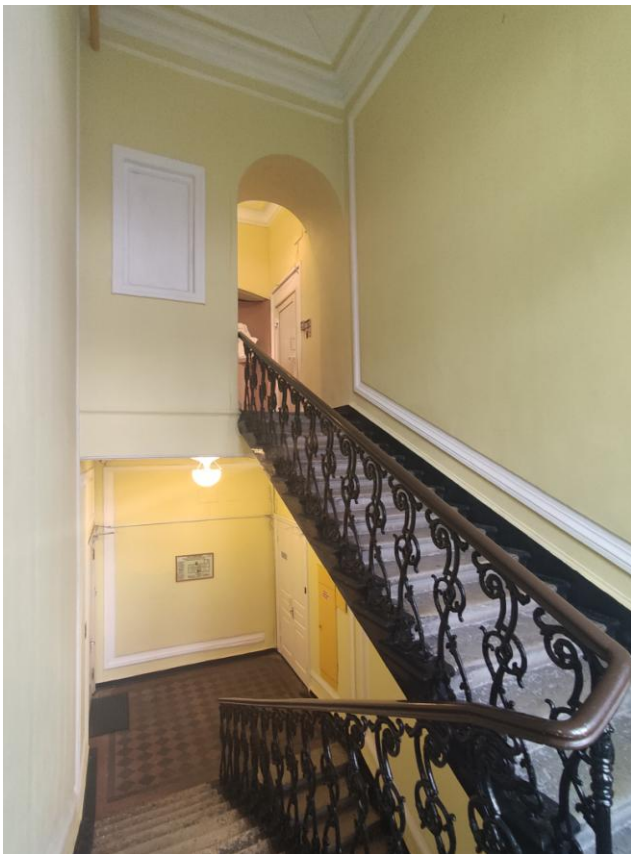
Фото 22. Лестничная площадка (на отм. +5.800)
