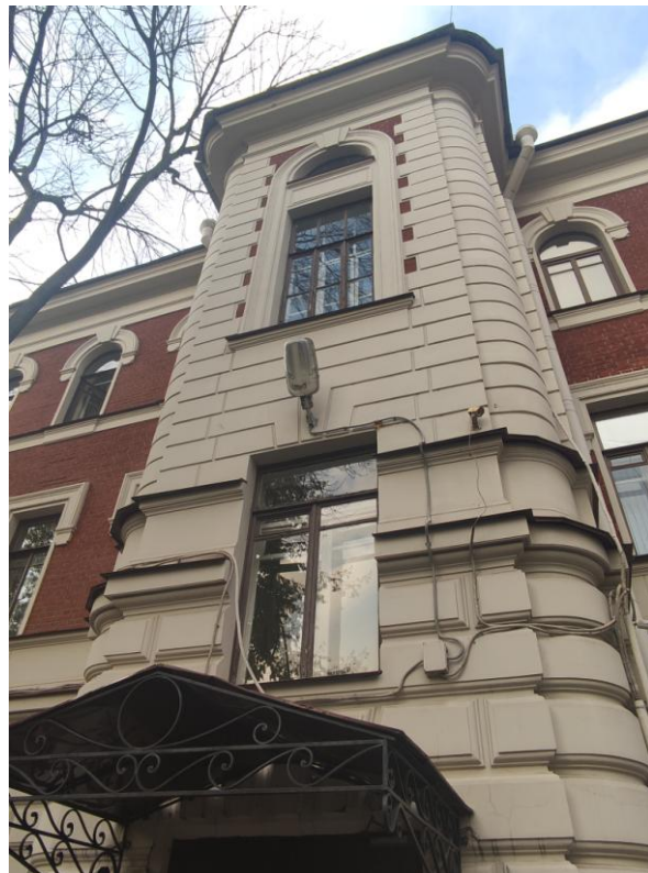
Фото 4. Фрагмент фасада объекта культурного наследия федерального значения «Жилой дом палаты мер и весов. Здесь в 1897-1907 гг. жил и работал химик Менделеев Д.И.», оконные заполнения
