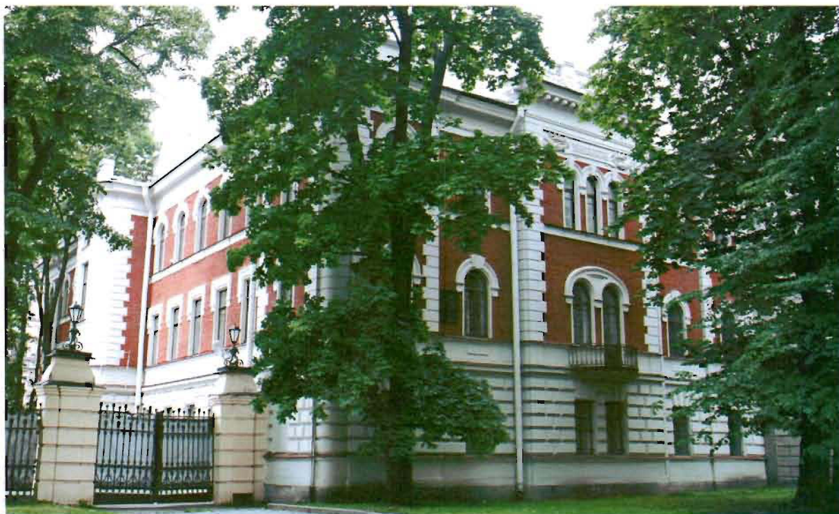
Фото №1. Вид со стороны Московского проспекта.
