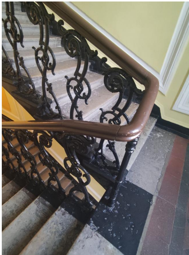
Фото 23. Лестничная площадка (на отм. +5.800), ограждение лестницы
