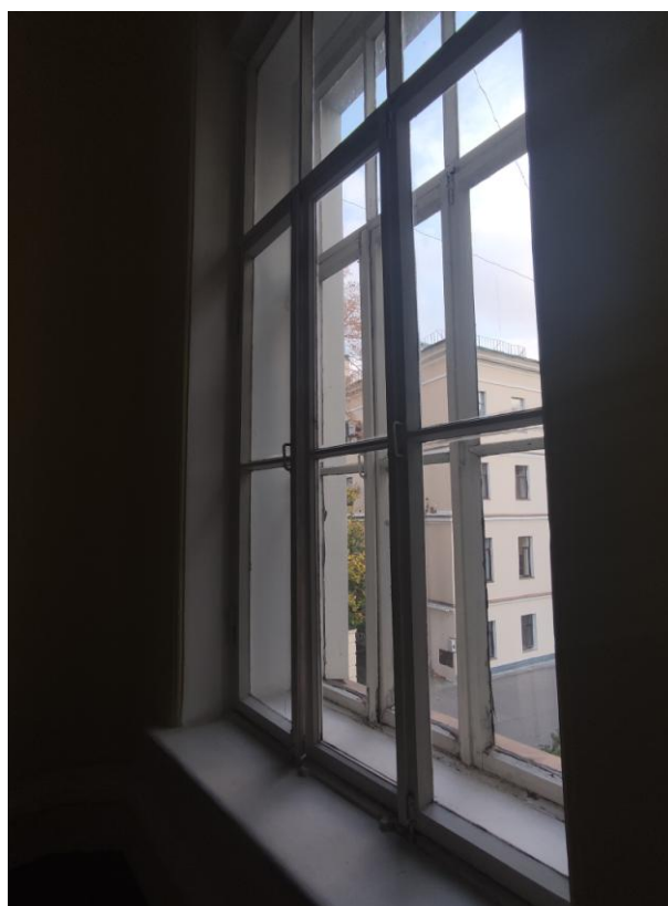
Фото 21. Лестничная площадка (на отм. +5.800), оконное заполнение
