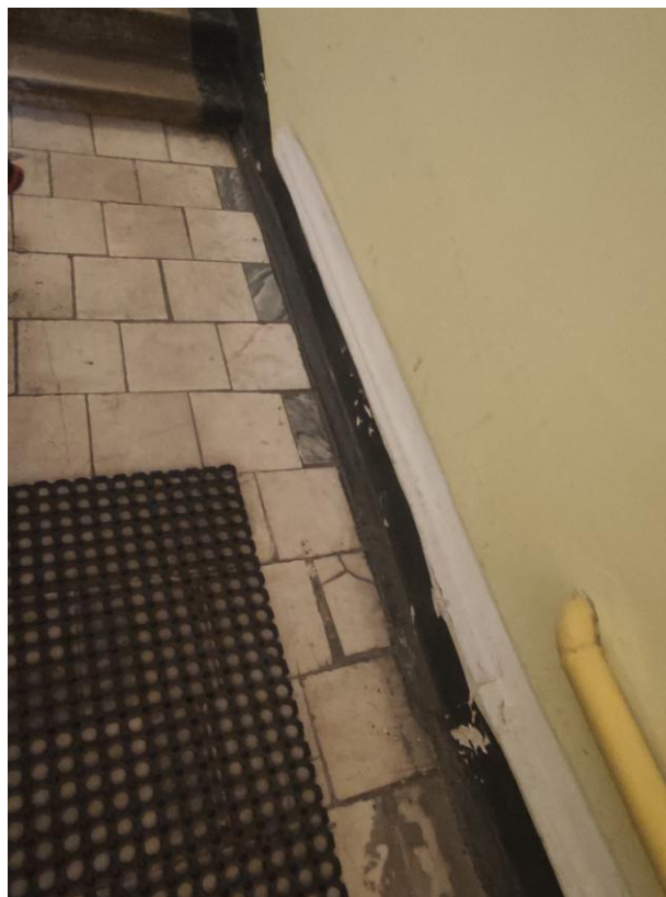
Фото 10. Лестничная площадка, напольная плитка первый этаж
