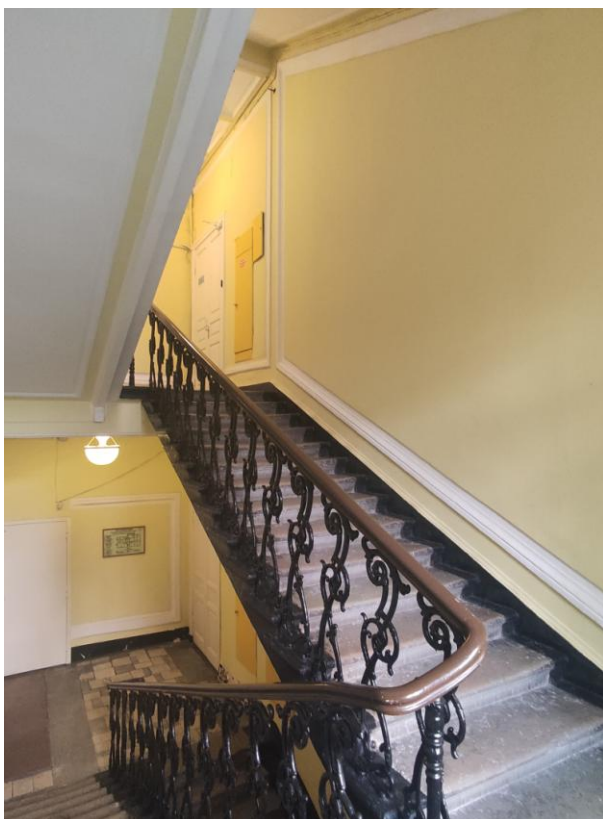
Фото 16. Лестничная площадка (на отм. +1.950)
